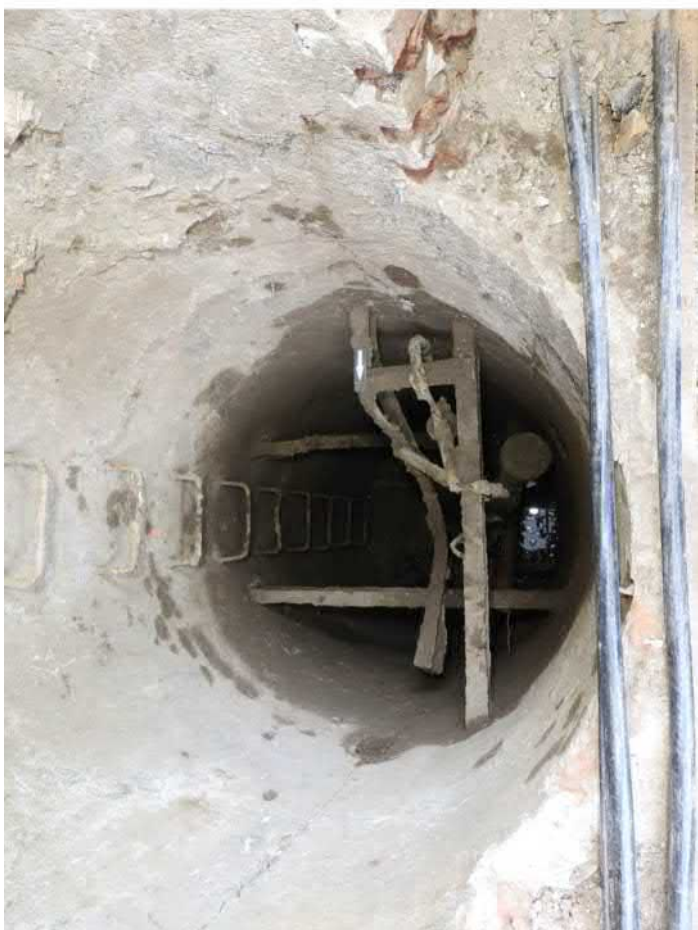
501-F31: Železné konstrukce a součásti čerpadla ve studni Z050; foceno od východu; fotil Ditmar E.; datum 17.6.2020
