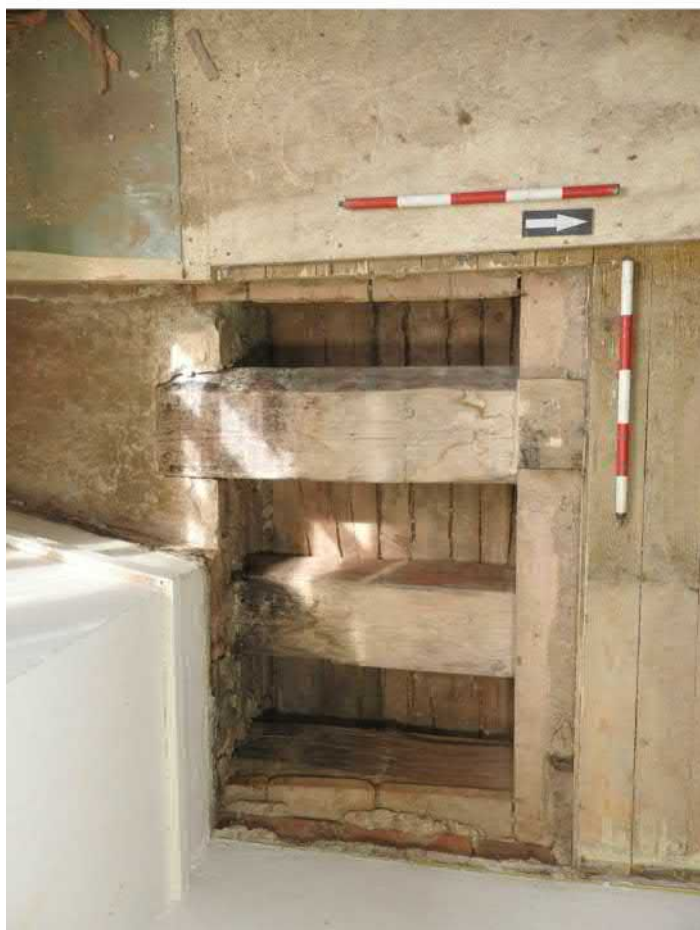
1306-F03: Stropní a podlahové trámy v sondě 1306; foceno od severu; fotil Ditmar E.; datum 20.5.2020
