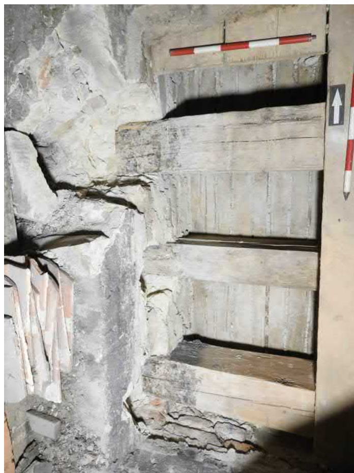
1406-F06: Stropní a podlahové trámy v sondě 1406; foceno od východu; fofil Ditmar E.; datum 26.5.2020
