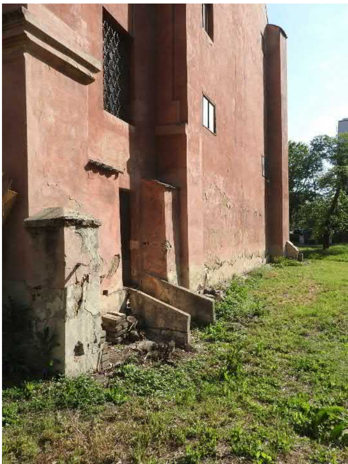
Celek-F017: Jihovýchodní roh Invalidovny před zahájením výzkumu; foceno od jihozápadu; fotil Ditmar E.; datum 21.5.2020
