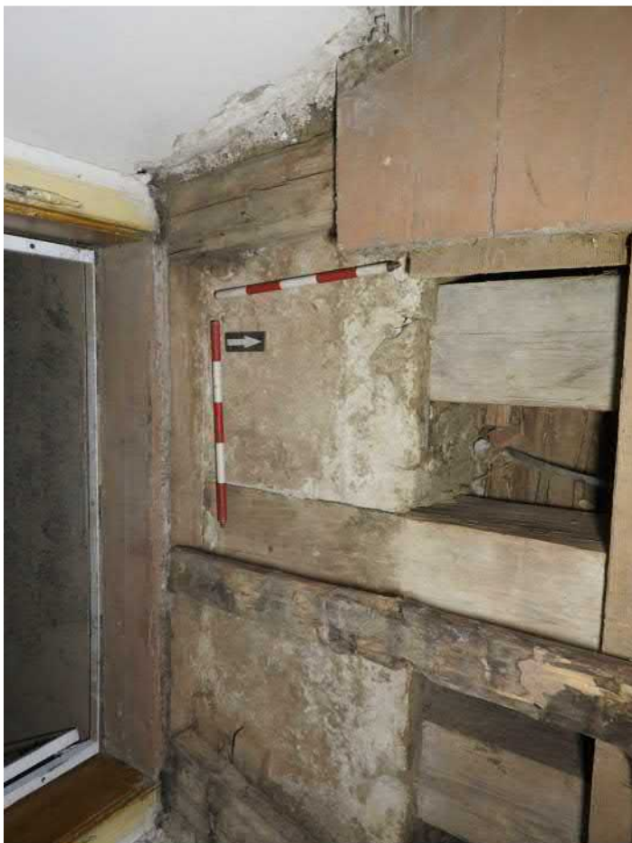
1304-F05: Stropní a podlahové trámy v sondě 1304; foceno od severu; fotil Ditmar E.; datum 20.5.2020
