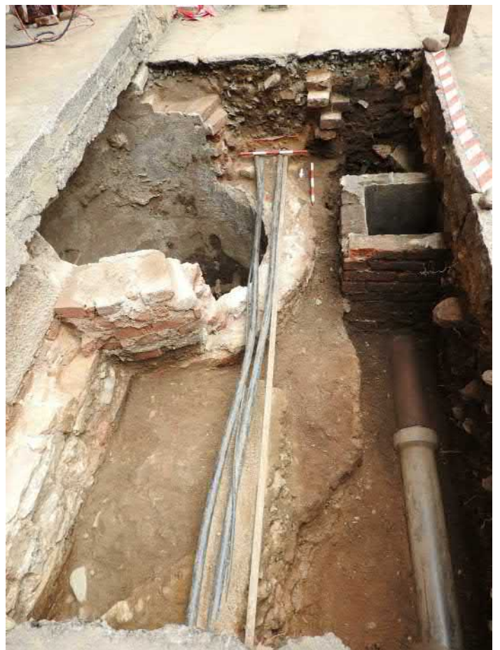
501-F60: Zdi Z048, Z049, Z050, Z051, výkopy V073, V074; foceno od severu; fotil Ditmar E.; datum 18.6.2020
