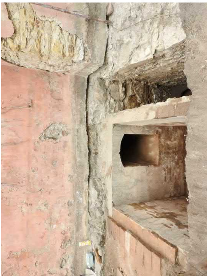
703-F13: Severní stěna sondy se zdmi Z001c a Z018; foceno od jihu; fotil Ditmar E.; datum 6.5.2020
