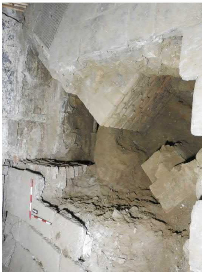
3101-F08: Zdi Z052, Z053, Z054, Z055; foceno od severu; fotil Ditmar E.; datum 10.6.2020
