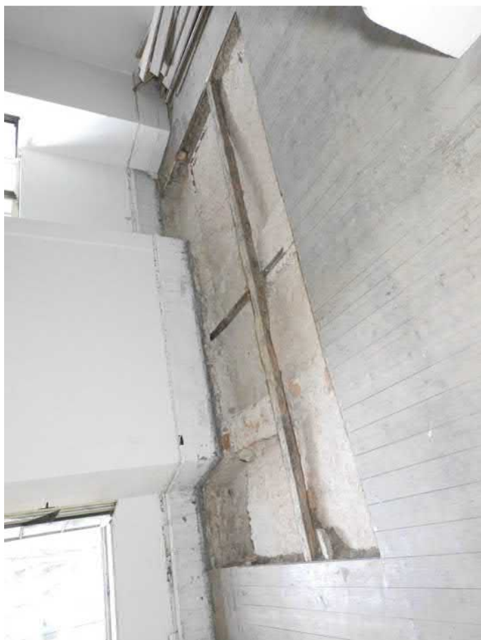
3201-F05: Zdiva v sondě 3201; foceno od severovýchodu; fotil Ditmar E.; datum 26.5.2020
