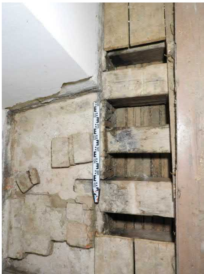
1301-F06: Stropní a podlahové trámy v sondě 1301; foceno od jihu; fotil Ditmar E.; datum 11.5.2020
