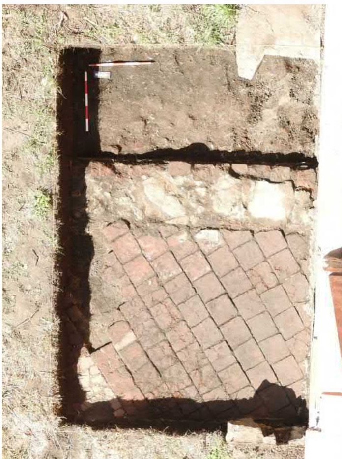
714-F09: Zdi Z025, Z026, dlažba vr. 714-02; foceno od severu; fotil Ditmar E.; datum 13.5.2020
