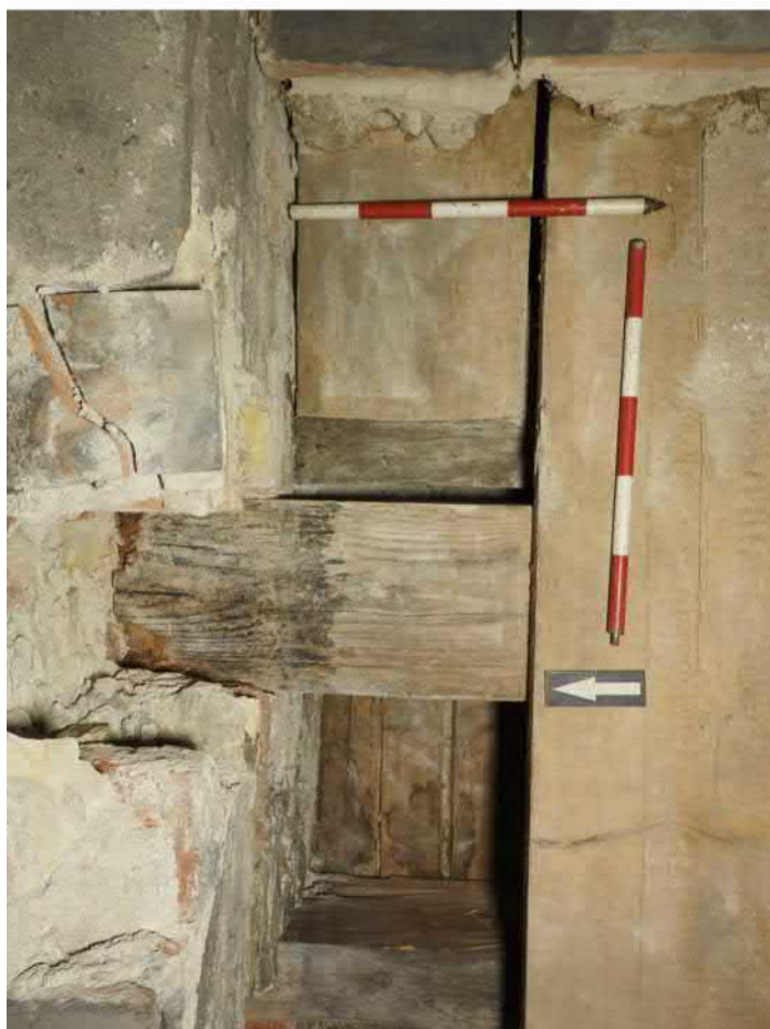
1401-F08: Stropní a podlahové trámy v sondě 1401; foceno od jihu; fotil Ditmar E.; datum 20.5.2020
