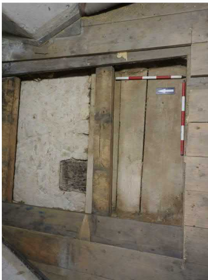
1303-F04: Sonda 1303 po odstranění druhé vrstvy prkenné podlahy; foceno od jihu; fotil Ditmar E.; datum 14.5.2020
