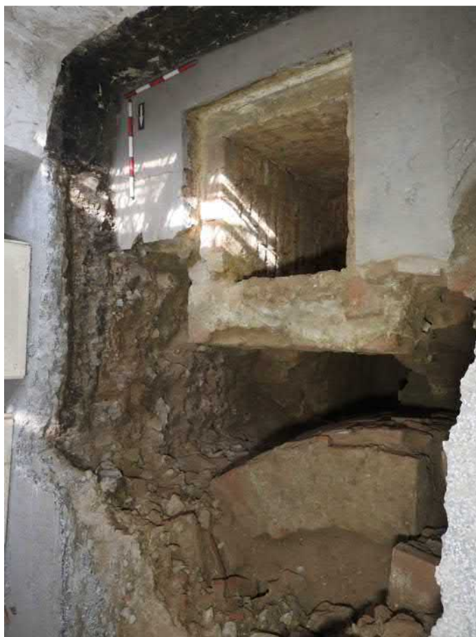
4101-F14: Zdi Z003c, Z018, Z033, Z034; foceno od západu; fotil Ditmar E.; datum 29.5.2020
