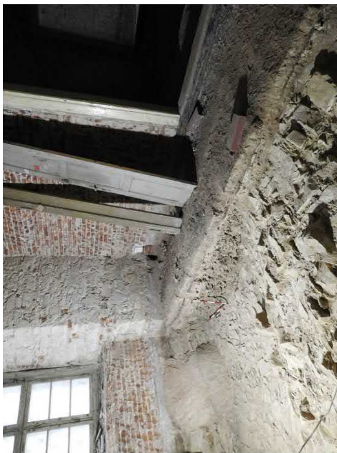
1101-F14: Řez 1101-RV; foceno od jihozápadu; fotil Ditmar E.; datum 30.4.2020
