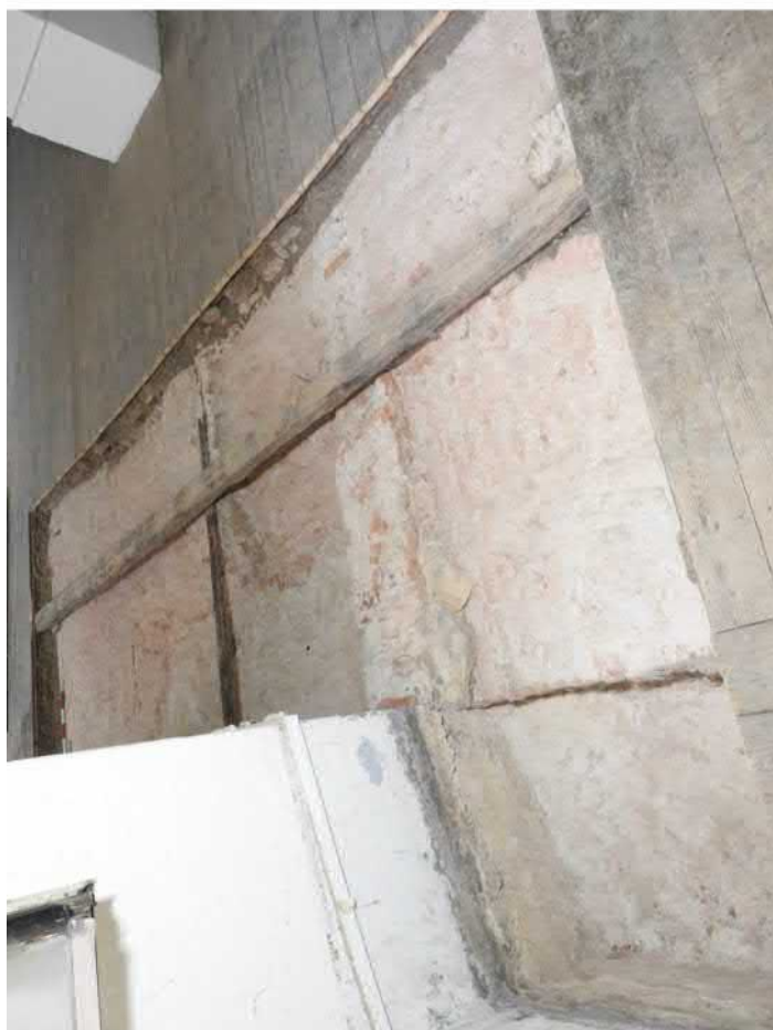
3201-F07: Zdiva v sondě 3201; foceno od jihovýchodu; fotil Ditmar E.; datum 26.5.2020
