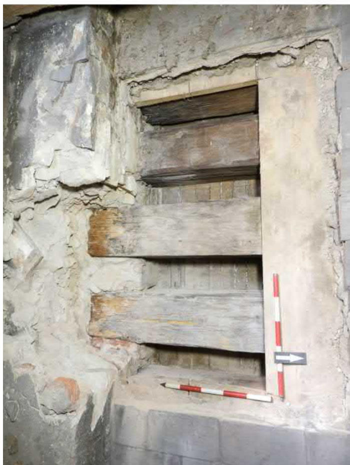
1403-F03: Stropní a podlahové trámy v sondě 1403; foceno od severu; fotil Ditmar E.; datum 26.5.2020
