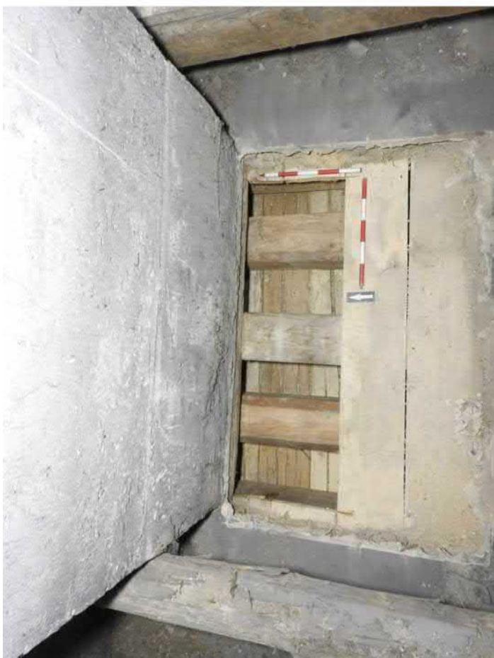
1405-F03: Stropní a podlahové trámy v sondě 1405; foceno od jihu; fotil Ditmar E.; datum 25.5.2020
