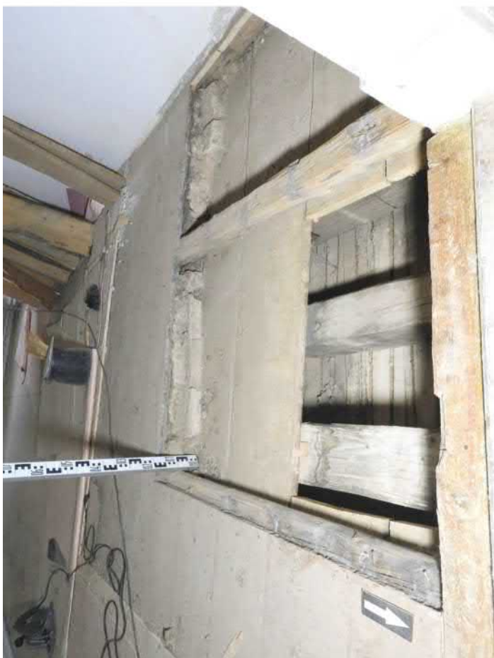
1302-F07: Stropní a podlahové trámy v sondě 1302; foceno od severu; fotil Ditmar E.; datum 11.5.2020
