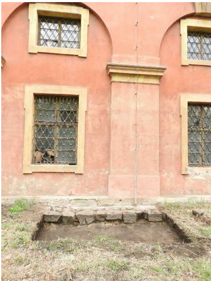
718-F01: Situace sondy 718; foceno od jihu; fotil Ditmar E.; datum 15.5.2020
