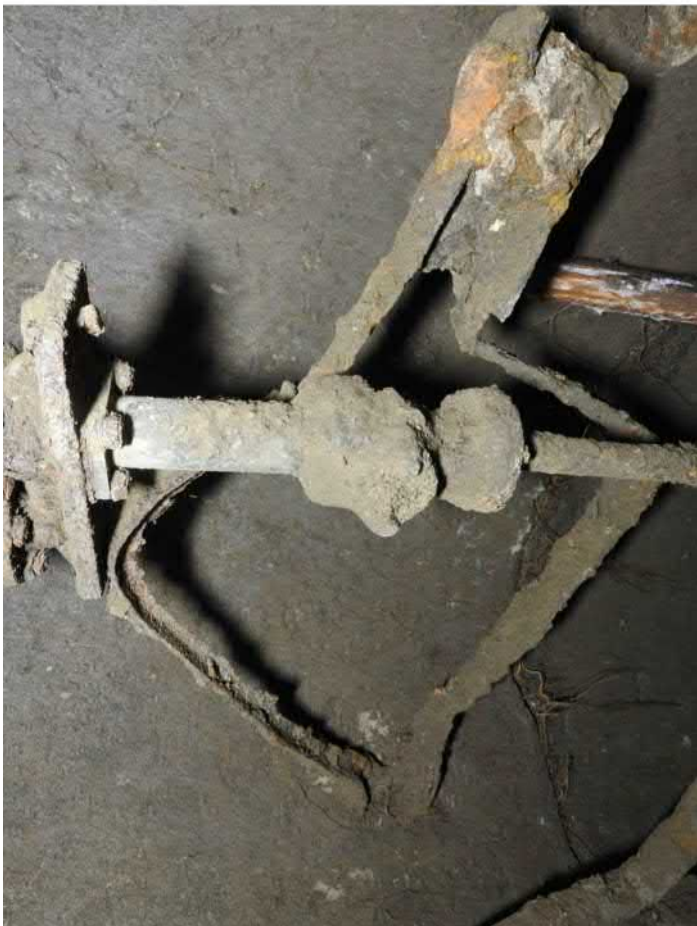
501-F47: Železná konstrukce a součásti čerpadla ve studni Z050; foceno od severovýchodu; fotil Ditmar E.; datum 17.6.2020
