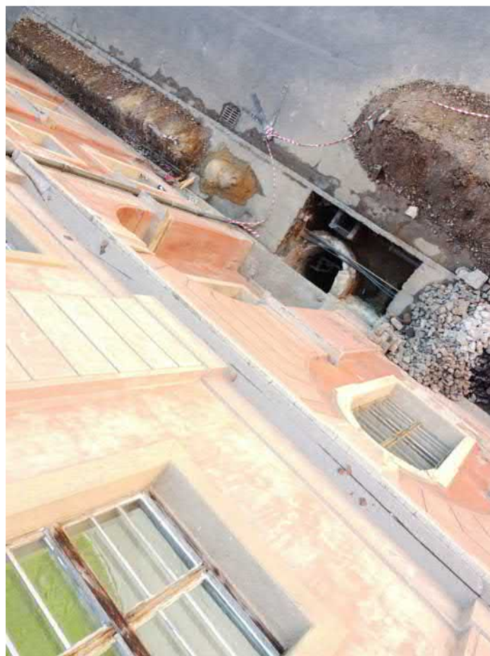
501-F78: Situace sondy 501; foceno od severozápadu; fotil Kalíšek M.; datum 22.6.2020
