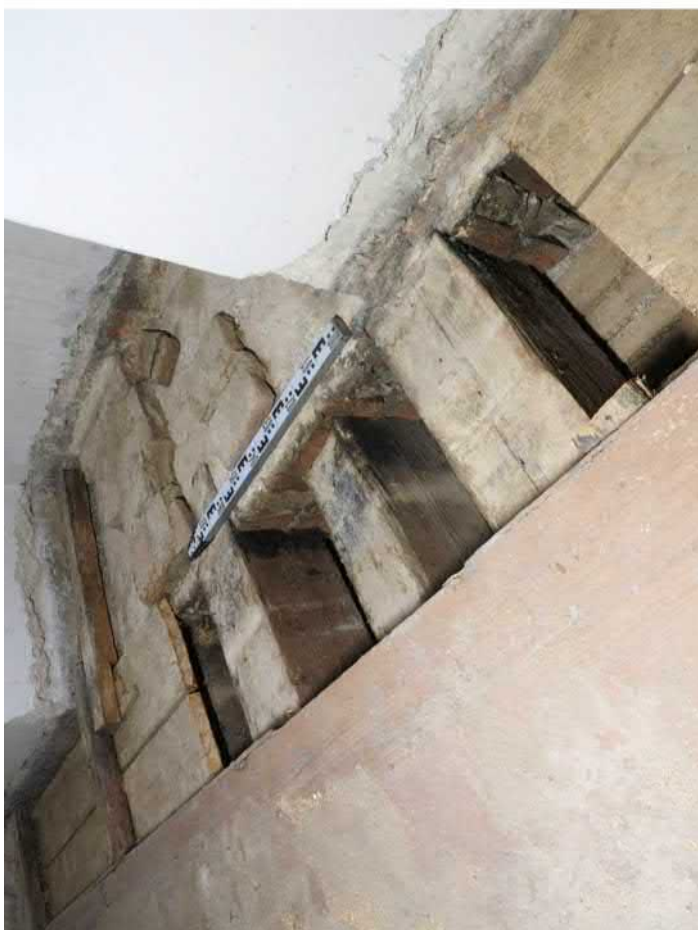
1301-F07: Stropní a podlahové trámy v sondě 1301; foceno od jihovýchodu; fotil Ditmar E.; datum 11.5.2020
