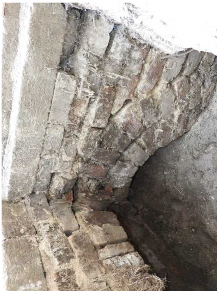
729-F10: Šachta kanalizace Z067; foceno od severozápadu; fotil Ditmar E.; datum 17.6.2020
