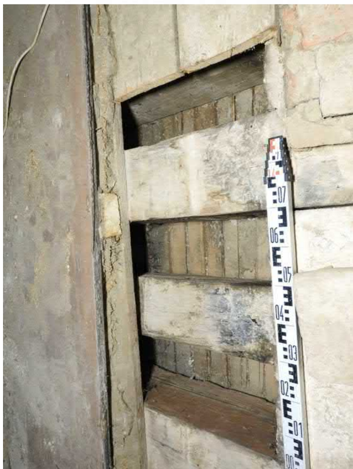
1301-F09: Stropní a podlahové trámy v sondě 1301; foceno od jihu; fotil Ditmar E.; datum 11.5.2020
