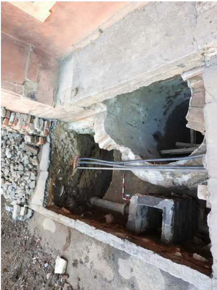
501-F61: Zdi Z048, Z049, Z050, Z051, výkopy V073, V074; foceno od jihu; fotil Ditmar E.; datum 22.6.2020
