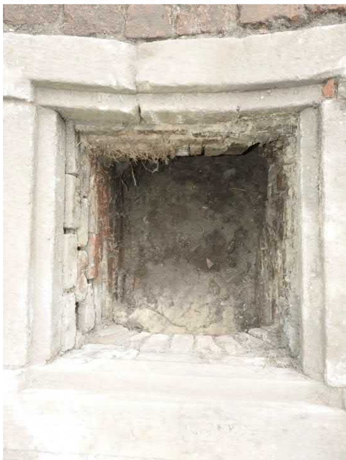
729-F05: Šachta kanalizace Z067; foceno od východu; fotil Ditmar E.; datum 17.6.2020
