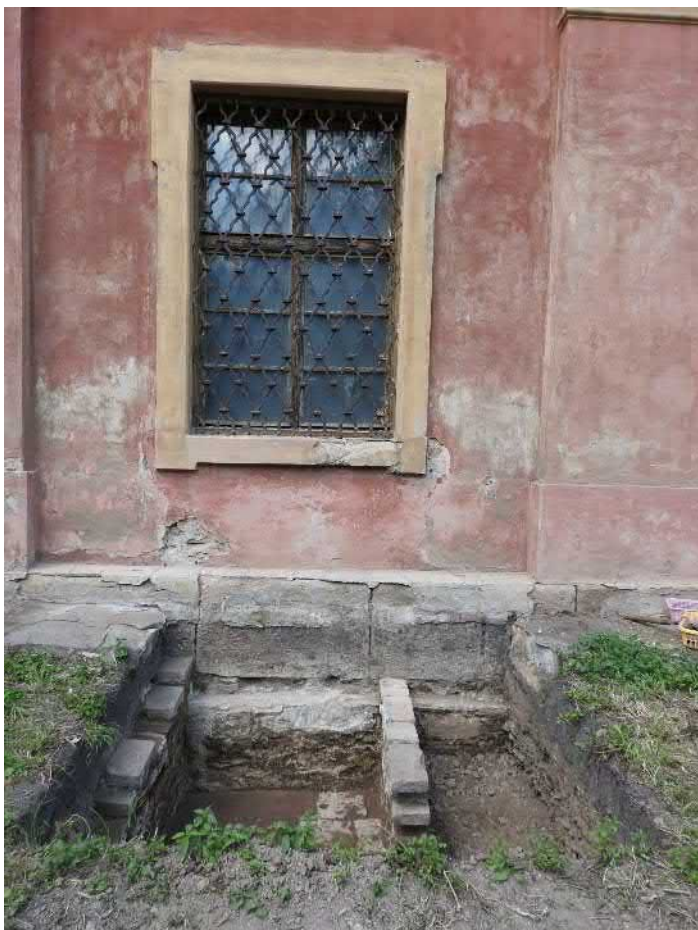
717-F13: Zdi Z026, Z030; foceno od jihu; fotil Ditmar E.; datum 19.5.2020
