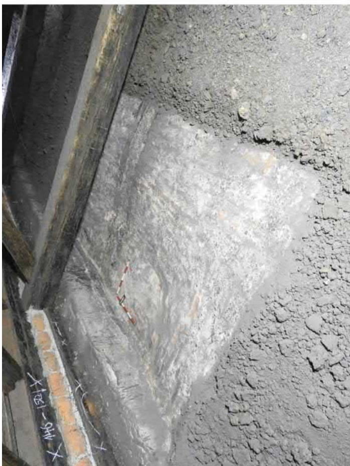
3401-F07: Zdiva v sondě 3401; foceno od severovýchodu; fotil Ditmar E.; datum 25.5.2020
