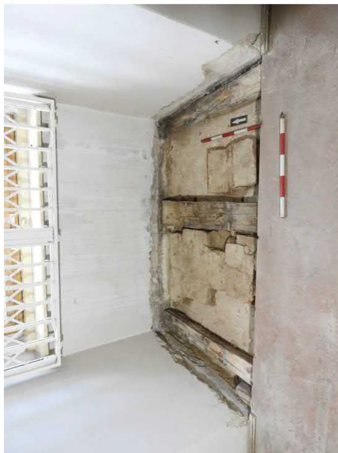
1301-F02: Sonda 1301 po odstranění podlahy; foceno od jihu; fotil Ditmar E.; datum 6.5.2020
