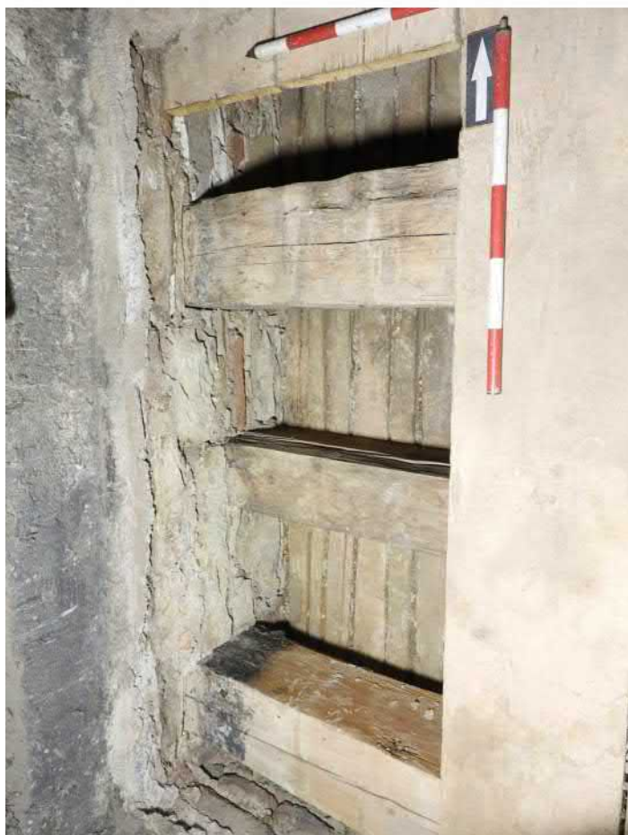
1406-F05: Stropní a podlahové trámy v sondě 1406; foceno od východu; fofil Ditmar E.; datum 25.5.2020
