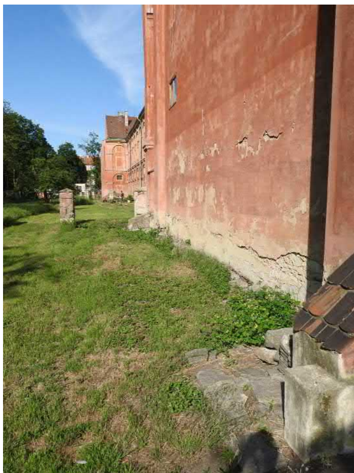
Celek-F016: Jihovýchodní roh Invalidovny před zahájením výzkumu; foceno od východu; fotil Ditmar E.; datum 21.5.2020
