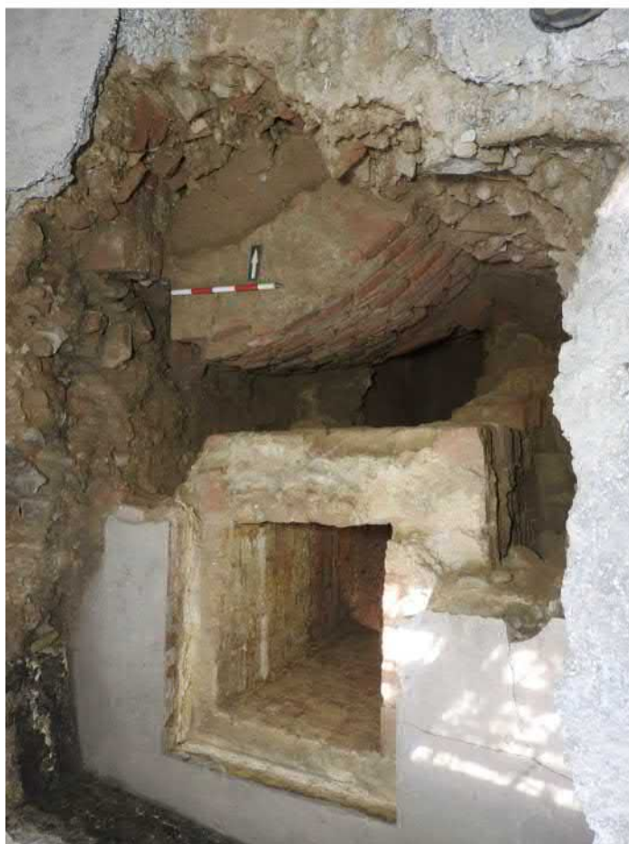
4101-F16: Zdi Z003c, Z018, Z033, Z034; foceno od východu; fotil Ditmar E.; datum 29.5.2020
