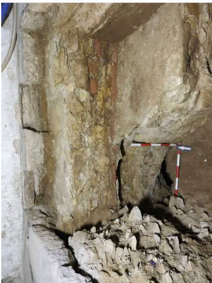
3102-F19: Severní stěna sondy se zdmi Z031, Z032 a výkopem V049; foceno od jihu; fotil Ditmar E.; datum 29.5.2020
