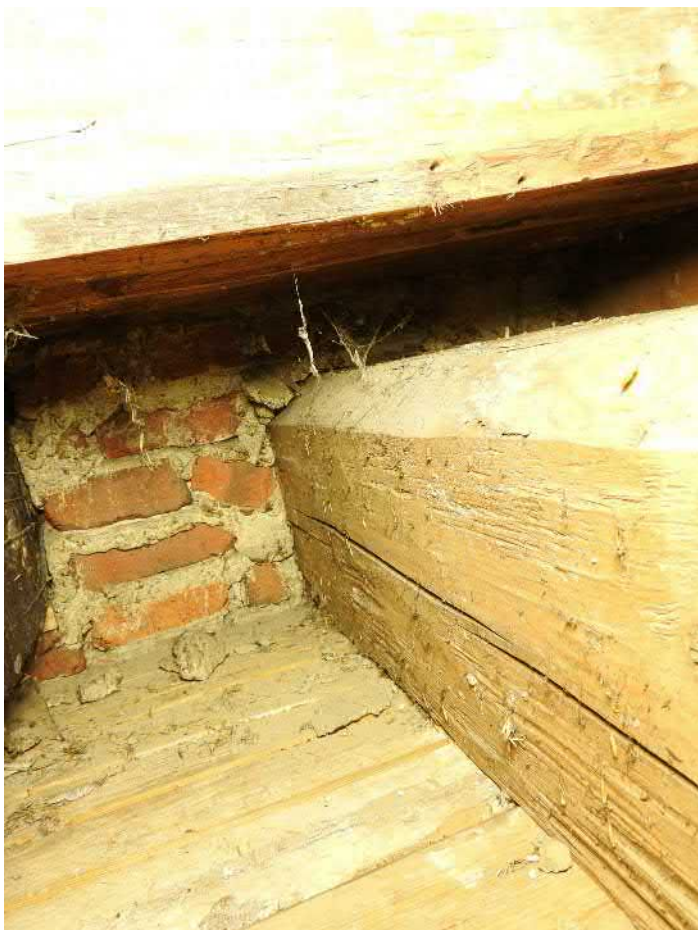
1405-F05: Stropní a podlahové trámy v sondě 1405; foceno od jihozápadu; fotil Ditmar E.; datum 25.5.2020
