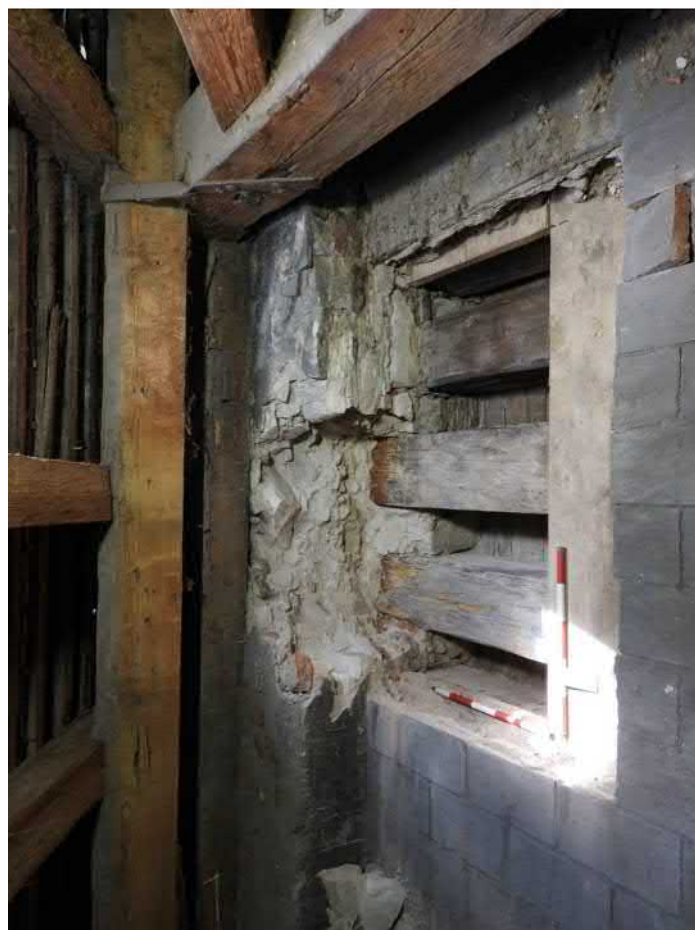
1403-F02: Stropní a podlahové trámy v sondě 1403; foceno od severu; fotil Ditmar E.; datum 26.5.2020
