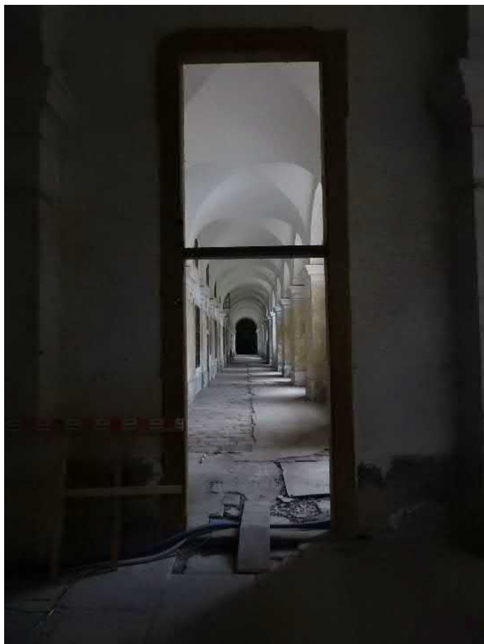
3102-F01: Situace sondy 3102; foceno od východu; fotil Ditmar E.; datum 28.5.2020
