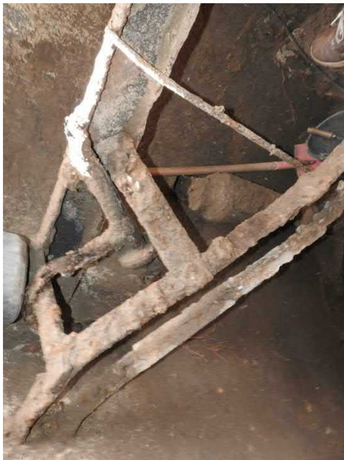
501-F30: Železné konstrukce a součásti čerpadla ve studni Z050; foceno od severozápadu; fotil Ditmar E.; datum 15.6.2020
