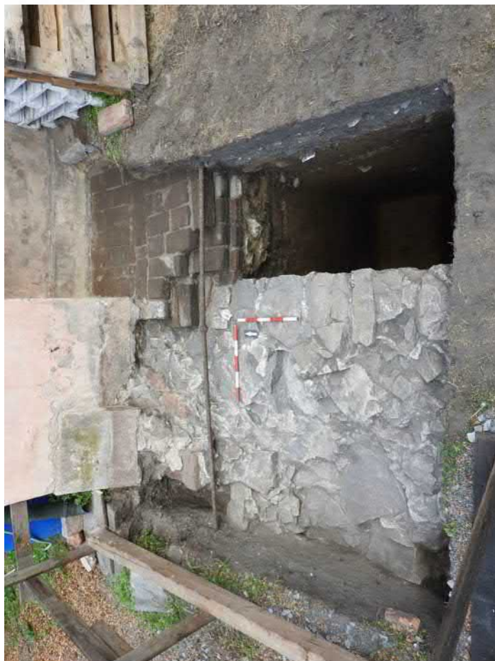
701-F18: Zdi Z01a, Z03a, Z05; foceno od jihu; fotil Ditmar E.; datum 1.5.2020
