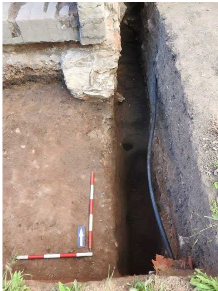
720-F18: výkopy V054, V061, V062; foceno od jihu; fotil Ditmar E.; datum 2.6.2020
