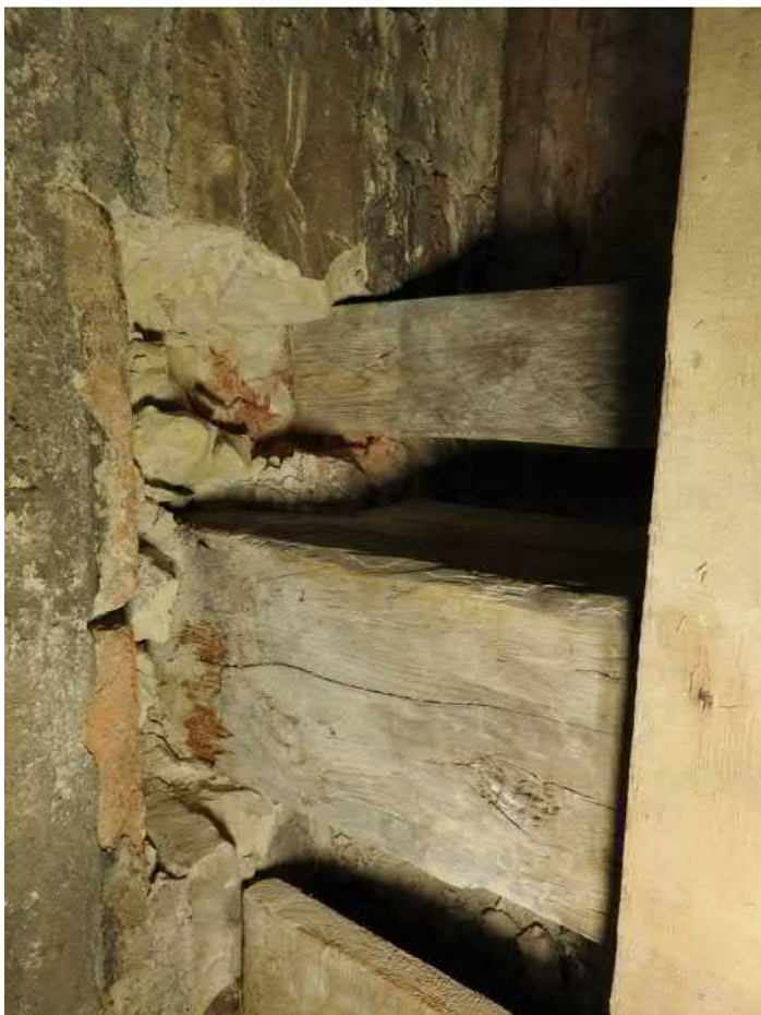
1401-F09: Stropní a podlahové trámy v sondě 1401; foceno od jihu; fotil Ditmar E.; datum 20.5.2020
