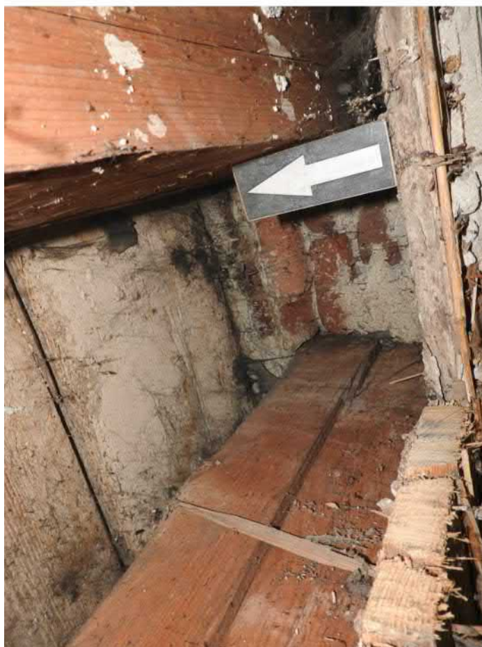
1310-F04: Stropní a podlahové trámy v sondě 1310; foceno od jihu; fotil Ditmar E.; datum 8.6.2020
