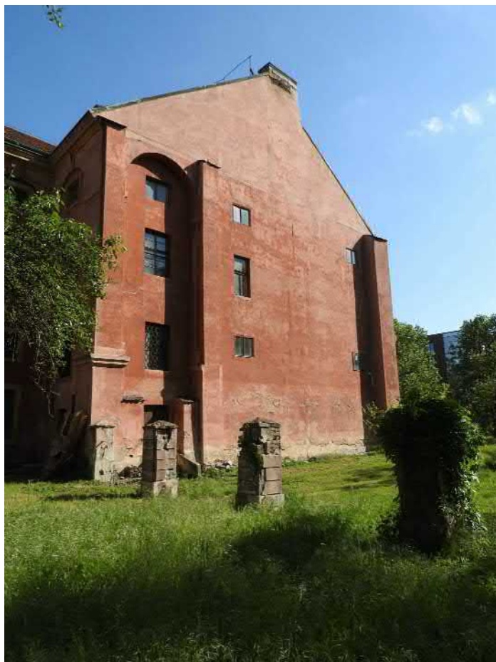
Celek-F014: Jihovýchodní roh Invalidovny před zahájením výzkumu; foceno od jihozápadu; fotil Ditmar E.; datum 21.5.2020
