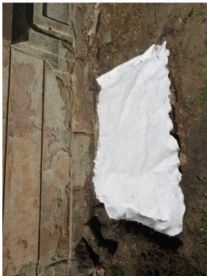
729-F16: Zakrytá šachta kanalizace Z067; foceno od východu; fotil Ditmar E.; datum 24.6.2020
