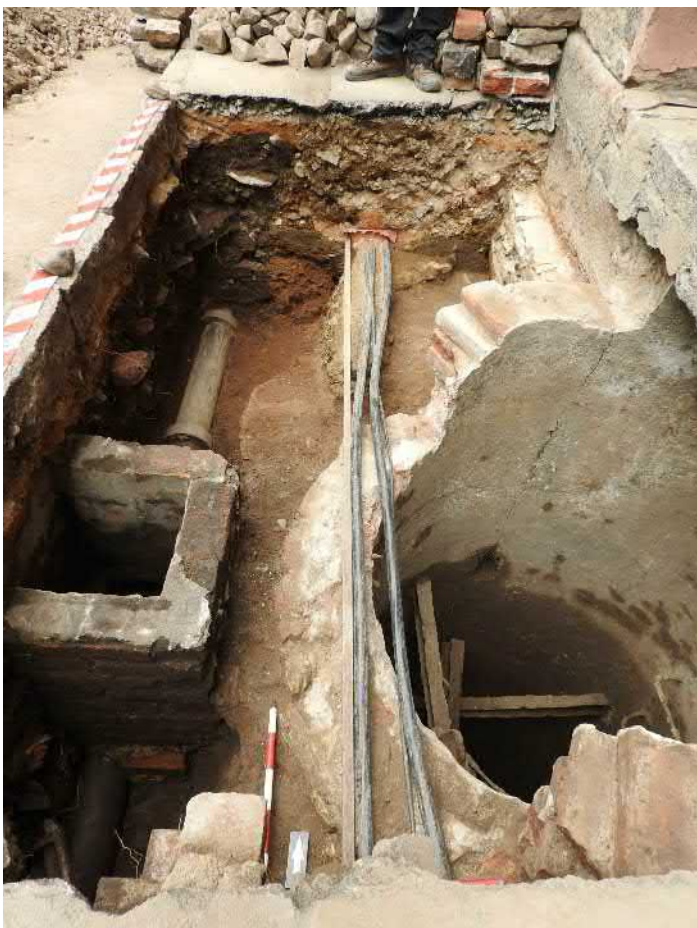
501-F59: Zdi Z048, Z049, Z050, Z051, výkopy V073, V074; foceno od jihu; fotil Ditmar E.; datum 18.6.2020
