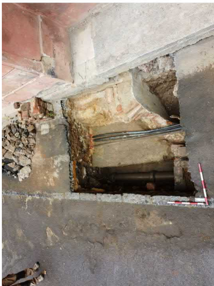
501-F12: Zdi Z048, Z049, Z050, Z051, výkopy V073, V074; foceno od jihu; fotil Kalíšek M.; datum 10.6.2020
