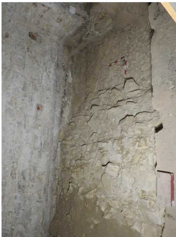
1101-F06: Zdi Z014, Z015; foceno od východu; fotil Ditmar E.; datum 30.4.2020
