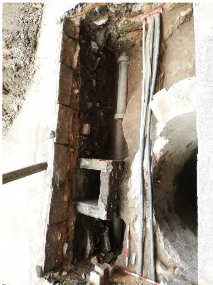
501-F54: Zdi Z048, Z049, Z050, Z051, výkopy V073, V074; foceno od východu; fotil Ditmar E.; datum 18.6.2020
