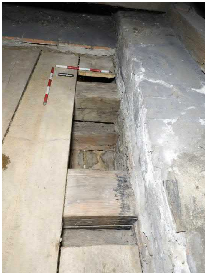
1401-F06: Stropní a podlahové trámy v sondě 1401; foceno od východu; fotil Ditmar E.; datum 11.5.2020
