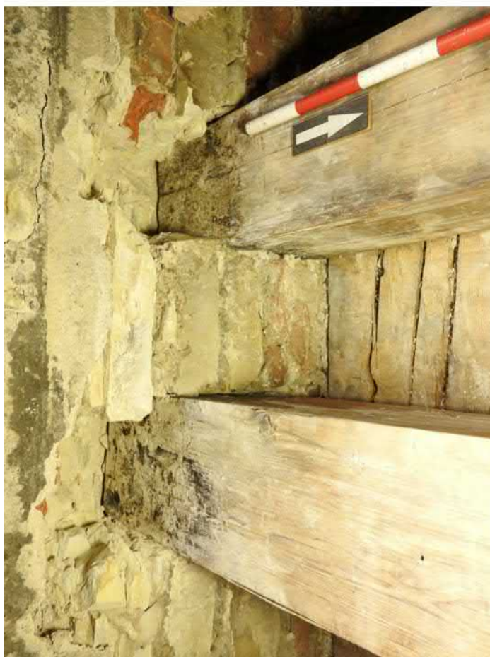
1404-F04: Stropní a podlahové trámy v sondě 1404; foceno od severu; fotil Ditmar E.; datum 26.5.2020
