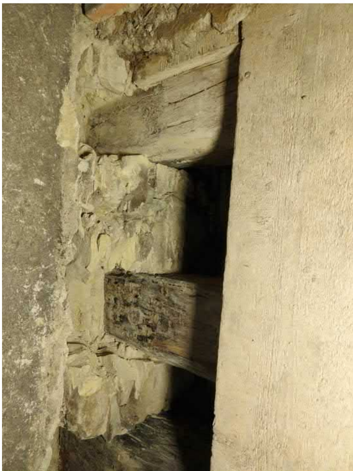
1402-F09: Stropní a podlahové trámy v sondě 1402; foceno od jihu; fotil Ditmar E.; datum 20.5.2020
