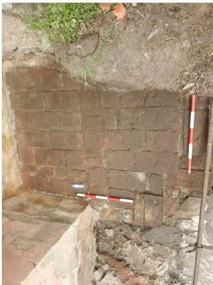
701-F16: Koruna zdi Z05; foceno od jihu; fotil Ditmar E.; datum 29.4.2020
