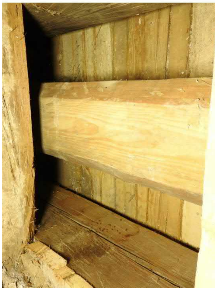
1405-F04: Stropní a podlahové trámy v sondě 1405; foceno od jihu; fotil Ditmar E.; datum 25.5.2020
