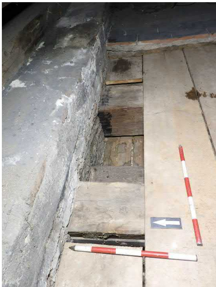
1401-F05: Stropní a podlahové trámy v sondě 1401; foceno od západu; fotil Ditmar E.; datum 11.5.2020
