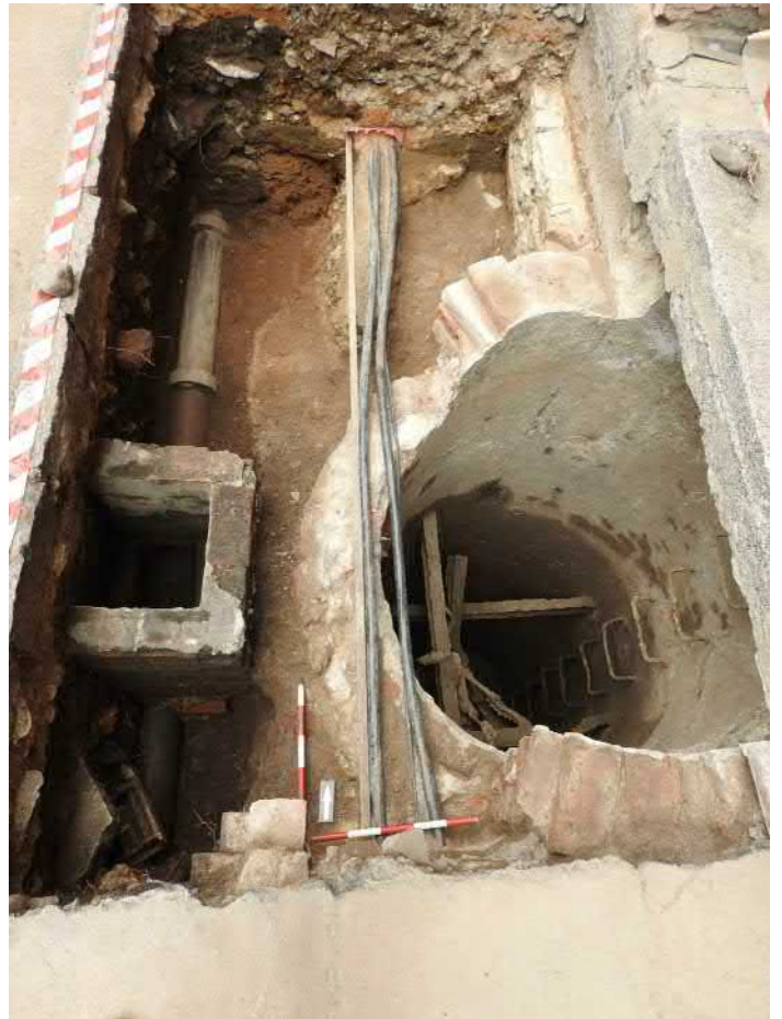
501-F58: Zdi Z048, Z049, Z050, Z051, výkopy V073, V074; foceno od jihu; fotil Ditmar E.; datum 18.6.2020
