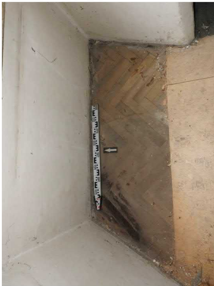
1203-F02: Sonda po odstranění dřevotřísky vr. 1203-01; foceno od jihu; fotil Ditmar E.; datum 11.5.2020
