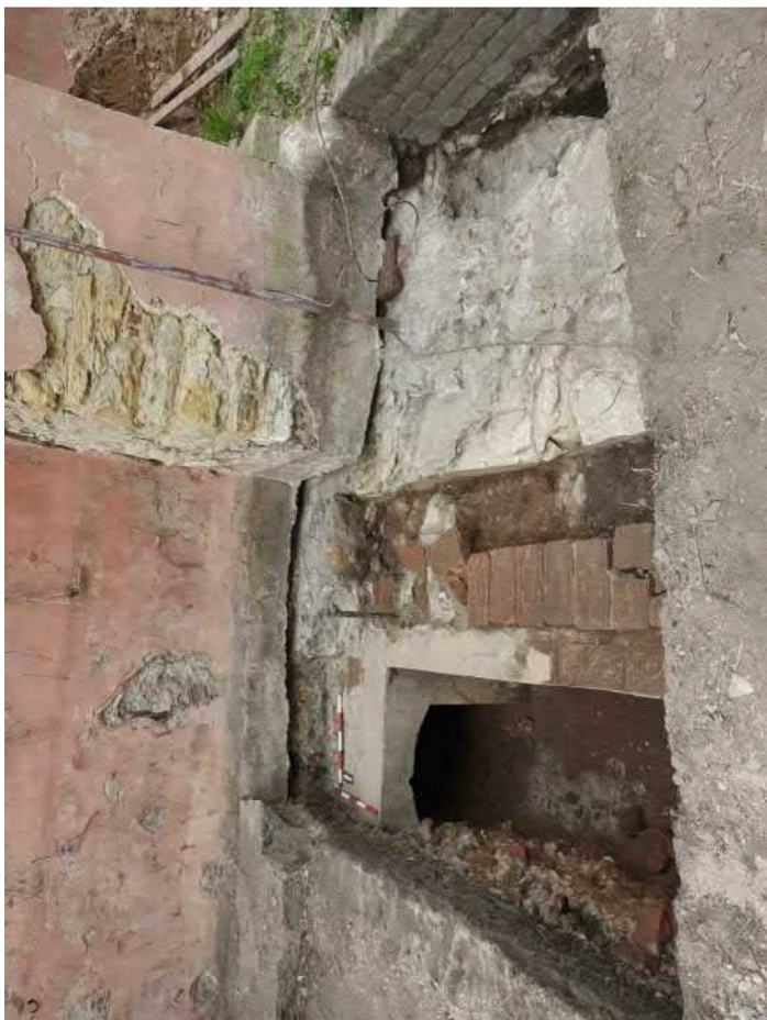
703-F09: Zdi Z001c, Z003d, Z018; foceno od západu; fotil Ditmar E.; datum 30.4.2020
