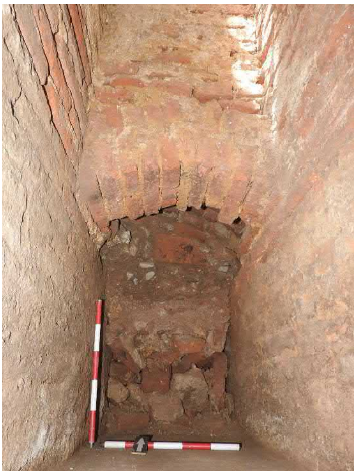
4101-F07: Kanál zdi Z18; foceno od jihu; fotil Ditmar E.; datum 29.5.2020
