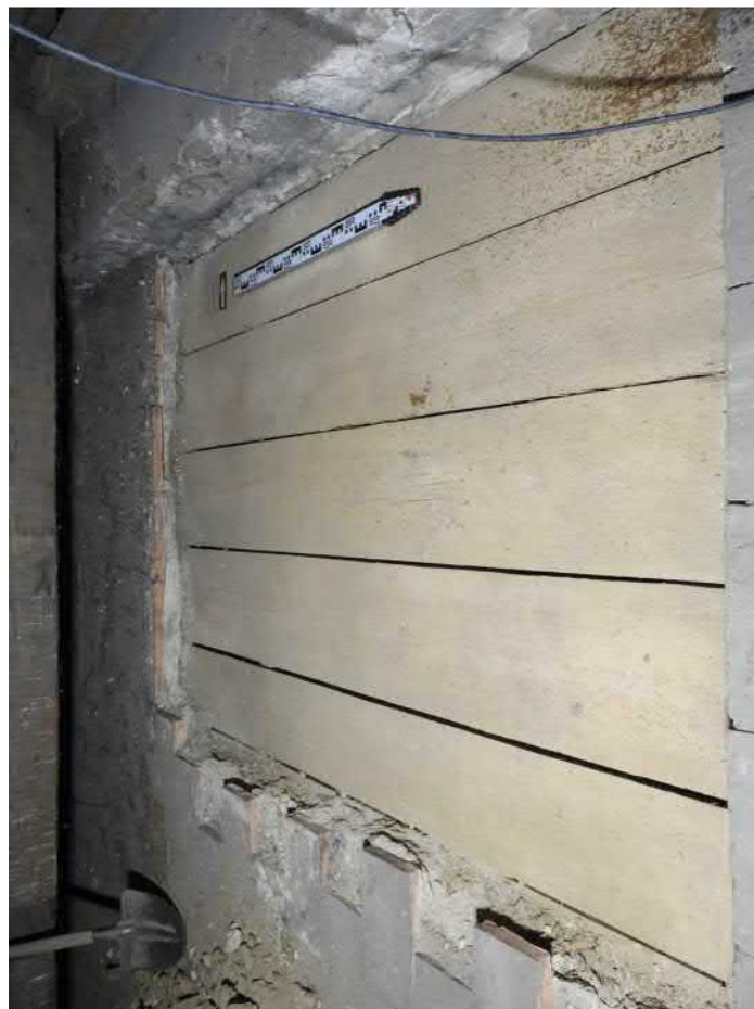
1401-F02: Sonda 1401 po odstranění cihlové dlažby; foceno od východu; fotil Ditmar E.; datum 11.5.2020
