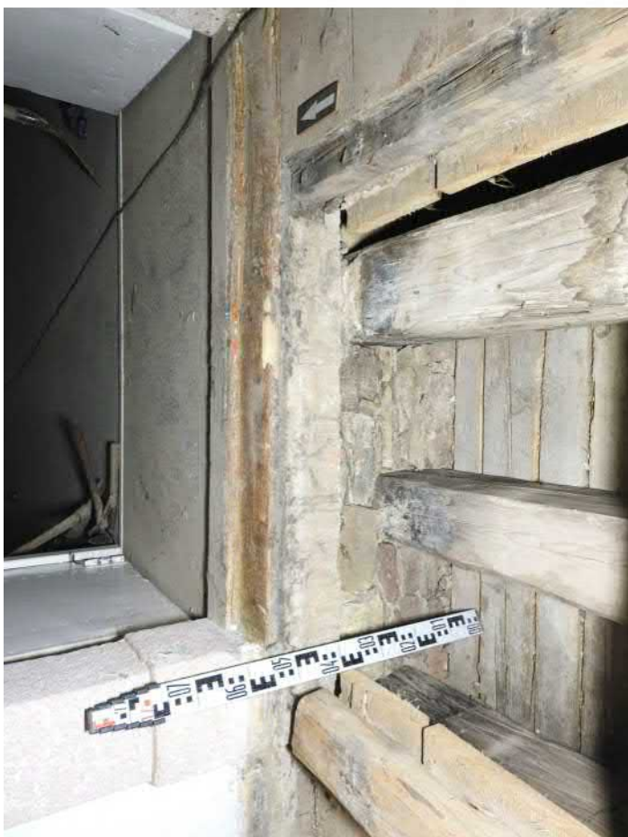
1302-F05: Stropní a podlahové trámy v sondě 1302; foceno od jihu; fotil Ditmar E.; datum 11.5.2020
