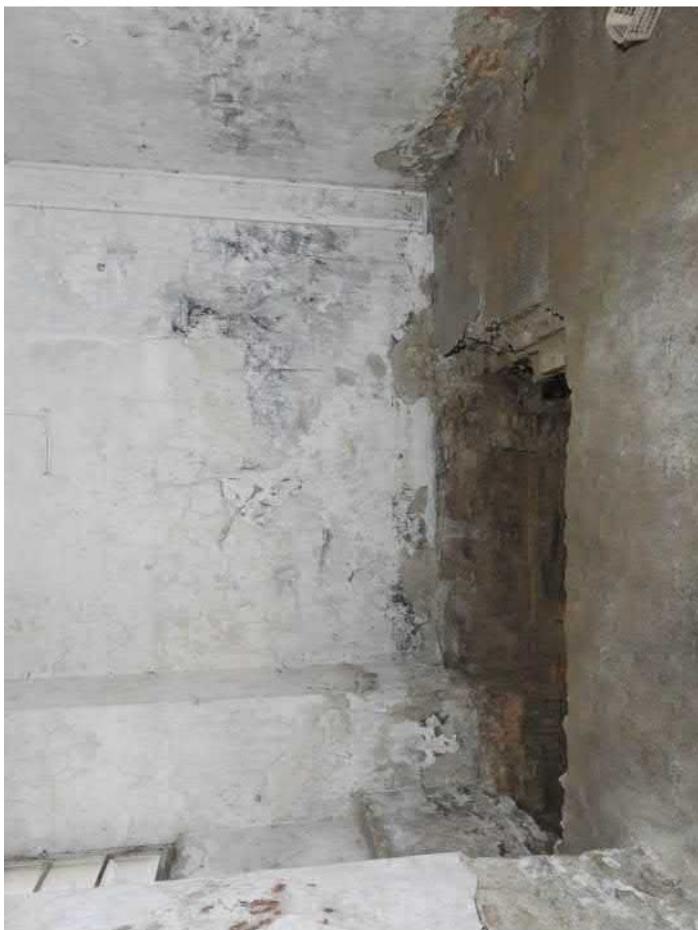
4102-F01: Situace sondy 4102; foceno od východu; fotil Ditmar E.; datum 11.6.2020
