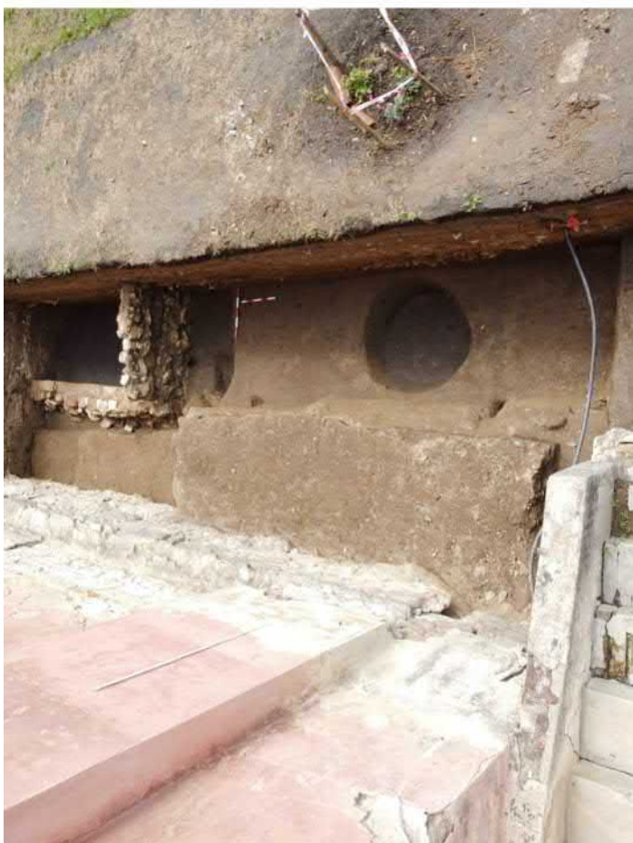
721-F11: Zdi Z035b, Z041, Z043, výkopy V002 = V054, V075, V080, V081; foceno od západu; fotil Kalíšek M.; datum 15.6.2020
