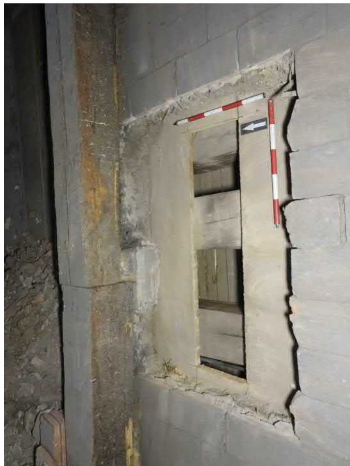
1408-F02: Stropní a podlahové trámy v sondě 1408; foceno od severu; fotil Ditmar E.; datum 18.6.2020
