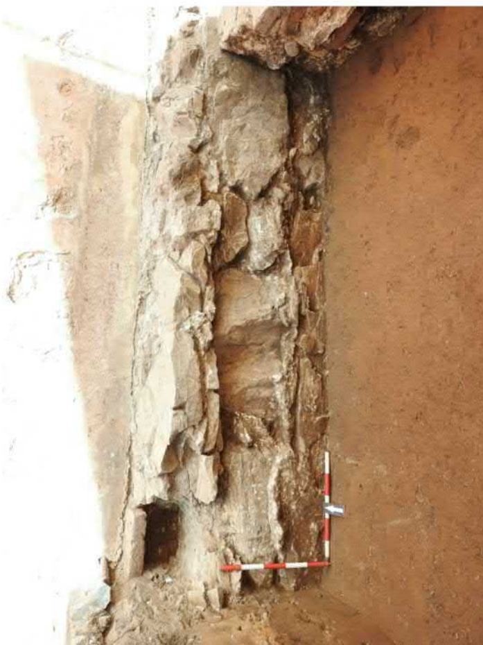
708-F19: Severní stěna sondy se zdí Z001c; foceno od jihu; fotil Ditmar E.; datum 8.5.2020
