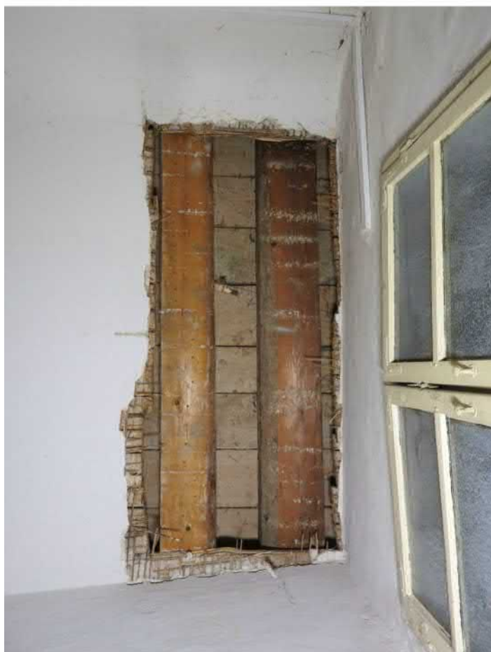
1308-F03: Stropní a podlahové trámy v sondě 1308; foceno od severu; fotil Ditmar E.; datum 21.5.2020
