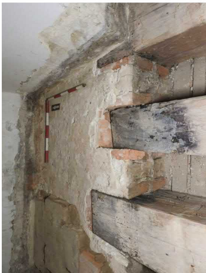
1301-F11: Stropní a podlahové trámy v sondě 1301; foceno od jihu; fotil Ditmar E.; datum 11.5.2020
