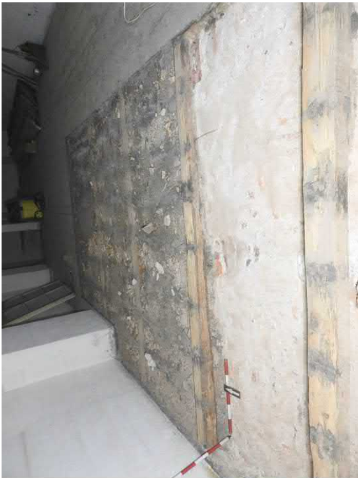
3301-F09: Zdiva v sondě 3301; foceno od jihu; fotil Ditmar E.; datum 25.5.2020
