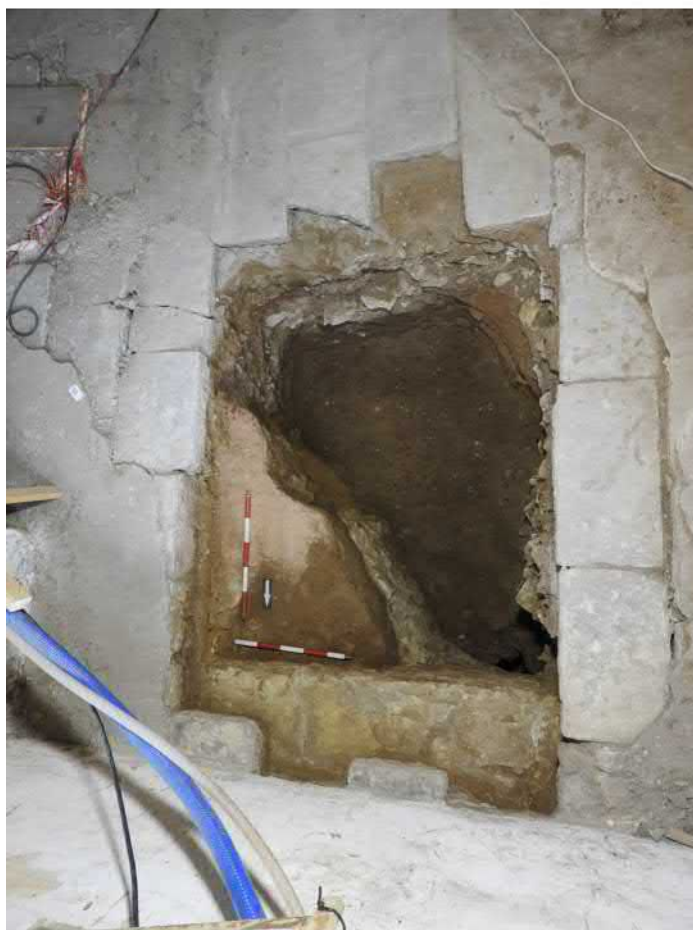
3102-F06: Zdi Z031, Z032, výkop V049; foceno od západu; fotil Ditmar E.; datum 28.5.2020
