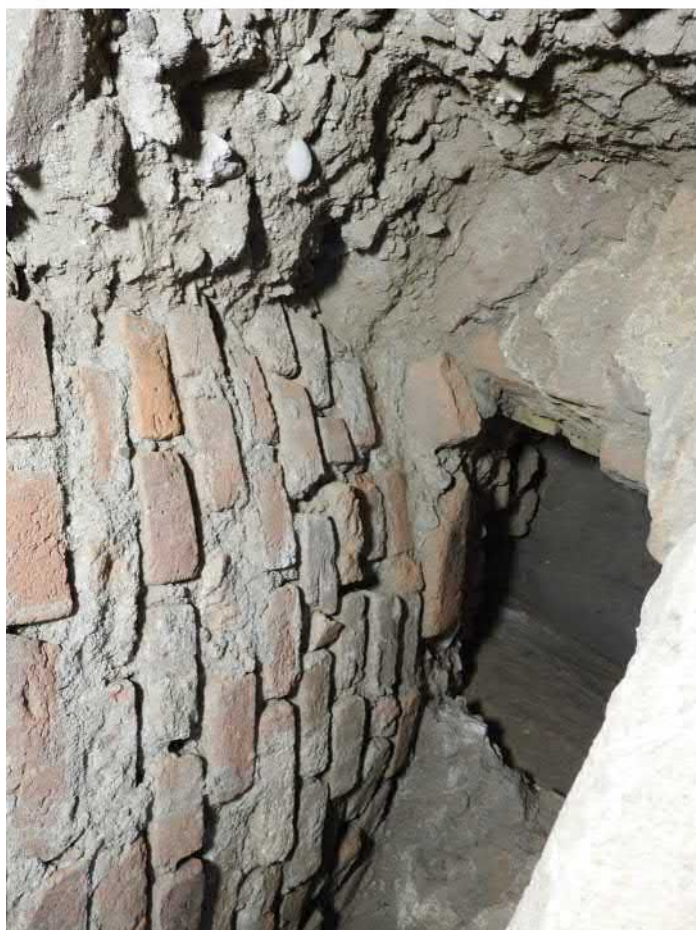
4101-F18: Zdi Z018, Z033; foceno od jihu; fotil Ditmar E.; datum 29.5.2020
