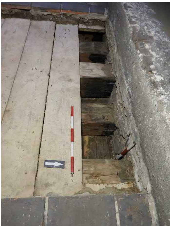
1402-F05: Stropní a podlahové trámy v sondě 1402; foceno od východu; fotil Ditmar E.; datum 14.5.2020
