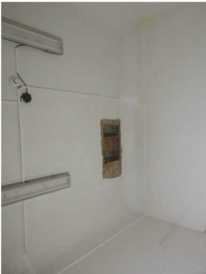
1310-F01: Stropní a podlahové trámy v sondě 1310; foceno od severu; fotil Ditmar E.; datum 8.6.2020
