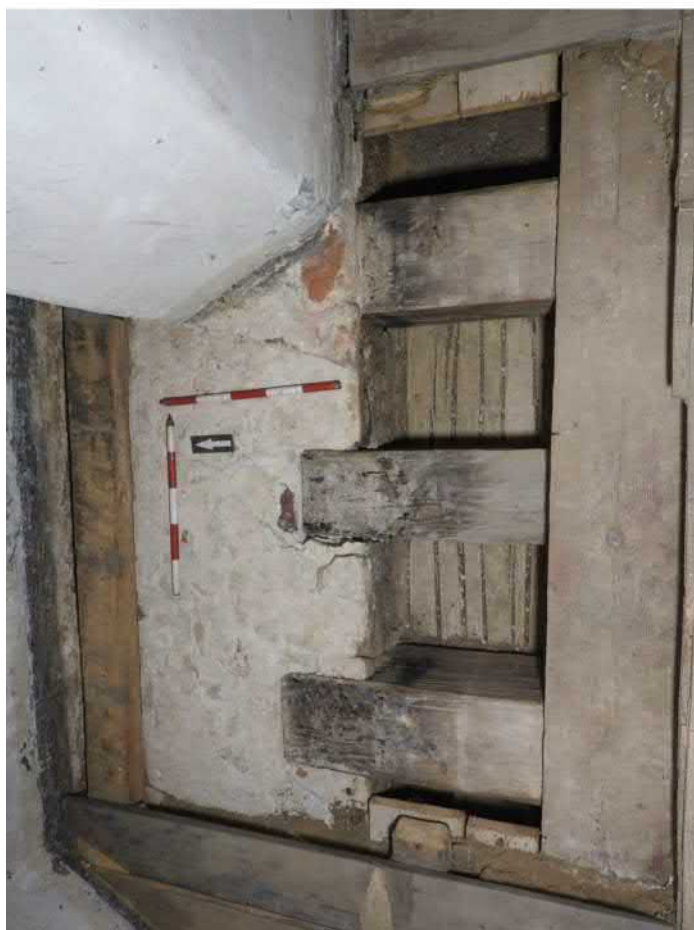
1303-F08: Stropní a podlahové trámy v sondě 1303; foceno od jihu; fotil Ditmar E.; datum 20.5.2020
