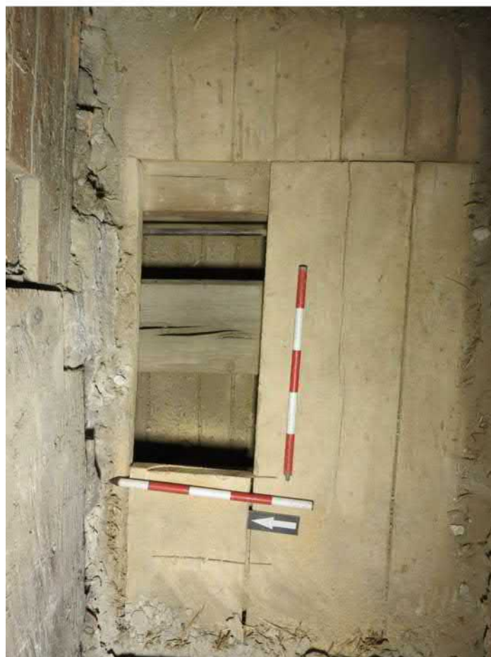
1407-F04: Stropní a podlahové trámy v sondě 1407; foceno od severu; fotil Ditmar E.; datum 18.6.2020
