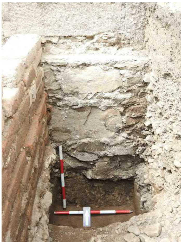
717-F28: Základ zdi Z026; foceno od jihu; fotil Ditmar E.; datum 21.5.2020
