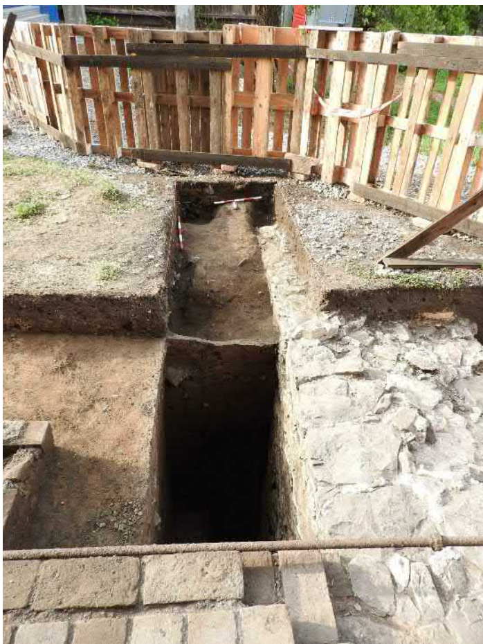
712-F01: Zeď Z003a, výkopy V024, V025; foceno od severu; fotil Ditmar E.; datum 8.5.2020
