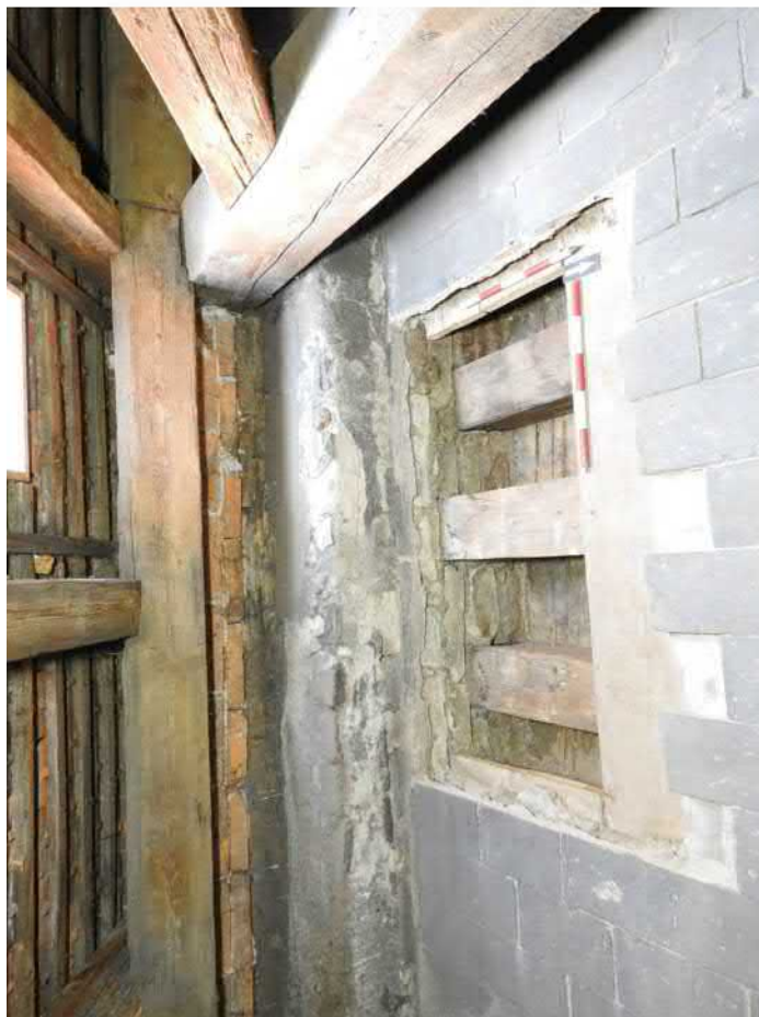
1404-F02: Stropní a podlahové trámy v sondě 1404; foceno od severu; fotil Ditmar E.; datum 26.5.2020
