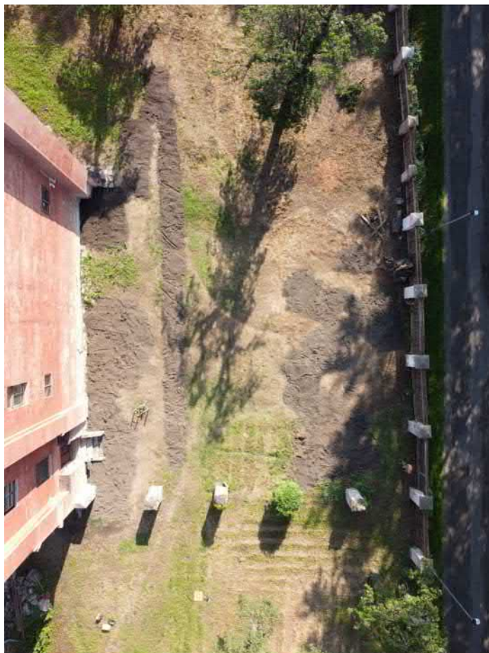
Celek-F078: Sondy při jihovýchodním rohu Invalidovny po zasypání; foceno od jihu; fotil Kalíšek M.; datum 23.6.2020
