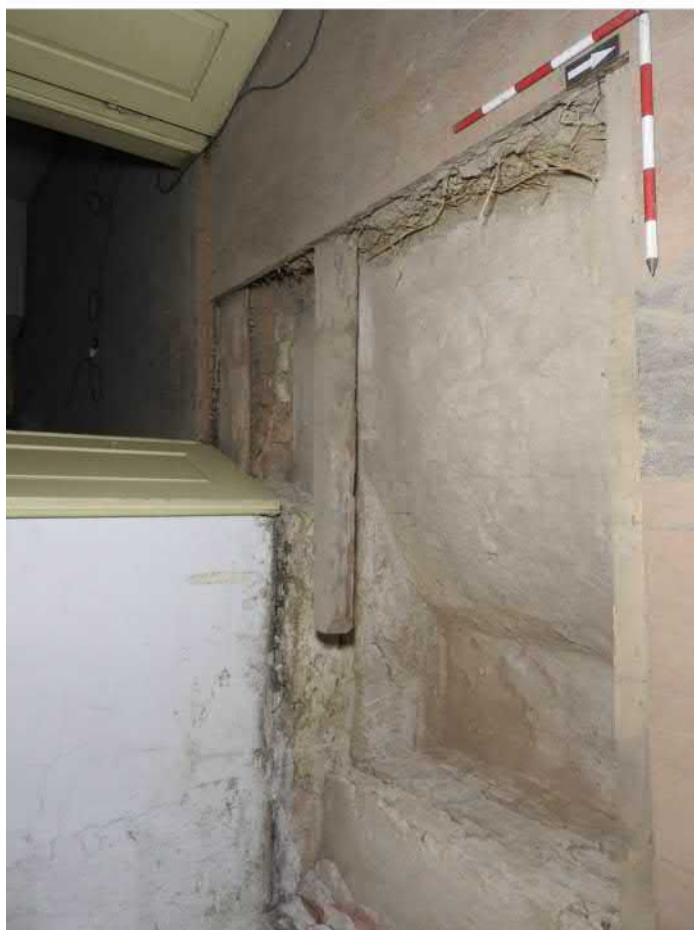
1201-F08: Zdi Z06, Z07, Z08, Z09, Z10; foceno od severu; fotil Ditmar E.; datum 27.4.2020
