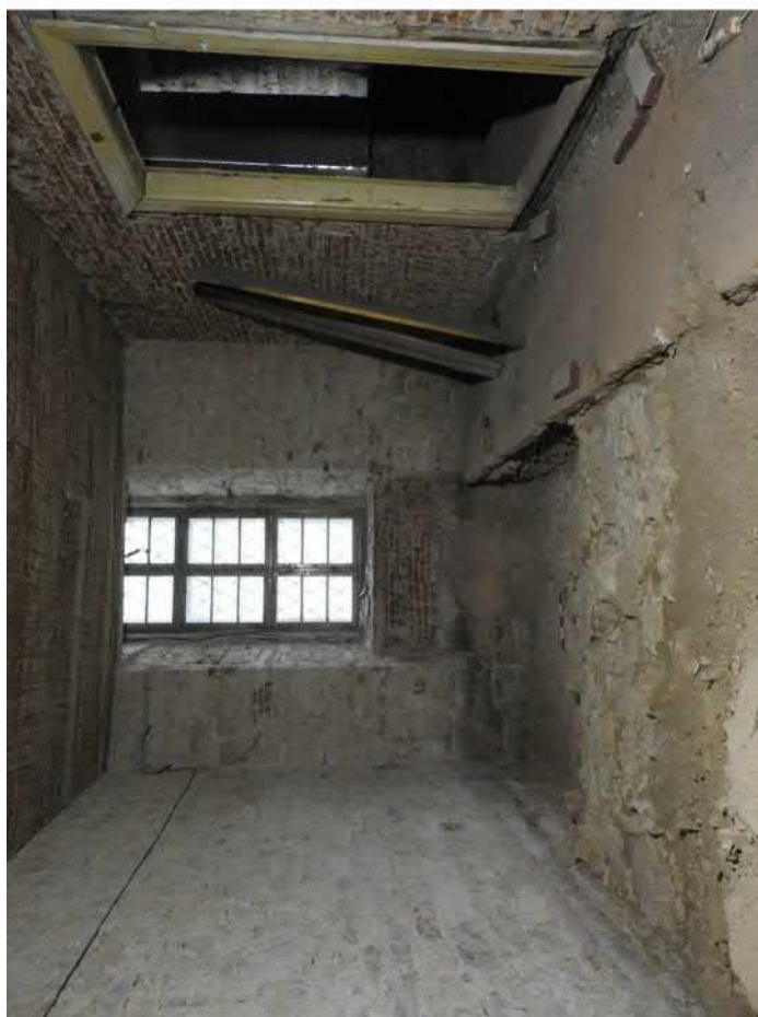
1101-F04: Situace sondy 1101; foceno od jihu; fotil Ditmar E.; datum 30.4.2020
