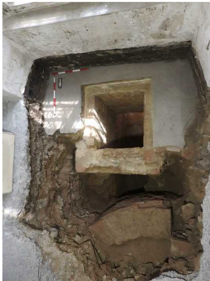
4101-F10: Zdi Z003c, Z018, Z033, Z034; foceno od západu; fotil Ditmar E.; datum 29.5.2020
