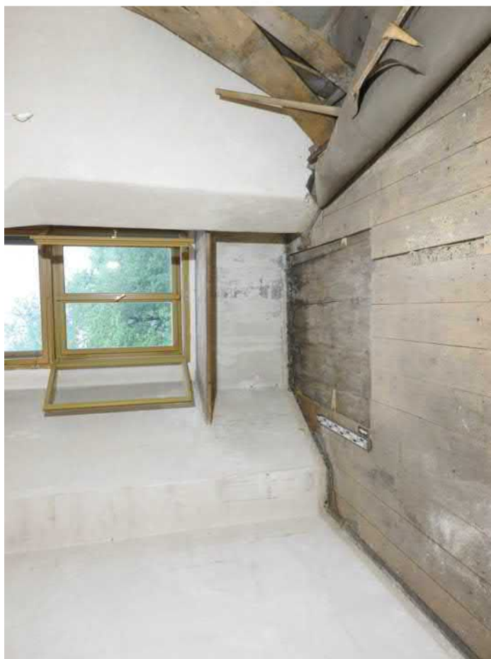
1303-F02: Sonda 1303 po odstranění první vrstvy prkenné podlahy; foceno od jihu; fotil Ditmar E.; datum 11.5.2020
