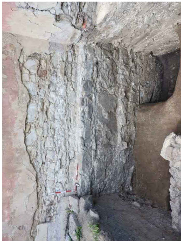
724-F30: Severní stěna sondy - základ Z043; foceno od jihu; fotil Ditmar E.; datum 3.6.2020
