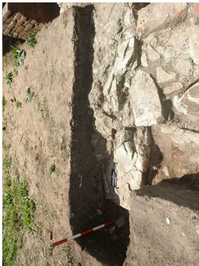
713-F22: Prodloužení sondy 713 k jihu se zakončením základu Z003b; foceno od východu; fotil Ditmar E.; datum 1.6.2020
