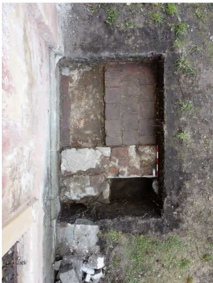
725-F19: Zdi Z063, Z064, Z065, dlažba vr. 725-04; foceno od východu; fotil Kalíšek M.; datum 16.6.2020
