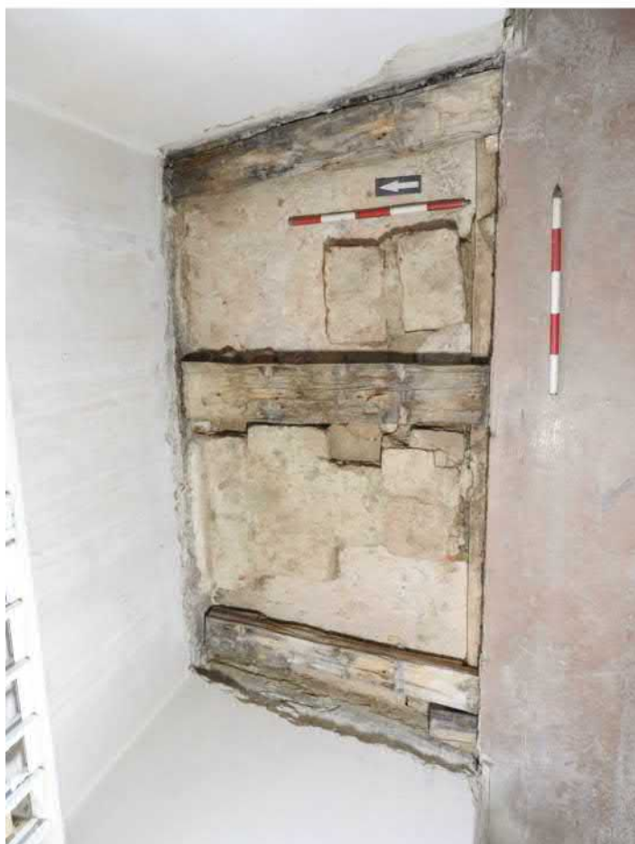
1301-F03: Sonda 1301 po odstranění podlahy; foceno od jihu; fotil Ditmar E.; datum 6.5.2020
