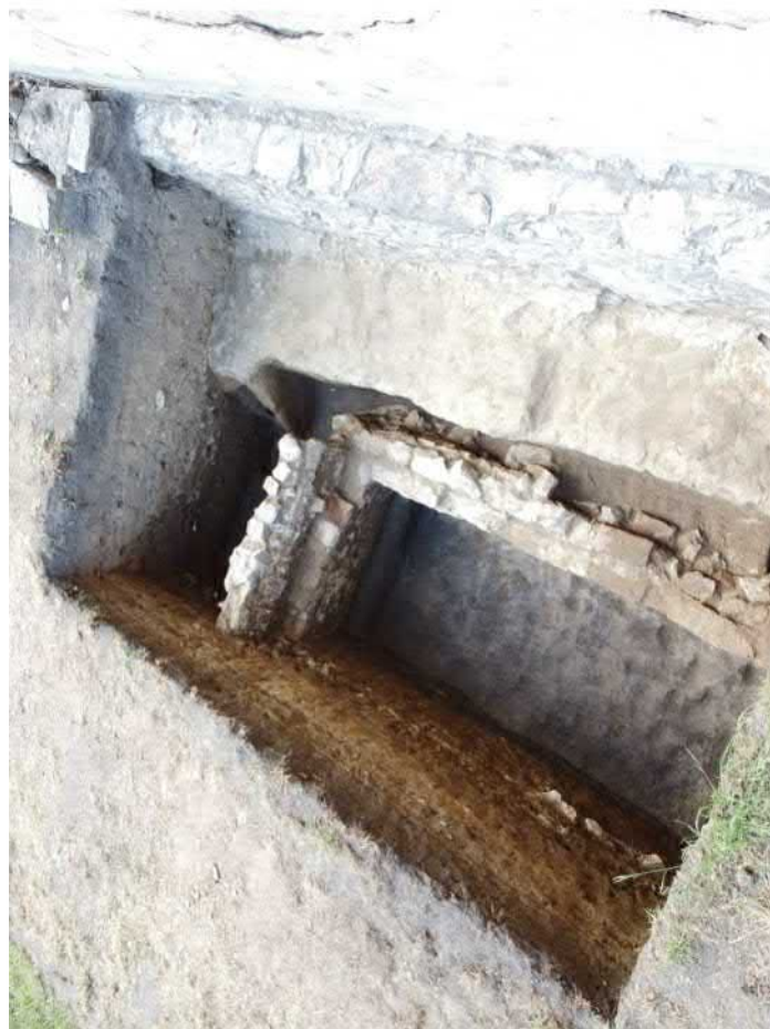
722-F20: Zdi Z42, Z43, Z44, výkopy V002, V055, V081; foceno od severovýchodu; fotil Kalíšek M.; datum 3.6.2020
