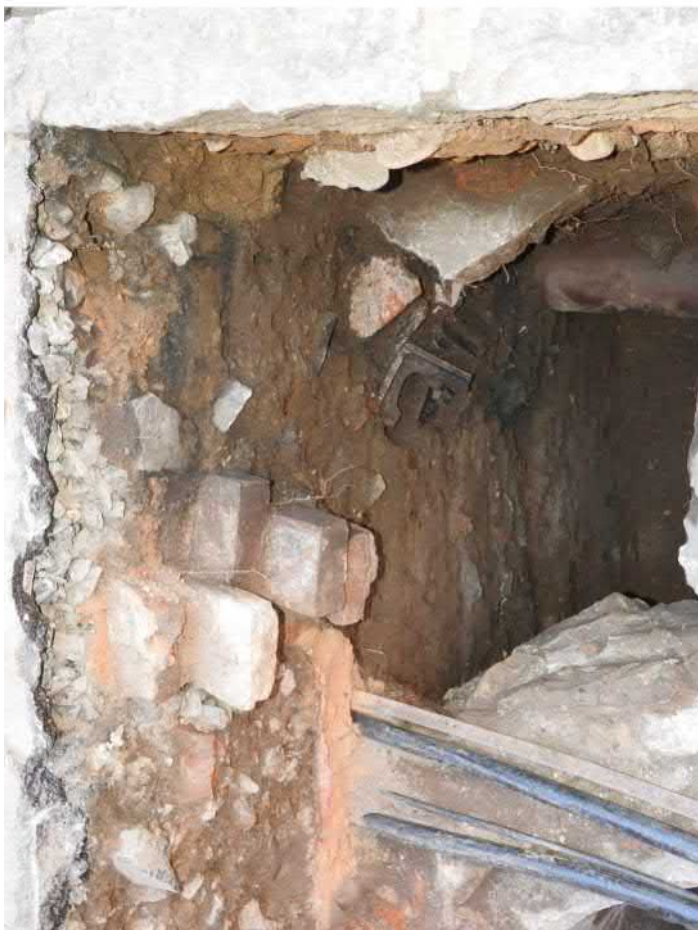
501-F67: Řez 501-RJ; foceno od severu; fotil Ditmar E.; datum 22.6.2020
