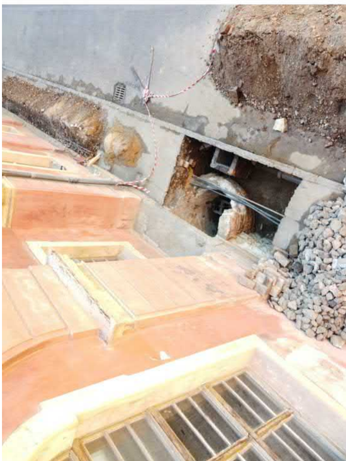
501-F79: Situace sondy 501; foceno od severozápadu; fotil Kalíšek M.; datum 22.6.2020
