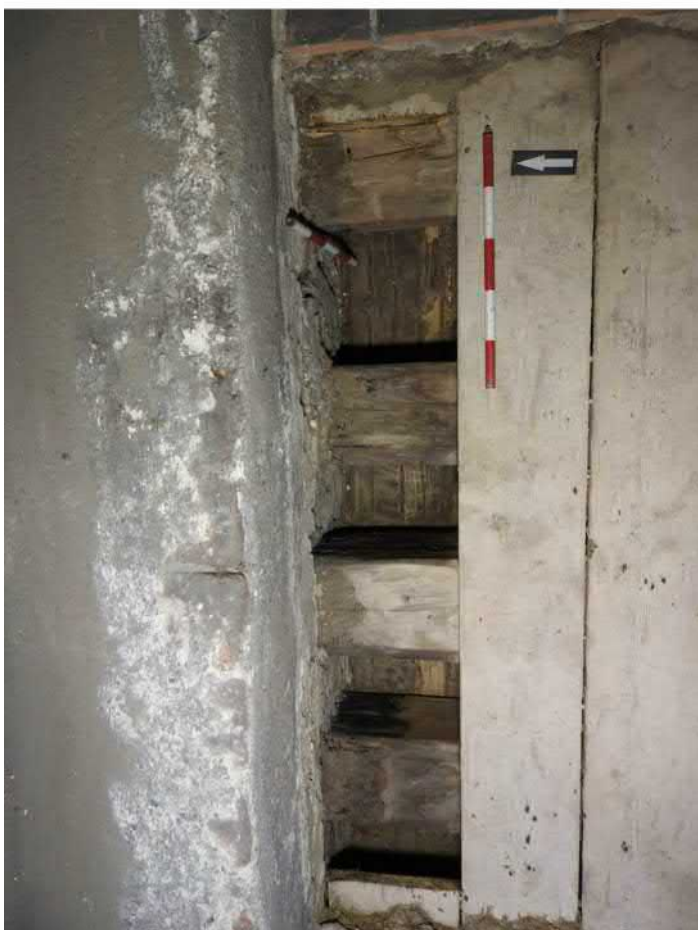
1402-F03: Stropní a podlahové trámy v sondě 1402; foceno od jihu; fotil Ditmar E.; datum 14.5.2020
