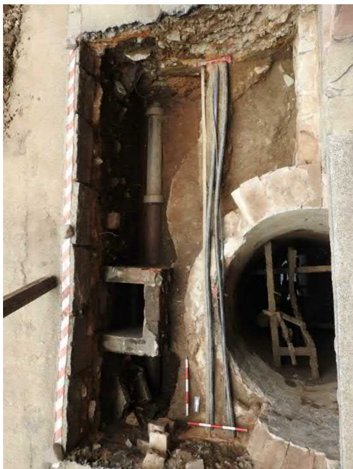
501-F53: Zdi Z048, Z049, Z050, Z051, výkopy V073, V074; foceno od východu; fotil Ditmar E.; datum 18.6.2020
