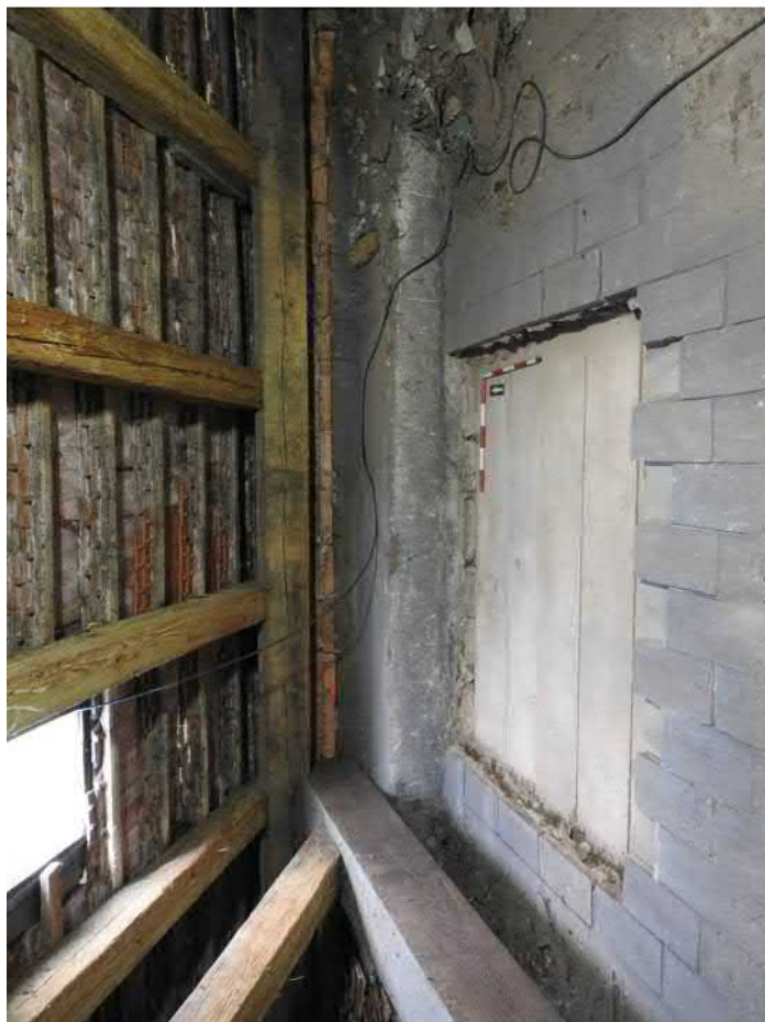
1402-F02: Sonda 1402 po odstranění cihlové dlažby; foceno od jihu; fotil Ditmar E.; datum 14.5.2020
