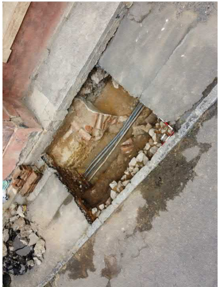
501-F08: Výkop V073, zdi Z048, Z050, kameny ve výkopu V088; foceno od jihozápadu; fotil Kalíšek M.; datum 9.6.2020
