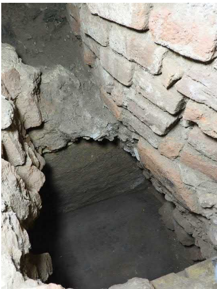
4101-F19: Zdi Z018, Z033; foceno od východu; fotil Ditmar E.; datum 29.5.2020
