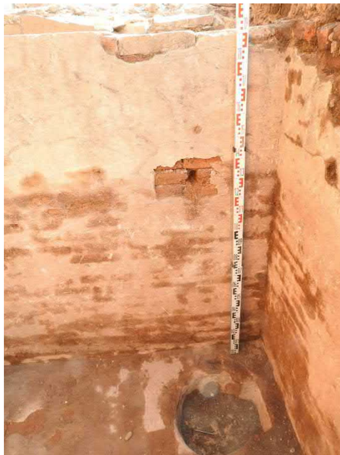
703-F22: Jihovýchodní roh nádrže Z018 s vyzděnou prohlubní a pozůstatky upevnění čerpadla; foceno od západu; fotil Ditmar E.; datum
