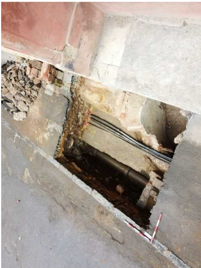
501-F13: Zdi Z048, Z049, Z050, Z051, výkopy V073, V074; foceno od jihovýchodu; fotil Kalíšek M.; datum 10.6.2020
