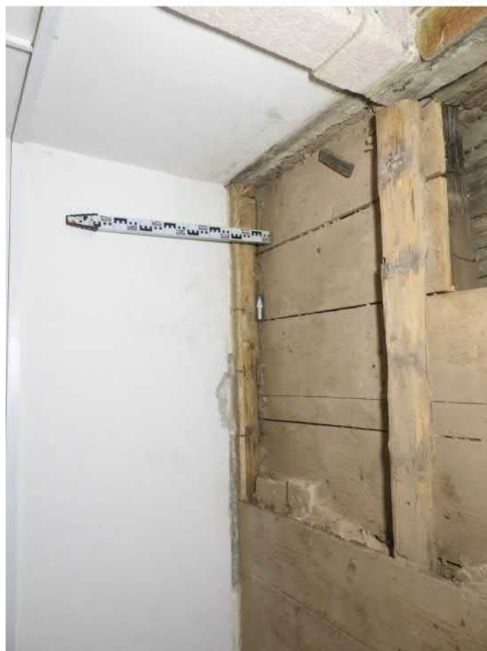
1302-F08: Skladba podlahy v sondě 1302; foceno od východu; fotil Ditmar E.; datum 11.5.2020
