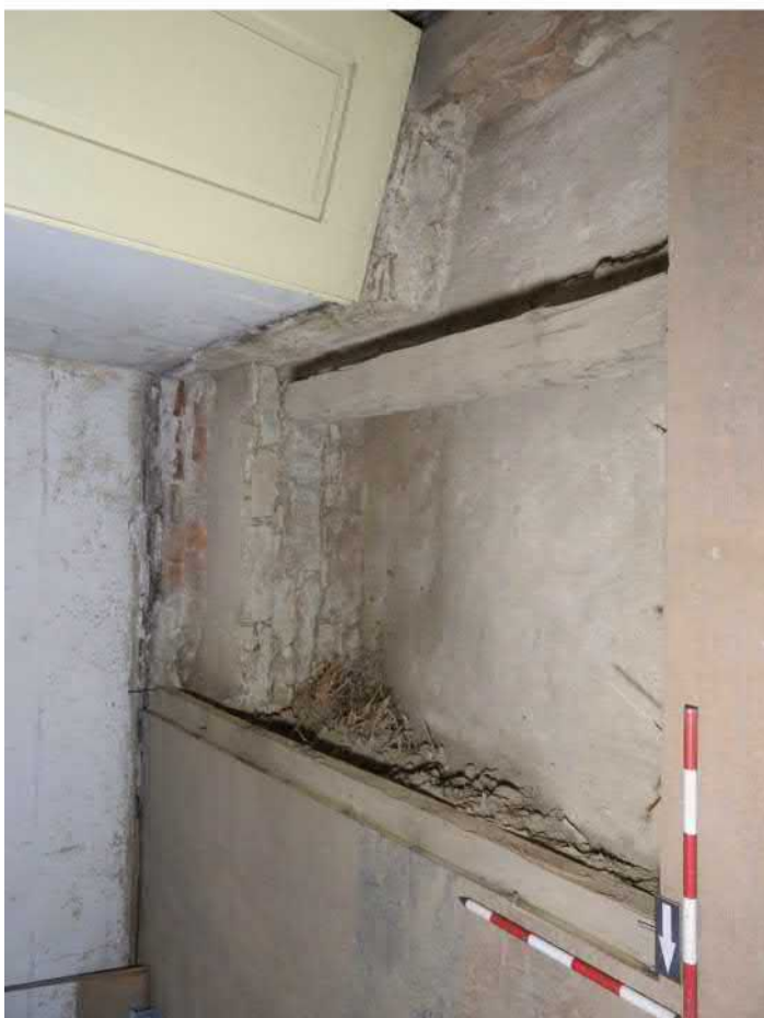
1201-F07: Zdi Z06, Z07, Z08, Z09, Z10; foceno od západu; fotil Ditmar E.; datum 27.4.2020
