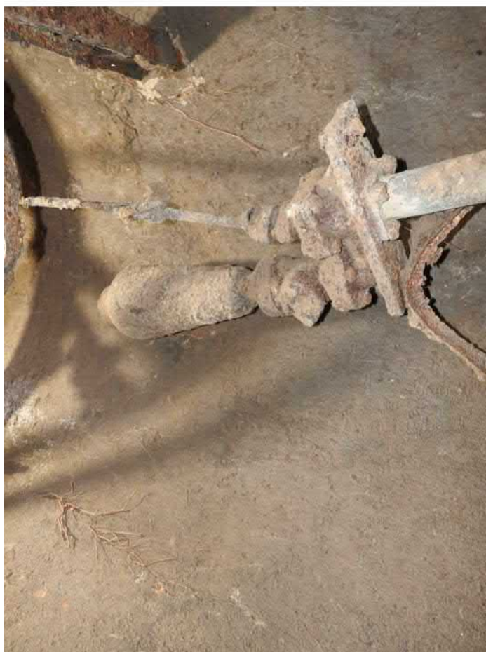
501-F40: Železné konstrukce a součásti čerpadla ve studni Z050; foceno od severovýchodu; fotil Ditmar E.; datum 17.6.2020
