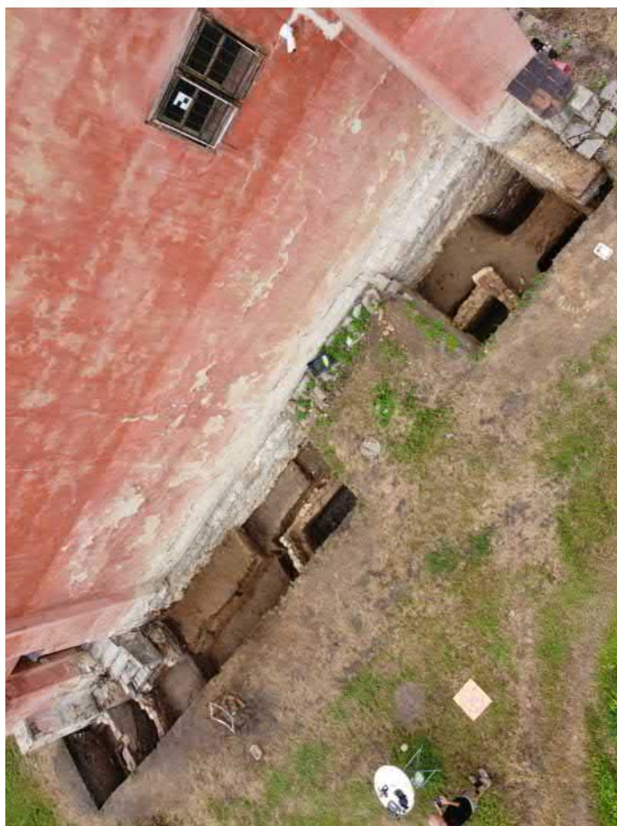
Celek-F050: Sondy při jihovýchodním rohu Invalidovny; foceno od jihovýchodu; fotil Kalíšek M.; datum 10.6.2020
