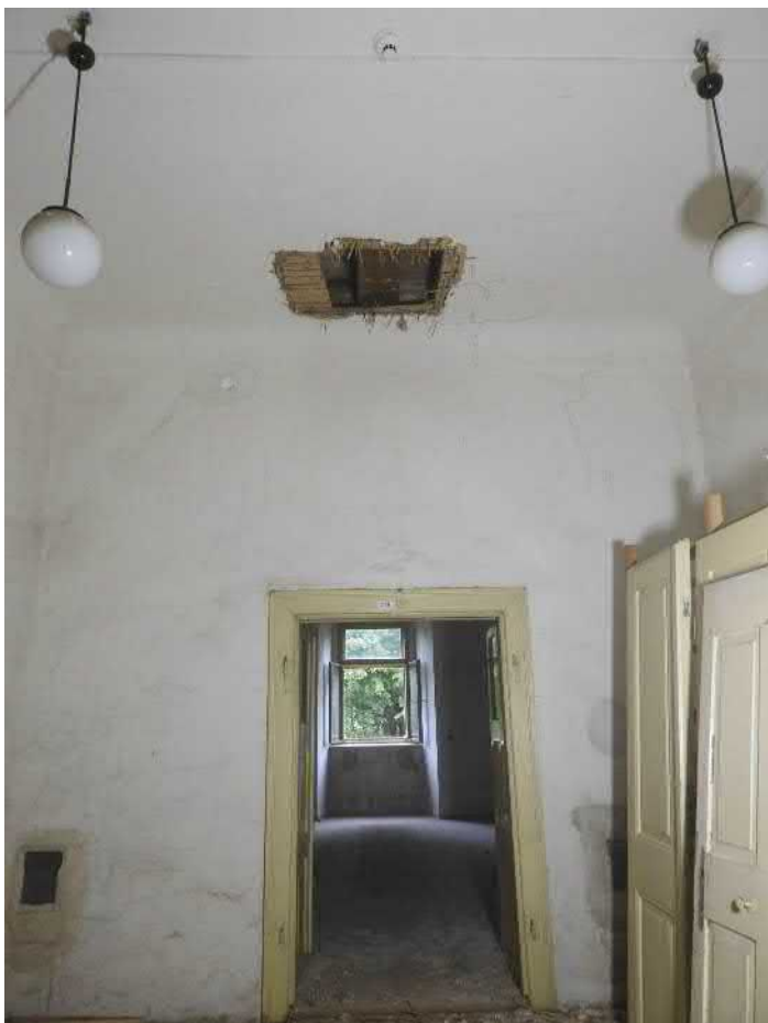
1309-F01: Situace sondy 1309; foceno od jihu; fotil Ditmar E.; datum 8.6.2020
