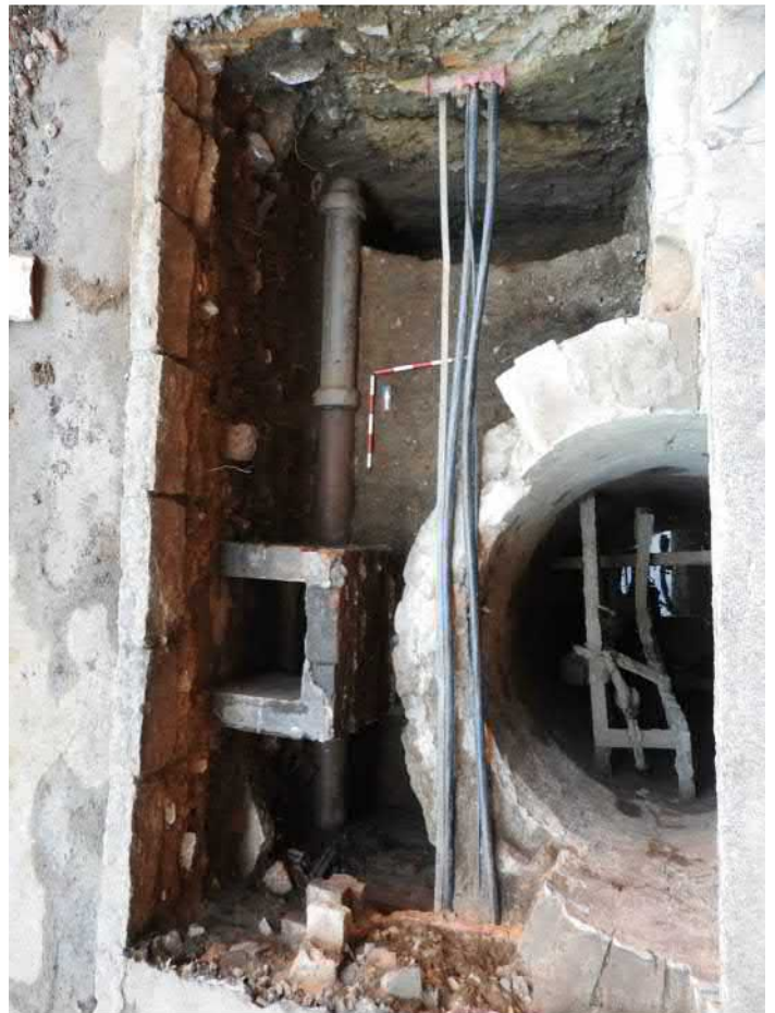
501-F62: Zdi Z048, Z049, Z050, Z051, výkopy V073, V074; foceno od východu; fotil Ditmar E.; datum 22.6.2020
