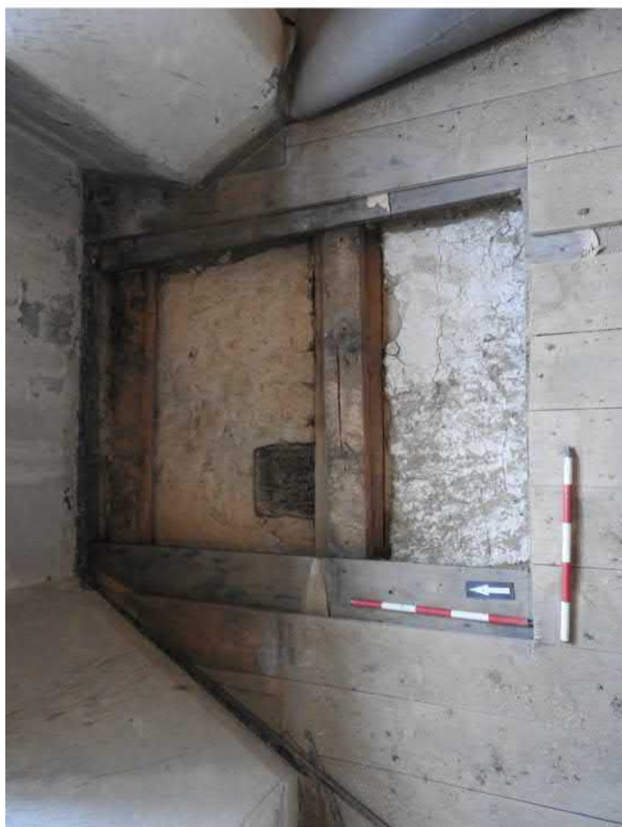
1303-F03: Sonda 1303 po odstranění druhé vrstvy prkenné podlahy; foceno od jihu; fotil Ditmar E.; datum 14.5.2020
