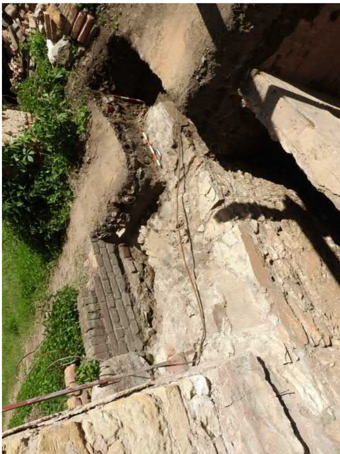
703-F37: Prodloužení sondy směrem k jihu se zakončením základu zdi Z003d; foceno od severozápadu; fotil Ditmar E.; datum 1.6.2020
