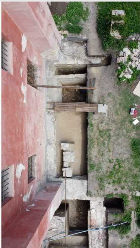
Celek-F041: Sondy při jihozápadním rohu Invalidovny; foceno od jihu; fotil Kalíšek M.; datum 1.6.2020
