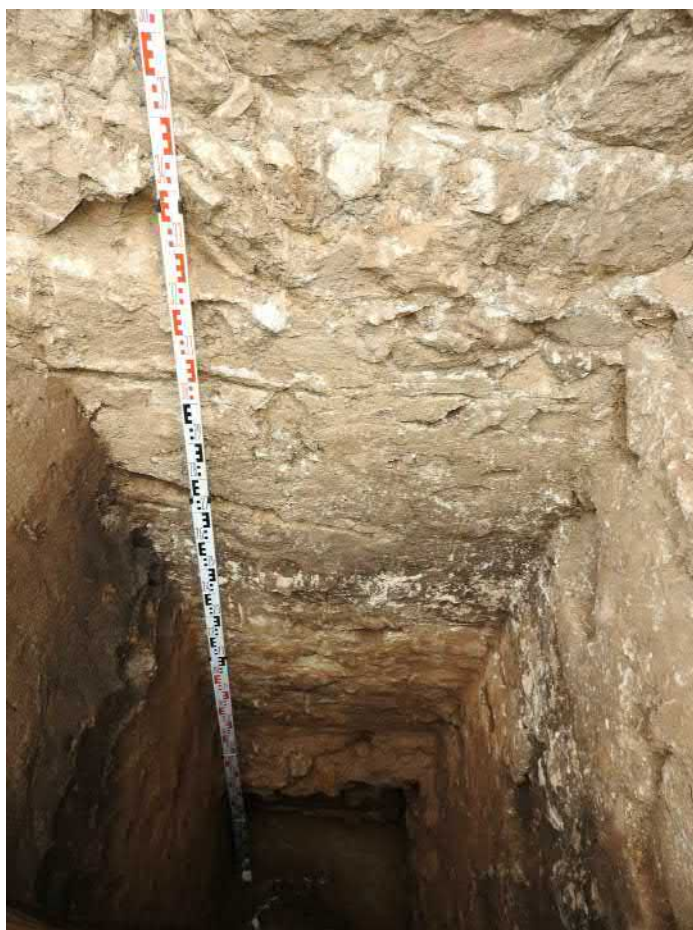
724-F36: Sonda dokopaná na základovou spáru zdí Z35c a Z043; foceno od jihu; fotil Ditmar E.; datum 8.6.2020
