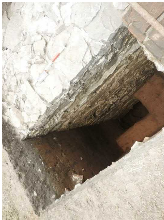
701-F26: Sonda prohloubená na základovou spáru zdi Z003a; foceno od severovýchodu; fotil Ditmar E.; datum 1.5.2020
