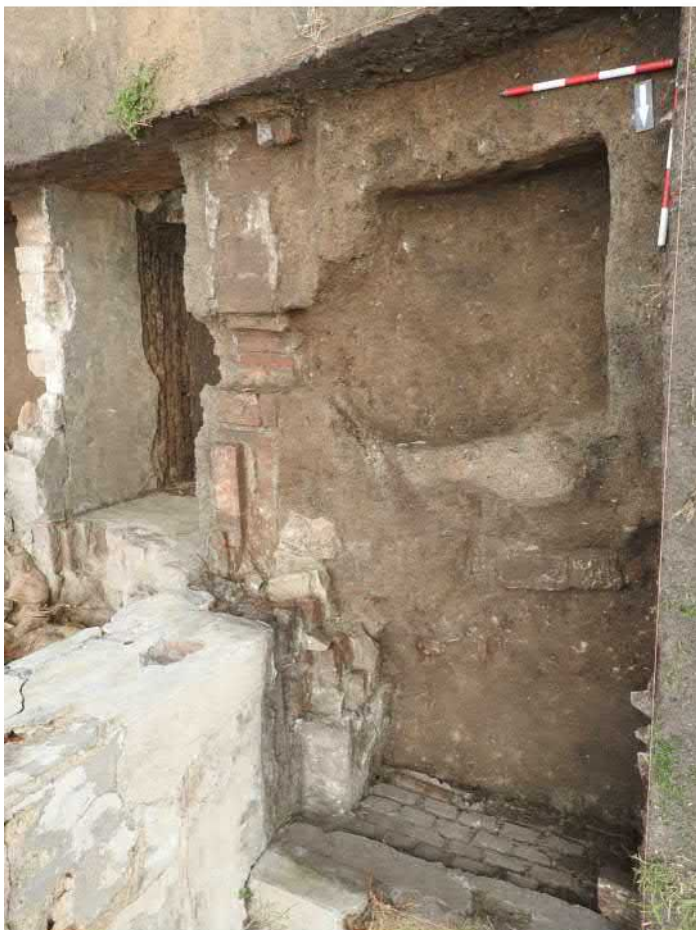
715-F01: Sonda 715 po prvním začišťení - zdi Z036, Z037, Z045; foceno od západu; fotil Ditmar E.; datum 2.6.2020
