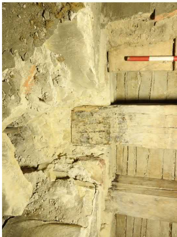
1406-F08: Stropní a podlahové trámy v sondě 1406; foceno od východu; fofil Ditmar E.; datum 26.5.2020
