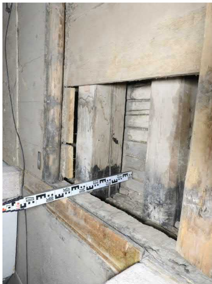
1302-F06: Stropní a podlahové trámy v sondě 1302; foceno od západu; fotil Ditmar E.; datum 11.5.2020
