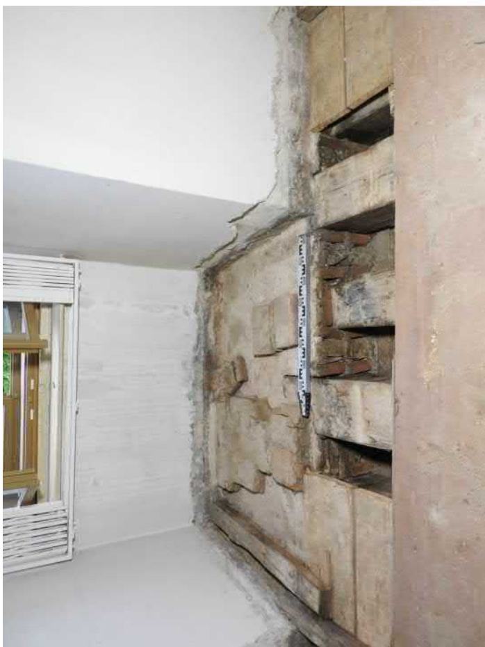
1301-F05: Stropní a podlahové trámy v sondě 1301; foceno od jihu; fotil Ditmar E.; datum 11.5.2020
