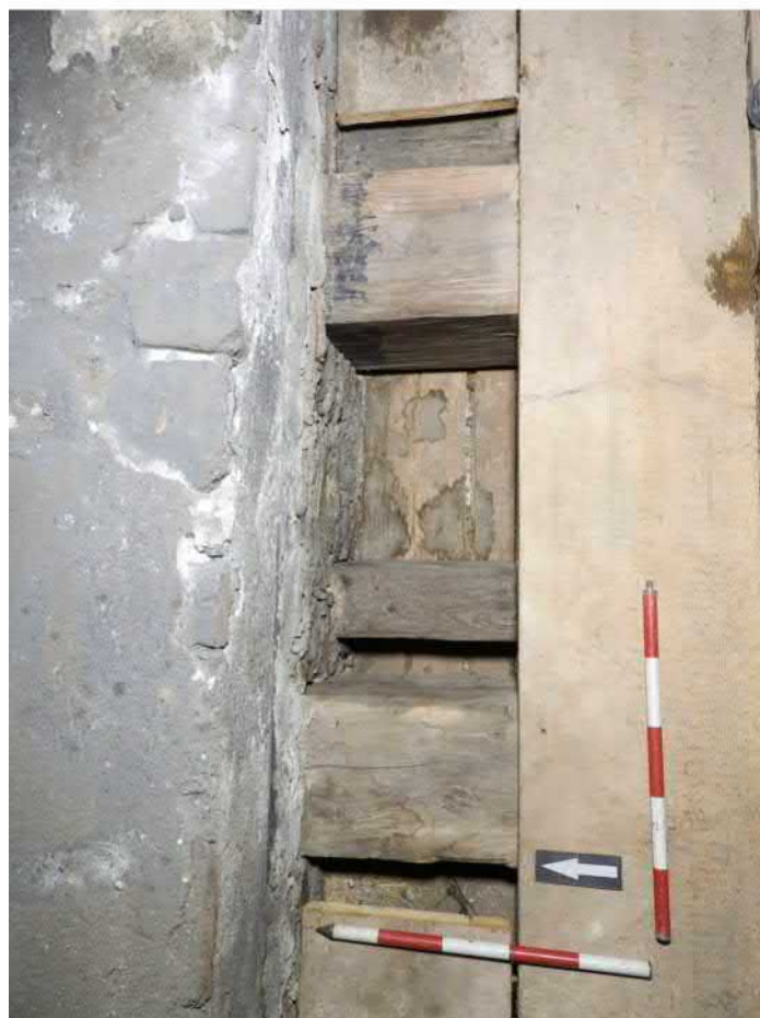
1401-F04: Stropní a podlahové trámy v sondě 1401; foceno od jihu; fotil Ditmar E.; datum 11.5.2020
