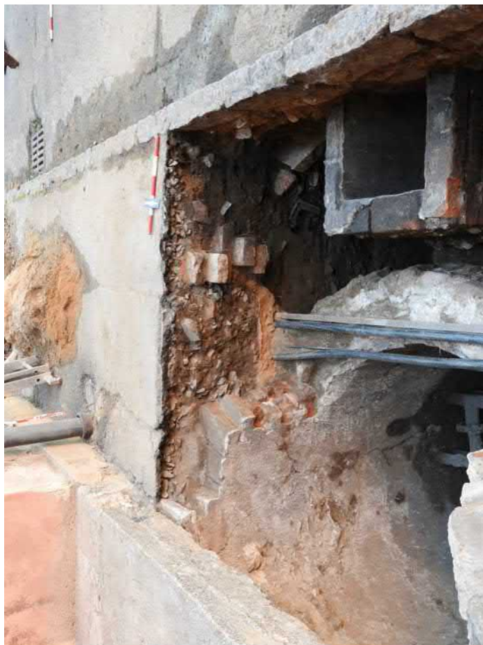
501-F66: Řez 501-RJ; foceno od severu; fotil Ditmar E.; datum 22.6.2020
