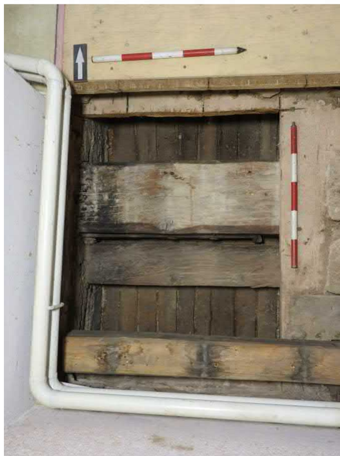
1305-F06: Stropní a podlahové trámy v sondě 1305; foceno od východu; fotil Ditmar E.; datum 20.5.2020
