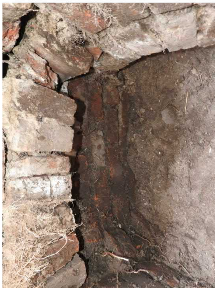
729-F08: Šachta kanalizace Z067; foceno od západu; fotil Ditmar E.; datum 17.6.2020
