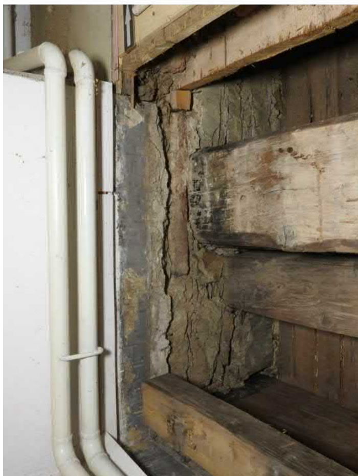
1305-F07: Stropní a podlahové trámy v sondě 1305; foceno od východu; fotil Ditmar E.; datum 20.5.2020
