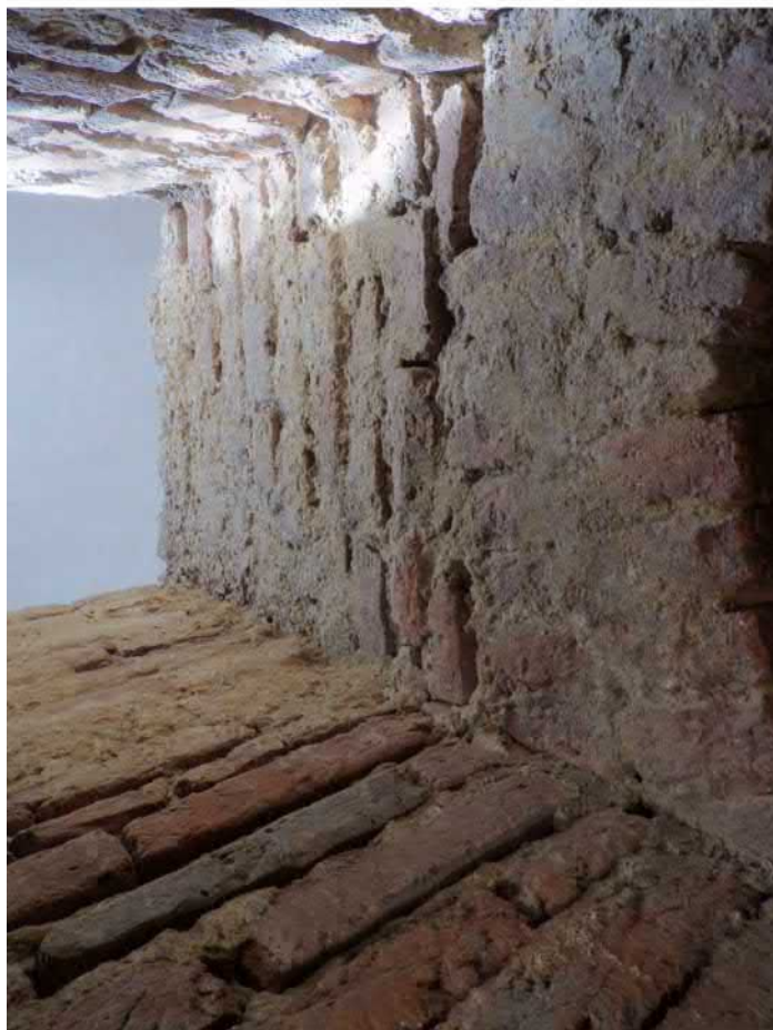
4101-F08: Šachta zdi Z18; foceno od jihu; fotil Ditmar E.; datum 29.5.2020
