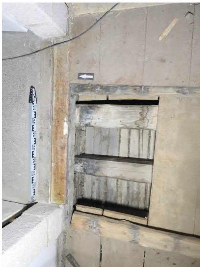
1302-F04: Stropní a podlahové trámy v sondě 1302; foceno od jihu; fotil Ditmar E.; datum 11.5.2020
