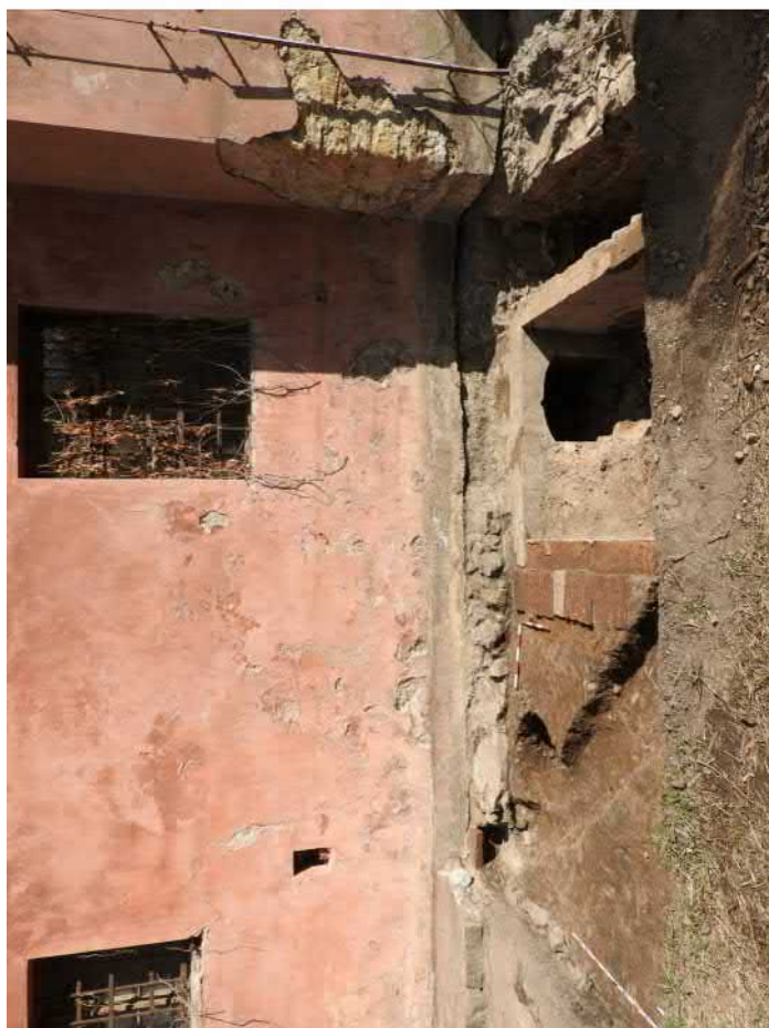
708-F06: Zdi Z001c, Z18, Z21, výkopy V007, V008, V009, V010, dlažba vr. 708-07; foceno od jihu; fotil Ditmar E.; datum 5.5.2020
