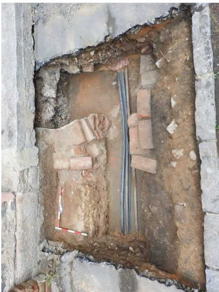
501-F03: Výkop V073, zdi Z048, Z050; foceno od západu; fotil Ditmar E.; datum 8.6.2020
