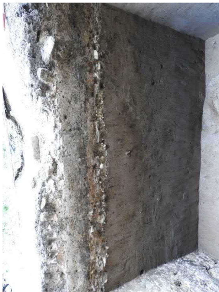
702-F26: Řez 702-RJ; foceno od severu; fotil Ditmar E.; datum 18.5.2020
