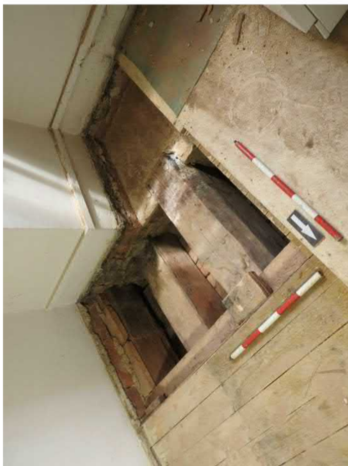
1306-F04: Stropní a podlahové trámy v sondě 1306; foceno od severozápadu; fotil Ditmar E.; datum 20.5.2020
