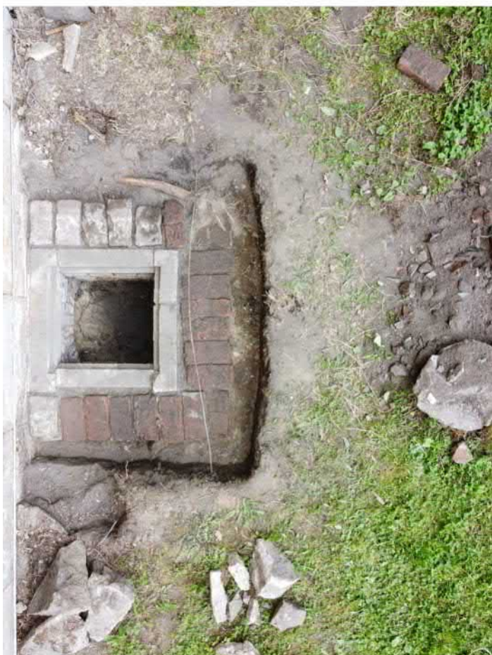
729-F11: Zdi Z067, Z068; foceno od východu; fotil Kalíšek M.; datum 17.6.2020
