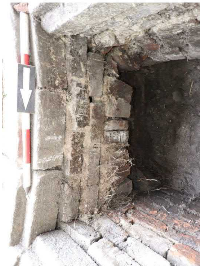
729-F07: Šachta kanalizace Z067; foceno od západu; fotil Ditmar E.; datum 17.6.2020
