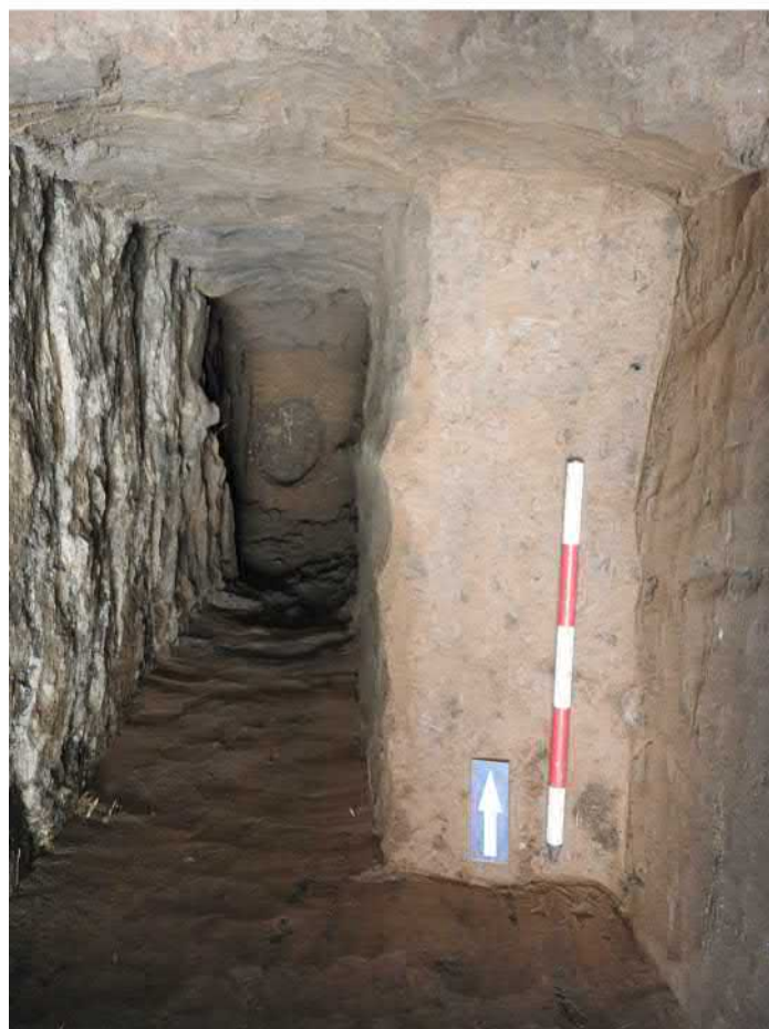
701-F28: Sonda prohloubená na základovou spáru zdi Z003a; foceno od východu; fotil Ditmar E.; datum 1.5.2020
