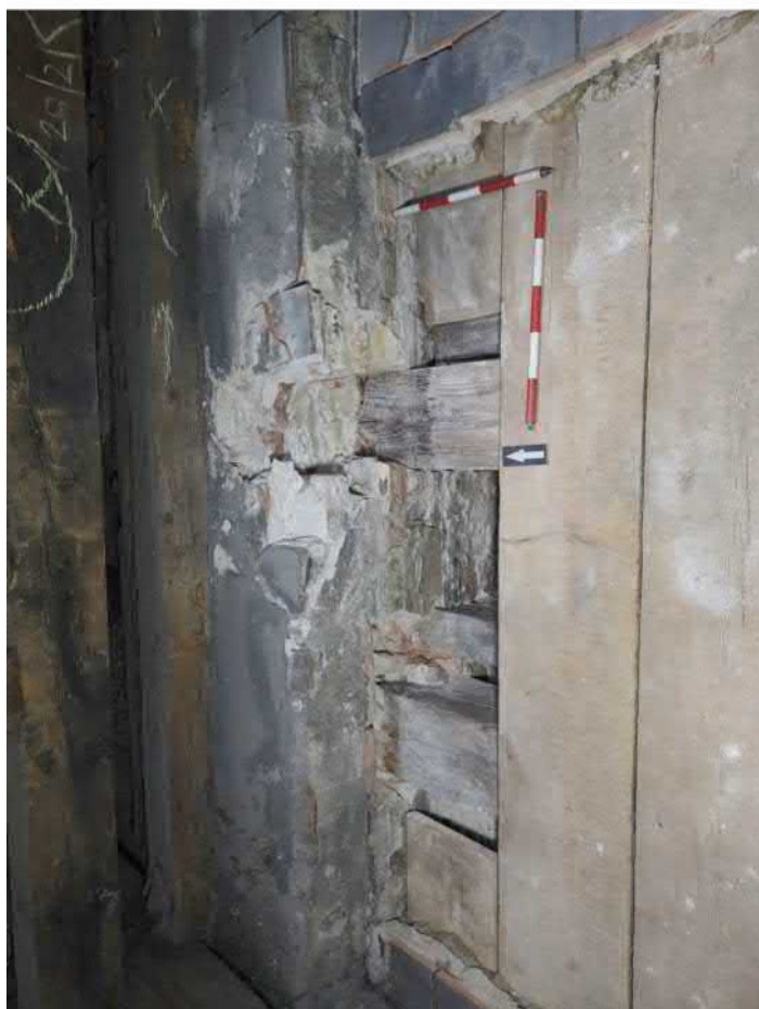
1401-F07: Stropní a podlahové trámy v sondě 1401; foceno od jihu; fotil Ditmar E.; datum 20.5.2020
