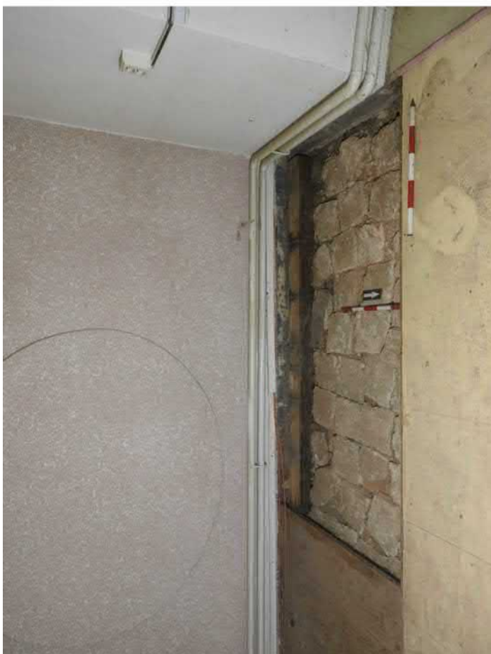
1305-F03: Sonda 1305 po odstranění zásypu pod podlahou; foceno od severu; fotil Ditmar E.; datum 20.5.2020
