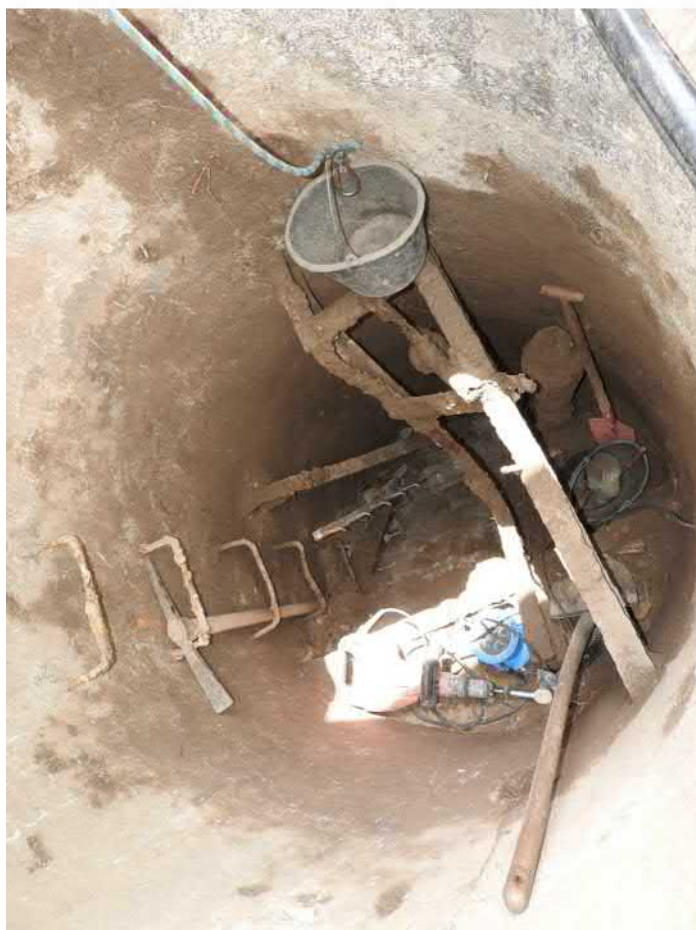
501-F26: Železné konstrukce a součásti čerpadla ve studni Z050; foceno od severozápadu; fotil Ditmar E.; datum 15.6.2020
