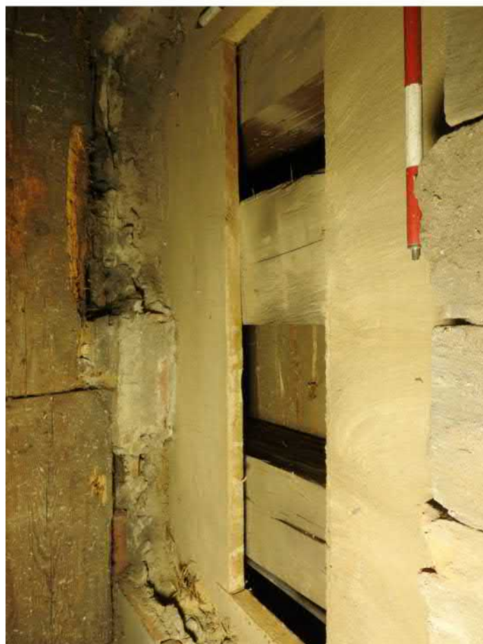
1408-F04: Stropní a podlahové trámy v sondě 1408; foceno od severu; fotil Ditmar E.; datum 18.6.2020
