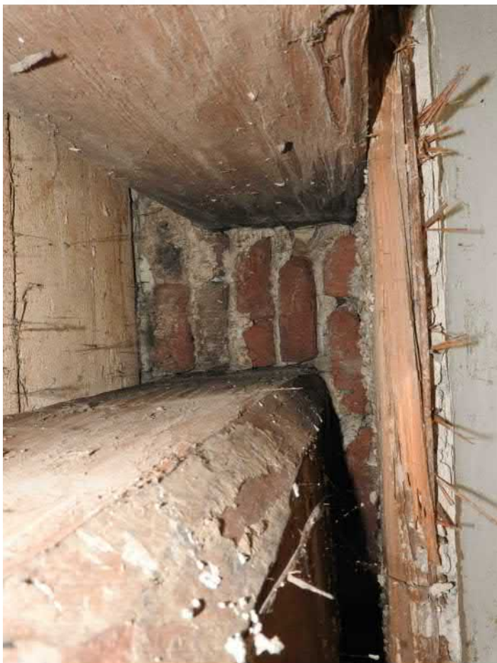
1308-F05: Stropní a podlahové trámy v sondě 1308; foceno od východu; fotil Ditmar E.; datum 21.5.2020
