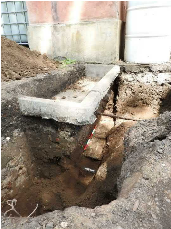
727-F17: Zdi Z061, Z062; foceno od jihozápadu; fotil Ditmar E.; datum 16.6.2020
