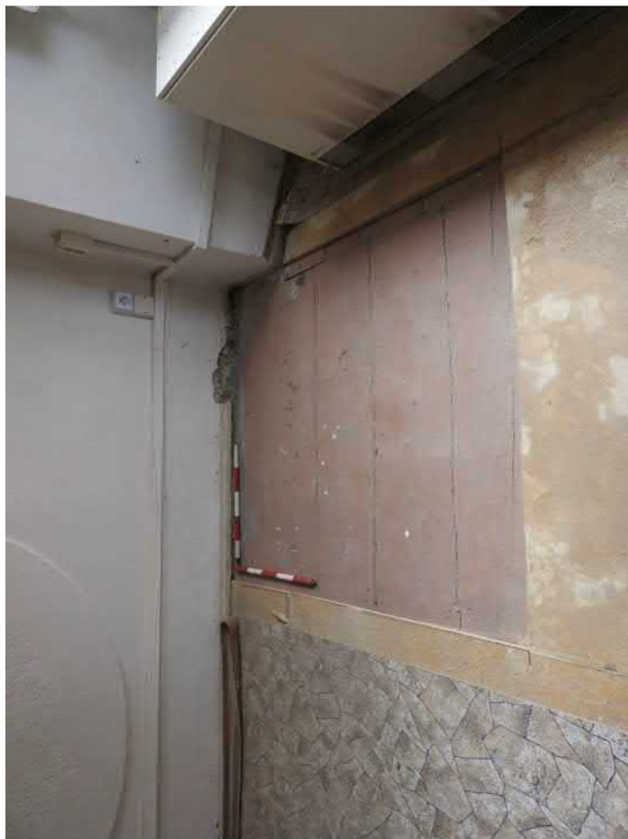
1307-F02: Sonda 1307 po odstranění dřevotřískových desek; foceno od severu; fotil Ditmar E.; datum 20.5.2020
