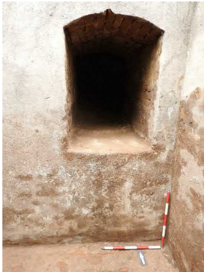
703-F18: Nádrž a ústí kanálu Z018; foceno od jihu; fotil Ditmar E.; datum 6.5.2020
