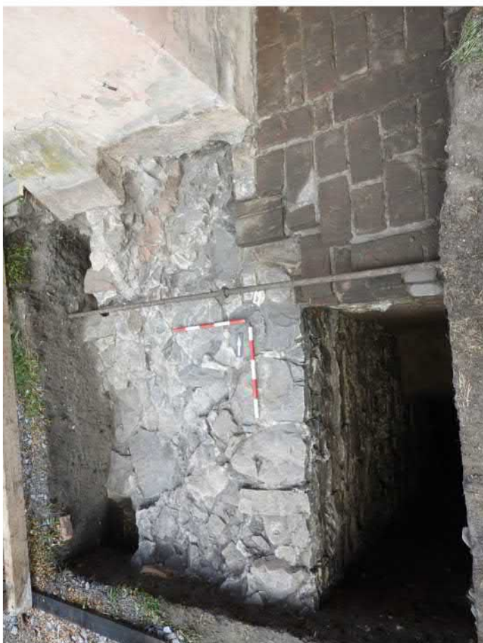
701-F19: Zdi Z01a, Z03a, Z05; foceno od východu; fotil Ditmar E.; datum 1.5.2020
