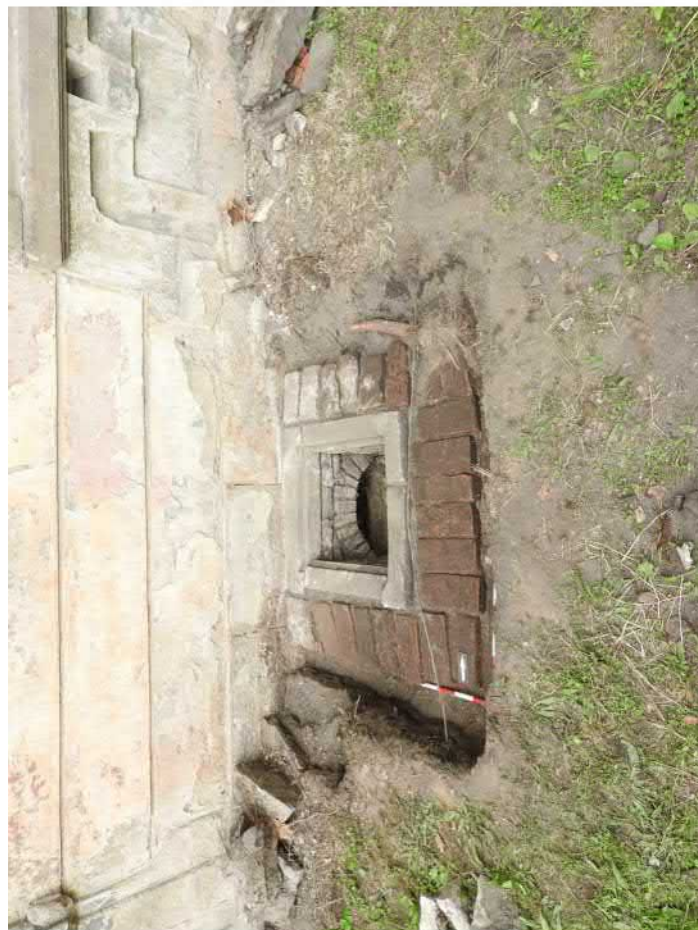
729-F02: Zdi Z067, Z068; foceno od východu; fotil Ditmar E.; datum 17.6.2020
