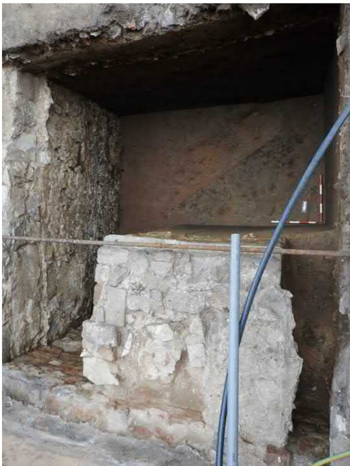
702-F21: Sonda po dokopání - povrch říčního náplavu vr. 702-11; foceno od západu; fotil Ditmar E.; datum 13.5.2020
