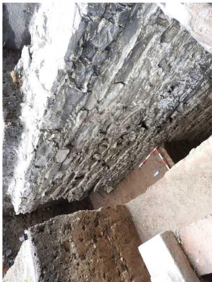
712-F08: Základ zdi Z003a; foceno od severovýchodu; fotil Ditmar E.; datum 12.5.2020
