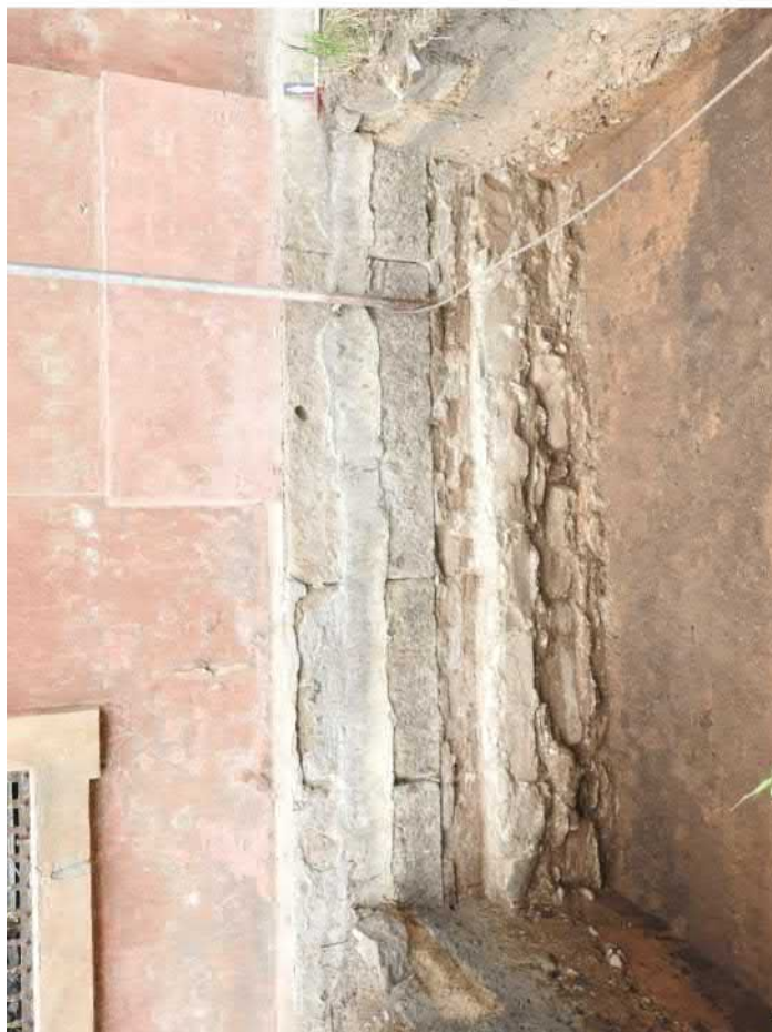
718-F12: Základ zdi Z026; foceno od jihu; fotil Ditmar E.; datum 21.5.2020
