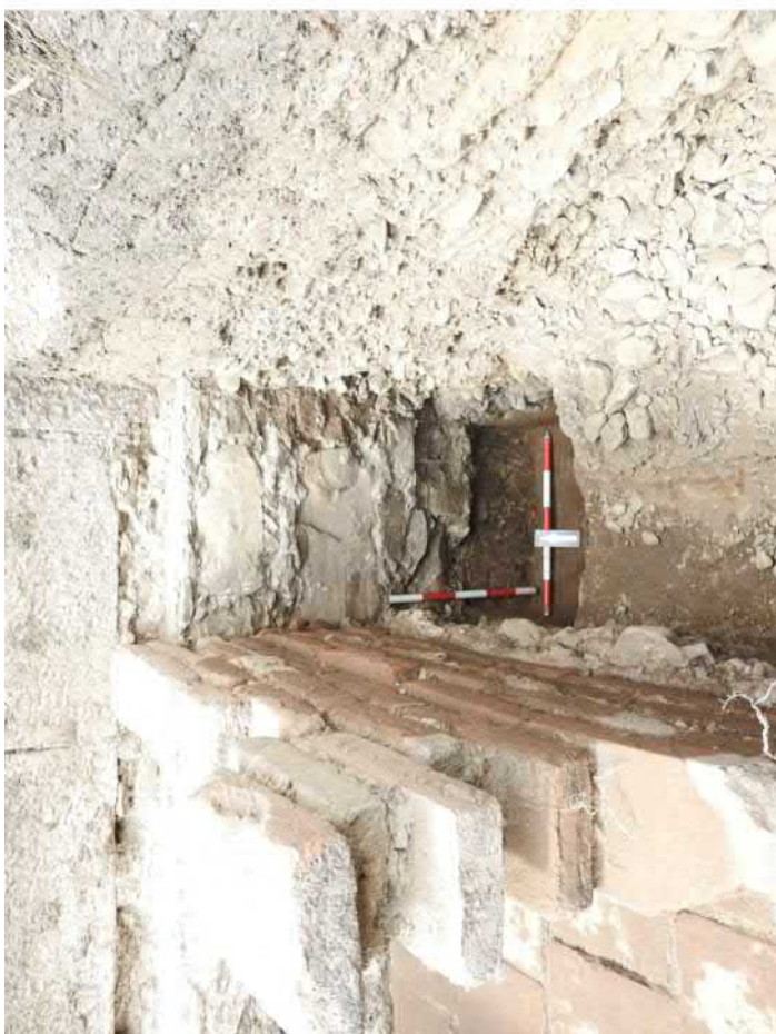
717-F27: Základ zdi Z026; foceno od jihu; fotil Ditmar E.; datum 21.5.2020
