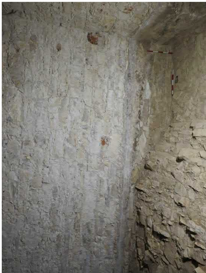
1101-F09: Zdi Z014, Z015; foceno od východu; fotil Ditmar E.; datum 30.4.2020
