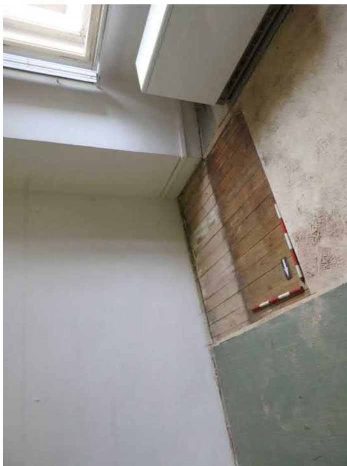
1306-F02: Sonda 1306 po odstranění dřevotřískových desek; foceno od severozápadu; fotil Ditmar E.; datum 20.5.2020
