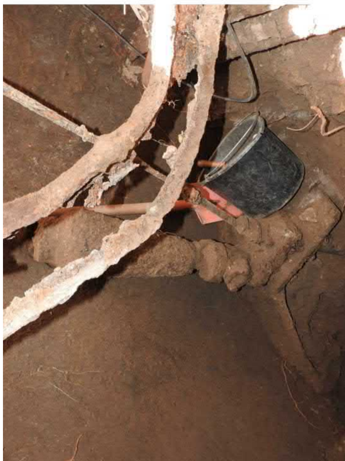
501-F28: Železné konstrukce a součásti čerpadla ve studni Z050; foceno od severovýchodu; fotil Ditmar E.; datum 15.6.2020
