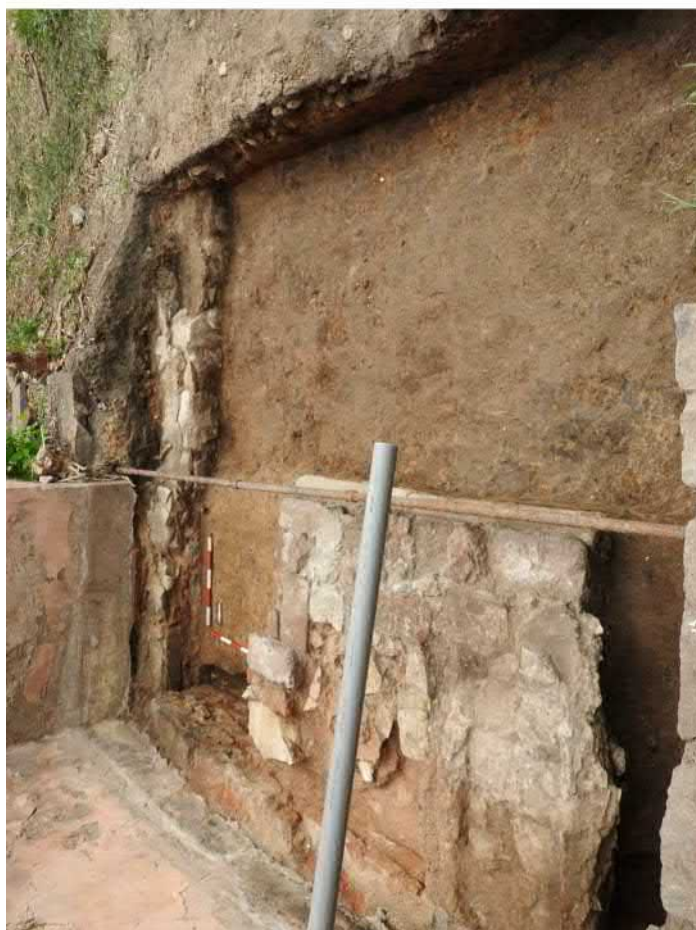
702-F12: Zdi Z001b, Z002, Z003c; foceno od západu; fotil Ditmar E.; datum 29.4.2020
