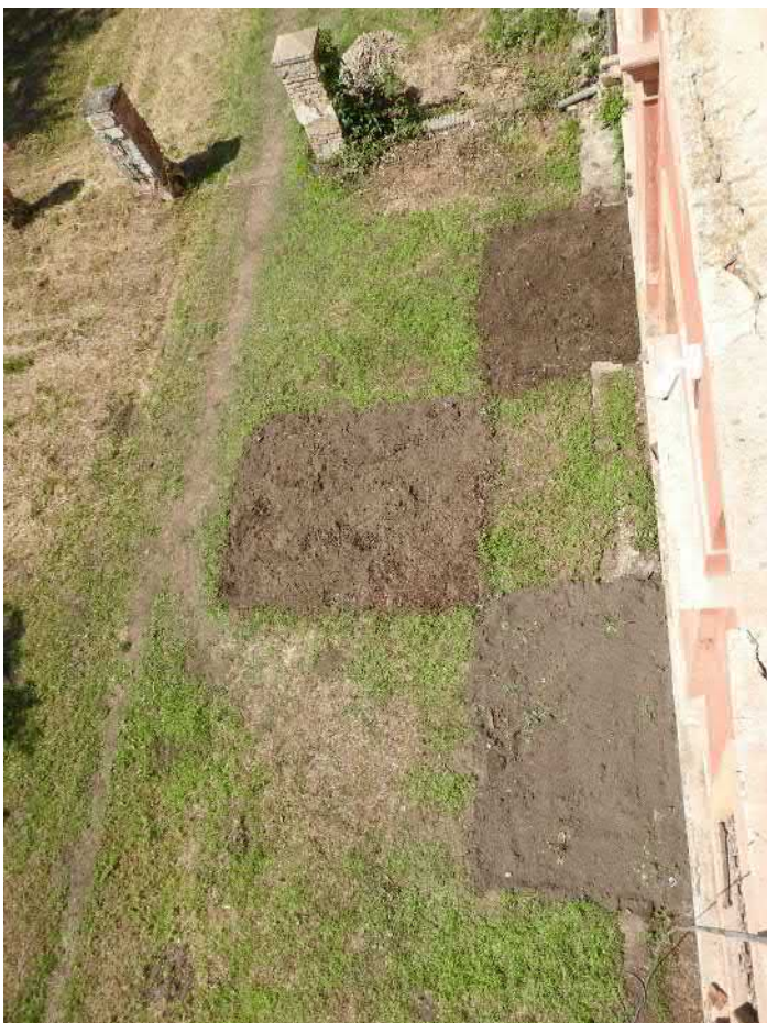
Celek-F079: Sondy na jižní zahradě Invalidovny po zasypání; foceno od východu; fotil Ditmar E.; datum 23.6.2020
