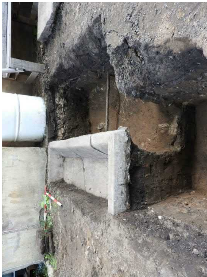
727-F06: Zdi Z061, Z062; foceno od západu; fotil Ditmar E.; datum 16.6.2020
