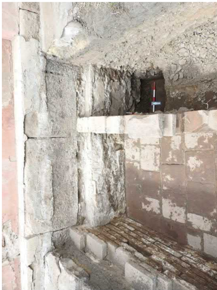
717-F26: Severní stěna sondy se zdmi Z026 a Z030; foceno od jihu; fotil Ditmar E.; datum 21.5.2020
