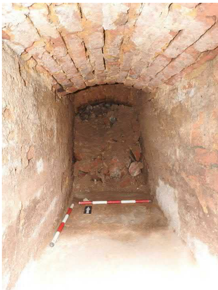
703-F23: Pohled do kanálu Z018; foceno od jihu; fotil Ditmar E.; datum 13.5.2020
