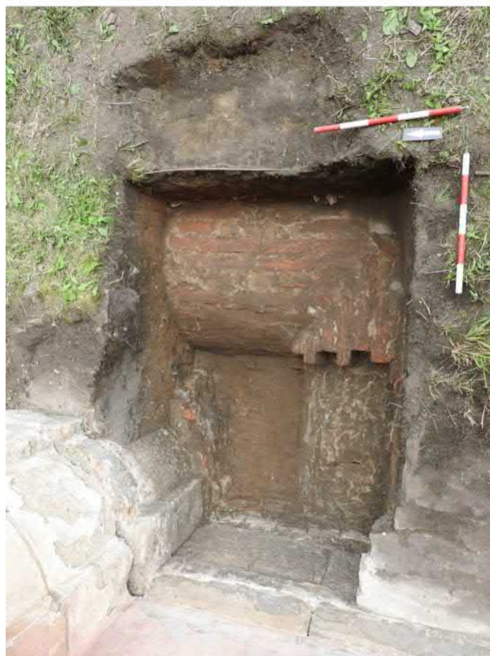
728-F04: Zdi Z65, Z67, Z68; foceno od jihu; fotil Ditmar E.; datum 17.6.2020
