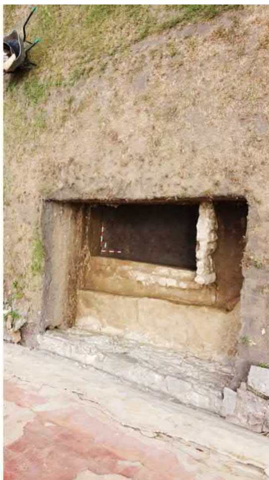
722-F08: Zdi Z42, Z43, Z44, výkopy V002, V055; foceno od západu; fotil Kalíšek M.; datum 2.6.2020
