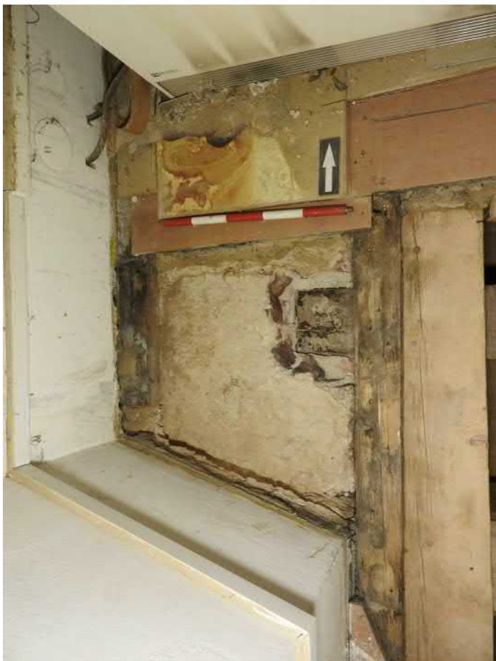
1307-F05: Stropní a podlahové trámy v sondě 1307; foceno od východu; fotil Ditmar E.; datum 20.5.2020
