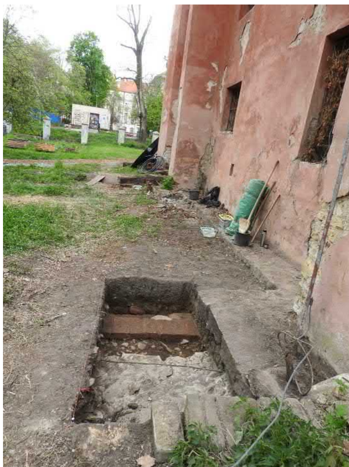
Celek-F008: Sondy při jihozápadním rohu Invalidovny; foceno od východu; fotil Ditmar E.; datum 28.4.2020
