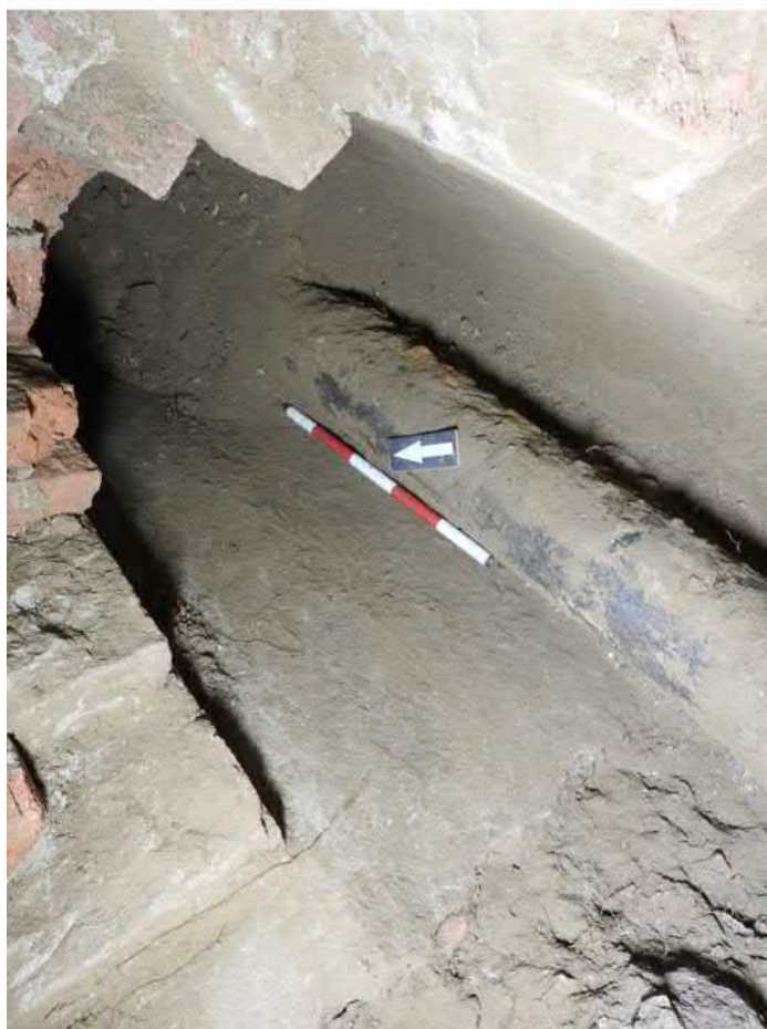
3101-F16: Litinová trubka v kanalizaci Z55; foceno od jihu; fotil Ditmar E.; datum 10.6.2020
