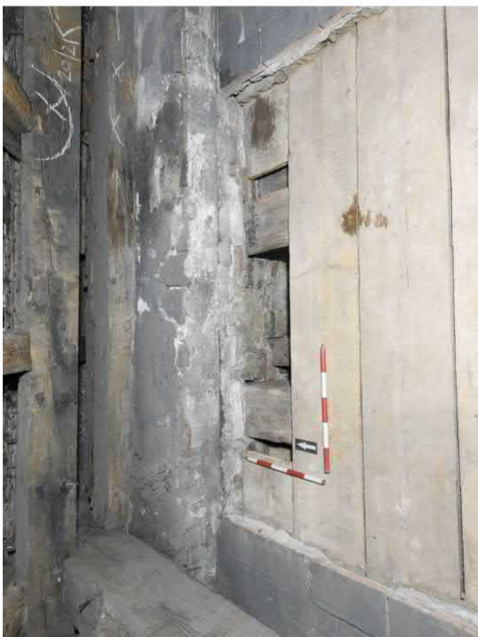
1401-F03: Stropní a podlahové trámy v sondě 1401; foceno od jihu; fotil Ditmar E.; datum 11.5.2020
