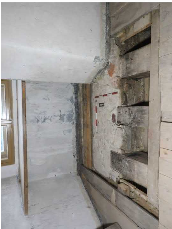
1303-F07: Stropní a podlahové trámy v sondě 1303; foceno od jihu; fotil Ditmar E.; datum 20.5.2020
