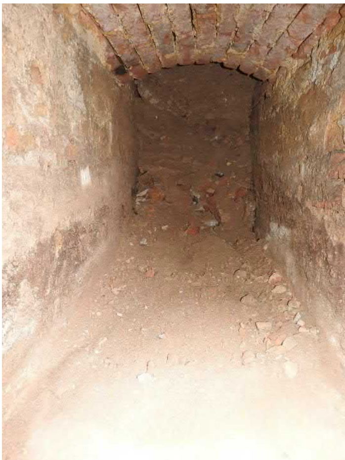
703-F19: Pohled do kanálu Z018; foceno od jihu; fotil Ditmar E.; datum 6.5.2020
