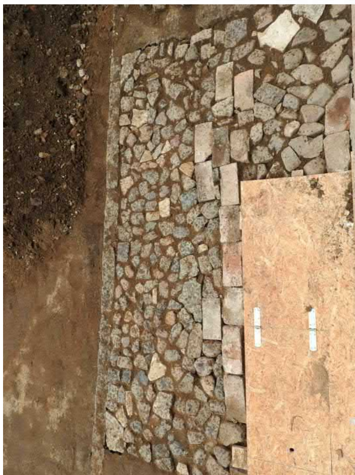
501-F85: Sonda po zasypání a provizorním zadláždění; foceno od východu; fotil Ditmar E.; datum 24.6.2020
