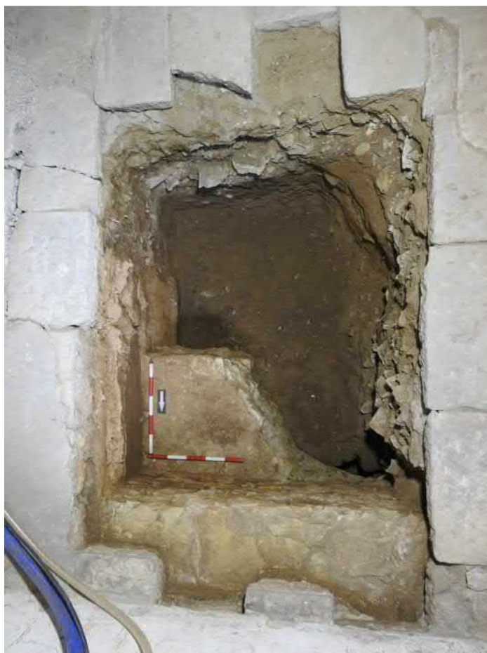
3102-F14: Zdi Z031, Z032, výkop V049; foceno od západu; fotil Ditmar E.; datum 29.5.2020
