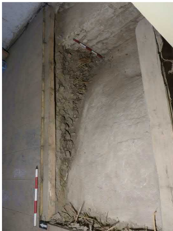
1201-F10: Řez 1201-RS; foceno od východu; fotil Ditmar E.; datum 27.4.2020
