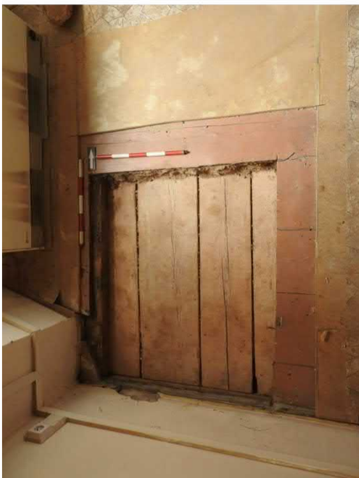
1307-F03: Sonda 1307 po odstranění prkenné podlahy a zásypu pod ní; foceno od východu; fotil Ditmar E.; datum 20.5.2020
