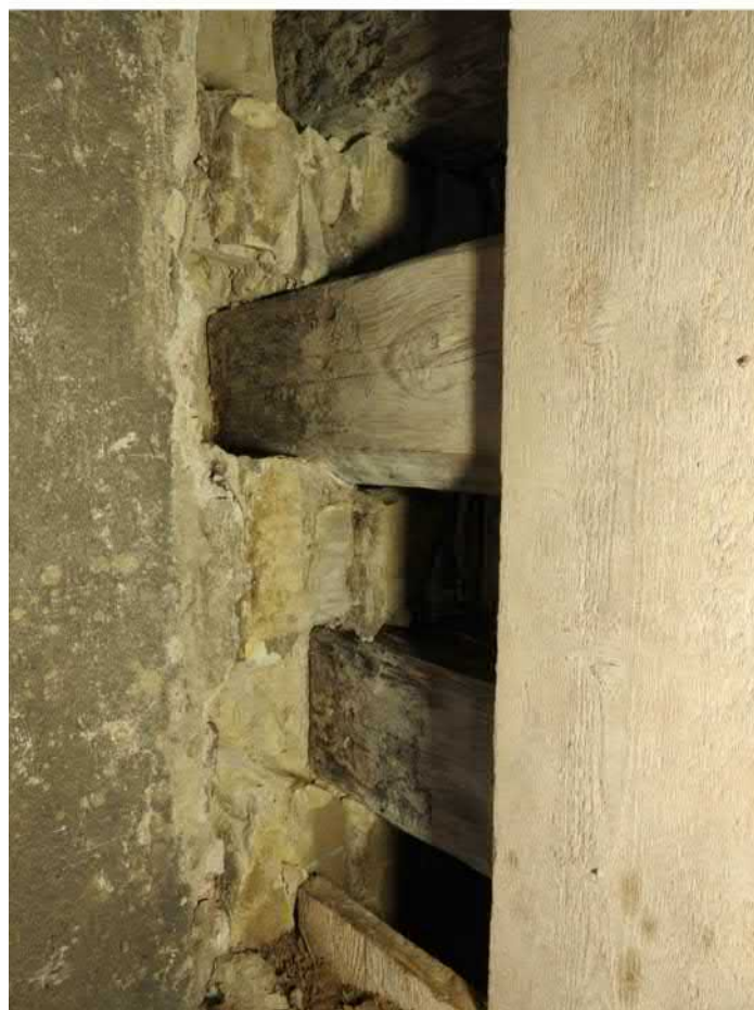
1402-F08: Stropní a podlahové trámy v sondě 1402; foceno od jihu; fotil Ditmar E.; datum 20.5.2020
