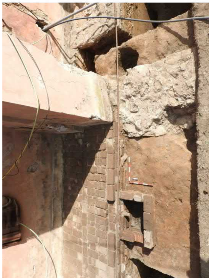
710-F04: Zdi Z001a, Z001b, Z003b, Z005, Z020, výkopy V001b, V026, V027; foceno od jihu; fotil Ditmar E.; datum 8.5.2020
