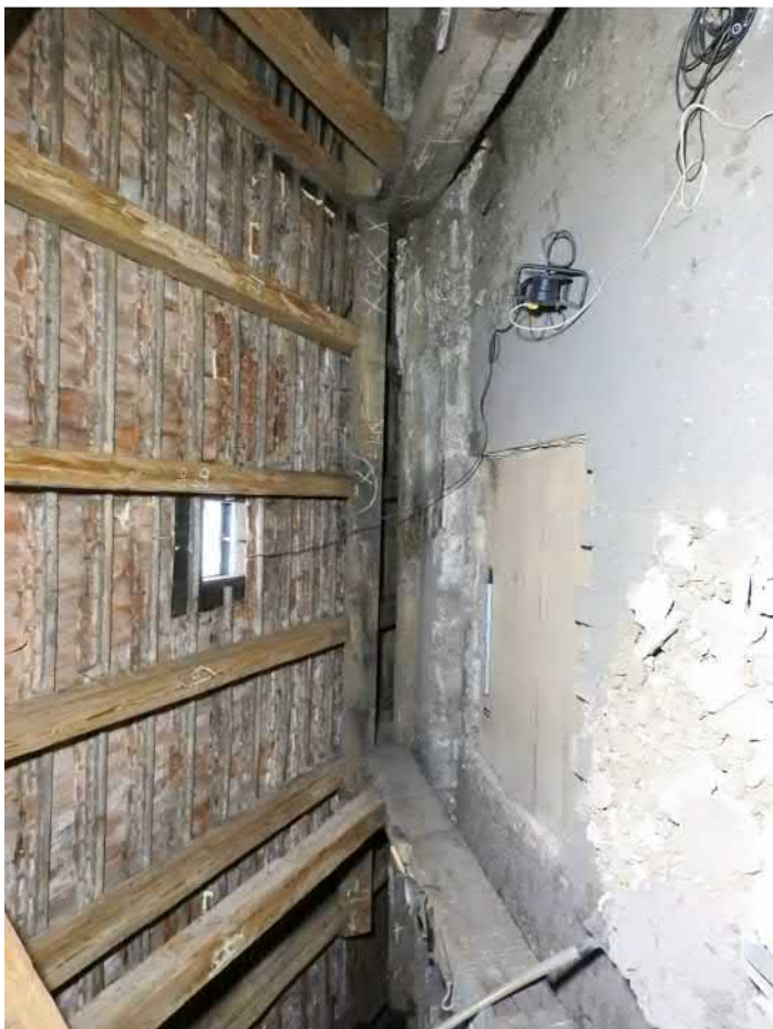
1401-F01: Situace sondy 1401; foceno od jihu; fotil Ditmar E.; datum 11.5.2020
