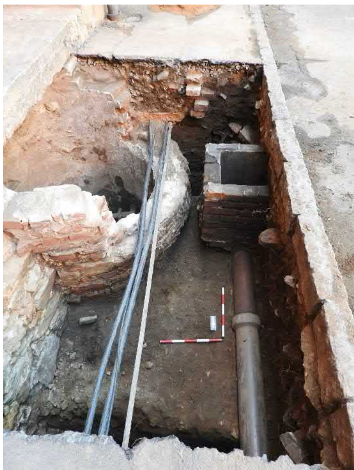
501-F83: Zdi Z048, Z049, Z050, Z051, výkopy V073, V074; foceno od severu; fotil Ditmar E.; datum 22.6.2020
