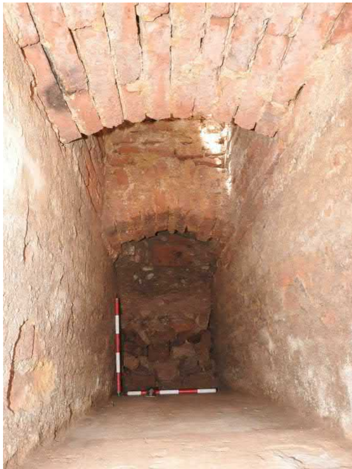
4101-F06: Kanál zdi Z18; foceno od jihu; fotil Ditmar E.; datum 29.5.2020
