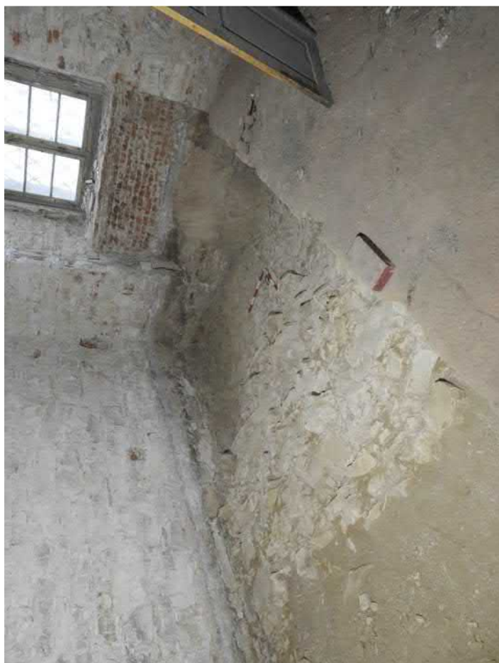
1101-F05: Zdi Z014, Z015, Z016, Z017; foceno od jihovýchodu; fotil Ditmar E.; datum 30.4.2020
