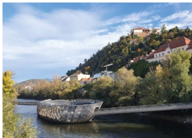
Projekt NAKI III Novostavby v historickém prostředí (DH23P03OVV017). Štýrský Hradec – město známé řadou novodobých architektonických intervencí v kontextu historického urbanismu. Aiola – mostem s kavárnou a umělym ostrovem překlenul italský architekt Vito Acconci na přelomu tisíciletí řeku Mur (1999–2003)
