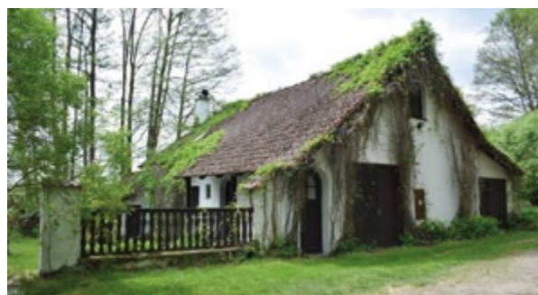
Dokumentace vodní elektrárny v zaniklé vsi Pomezná (katastr. území Cheb) vybudované na základech vodního mlýna, záznam v Památkovém katalogu, https://pamatkovykatalog.cz/vodni-elektrarna-25798563 ↗
