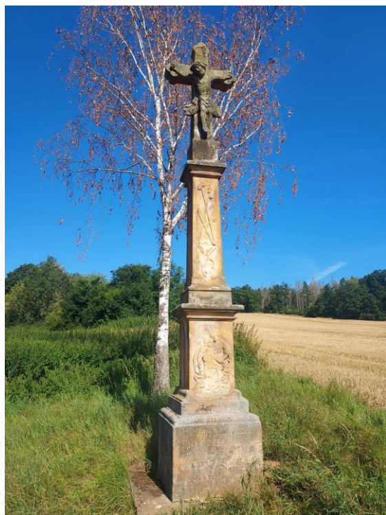
Fotografie z realizace obnovy kříže u Hegerovy zmolý v roce 2024:
