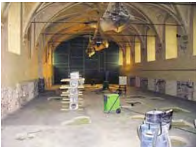
Praha 1-Malá Strana, Valdštejnský palác, vysoušení jednacího sálu Senátu ČR. (Foto Ondřej Šefců)
