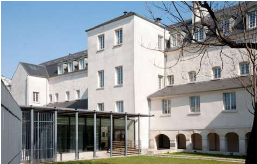
D5.1 Pohled na renovovanou klášterní budovu Les Récollets s moderním vestibulem
