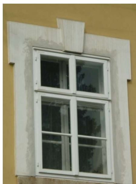
Čp. 93 ulice Slavatovská – okna po výměně
