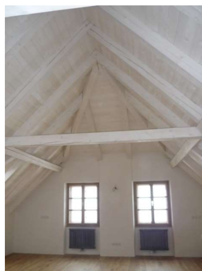
Čp. 48 náměstí Zachariáše z Hradce – nový krov, půdní vestavba
