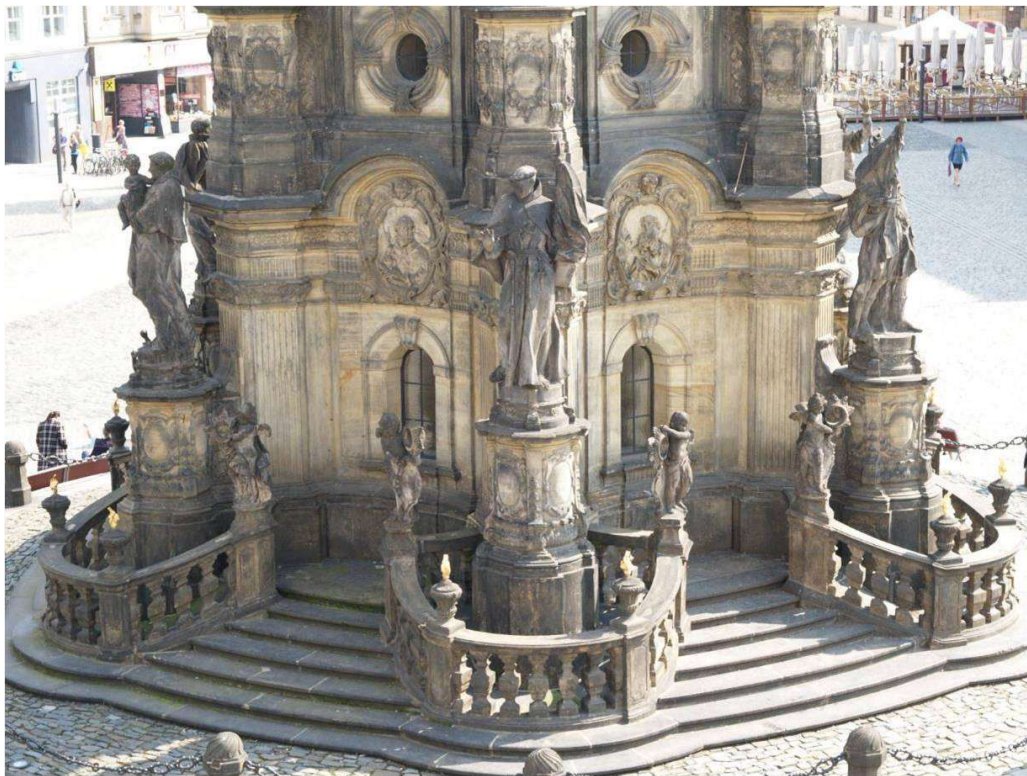
Schody, balustráda, 1. patro světců
