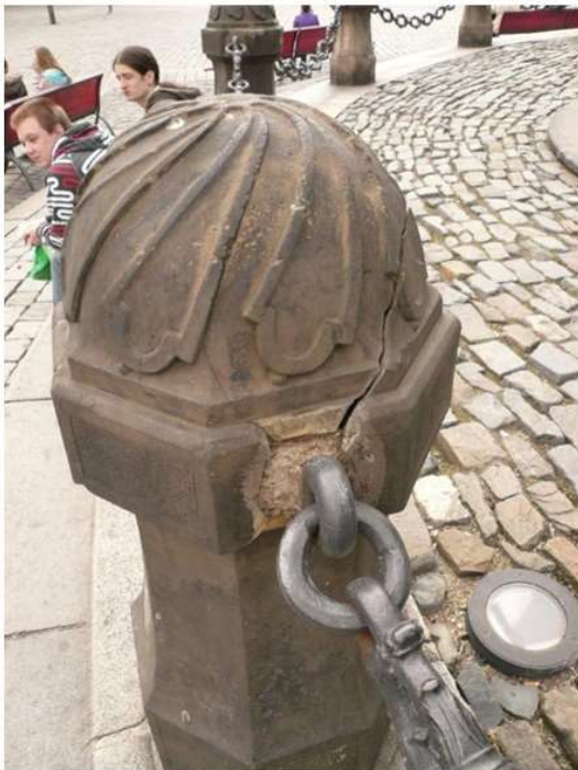
Projevy pohupování na řetězech přenášející se do pilířků – praskliny v kameni (stav 2012).
