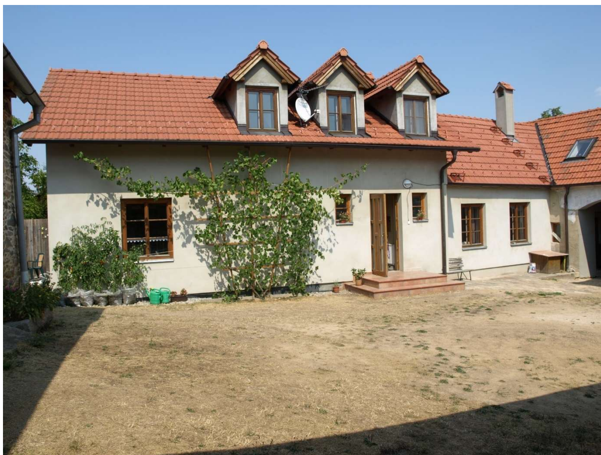
Holašovice, (okres České Budějovice), nový obytný dvorní trakt usedlosti čp. 20 stojící na západní straně návsi, pohled od jihu, (foto Michaela Špinarová, 2015)
