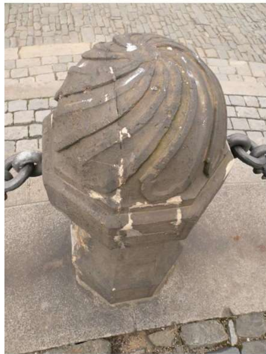
Projevy pohupování na řetězech přenášející se do pilířků – praskliny v kameni (stav 2012).
