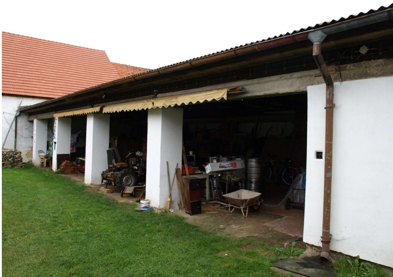
Holašovice, (okres České Budějovice), dvorní trakt garáží usedlosti čp. 3 stojící na východní straně návsi, (foto Pavel Bureš)
