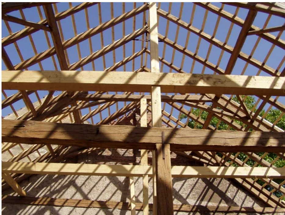
Holašovice, (okres České Budějovice), záběr na detaily výměny dřevěných prvků konstrukce krovu při obnově střechy obytné části usedlosti čp. 8, (foto Michaela Špinarová, 2008)
