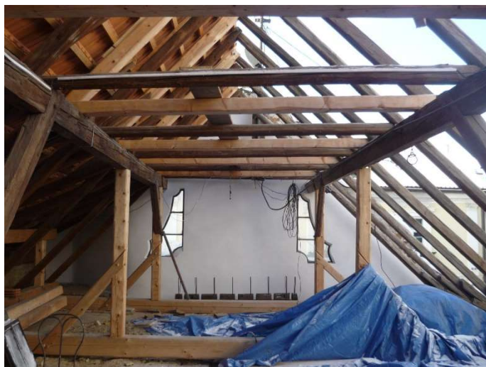
Oprava krovu u domu čp. 28 v ulici Palackého
