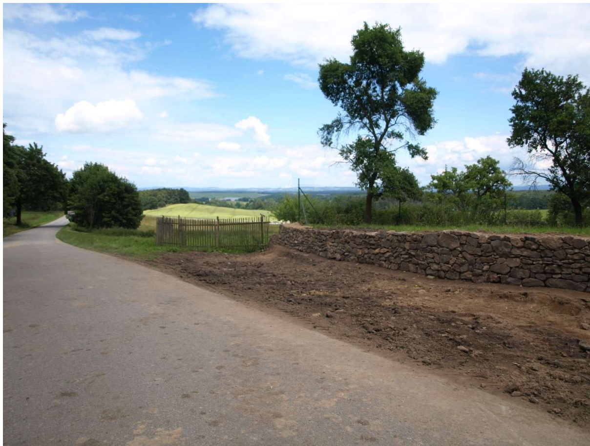
Holašovice, (okres České Budějovice), pohled od jihozápadu na vzorově obnovenou kamennou zídku na severním konci intravilánu sídla, (foto Michaela Špinarová, 2015)
