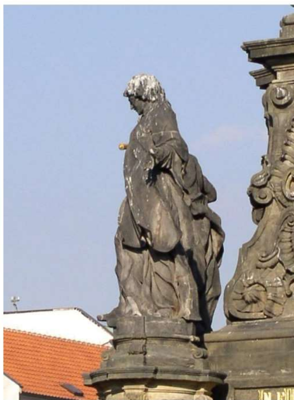
Holubí guáno (dusičnany a fosforečnany) – přetrvávající problém Sloupu.
