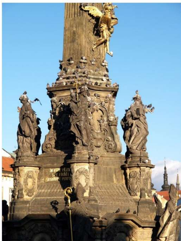
Holubí guáno (dusičnany a fosforečnany) – přetrvávající problém Sloupu.
