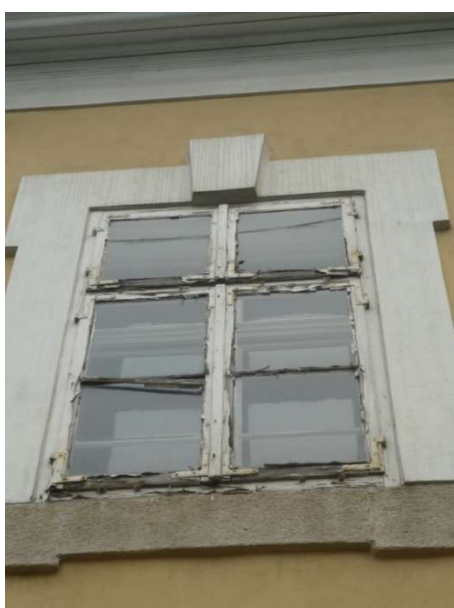
Čp. 93 ulice Slavatovská – okna před výměnou
