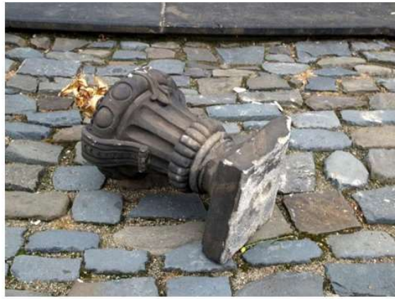
05/2008 vandalský útok na Sloup, 09/2008 neúmyslné poškození sloupku řetězu
