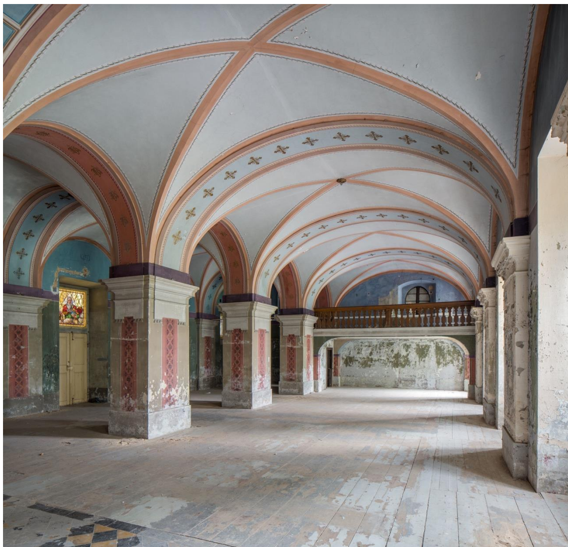
Téma 5, foto č. 3 – kaple, severní křídlo, přízemí
