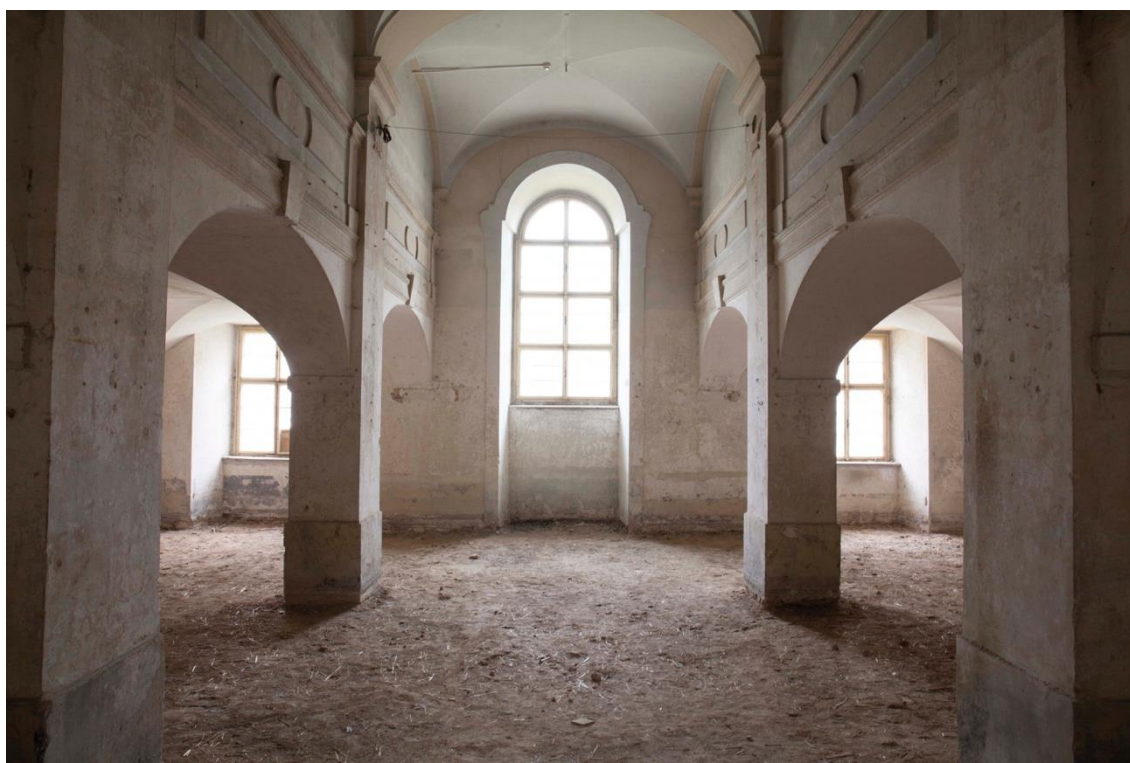
Téma 4, foto č. 2 – obytná jednotka s osekanou omítkou po povodních, východní křídlo, přízemí
