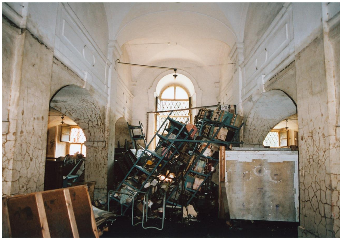
Téma 4, foto č. 2 – obytná jednotka s osekanou omítkou po povodních, východní křídlo, přízemí
