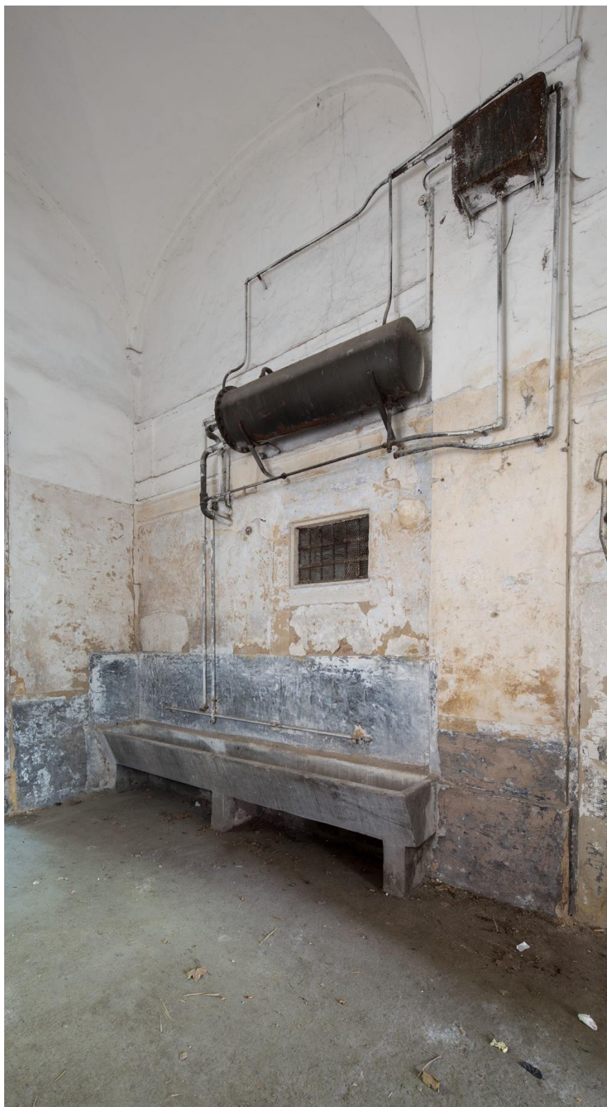
Téma 5, foto č.5 – dochovaná umývárna, západní křídlo, přízemí
