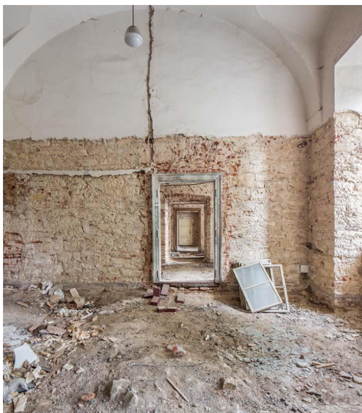
Téma 4, foto č. 5 – severní křídlo, současný stav místností, omítka osekaná do výšky vodní hladiny při povodních 2002
