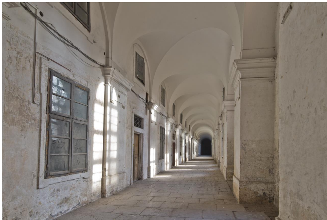
Téma 4, foto č. 5 – severní křídlo, současný stav místností, omítka osekaná do výšky vodní hladiny při povodních 2002
