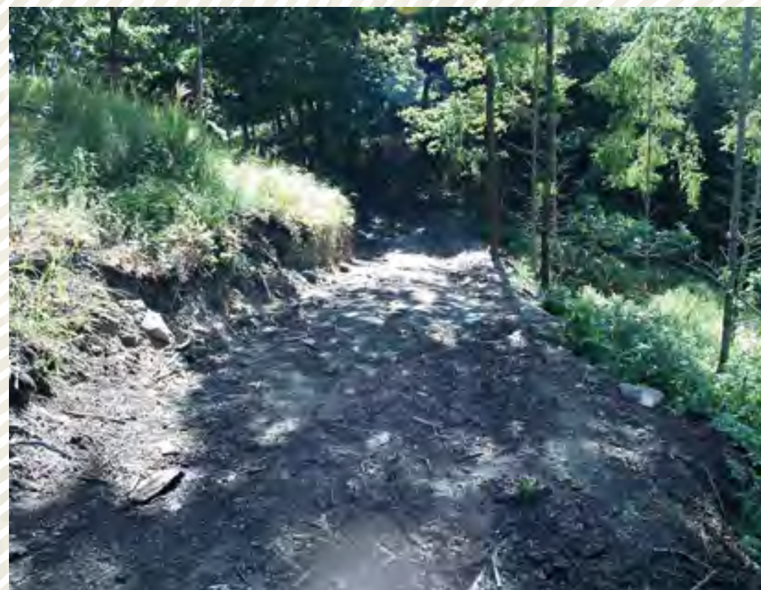
Albrechtice nad Vltavou, okr. Písek: hradiště ze starší doby bronzové a raného středověku; pro odvoz vytěženého dřeva vytvořen nový průraz valem hradiště
