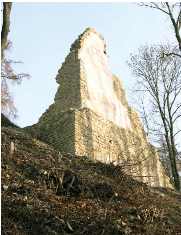
Obnova hradu Brandýs nad Labem
