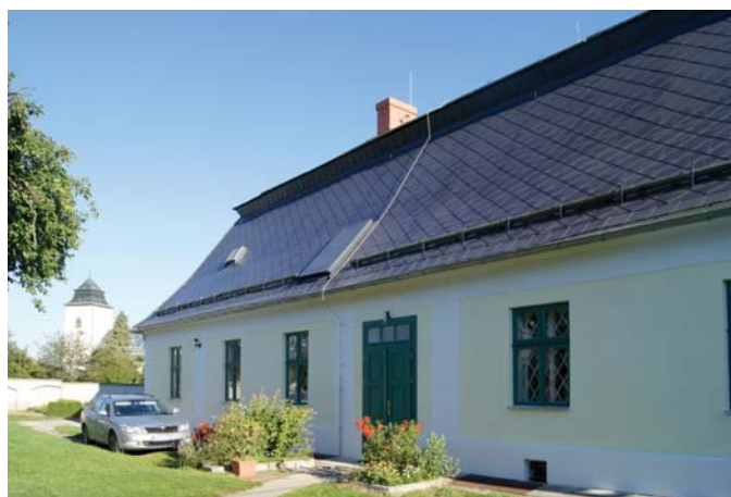
OPD a následná příkladná rekonstrukce fary v Měrotíně
