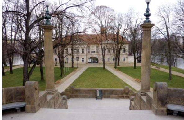
Rehabilitace severní části Střeleckého ostrova v Praze
