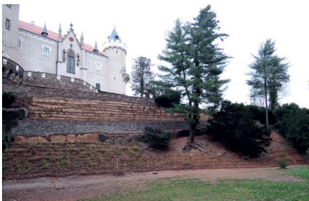
Státní zámek Žleby před provedením stabilizace svahů a po jejím provedení
