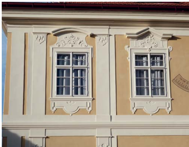
Panenské Břežany: detail obnoveného průčelí zámku
