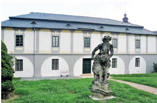
Zámecký letohrádek ve Velkých Losinách po obnově
