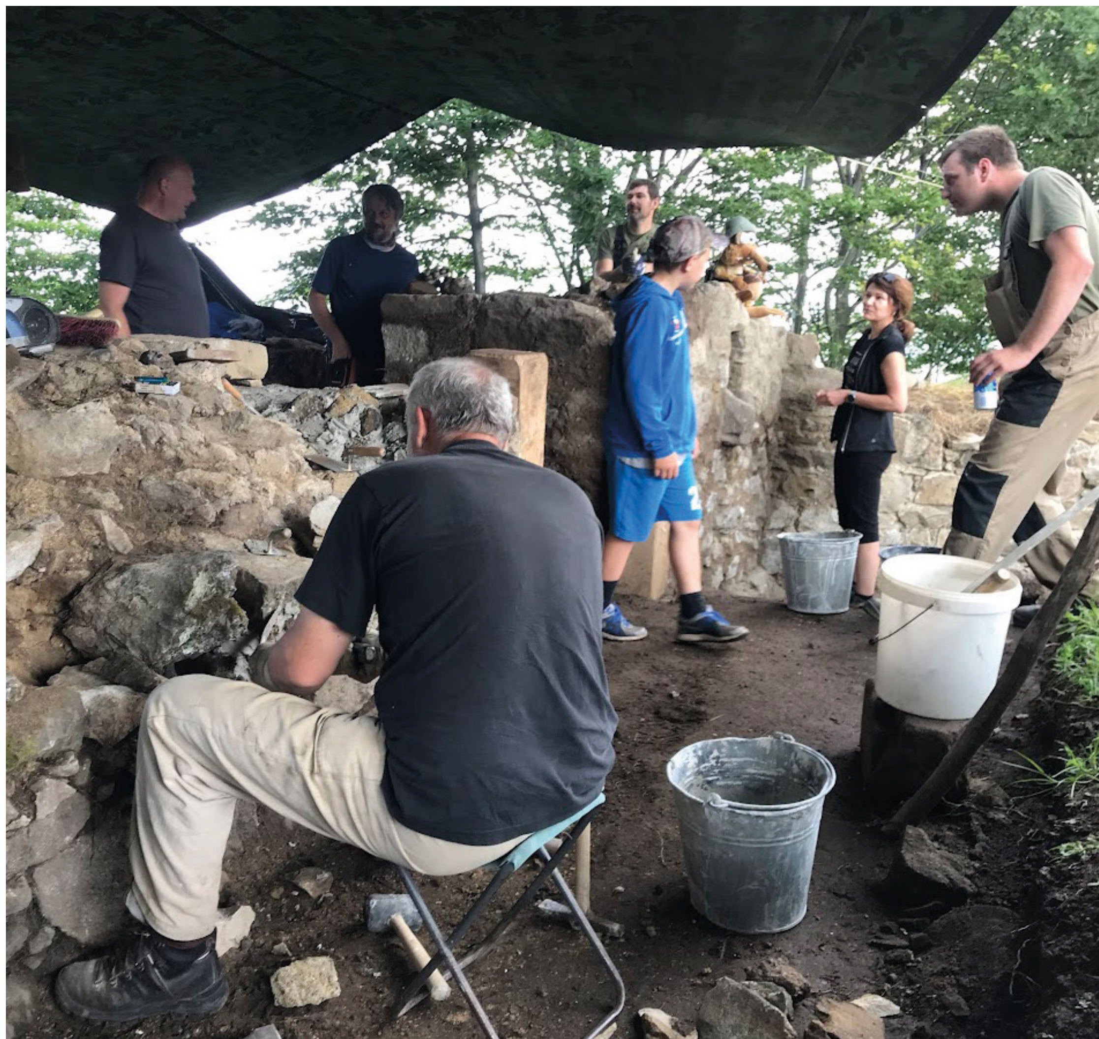
Průběh konzervačních prací v severozápadním koutě nádvoří; na práci se podílejí členové spolku, nadšenci i pracovníci NPÚ (archív spolku 2021).
