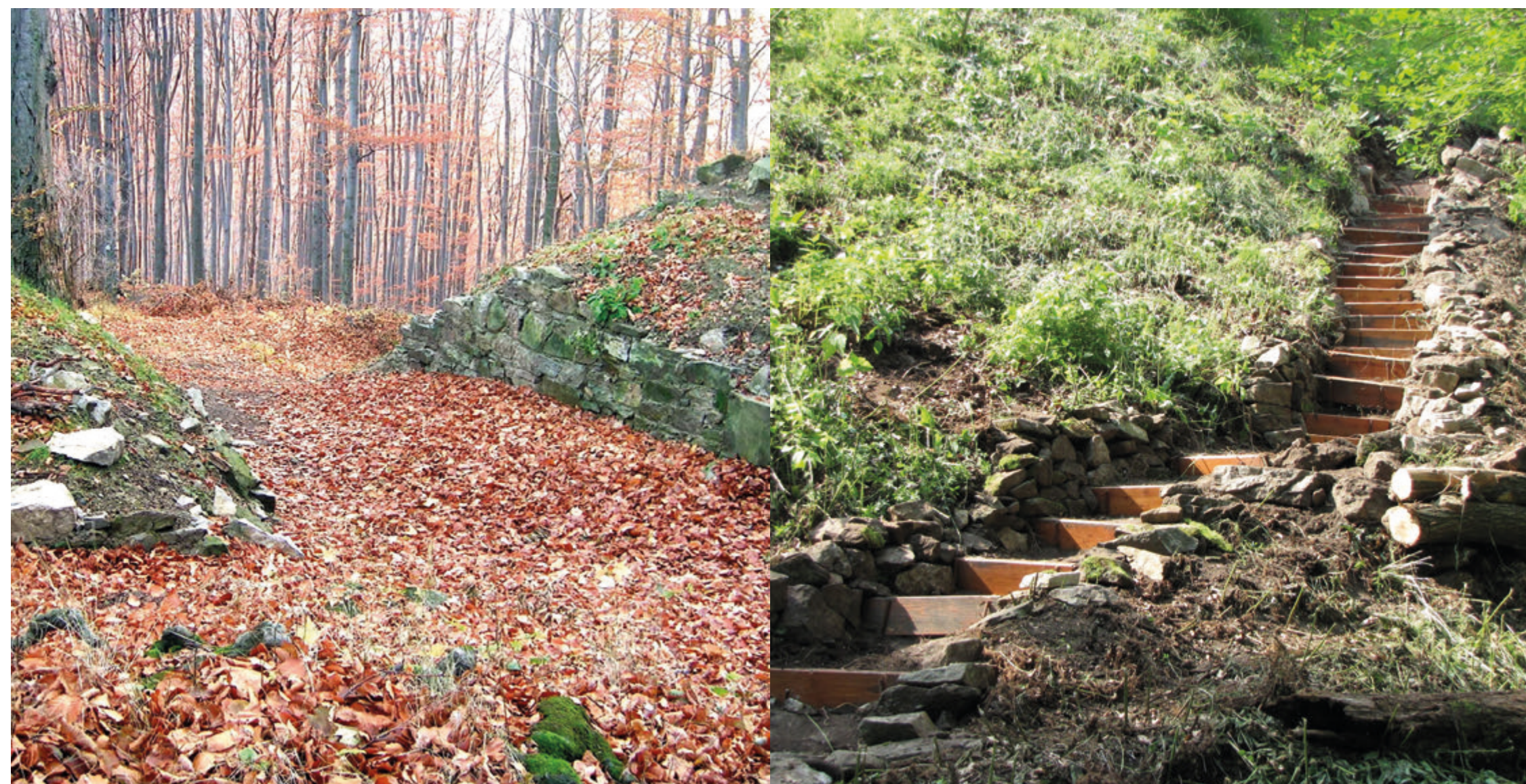
Ukázky prací, provedených na hradě: vlevo zakončované pozůstatky vstupní věže, vpravo terénní schodiště, zpřístupňující hradní jádro. Práce jsou zaměřeny výhradně na záchrano ohrožených partií zříceniny a pro její bezpečnější zpřístupnění, bez vzniku případných parazitních staveb (R. Vlára 2010).
