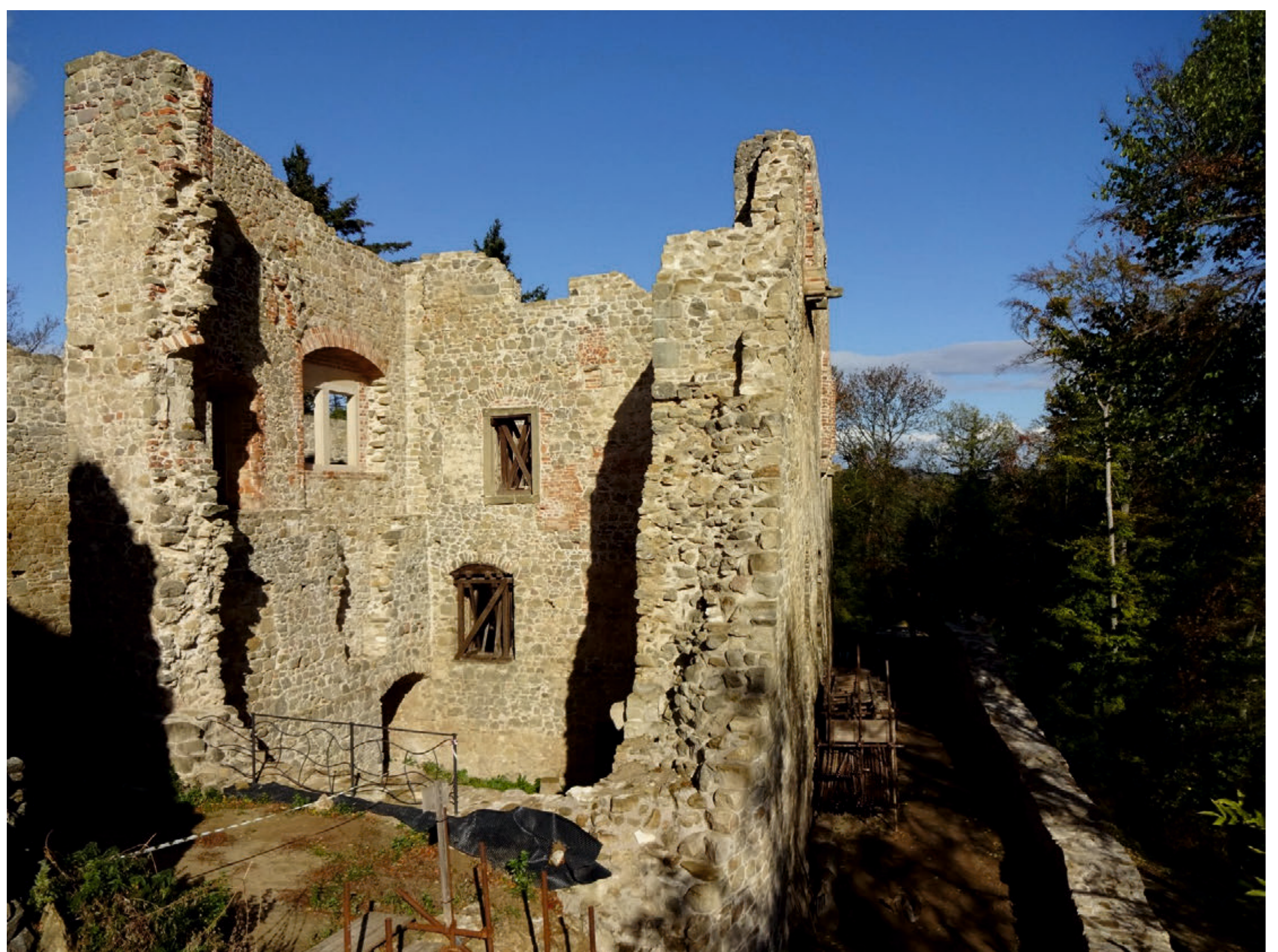
Sanace paláce a parkánu – po obnově.
