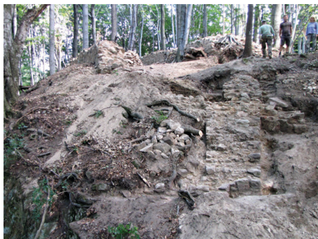
Pohled na zříceninu hradní brány, téměř zničené pohybem návštěvníků po svahu; nalevo stav po vyčištění zdiva, vpravo tatáž partie po konzervaci a instalaci terénního schodiště, které ochrání památku a návštěvníkům umožní bezpečný vstup (2013).
