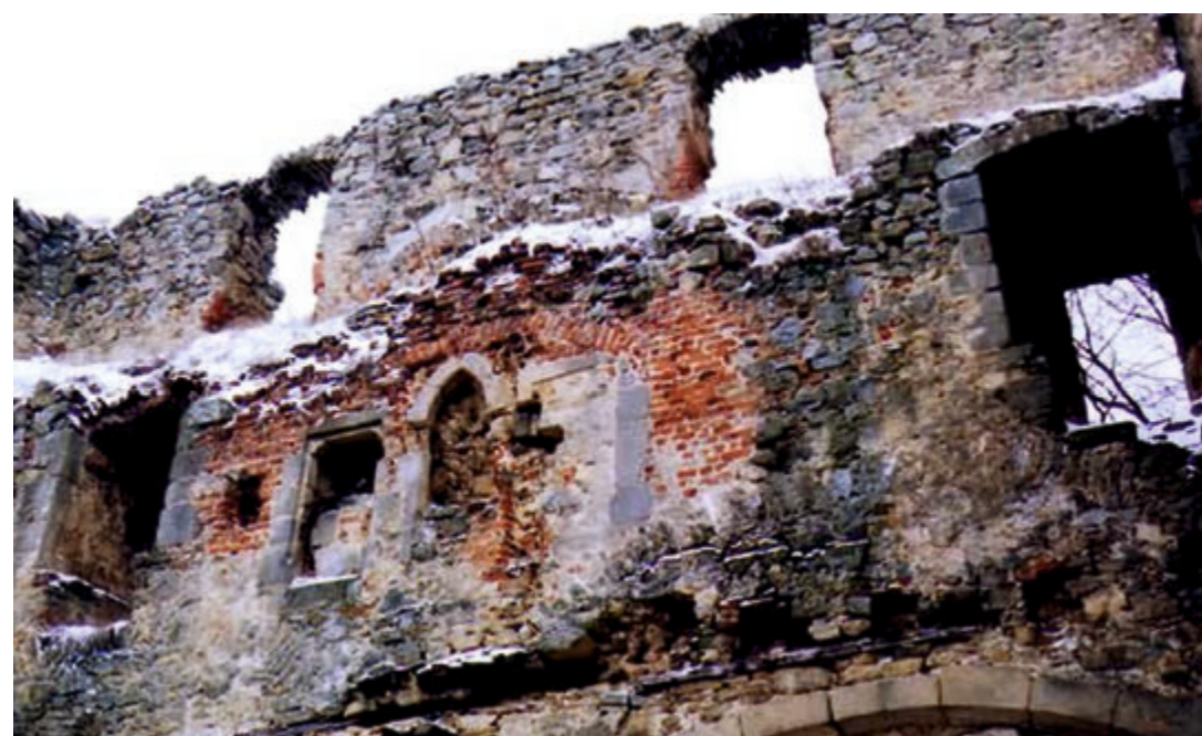
Konzervace hradní kaple a koruny jižní palácové zdi.
