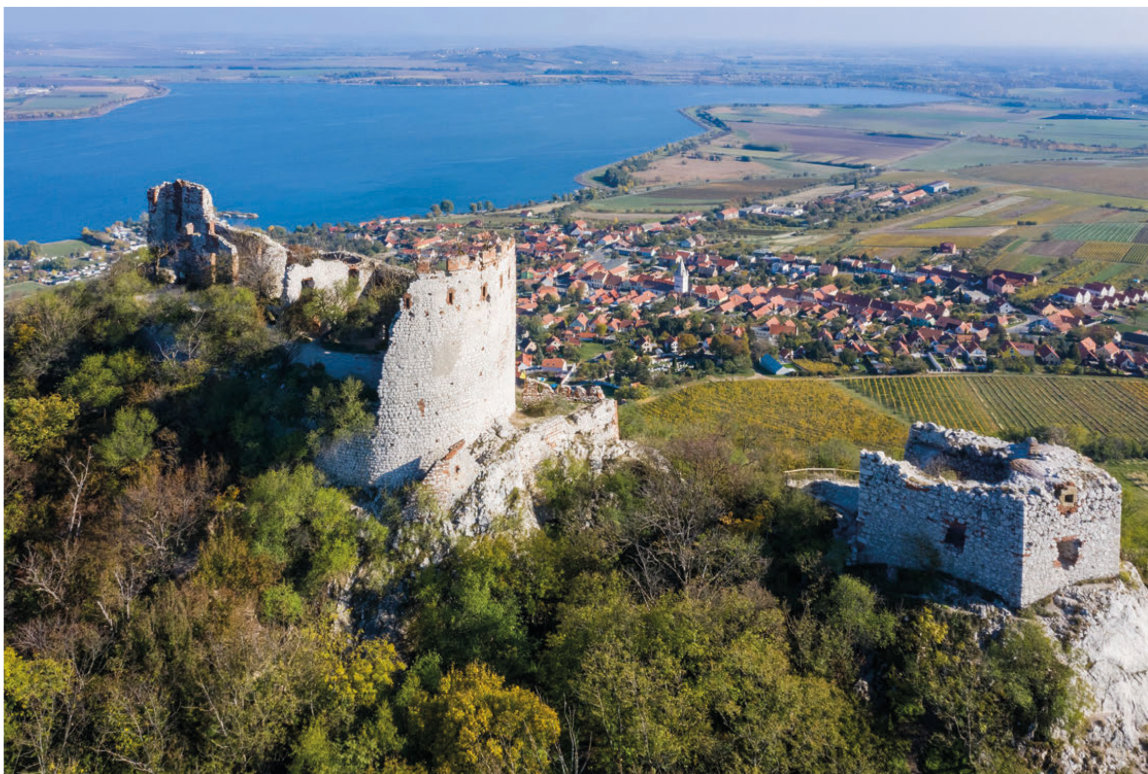
Celkový pohled na hrad od jihozápadu.
