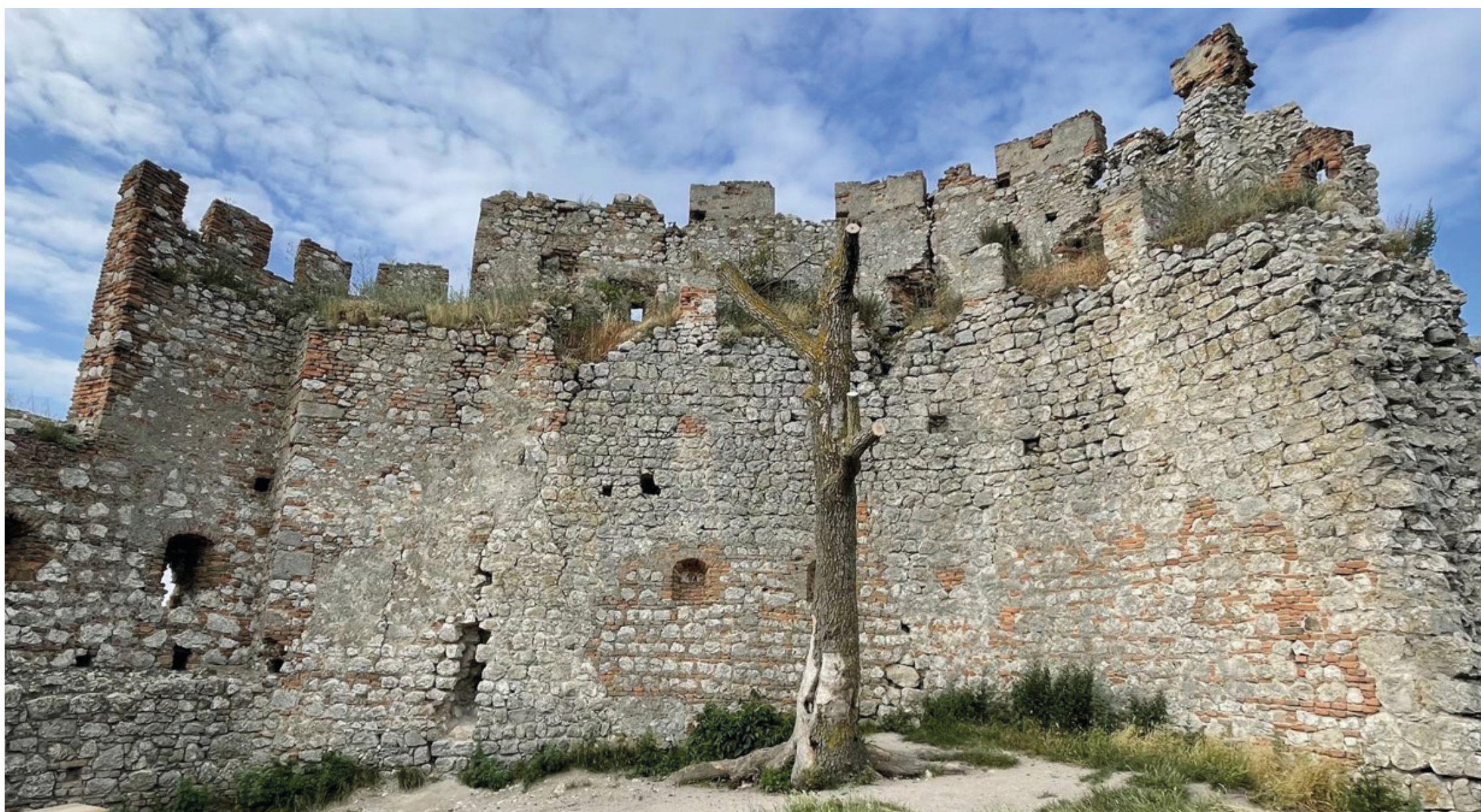
Vnitřní líc jižní obvodové stěny hradu před obnovou.
