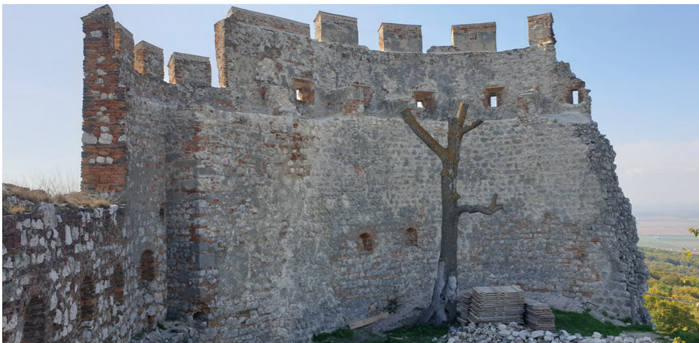
Vnitřní líc jižní obvodové stěny hradu po obnově roku 2021 a 2022.
