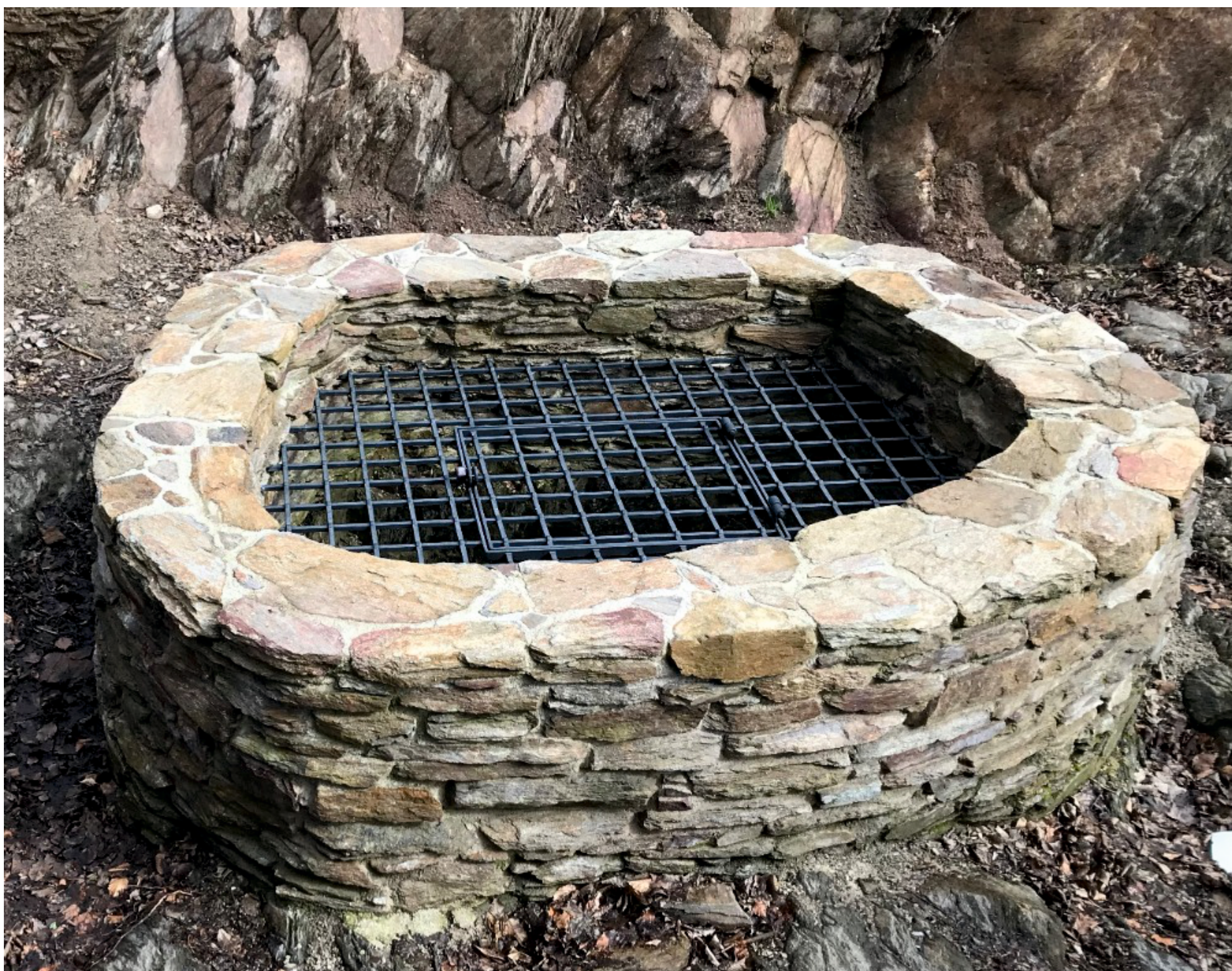
Po výsledné rekonstrukci cisterny měl být do jisté míry patrný rozdíl mezi zpevněným dochovaným zdívem a nově vyzděnou vrstvou. Kamenické práce byly provedeny zkušenými kameníky, kteří byli doporučení A. Dunajovou z NPÚ, ÚOP v Brně. Mříž vyrobil kovář T. Zima.
