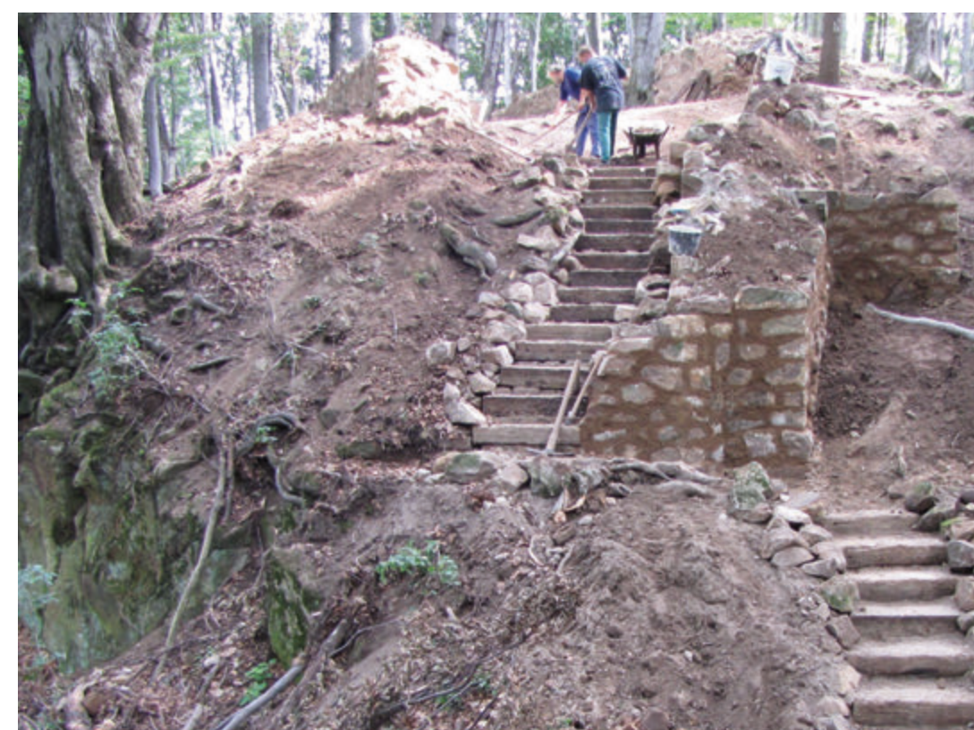
Pohled na zříceninu hradní brány, téměř zničené pohybem návštěvníků po svahu; nalevo stav po vyčištění zdiva, vpravo tatáž partie po konzervaci a instalaci terénního schodiště, které ochrání památku a návštěvníkům umožní bezpečný vstup (2013).
