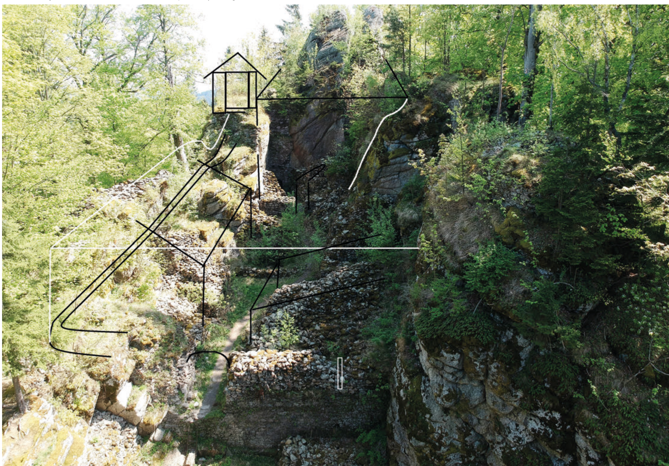
Ukládání stavebního kamene. Během výzkumu byla odvážena pouze suť. Veškeré kameny byly skládány v prostorách hradu a jeho nejbližšího okolí pro případ rekonstrukce. Na obrázku pohled do jádra hradu s náčrtem řešení stabilizace zdiva a prezentace budov.
