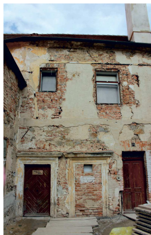
Detail průčelí s dvojitými portálky před obnovou v r. 2015.
