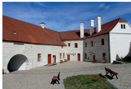
Předzámčí po celkové rekonstrukci, r. 2016.
