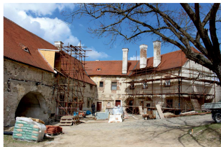
Předzámčí během rekonstrukce, r. 2015.
