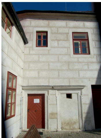
Detail průčelí s dvojitými portálky po obnově v r. 2017.
