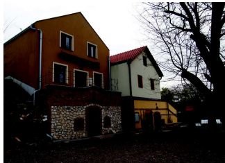
Vinný sklep se zemní lisovnou z roku 1977 po přestavbě, foto z roku 2015.
