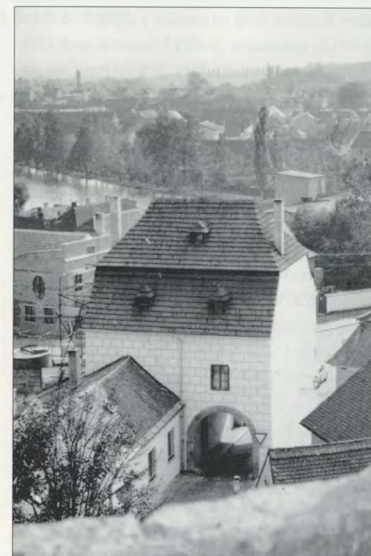
Severní fasáda - stav po opravě
