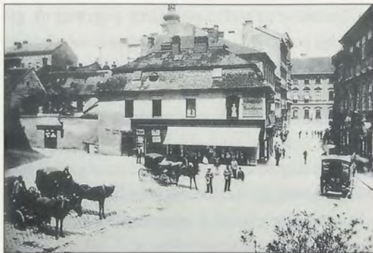
Brno - ulice Běhounská v minulosti
