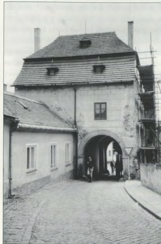
Severní fasáda - stav před opravou
