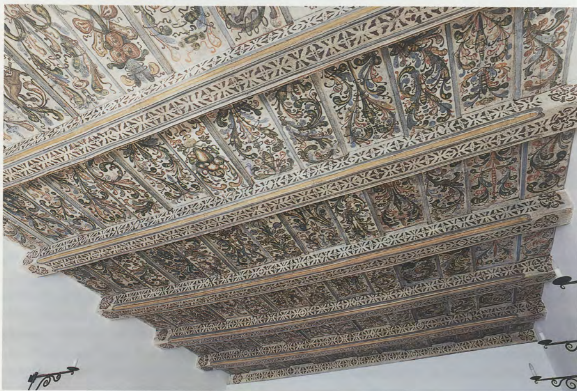
Trámový záklopový strop s ornamentální malbou na celé ploše
