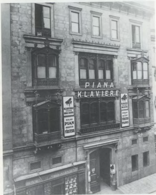
Průčelí Kleinova paláce. Fotografie z doby po r. 1905 (po 1918?) v Archivu města Brna. Reprodukce AMB
