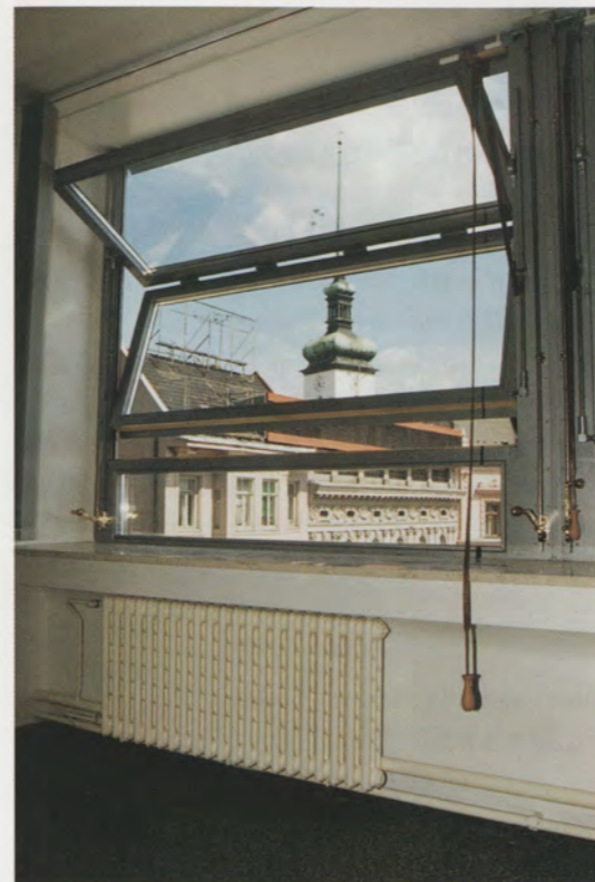
Krausovo okno; sklápění ovládané řemenovými pásy
