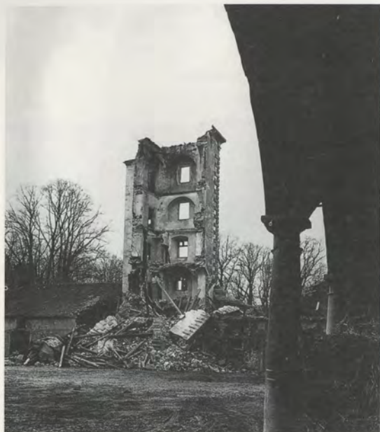
Destrukce renesanční věže – jižní křídlo vstupního arkádového nádvoří, listopad 1970.
