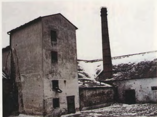
Pohled na budovu lihovaru ze strany hospodářského dvora.
