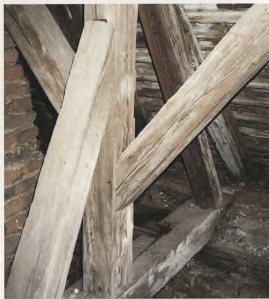
Detail renesančního krovu budovy kuchyně, rok 1996.
