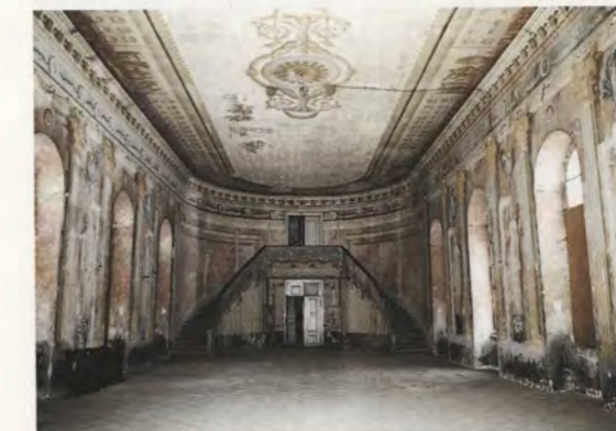
Pohled ke vstupu do banketního sálu, současný stav.
