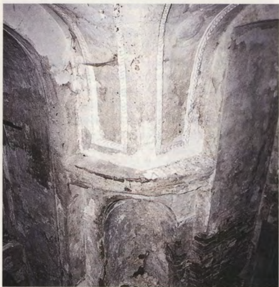
Zámecká kaple. Fotografie dokumentuje vysoký stupeň narušení omítkových vrstev a štukové výzdoby.
