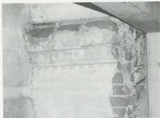
Sgrafitová výzdoba v prostoru krovu přízemního objektu hospodářské části u nároží jižního křídla zámku.
