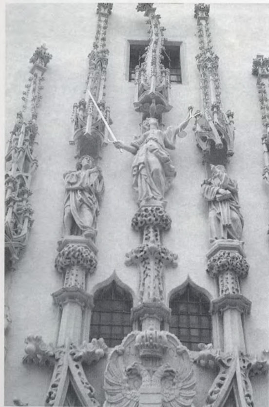
Střední část portálu; stav v roce 1999.
