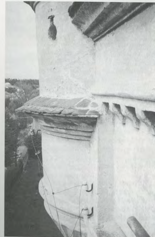
Plášť jihozápadní věžičky s otiskem odstraněné korunní římsy čelní zdi arkádového nádvoří.
