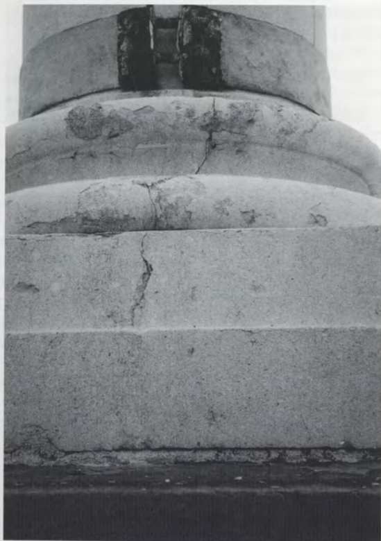
Detail plintu a patky sloupu s prasklinou.
