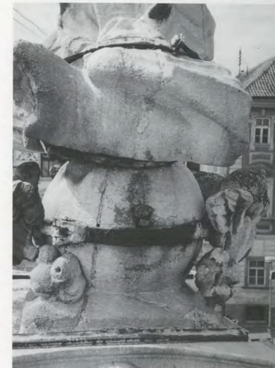
Detail základny sochy Immaculaty a zeměkoule před rozebráním.
