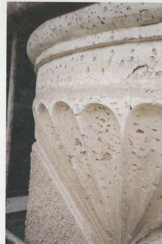
Detail východního polokruželu jihovýchodní věžičky se zbytky okrového nátěru.
