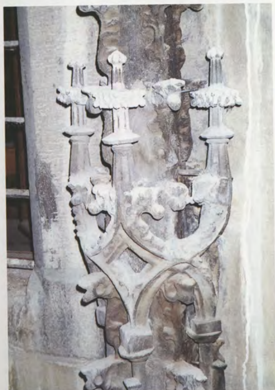
Detail fiály před započatím prací; květen 1997; foto D. Neuwirth.
