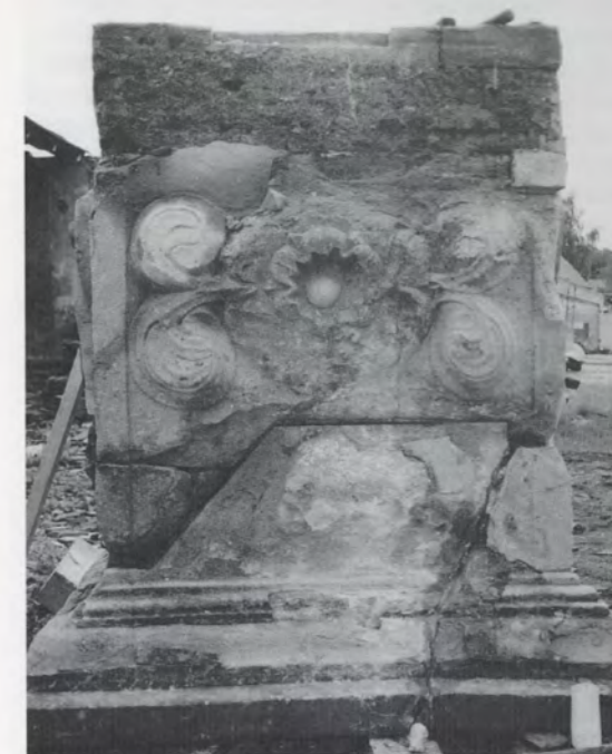
Hranolový podstavec sloupu po demontáži.
