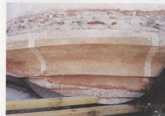
Původní barevná úprava jihozápadní nárožní věžičky arkádového nádvoří (okrový nátěr s bílými linkami na spodní římsě; červený pruh v místě omazání styku krytiny s tělesem věžičky).
