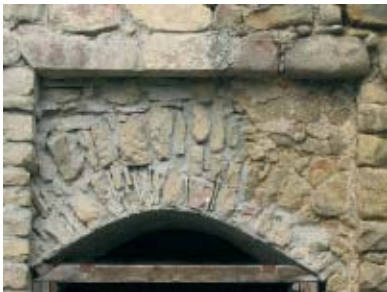
Obr. 7 Detail vnějšího vyústění průchodu v přízemí vstupní věže; záklenek i větší část plochy vpadliny pro padací most vyžděna nově; i když nové zdivo respektuje tvar původního záklenku i obrys niky pro padací most a jeho řemeslné provedení převyšuje kvalitu soudobých rekonstrukčních prací na hradě (1987), jeho výraz, daný především použitou maltou (cement) a jejím povrchovým zpracováním, je zcela nevhodný.
