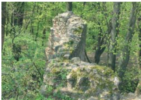
Obr. 21 Pohled shora na torzo bašty v západní části hradu; koruna zdiva byla zakonzervována v r. 1997 mírným nadezděním a přespárováním nastavenou maltou. I po letech je tato úprava poměrně trvanlivá, na některých místech se však objevují dílčí poškození vlivem mrazu. V daném prostředí je rovněž nutno dbát na to, aby se na koruně opět neuchytily náletové dřeviny.
