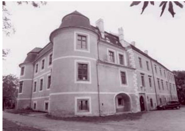
Zámek Police – pohled ze severozápadu.
