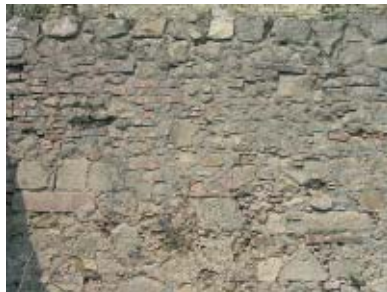
Obr. 8 Detail struktury zdiva v jižní části západního paláce – originální zdivo, vložené při renesanční přestavbě mezi starší konstrukce má specifickou strukturu líců – typické zde je použití cihel – často v krátkých horizontálních řadách či menších plochách – a starších kamenických článků. Na počátku 90. let došlo k vyspárování zdiva cementovou maltou s přídavkem chemického, provzdušňujícího prostředku (Ravenit HDP, technologická pomoc: Ing. Miluše Pospíšilová). Malta díky uvedené příměsi umožňuje omezené „dýchání“ jádra zdiva a neprojevují se zde výrazné degradační procesy originální konstrukce. Barva, struktura a zpracování malty (zahlazený a za líc zdícího materiálu zatlačenný, zcela hladký povrch) však představují nápadný výrazový defekt, který podstatně mění původní vzhled. V dolní části záběru je patrna touto úpravou nedotčená partie zdiva, zčásti krytá zbytky původních omítek.
