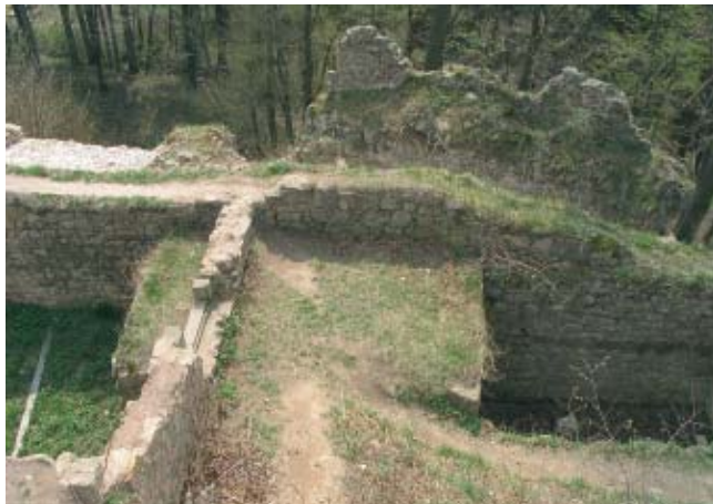
Obr. 19 Pohled na koruny zdiva jižní části západního paláce. Tyto koruny byly poměrně citlivým způsobem zpevněny v 80. letech 20. století, překryty vrstvou jílu a zadrnovány. Díky pravidelné údržbě byla tato úprava dlouho zcela funkční a esteticky kvalitní, dnes jsou však některé její části poškozeny „chodničky“ neukázněných návštěvníků. Nápravu by měla přinést chystaná redukce návštěvnosti hradu (vytyčení prohlídkové trasy a uzavření areálu pro volný vstup).
