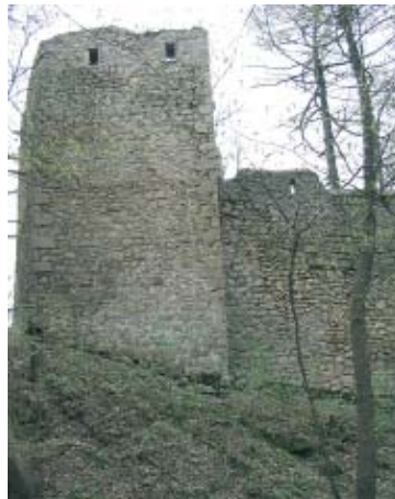
Obr. 20 Věž Svatojánska s přilehlou hradební zdí; věž v roce 2003 prošla výraznou stavební obnovou (doplnění chybějícího zdiva, osazení ostění okének, nová koruna zdiva). Nerovný průběh nové koruny vytváří velmi příjemný detail, souznící s přirozeným rozpadem modelovanými obrysy okolních hradebních zdí. Finální zadrnování koruny je poměrně snadno udržovatelné z interiéru věže.
