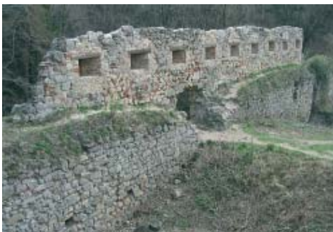
Obr. 10 Severovýchodní hradební zeď jádra s dochovanými zbytky poprsní zidky se střílnami; vzhledem k havarijnímu stavu poprsní zidky proběhlo v letech 2002–2003 její stavební zajištění. Na základě detailního průzkumu bylo možno provést poměrně přesnou tvarovou rekonstrukci střílnových otvorů. Do vylámaných otvorů po střílnách byly vsazeny dřevěné trámký, na vyzdění chybějících částí špalet a parapetů bylo použito starých cihel. Nové zdivo bylo zděno na mírně nastavenou vápennou maltu, která byla v líci strhávána zednickou lžící. Geometrický tvar výřezů střílen je poněkud potlačen nerovností koruny zdiva, celkový výraz práce, rovněž díky řemeslné zručnosti a použité technologii, vyznívá velmi příznivě.
