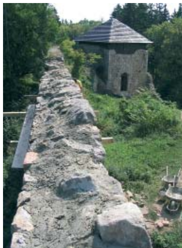
Obr. 19 Pohled na koruny zdiva jižní části západního paláce. Tyto koruny byly poměrně citlivým způsobem zpevněny v 80. letech 20. století, překryty vrstvou jílu a zadrnovány. Díky pravidelné údržbě byla tato úprava dlouho zcela funkční a esteticky kvalitní, dnes jsou však některé její části poškozeny „chodničky“ neukázněných návštěvníků. Nápravu by měla přinést chystaná redukce návštěvnosti hradu (vytyčení prohlídkové trasy a uzavření areálu pro volný vstup).
