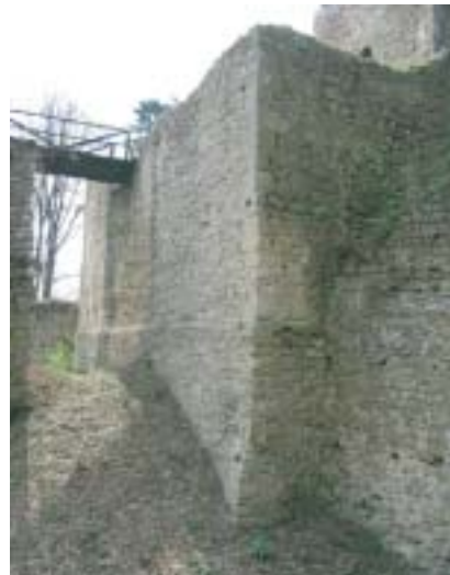
Obr. 9 Pohled na objekt mohutného předbraní, jehož části byly v roce 1992 podrobeny stavebním úpravám. Cílem úprav bylo zacelení rozměrné jizvy v ose průčelí a sanace silně narušených korun zdiva; v rámci zásahu bylo provedeno i vyspárování celého hlavního průčelí cementovou maltou, opět s přísadou chemického prostředku. Úprava líce zdiva se i po letech jeví jako technicky stabilní, díky odlišné struktuře a barvě použité malty však vytváří monolitický blok, který pohledově nezapadá do okolního prostředí, určovaného pestrou paletou originálních líců hradebních zdí.
