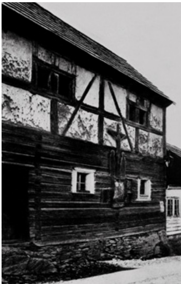
Obr. 2 Rabštejn nad Střelou – okres Plzeň-sever, Domovní zástřita čp. 36.
