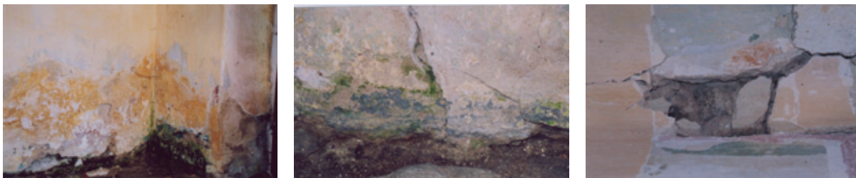
Degradace byla způsobena vztlínáním vlhkosti i samotnými konstrukčními nedostatky stavby.
