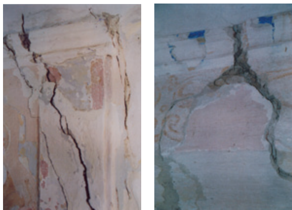
Havrijní stav byl zaznamenán zejména v severozápadním rohu kaple, na nároží oltářní stěny, u okenních a dveřních záklenků.
