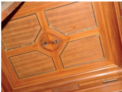
Strop kabiny, ve středu stropu chybějící lampa, před započítím prací.
