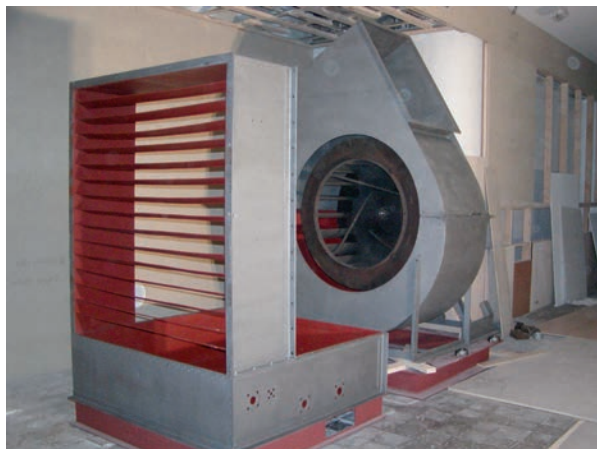
Strojovna klimatizace, ustavování rozměrných dílů v místě konečné instalace.
