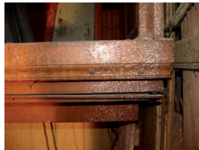
Poškozený práh, viditelná utržená lišta, před započítím prací.
