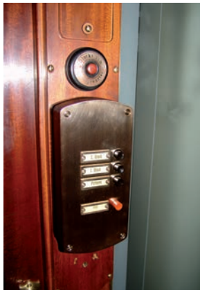
Detailní pohled na ovladač kabiny po ukončení restaurátorských prací.
