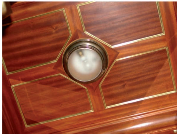
Detailní pohled na strop po ukončení restaurátorských prací.
