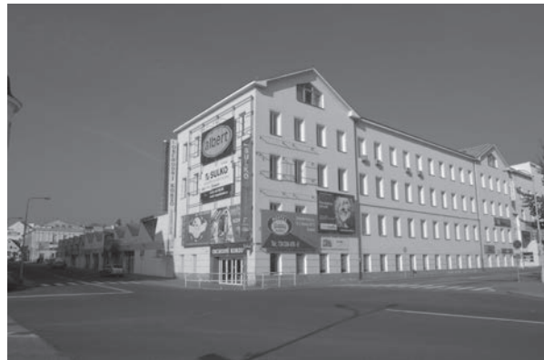
Obr. 7 Bývalá tkalcovna firmy Karl Siegl sen. v Šumperku, současný stav.
