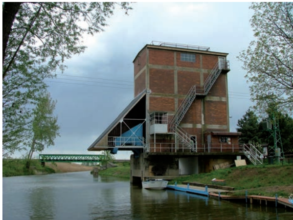
Výklopník s odkrytou výsypkou; v pozadí ocelový nýtovaný příhradový most vyrobený ve Vítkovických železárnách v roce 1889.
