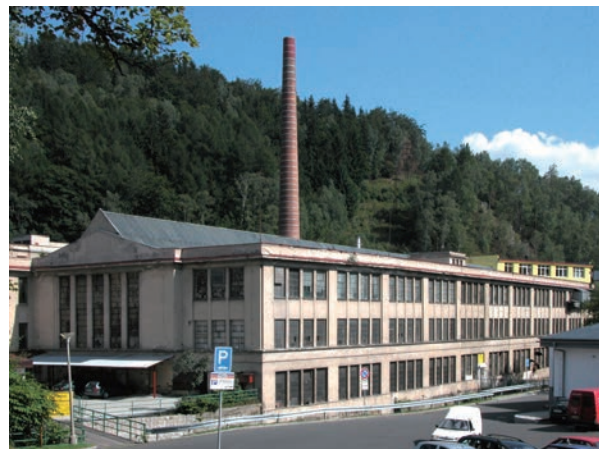
Obr. 6 Hala slévárny a. s. Tanvaldská přádelna bavlny, Tanvald, 2006. Foto Lukáš Beran.
