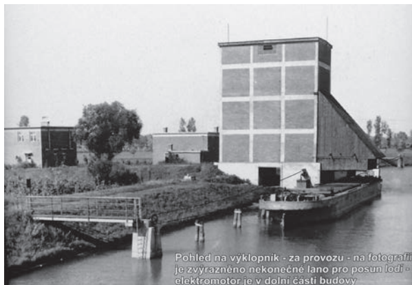
Pohled na areál výklopníku. Dobová fotografie z roku 1938 od neznámého autora.
