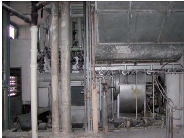
Strojovna klimatizace v průběhu demontážních prací, celkový pohled.
