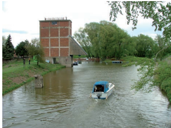
Pohled na výklopník s rejdou.
