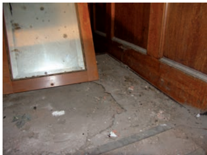
Těžce devastovaná podlaha kabiny s poškozeným linoleem, před započítím prací
