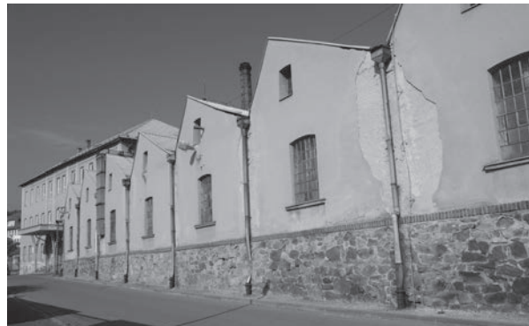
Obr. 18 Bývalá továrna firmy W. Lubich & Sohn v Šumperku, současný stav.
