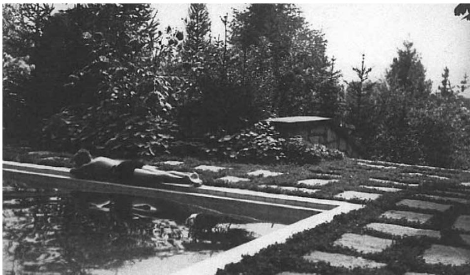
Obr. 47: Bazén ve 30. letech 20. století (archív NPÚ, ÚOP v Brně)
