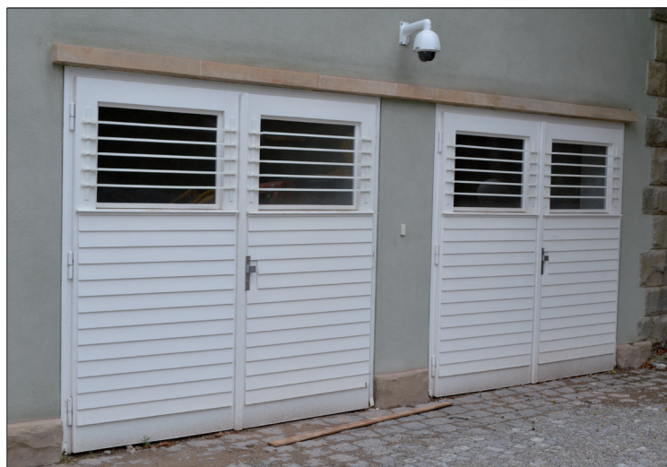
Obr. 8: Brno, objekt v areálu villy Stiassni. Dvoukřídlá garážová vrata usazená v kovové zárubni. Venkovní výplně jsou řešeny dřevěnými lamelami.
