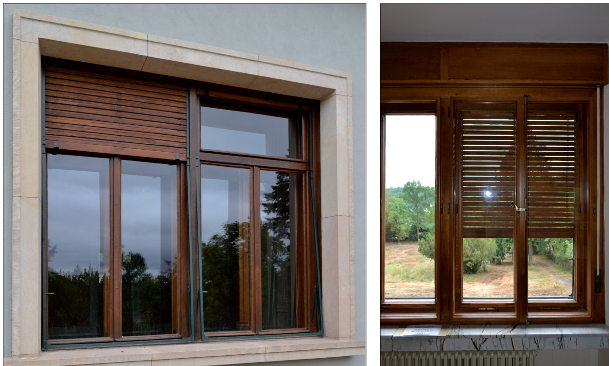
Obr. 30: Brno, vila Stiassni. Okno s dřevěnými lamelovými roletami. V horní části okna je dřevěné krytí osazené venkovní rolety včetně postranního ovládacího mechanismu, který je zabudován v hlavním okenním rámu.
