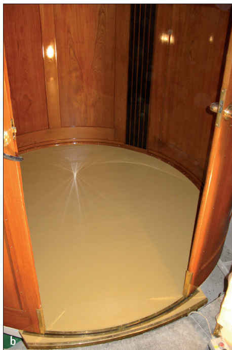
Obr. 52: Praha, Pražský hrad. a – dřevěná kabina válcového typu prezidentského výtahu z roku 1926; b – detail vstupu; (dle J. Plečnika).
