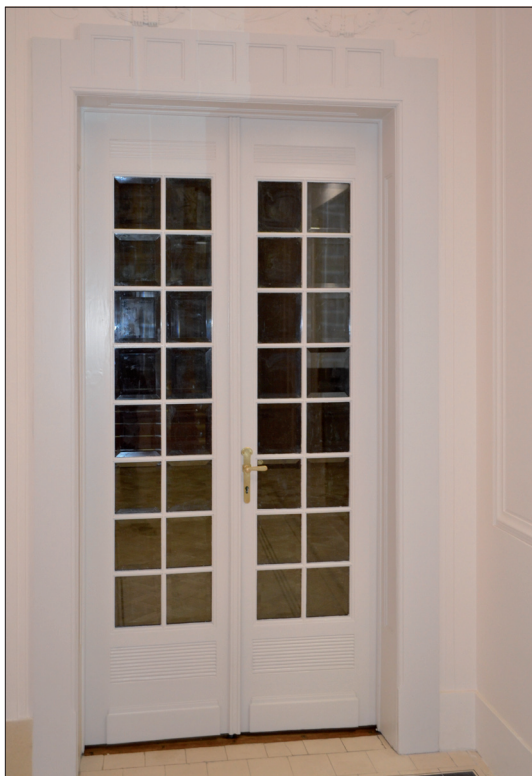
Obr. 20: Brno, Löw-Beerova vila. Dvoukřídlé celoprosklené interiérové dveře s výplněmi z čirého fasetového skla.
