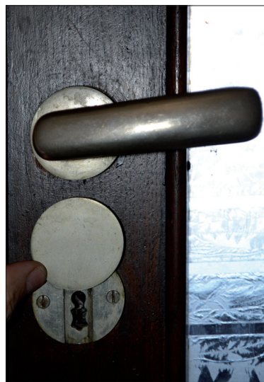
Obr. 37: Brno, Minská ulice, nájemní dům z roku 1938–1939. Velmi dobře dochované dveře v přízemí hlavního schodiště včetně původního zasklení ledovým sklem a poniklovaného dveřního kováří.
