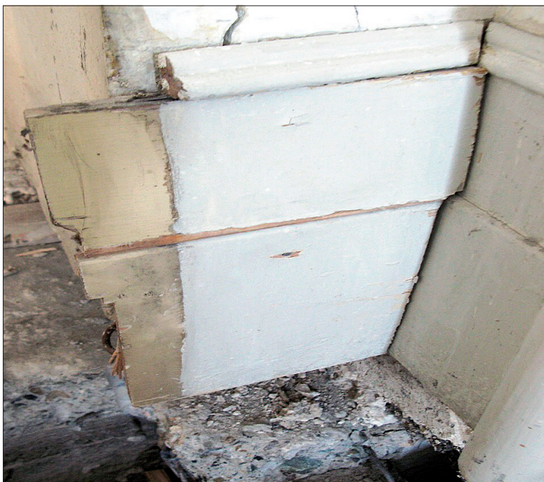
Obr. 65: Brno, vila Stiassni. Nález původní barevnosti na dřevěném obkladu, učiněný až v průběhu rekonstrukce.
