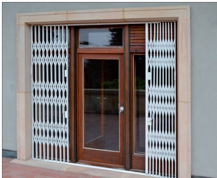
Obr. 9: Brno, vila Stiassni. Exteriérová dřevěná prosklená stěna s dveřmi z dubového dřeva. Stav po úplné obnově venkovní i vnitřní povrchové úpravy.
