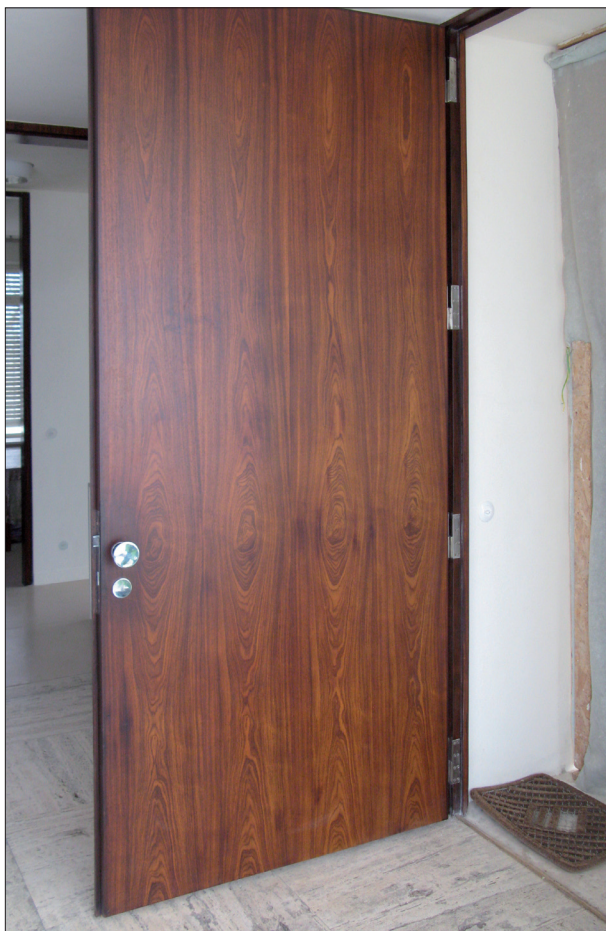
Obr. 11: Brno, vila Tugendhat. Nadstandardní provedení exteriérových jednokřídlých vstupních dveří dýhovaných dýhou z východoindického palisandru.
