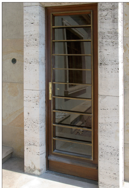
Obr. 66: Brno, vila Stiassni. Vnější jednokřídlé prosklené dveře z masivního dubového dřeva. Na exteriérové straně je jednoduchá mříž. Na dveřích se zachovalo původní kování v podobě mosazných závěsů a klíky se štítky rovněž z lité mosazi (polovina klíky chyběla). Při obnově byla za použití dubového masivu a silné dubové švartny opravena poškozená okapová lišta na spodní části křídla i spodní příčka rámu dveří. Pro novou povrchovou úpravu byla zvolena silnourstvá barevná lazura od firmy Herbol.
