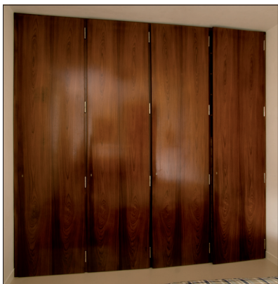
Obr. 41 a, b: Brno, vila Tugendhat. Pánský pokoj s vestavěnou šatní skříní. Dveřní křídla jsou na povrchu dýhována dýhou z východoindického palisandru. Vnitřek skříní je dýhován v dýze javorové.
