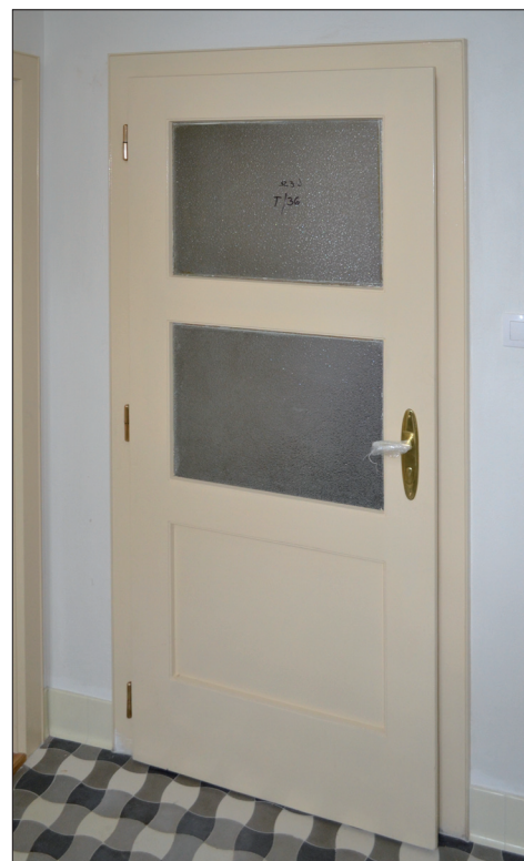
Obr. 22: Brno, vila Stiassni. Interiérové jednokřídlé, částečně prosklené dveře s dochovaným mrazovým sklem ve vstupu do kuchyně.
