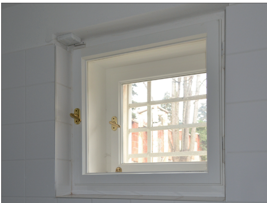
Obr. 24: Brno, vila Stiassni. Jednokřídlé zdvojené okno ve vstupním objektu (byt řidiče).
