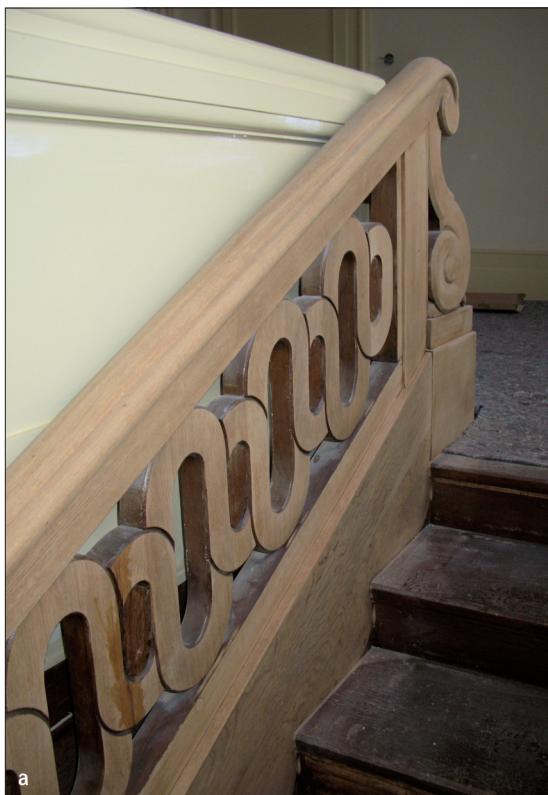
Obr. 51: Brno, vila Stiassni. Tvarované dřevěné zábradlí hlavního schodiště. Zábradlí s madlem je složeno z několika částí vyrobených z dubového masivu.
