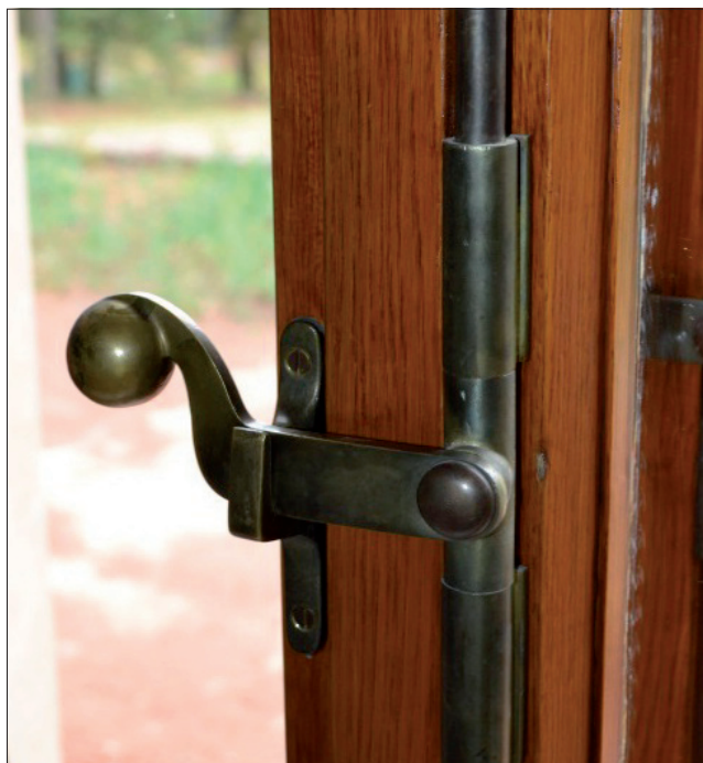
Obr. 27: Brno, vila Stiassni. Dvojité vícekřídle okno. Rámy i křídla byly vyrobeny z dubového masivu. Okna se zachovala se včetně původního kování (mosazné panty). Uzavírání je řešeno pomocí mosazné otočné tyče se středovou závorou. Původní venkovní povrchová úprava rámu i křídel, provedená transparentním nitrocelulózoovým lakem, byla zcela dožilá. Po opravě defektů, zčásti i odýhování novou dubovou dýhou, byla pro nový nátěr vybrána silnovrstvá barevná lazura firmy Herbol, nanesená ve třech vrstvách. V interiéru byla použita obarvená lazura stejné firmy.
