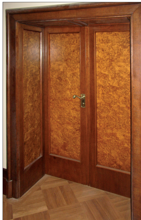
Obr. 17: Brno, vila Stiassni. Interiérové dvoukřídlé kazetové dveře s kazetovým obkladem ostění. Rámová konstrukce dveří a obkladu mořená dubová dýha, kazetové výplně březová kořenice.
