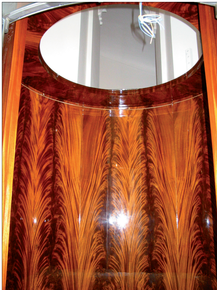
Obr. 53: Praha, Pražský hrad. Dřevěná kabina válcového typu druhého prezidentského výtahu (vybudován v takzvaném křídle kanceláře první dámy prezidenta republiky) z roku 1935 dle návrhu O. Rottmayera s ušlechtilou mahagonovou dýhou (stav při obnově 2007).
