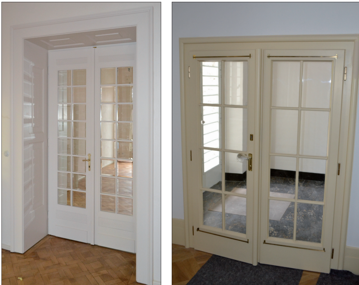
Obr. 15: Interiérové, zcela prosklené dveře s porchovou úpravou v bílém a lomeném emailovém laku (takzvané slonové kosti).
