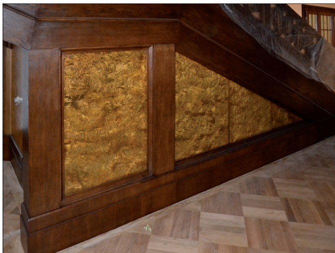
↑ Obr. 50: Brno, vila Stiassni. Podschodišťový prostor hlavního schodiště, uzavřený hladkými kazetovými výplněmi, osazenými v profilovaných rámech. Výplně jsou dýhované očkovou topolovou kořenicí.
