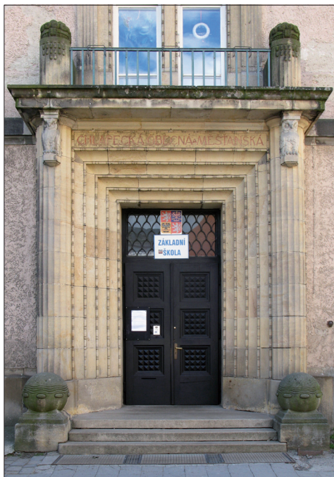
Obr. 2: Uherské Hradiště, obecná a měšťanská chlapecká a dívčí škola z roku 1912–1913 (projekt L. Skřivánek). Vstupní dveře (stav před obnovou a po obnově).
