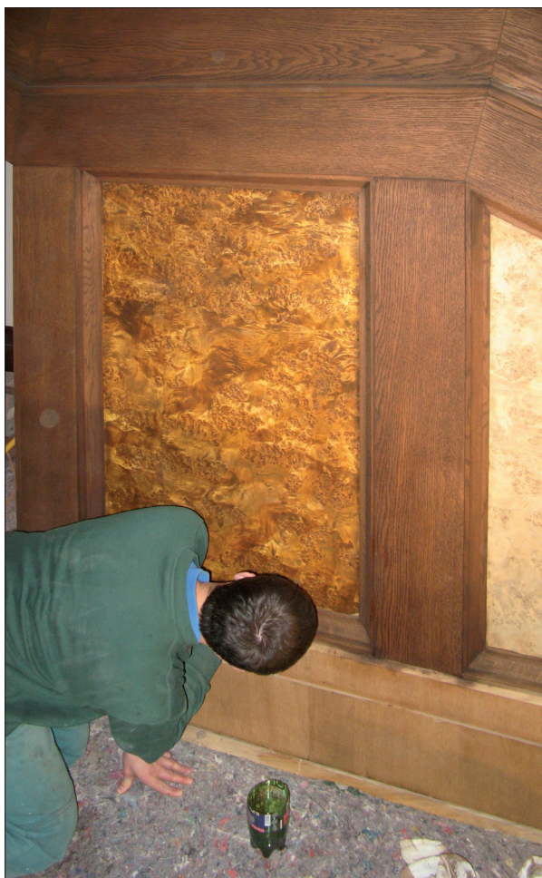
Obr. 67: Brno, vila Stiassni. Dřevěný kryt radiátoru spojený s obložení ostění okna: a – drobné defekty u dvířek s ratanovou výplní byly opraveny; b – při větším poškození byl zhotoven nový výplet.
