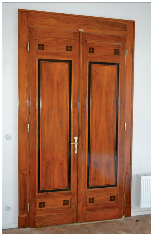
Obr. 16: Brno, Löw-Beerova vila. Interiérové dvoukřídlé kazetové dveře z třešňového dřeva, doplněné intarzovaným ornamentem.
