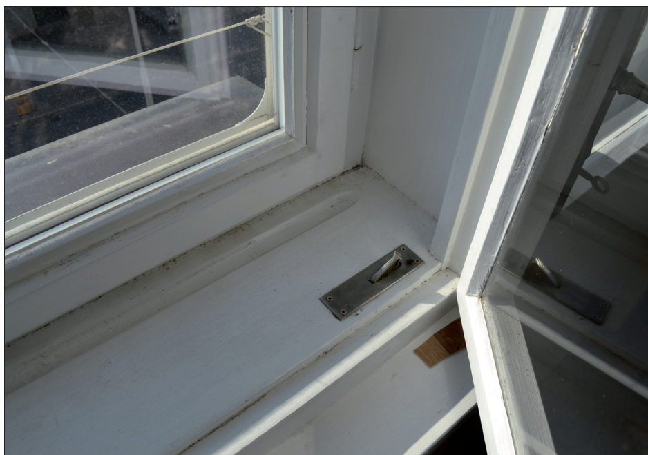
Obr. 4: Členitější obvodová profilace jednotlivých okenních křídel a rámců u zdvojených oken, omezující průnik chladného vzduchu.
