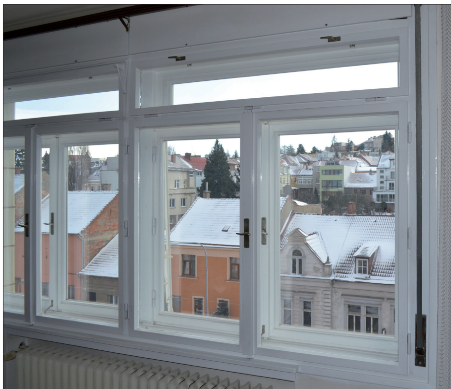
Obr. 25: Brno, Minská ulice, nájemní dům z roku 1938–1939. Vícekřídlé zdvojené okno v horní části s vyklápěcími křídly (ventilačky).
