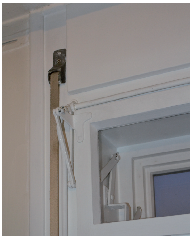
Obr. 26: Brno, Minská ulice, nájemní dům z roku 1938–1939. Ukázky původního mechanismu výklopných křídel.
