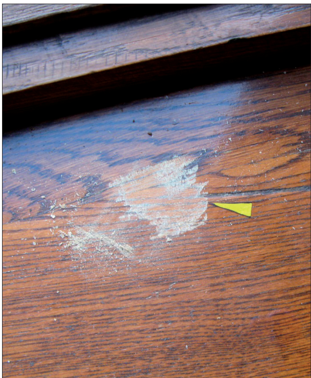
Obr. 60: Brno, vila Stiassni. Odebrání vzorku povrchové úpravy výjimečně tvrdým transparentním lakem na vnitřní parapetní desce dvojitého vícekřídlého okna.
