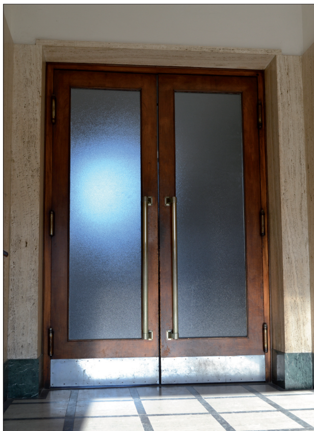
Obr. 57: Brno, Minská ulice, nájemní dům z roku 1938–1939. Zcela dochované dvoukřídlé prosklené dveře včetně veškerého původního kování mezi vstupní chodbou a hlavním schodištěm.
