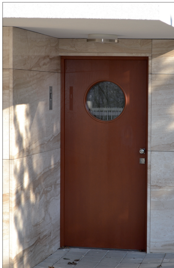
Obr. 12: Vstupní dveře s částečným prosklením v podobě kajutového okénka.
