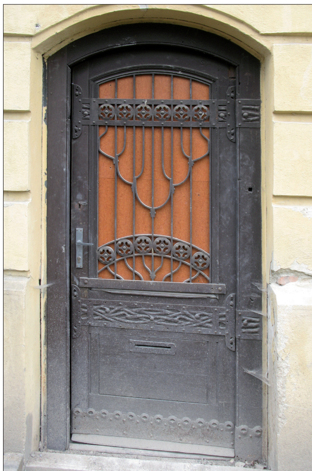
Obr. 55: Brno, Löw-Beerova vila. Boční vstupní dveře. Stav před obnovou. Ve dveřích není původní skleněná výplň a chybí původní kovaná dveřní klíka.
