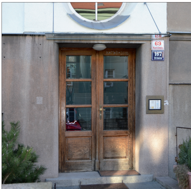
Obr. 9: Brno, vila Stiassni. Exteriérová dřevěná prosklená stěna s dveřmi z dubového dřeva. Stav po úplné obnově venkovní i vnitřní povrchové úpravy.
