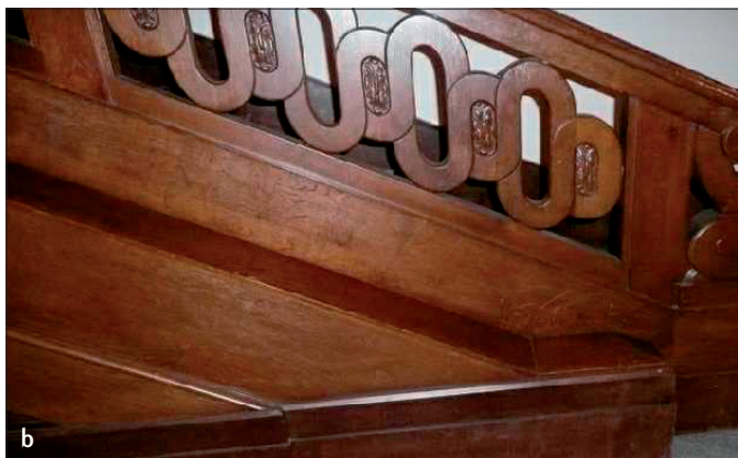
Obr. 51: Brno, vila Stiassni. Tvarované dřevěné zábradlí hlavního schodiště. Zábradlí s madlem je složeno z několika částí vyrobených z dubového masivu.
