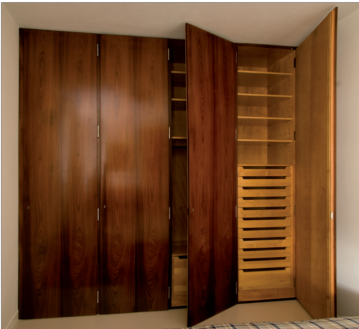
Obr. 41 a, b: Brno, vila Tugendhat. Pánský pokoj s vestavěnou šatní skříní. Dveřní křídla jsou na povrchu dýhována dýhou z východoindického palisandru. Vnitřek skříní je dýhován v dýze javorové.
