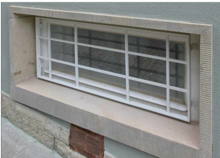
Obr. 23: Brno, areál vily Stiassni, dům zahradníka. Jednoduché jednokřídlé okno s jednoduchým rámem a zasklením.
