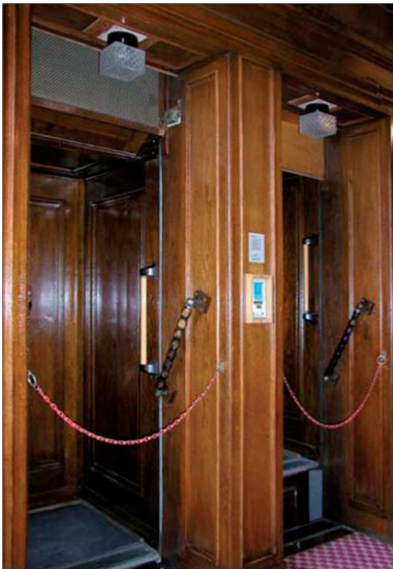
Obr. 54: Praha, Pečkův palác z let 1923 až 1929. Kabina výtahu „páternoster“.
