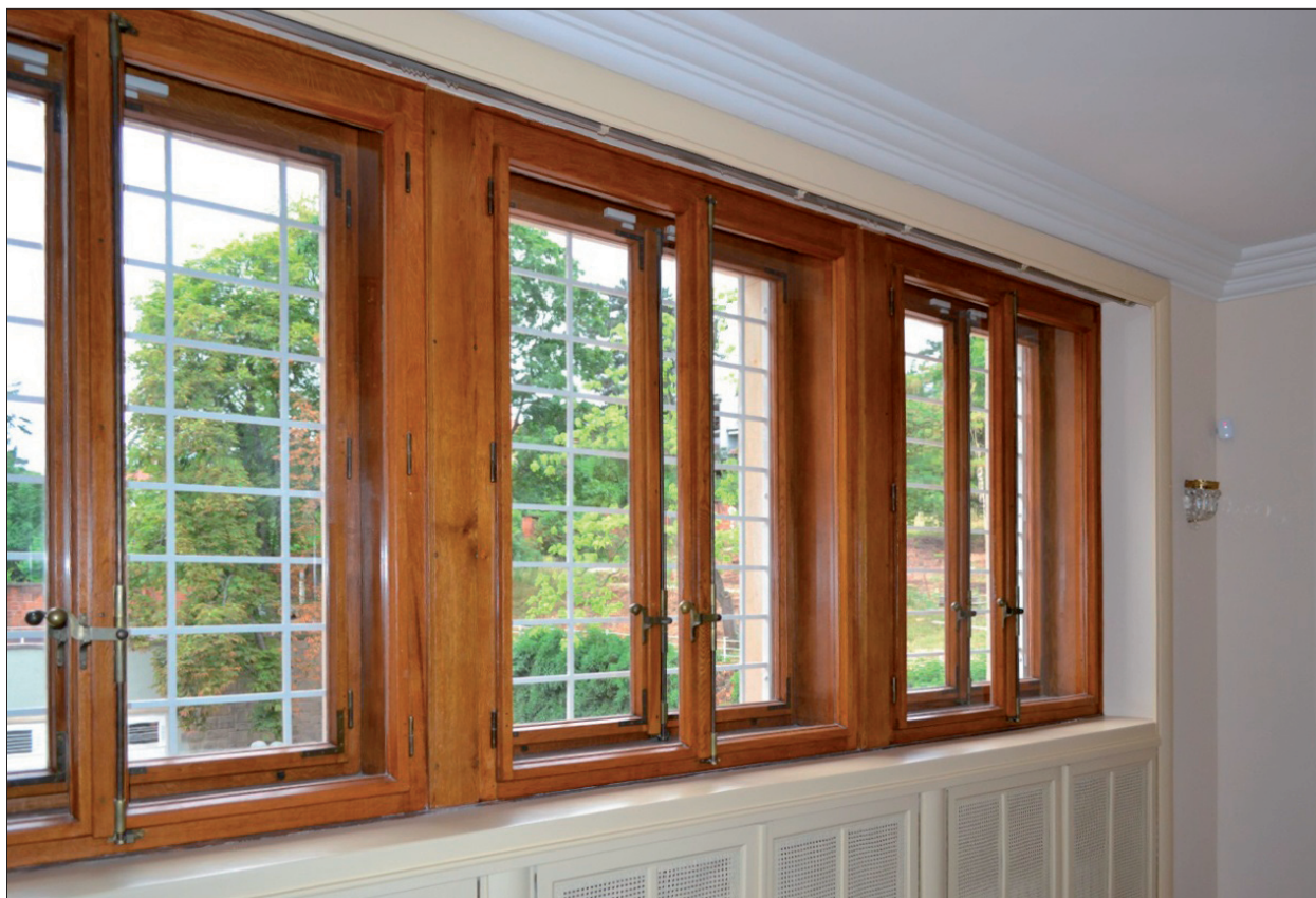
Obr. 27: Brno, vila Stiassni. Dvojité vícekřídle okno. Rámy i křídla byly vyrobeny z dubového masivu. Okna se zachovala se včetně původního kování (mosazné panty). Uzavírání je řešeno pomocí mosazné otočné tyče se středovou závorou. Původní venkovní povrchová úprava rámu i křídel, provedená transparentním nitrocelulózoovým lakem, byla zcela dožilá. Po opravě defektů, zčásti i odýhování novou dubovou dýhou, byla pro nový nátěr vybrána silnovrstvá barevná lazura firmy Herbol, nanesená ve třech vrstvách. V interiéru byla použita obarvená lazura stejné firmy.
