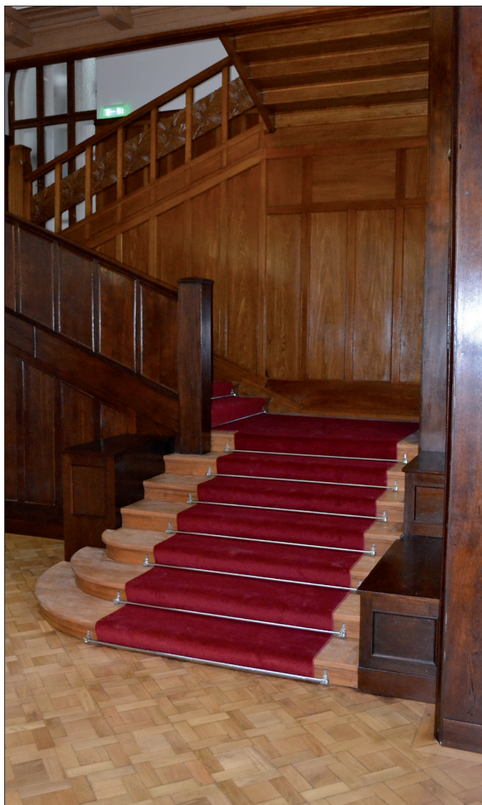
Obr. 48: Brno, vila Stiassni. Dřevěná parapetní deska postranního schodiště. Vyrobeno z masivního dubového dřeva. Na základě stratigrafického průzkumu byl odstraněn nepůvodní šedobílý krycí nátěr a bylo prezentováno autentické provedení v přírodním dubovém dřevě a dýže s nátěrem lehce tónované silnovrstvé lazury firmy Herbol.
