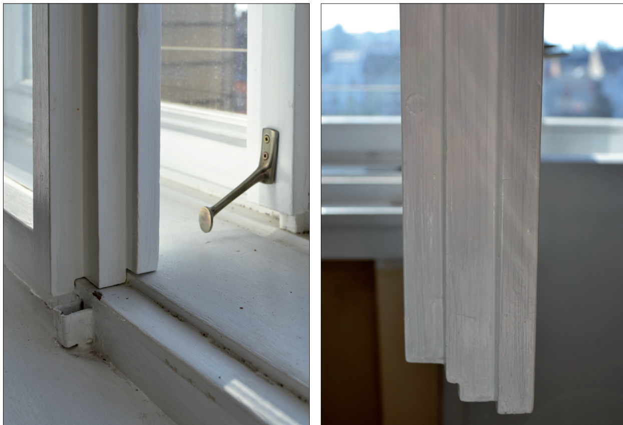
Obr. 4: Členitější obvodová profilace jednotlivých okenních křídel a rámců u zdvojených oken, omezující průnik chladného vzduchu.
