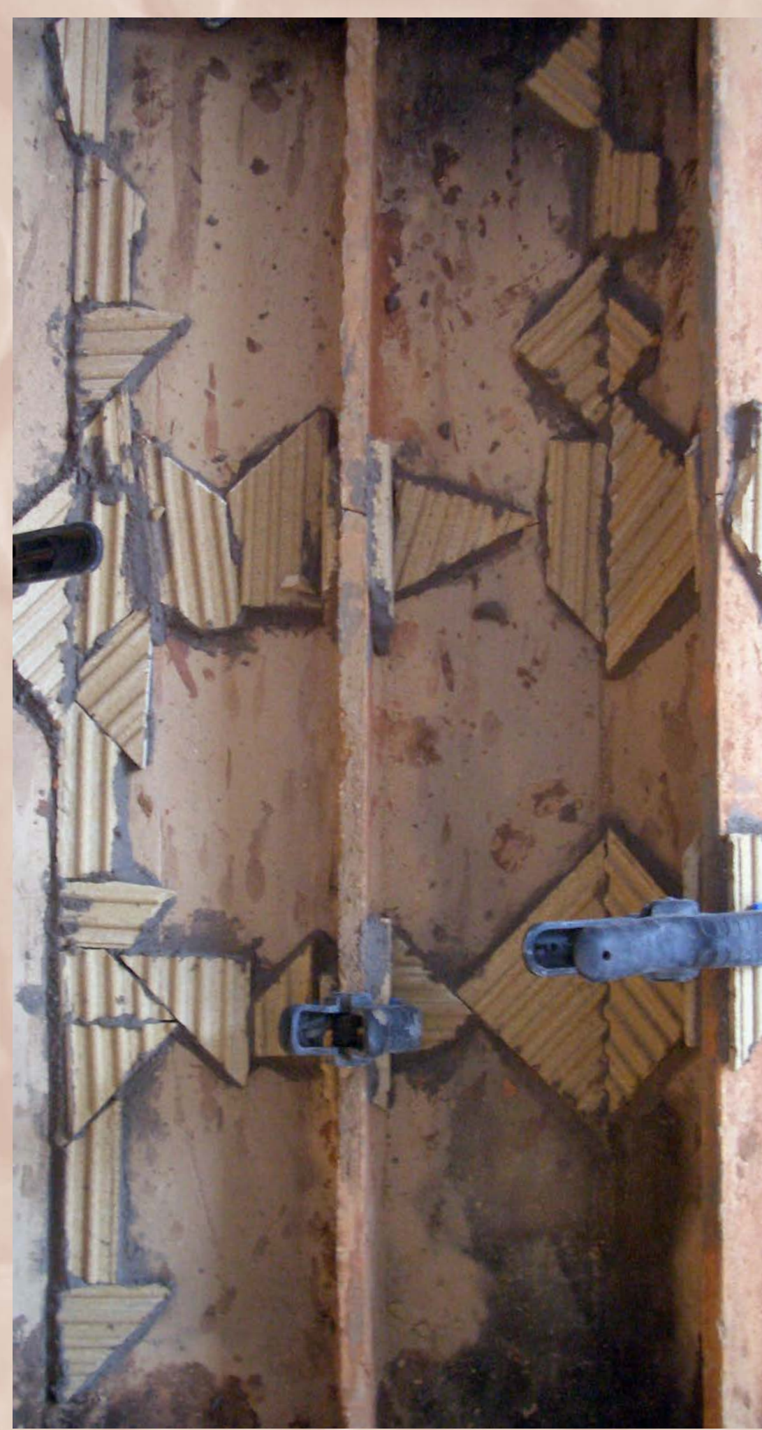
Vnitřní zajištění spojů keramickými žáruvzdornými plombami
