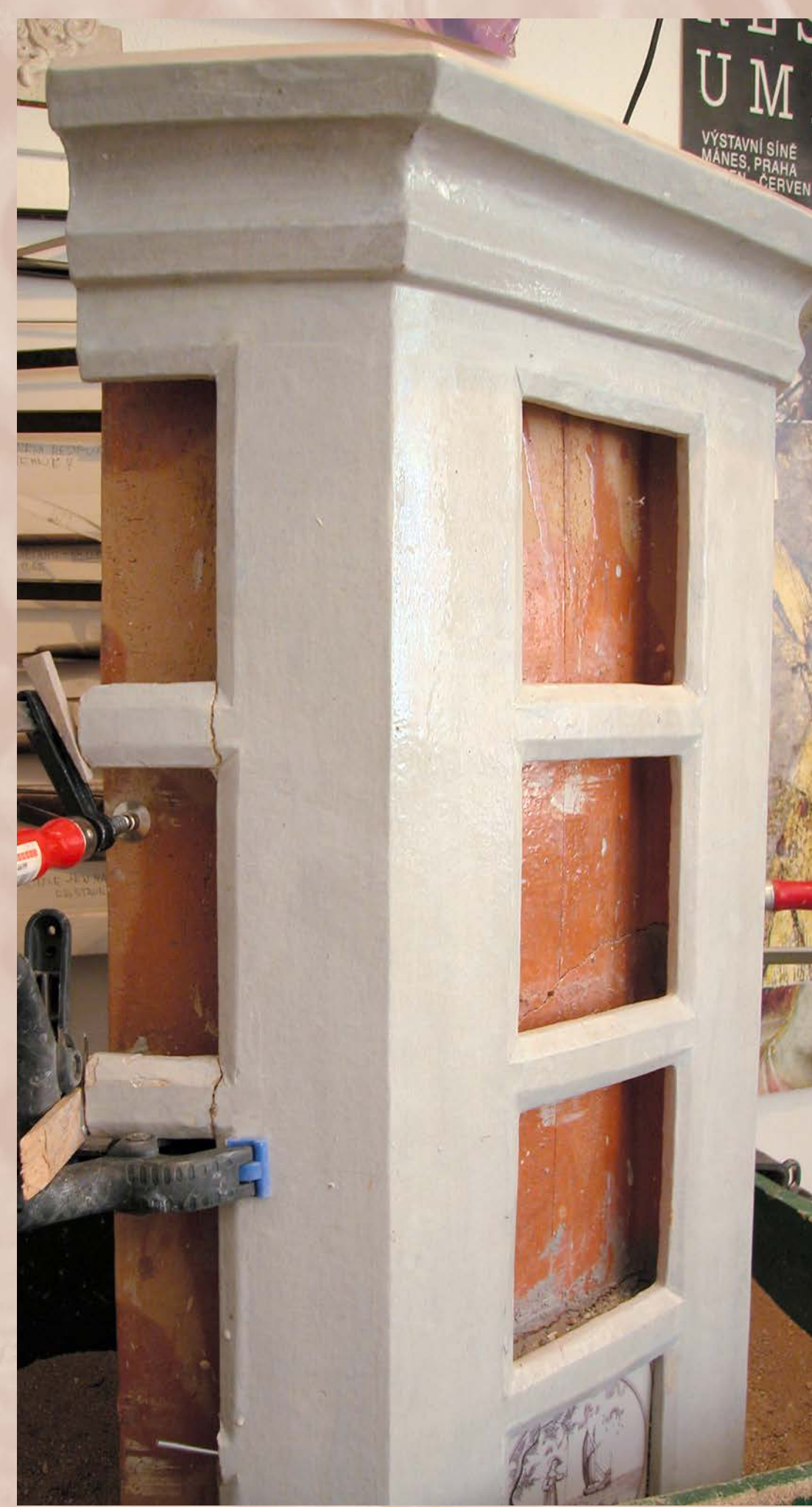
Lepení odlomených částí a jejich fixace ve správné poloze pomocí svorek
