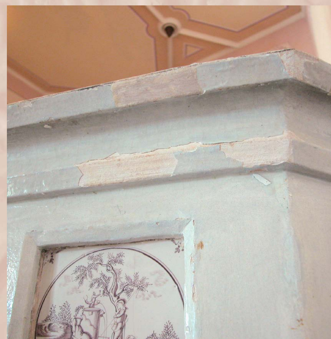
Odpadávání glazury a engobové mezivrstvy v důsledku dlouhodobého provlčnění
