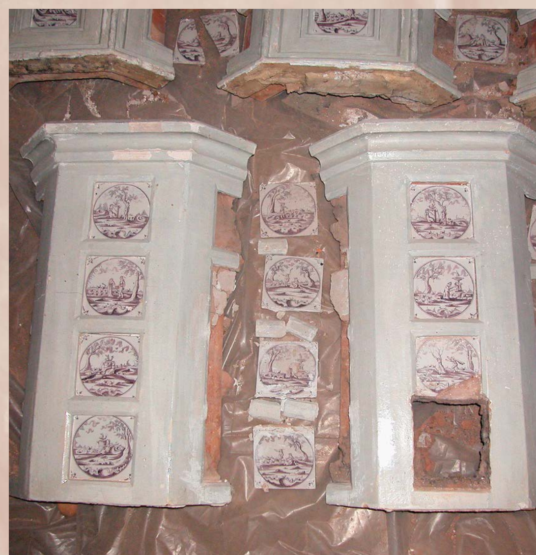
Odlomené části mřížky, uvolněné po odebrání kamnářských výplní při demontáži kamen
