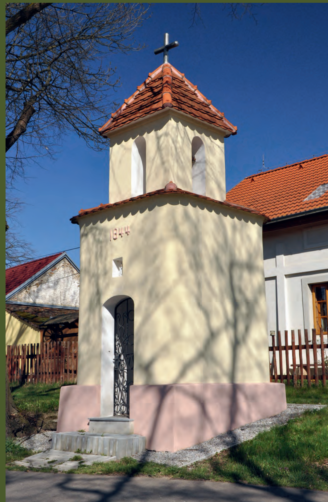
Čavyně (ST) – návesní kaple sv. Jana Nepomuckého, počátek 19. století, úprava 1844, stav 2018
