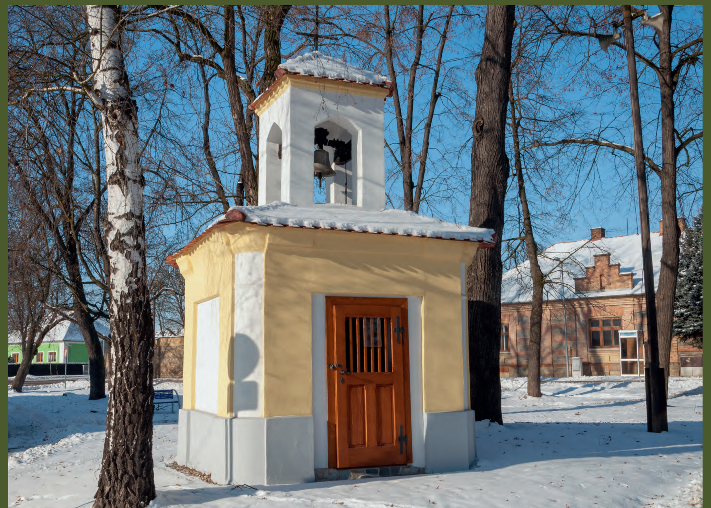
Čejkovice (CB) – návesní kaple sv. Jana Nepomuckého, před 1827, stav v roce 2017
