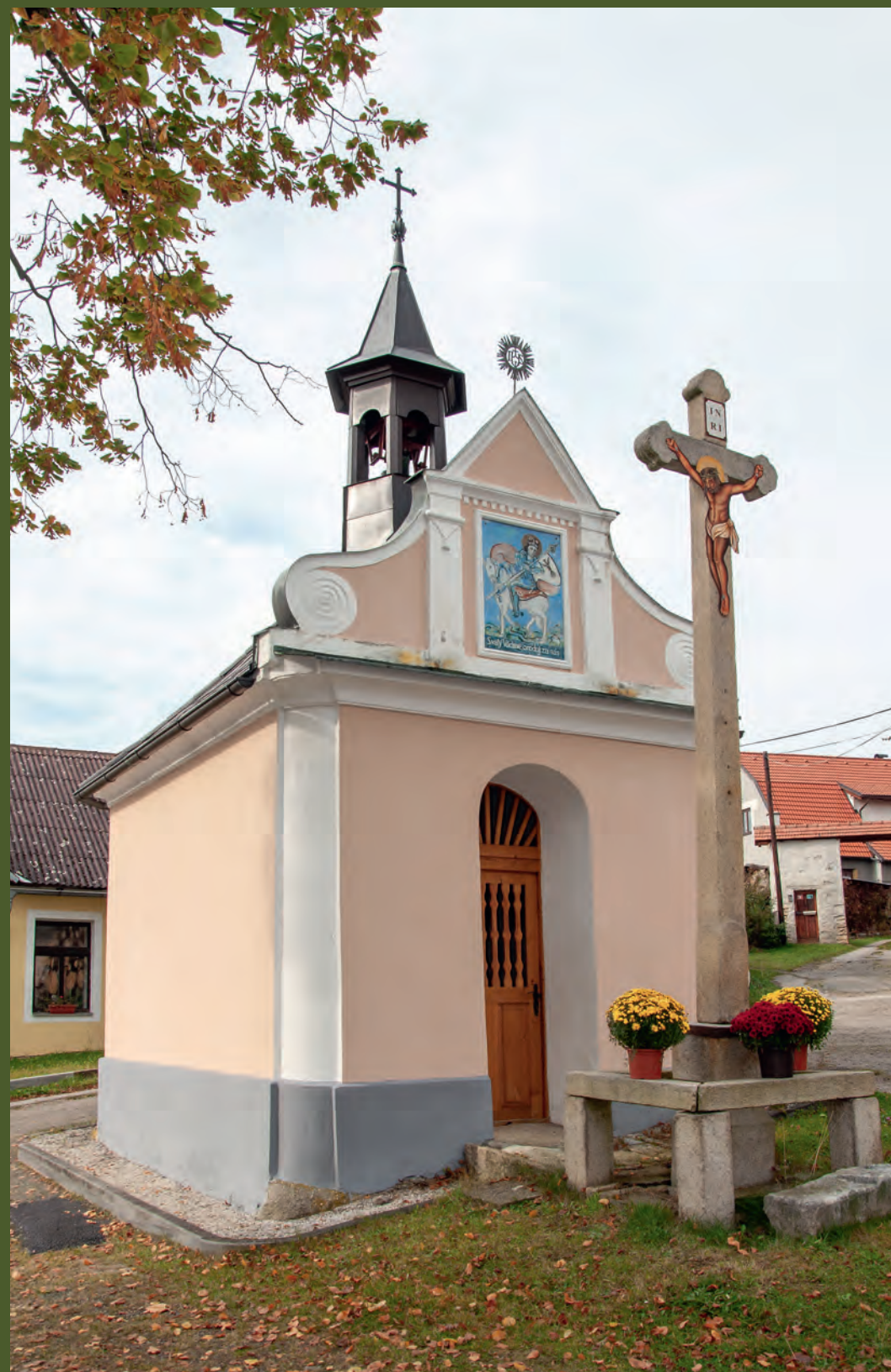
Lčovice (PT) – kaple Panny Marie Bolestné, po 1850, stav 2020
