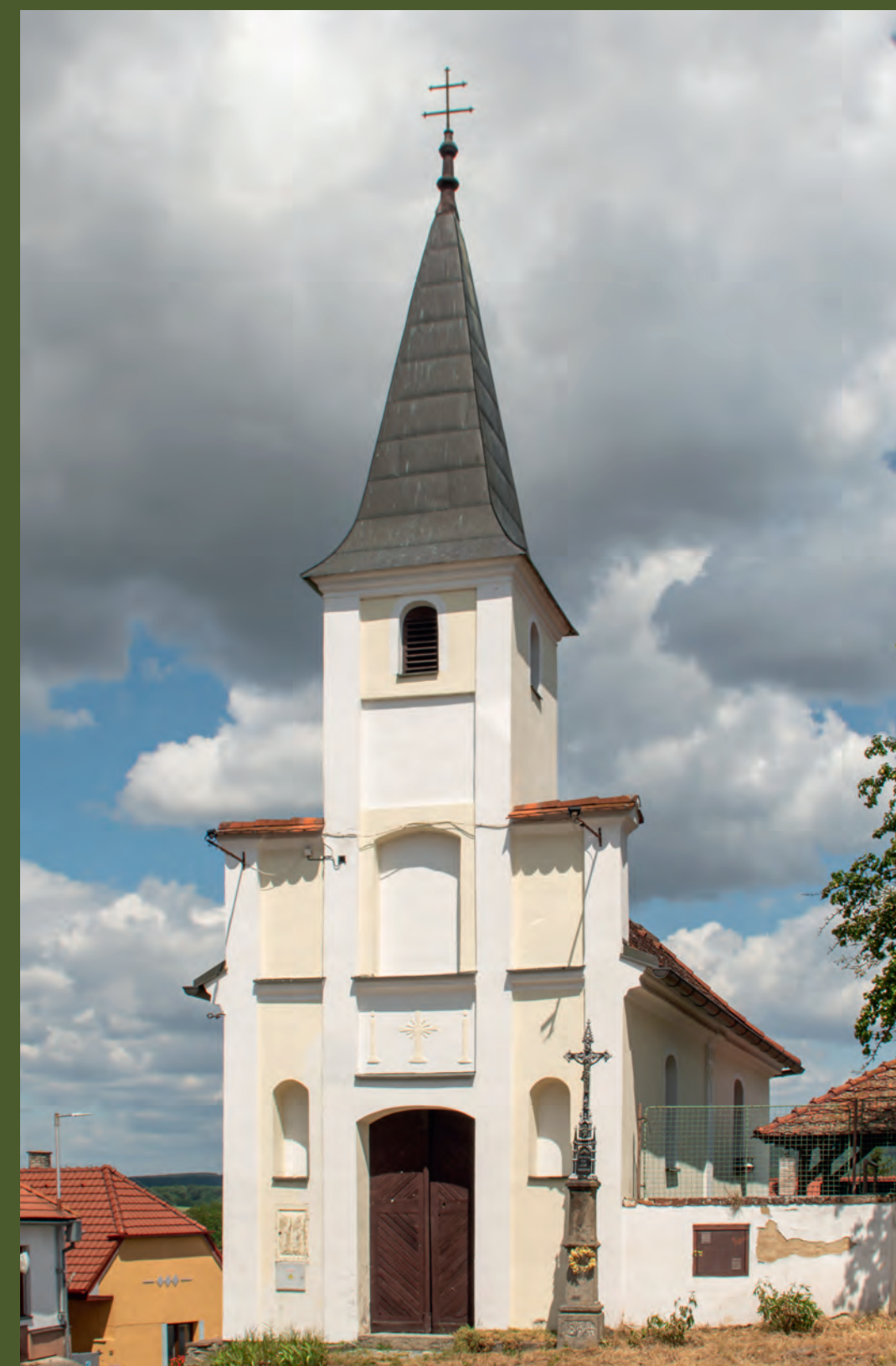
Mnichov (ST) – kaple sv. Vojtěcha, 1869, stav 2026
