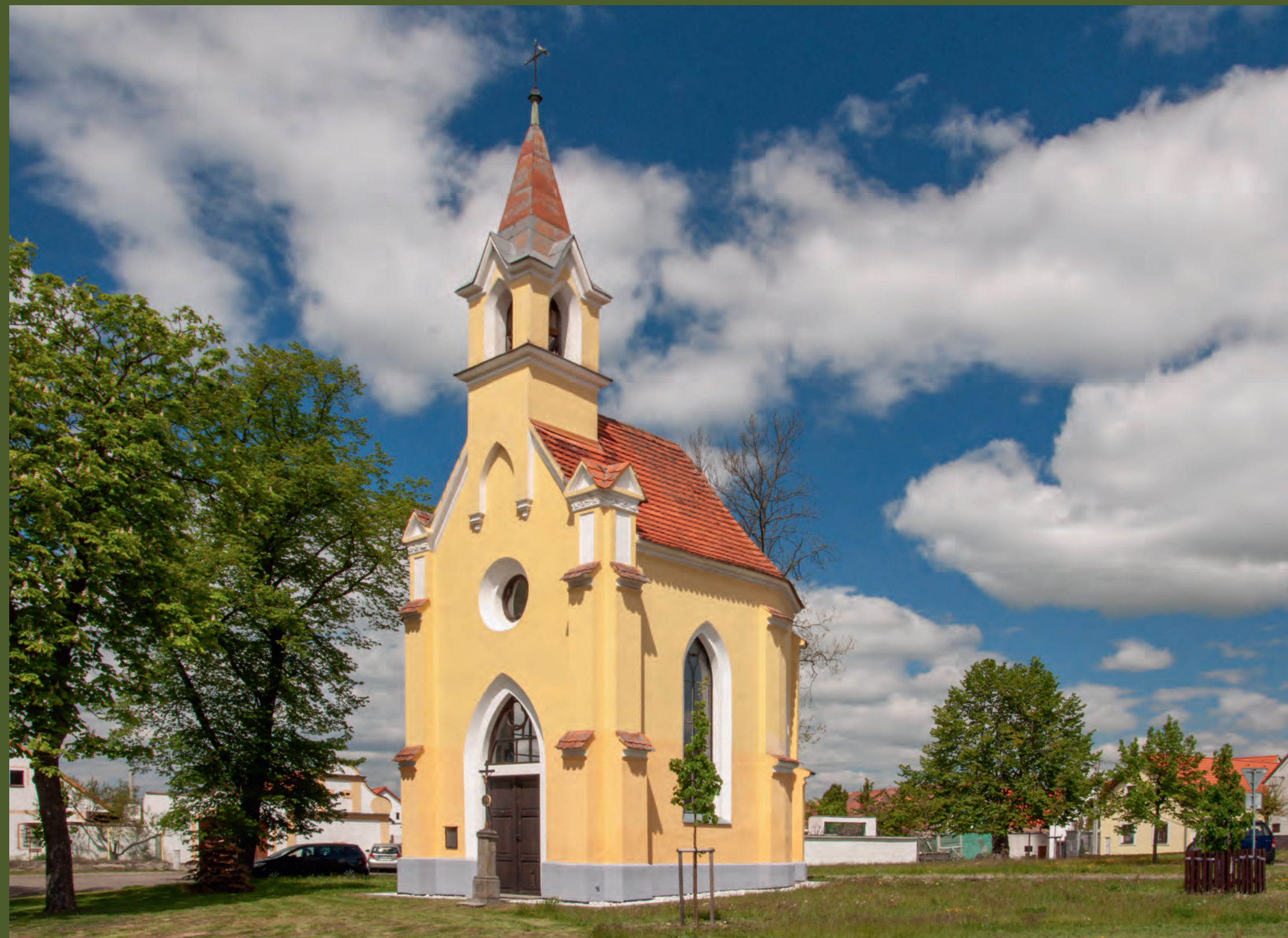
Radošovice (ST) – kaple Panny Marie, 1887, stav 2018
