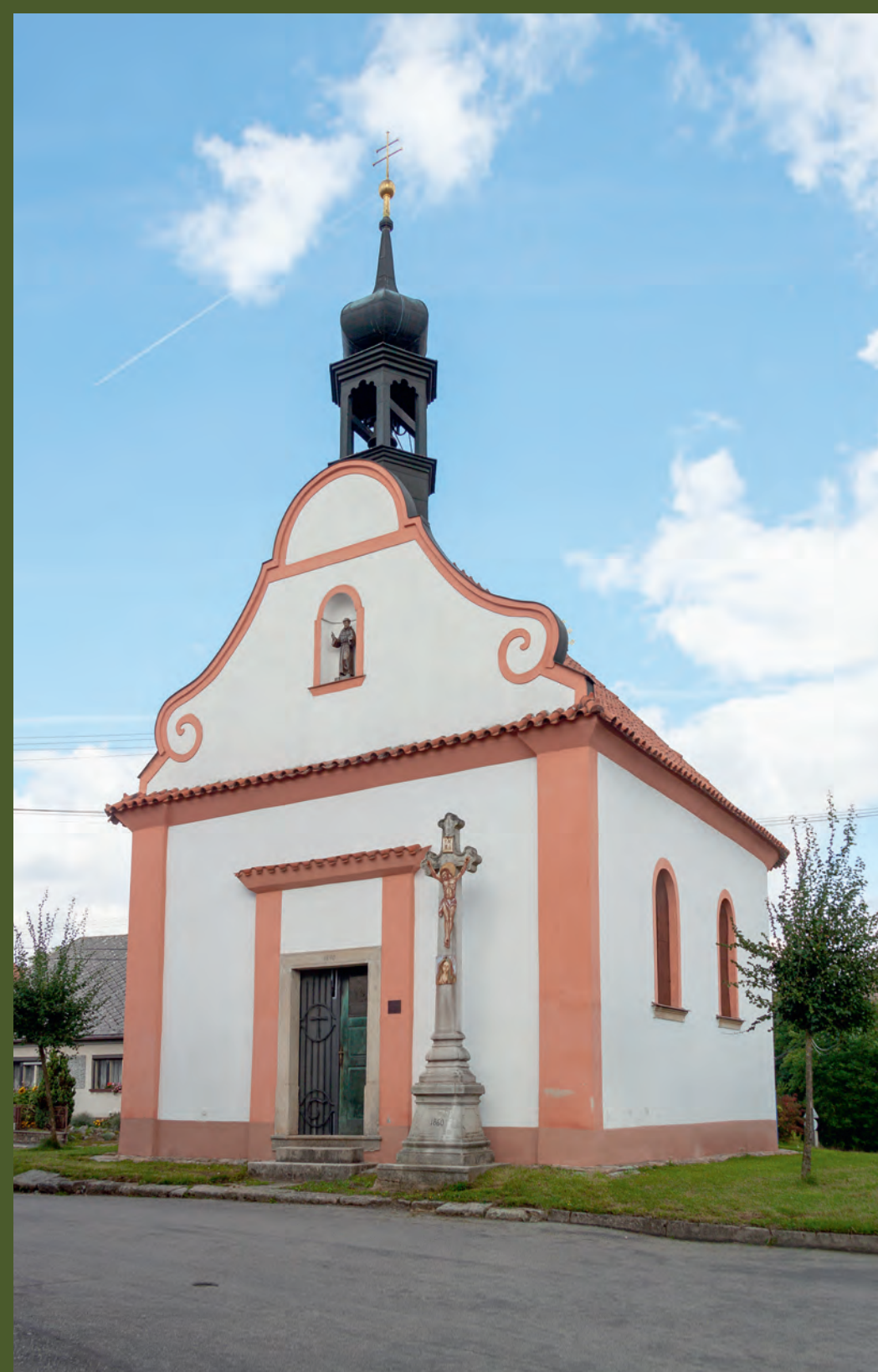
Červený Hrádek (JH) – návesní kaple Navštívení Panny Marie, 1843, stav 2021
