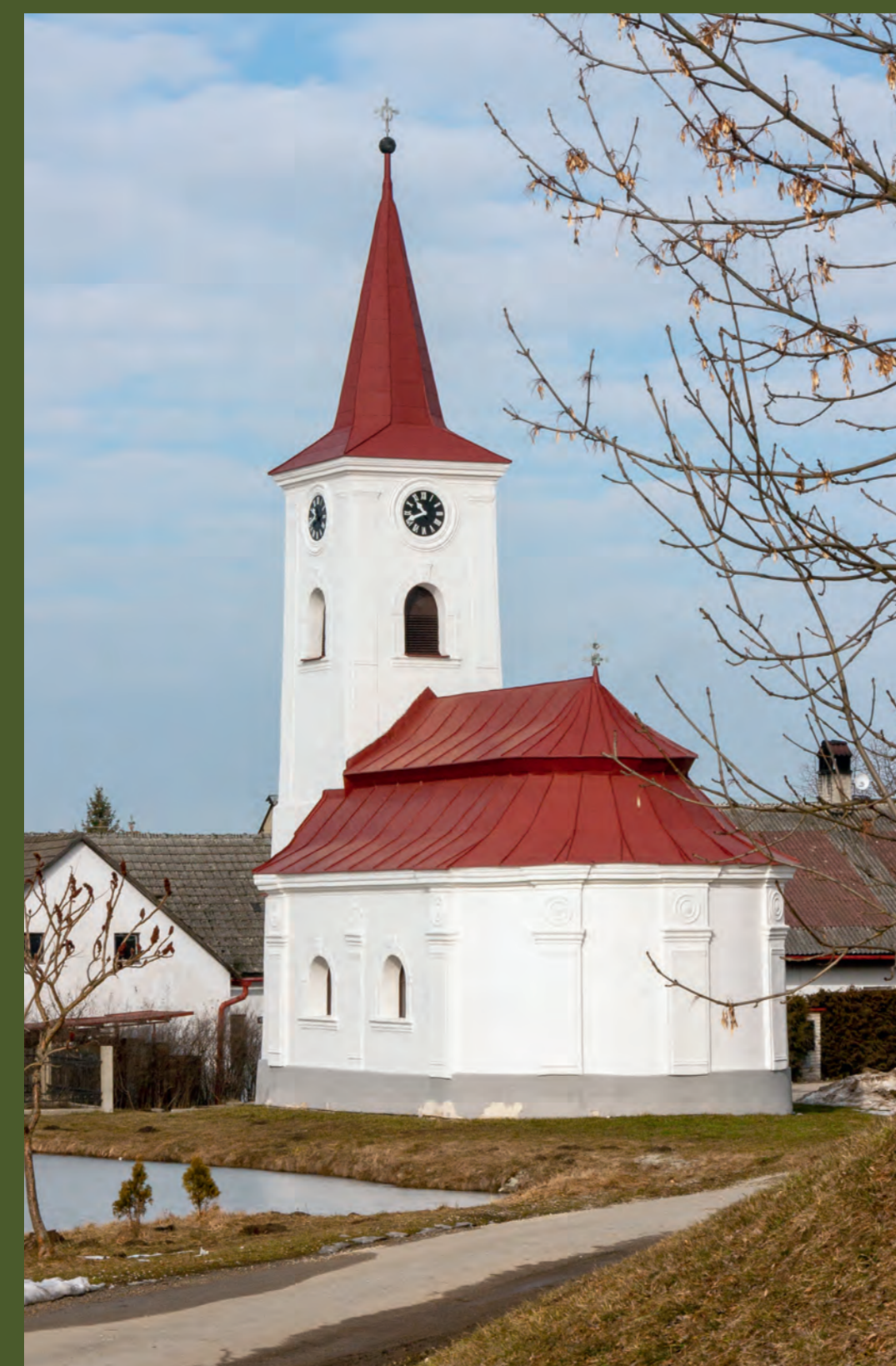
Kačlehy (JH) – návesní kaple sv. Barbory, 1804, stav 2019
