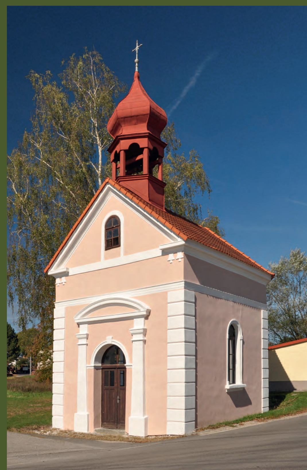
Topělec (PI) – kaple sv. Andělů strážných, 1905, stav 2018
