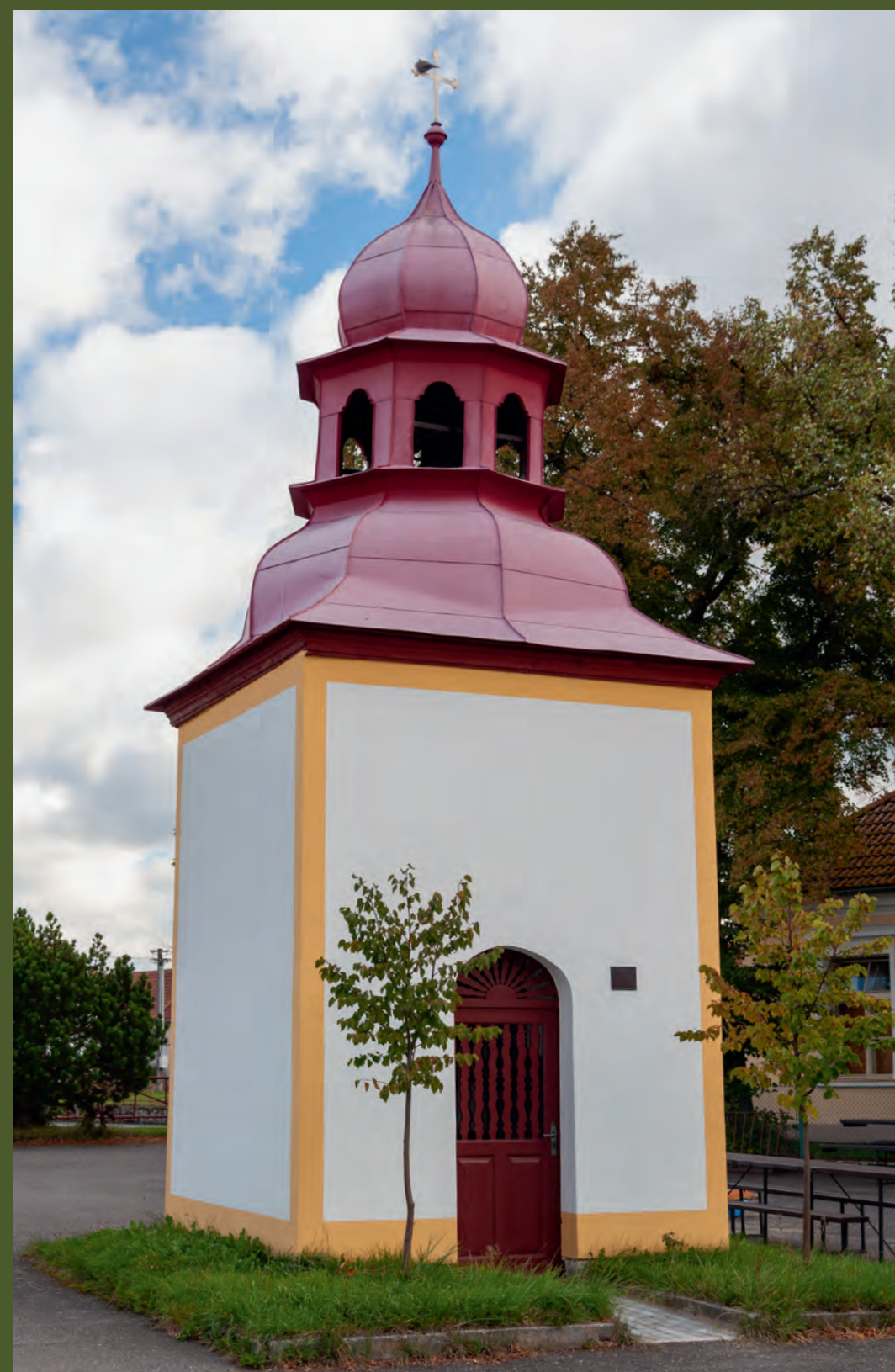
Hvoždany (TA) – návesní kaple Panny Marie, druhá polovina 18. století, stav 2018
