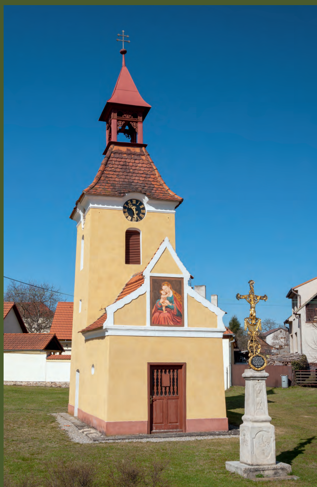
Drahonice (ST) – kaplová zvonice Panny Marie s druhotnou přístavbou, po 1800, stav 2018
