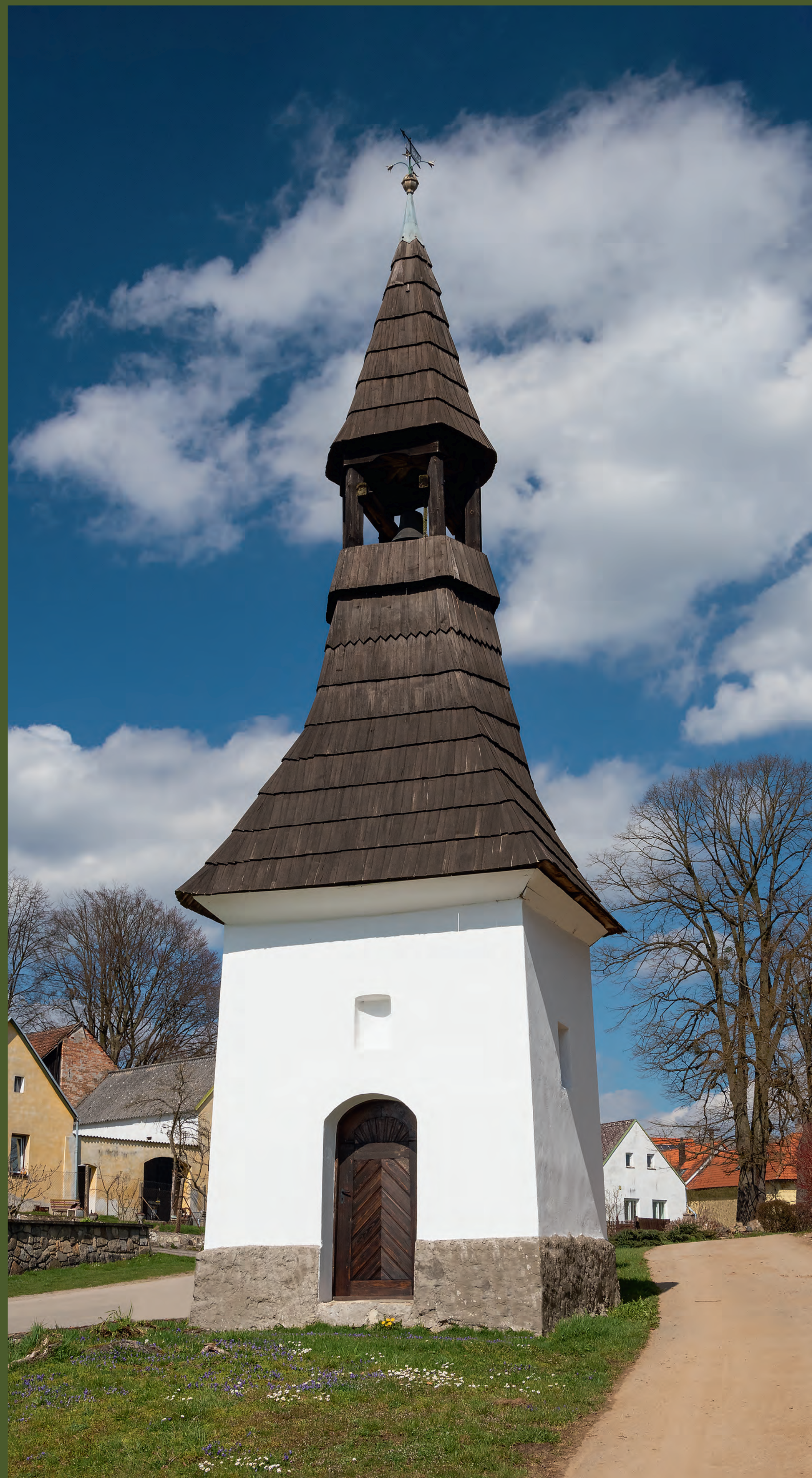
Ratiboř (JH) – kaplová zvonice Panny Marie, asi 1780, stav 2021
