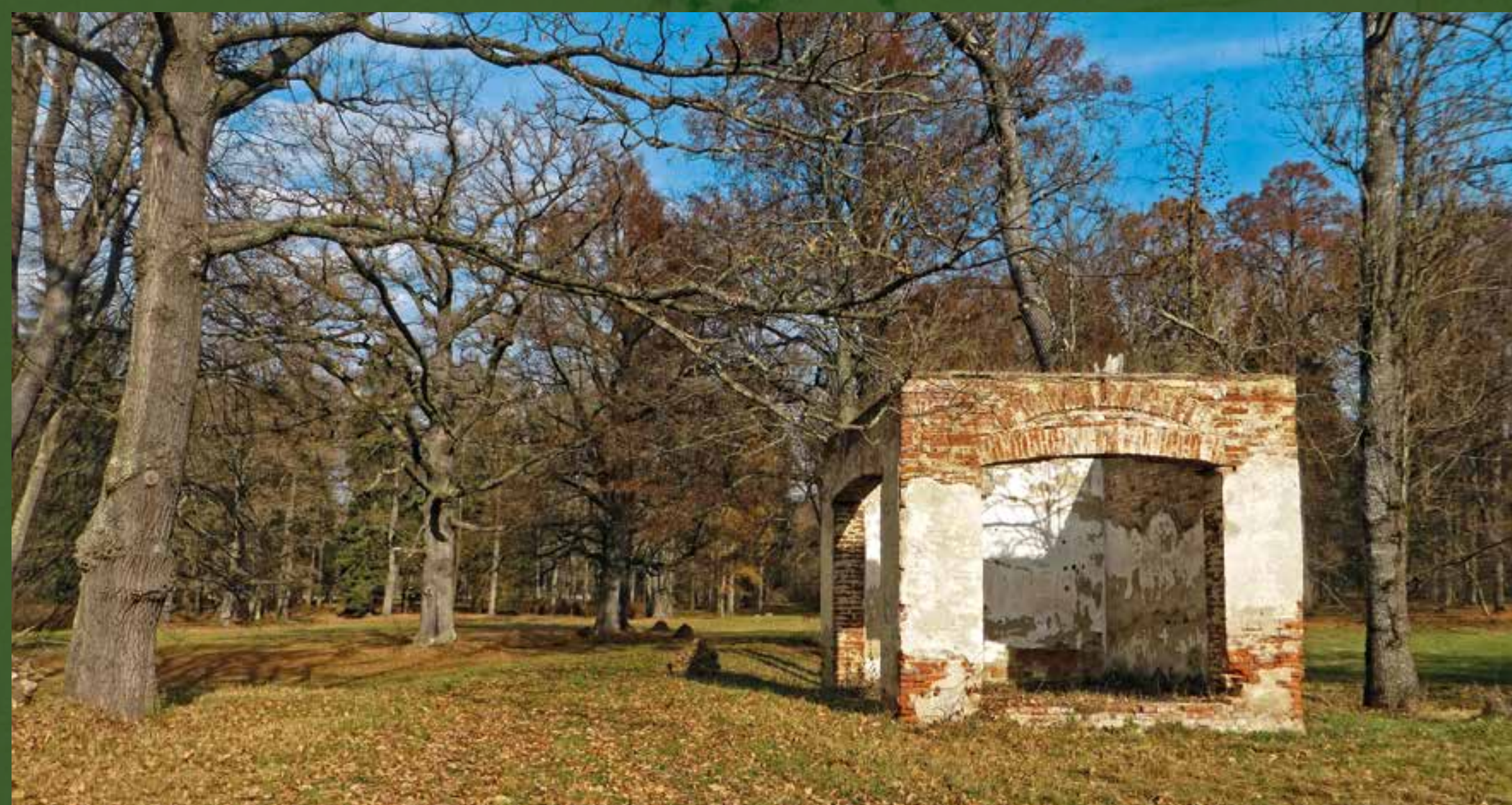
Torzo jedné ze dvou staveb vrátnice z roku 1840, postavených po obou stranách nové příjezdové cesty k zámku
