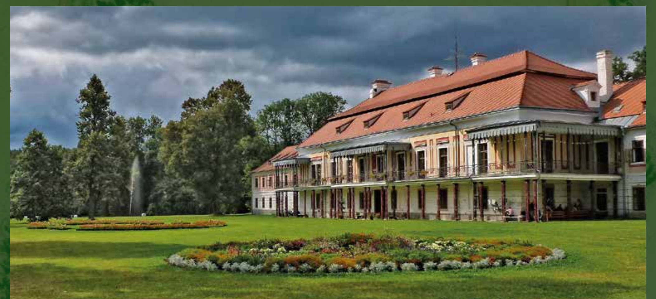
Parterová zahrada před průčelím zámku po rekonstrukci květinových záhonů
