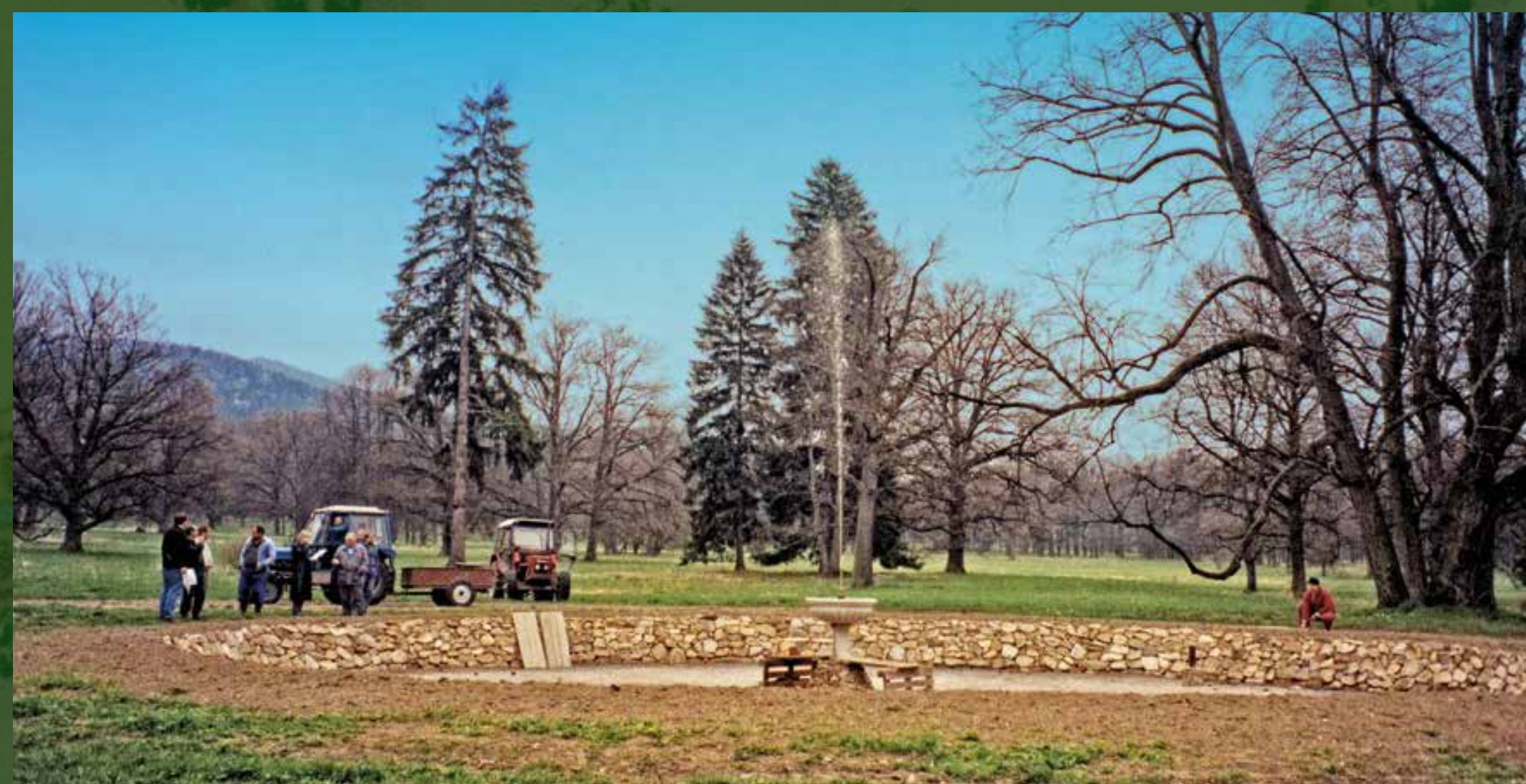
Rekonstrukce nádrže a vodotrysku středové fontány, 1998
