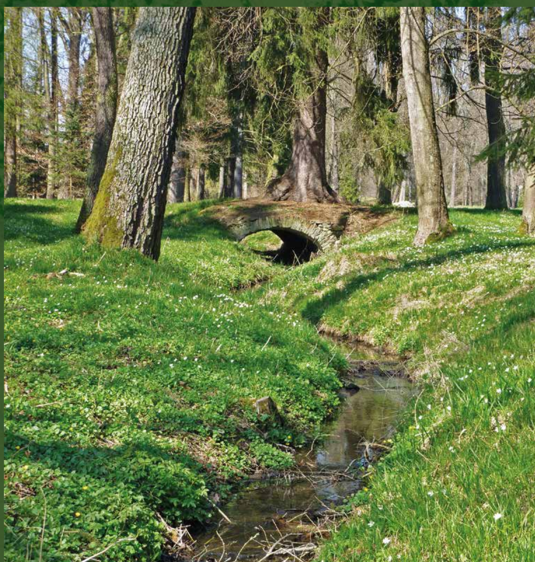
Klenutý propustek na Červenodvorském potoce dokládá směr přímé cesty v barokní zahradě
