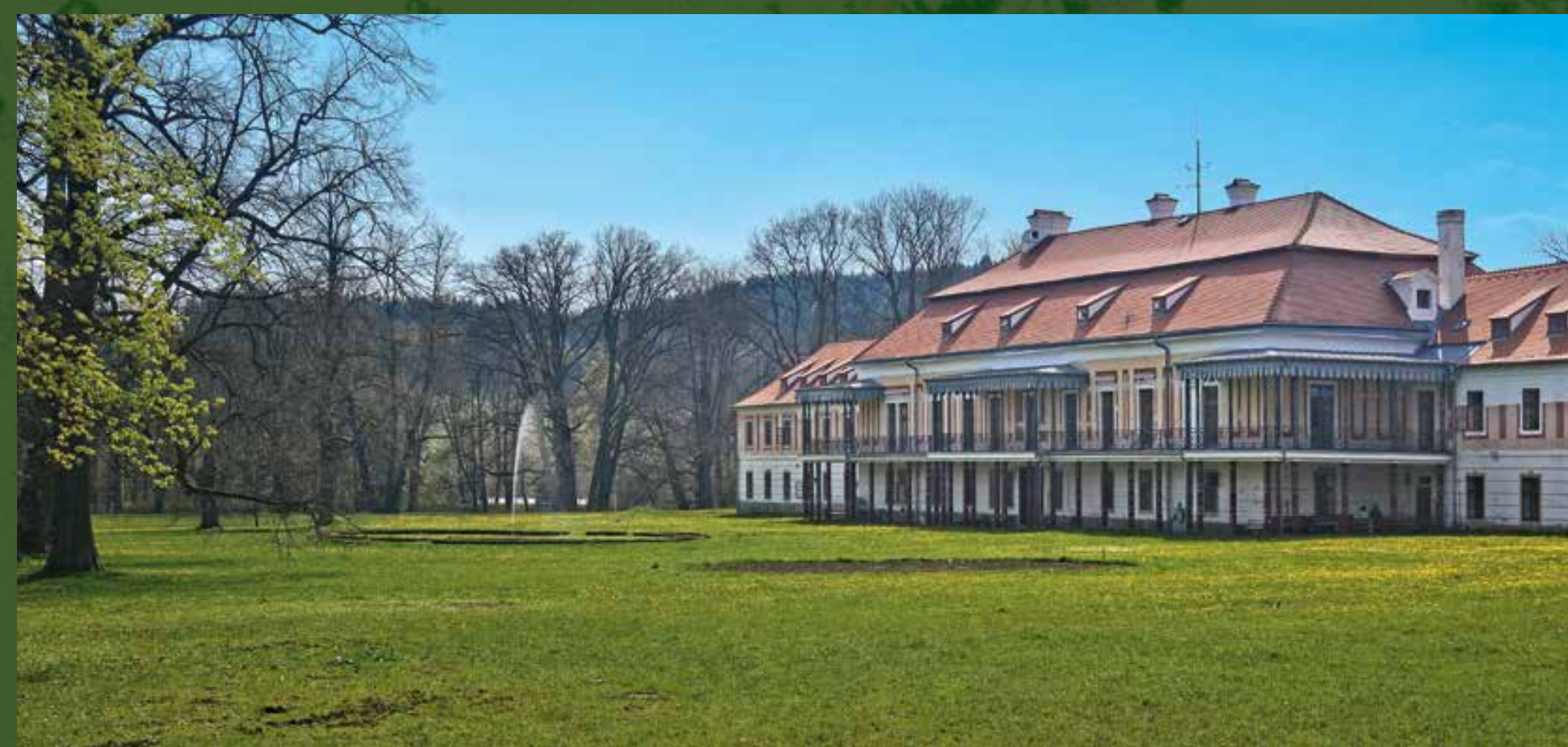
Zahradní průčelí zámku s parterovou zahradou – současný stav
