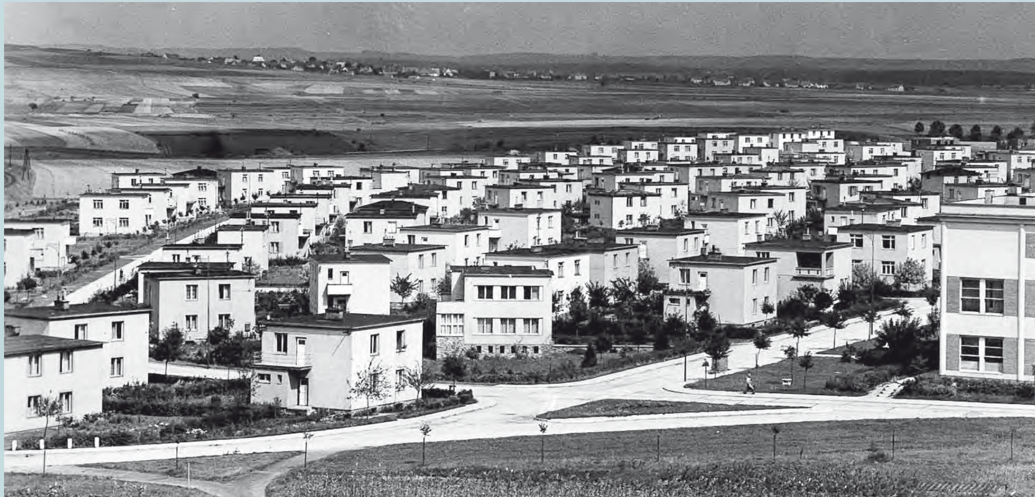
Kolonie 150 domků. Většinou se jednalo o jednopatrové cihlové dvojdomky, zpravidla nepodsklepené. V přízemí se nacházela obytná kuchyně, koupelna a záchod, z kuchyně vedlo schodiště do místnosti v patře.
