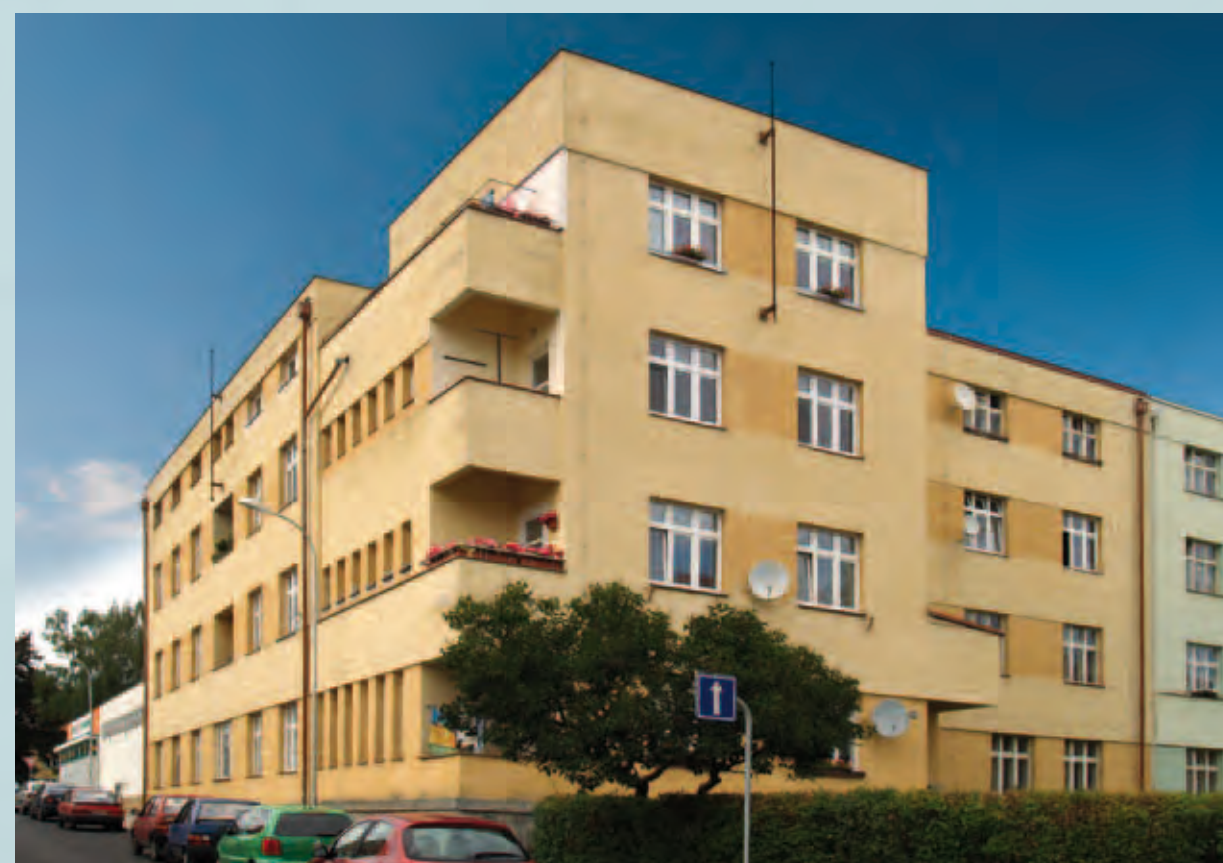
Strakonice - činžovní dům penzijního fondu akciové společnosti Fezko, P. Bezručova čp. 525, r. 1929-1930
