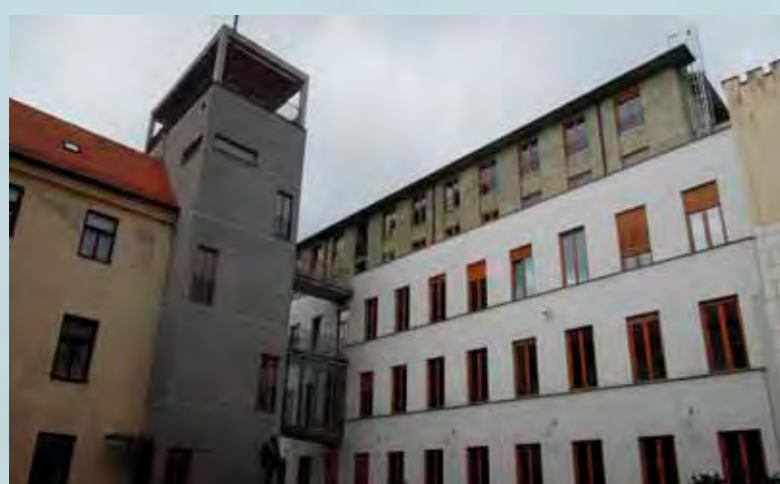
České Budějovice - rekonstrukce a dostavba radnice, nám. P. O. II. čp. 1-2 a 4-5, r. 1998-2000
