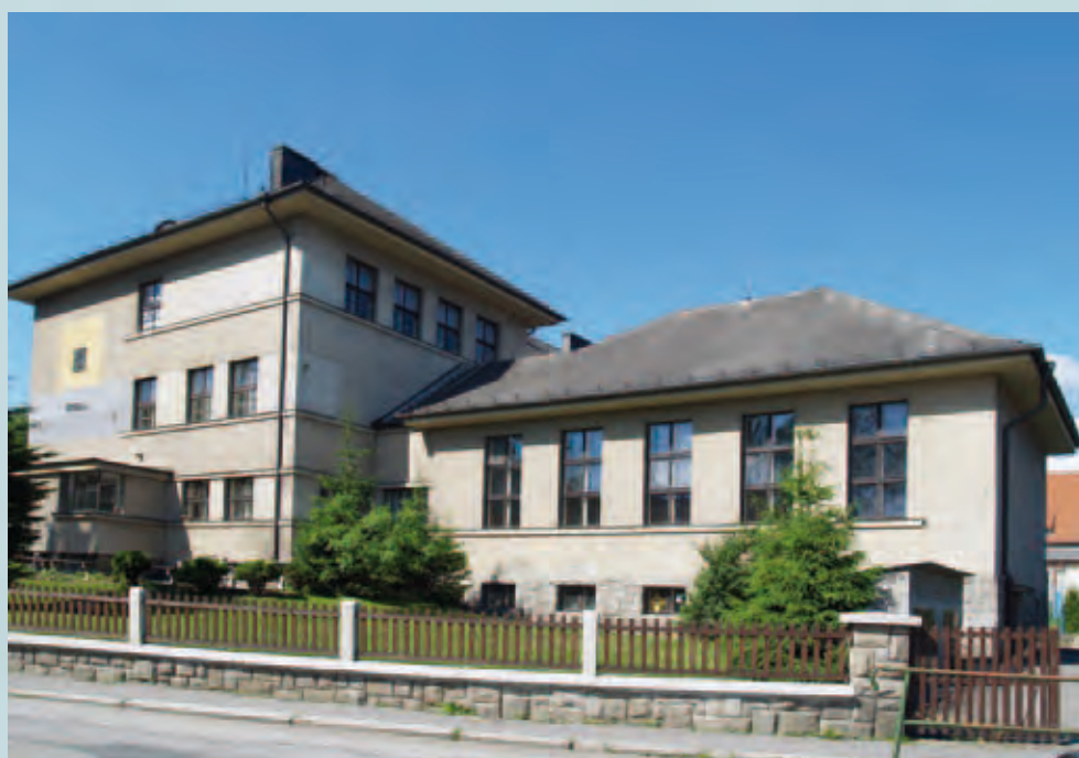
Kaplice – Státní obecná a měšťanská škola, Omlenická čp. 436, r. 1937–1938
