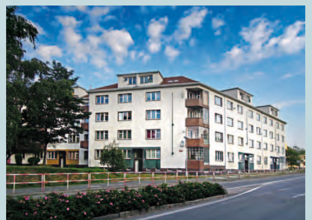
Strakonice - obytné domy České zbrojovky, Nádražní čp. 400–406, r. 1948–1950
