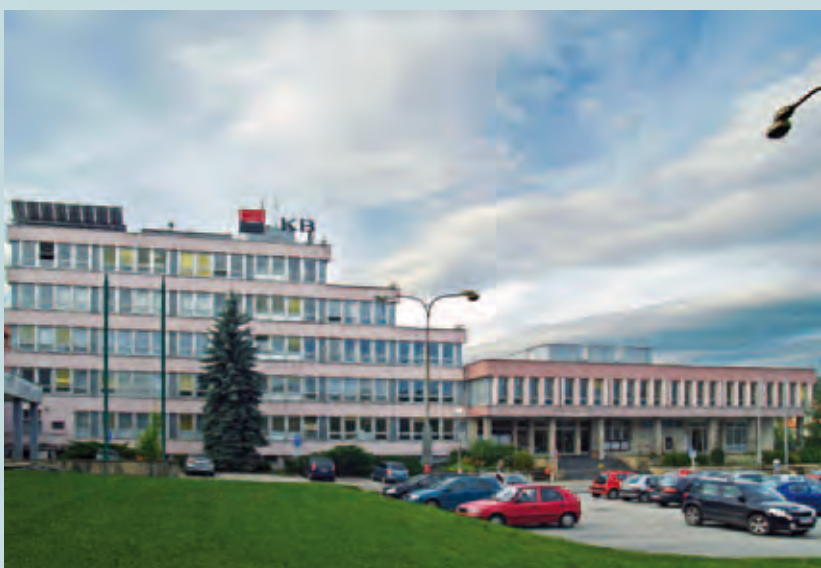
Český Krumlov - budova OV KSČ, Kaplická čp. 439 a 448, r. 1977-1979
