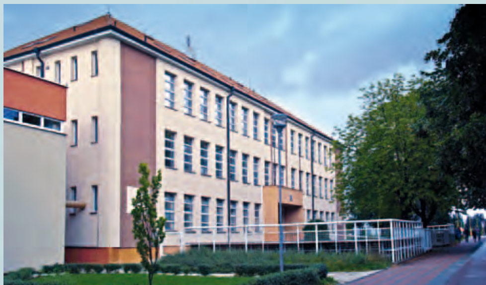
Baťova škola práce, další dominant na hlavní ose města. Konstrukce je opět železobetonová s cihelnými vyzdívkami, původně měla stavba plochou střechu.
