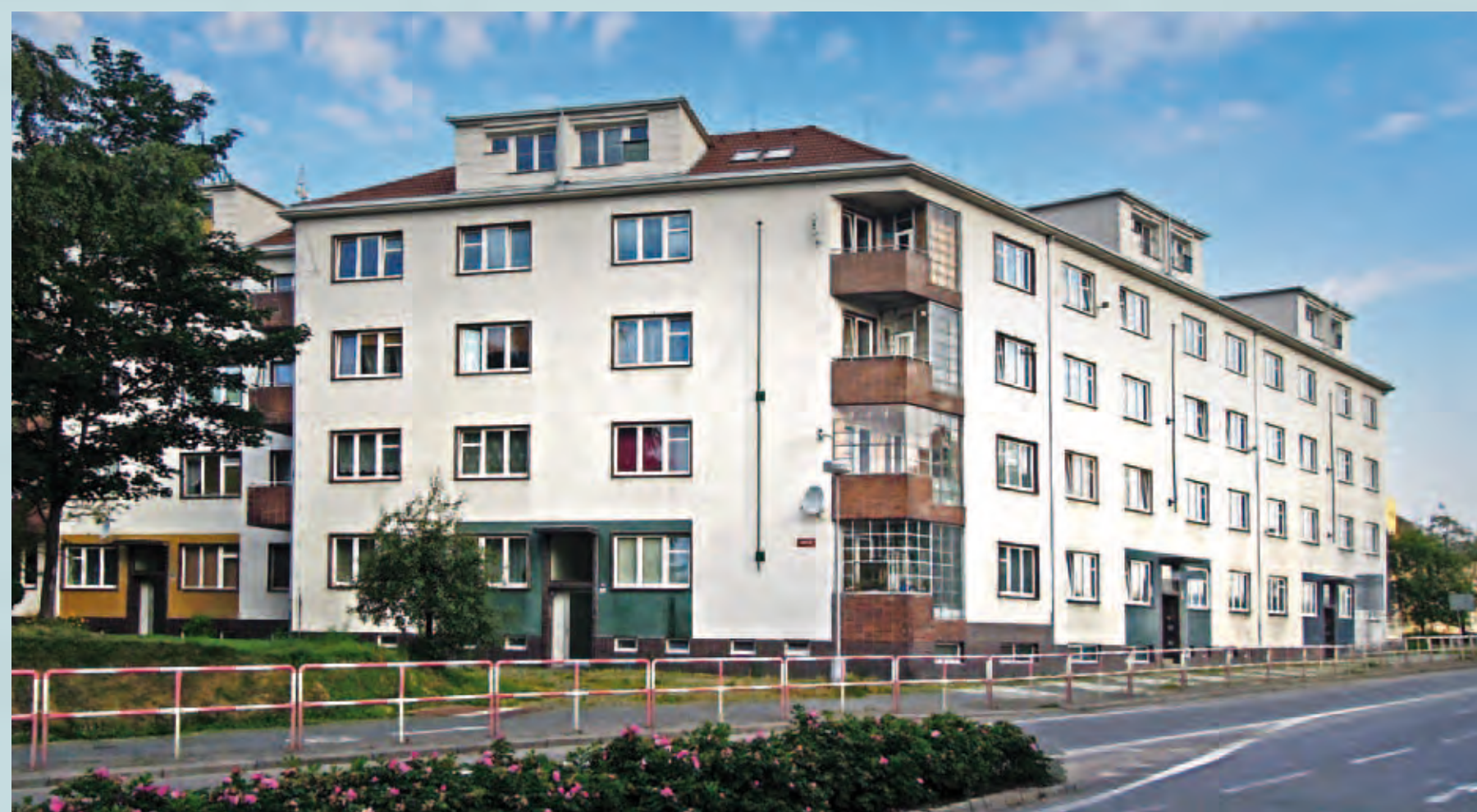
Strakonice - obytné domy České zbrojovky, Nádražní čp. 400-406, r. 1948-1950
