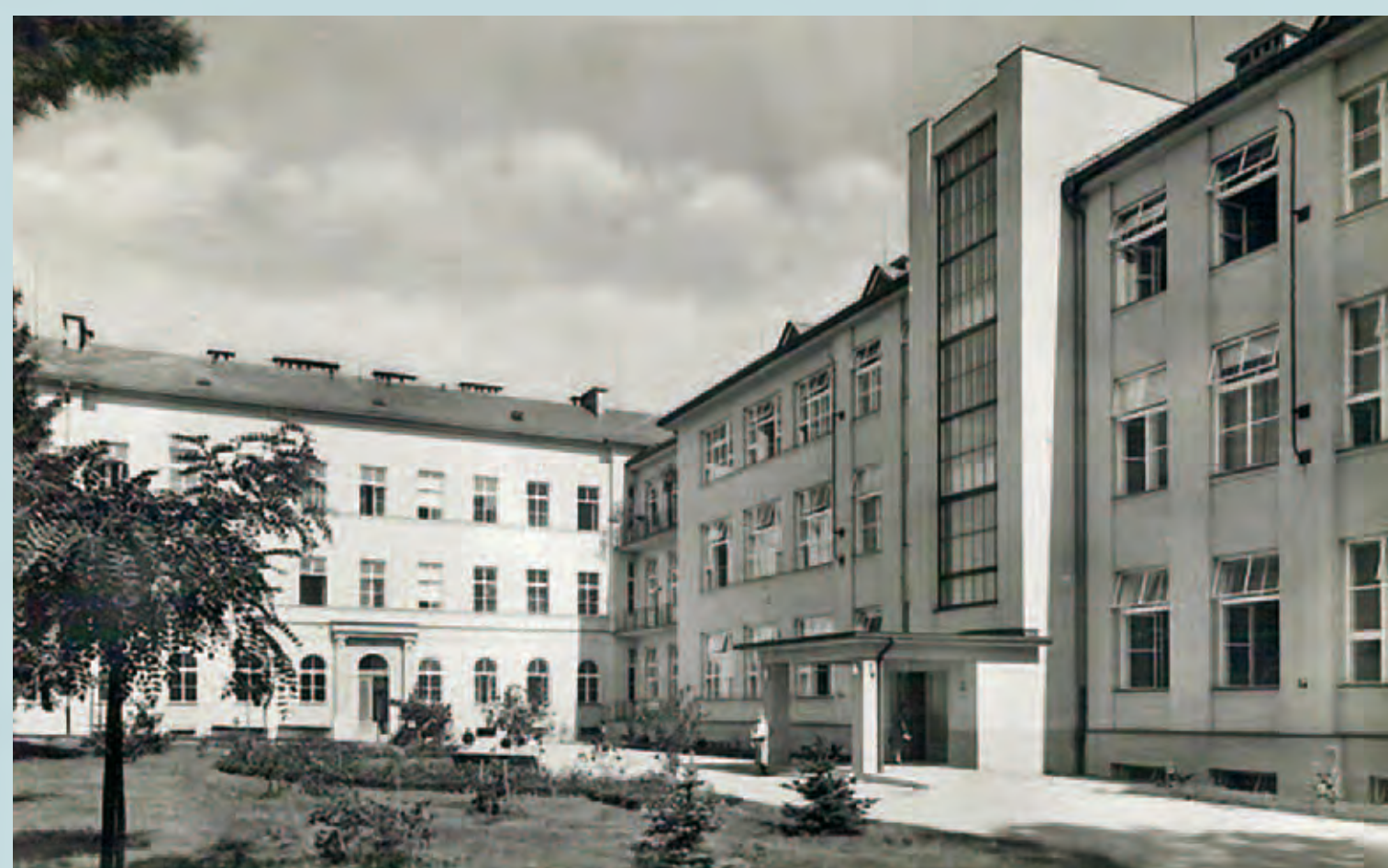
Jindřichův Hradec - chirurgický pavilon nemocnice, U Nemocnice čp. 167, r. 1938
