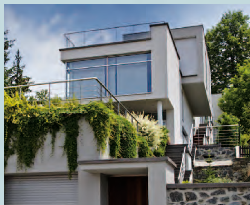
Český Krumlov - vila BMS Touristic, Rožmberská čp. 349, r. 1997-2002
