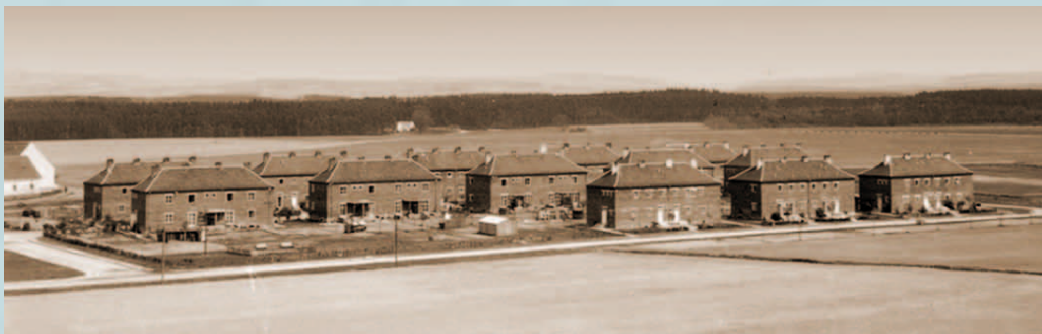
Kolonie 13 čtyřdomků typu M, tzv. Německo, nachází se východně od hlavní osy města, postaveno r. 1942. Byty byly komfortnější a místnosti větší než u předchozích typů domků. Bydlení bylo opět dvoupodlažní, v přízemí samostatná kuchyně se spíží a obývací pokoj se schodištěm do patra, kde byly dva pokoje a koupelna se záchodem.
