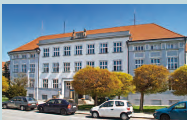
Jindřichův Hradec - soudní budova, Nádražní čp. 567, r. 1928-1929
