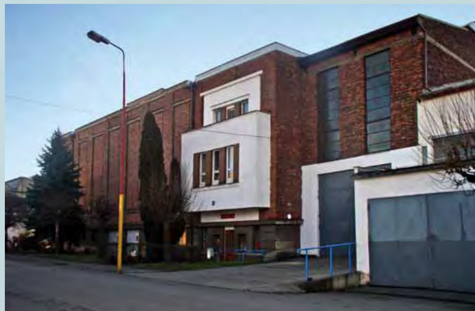
Elektrárna továrny. Halový objekt byl postaven typickým baťovským modulovým skeletem.
