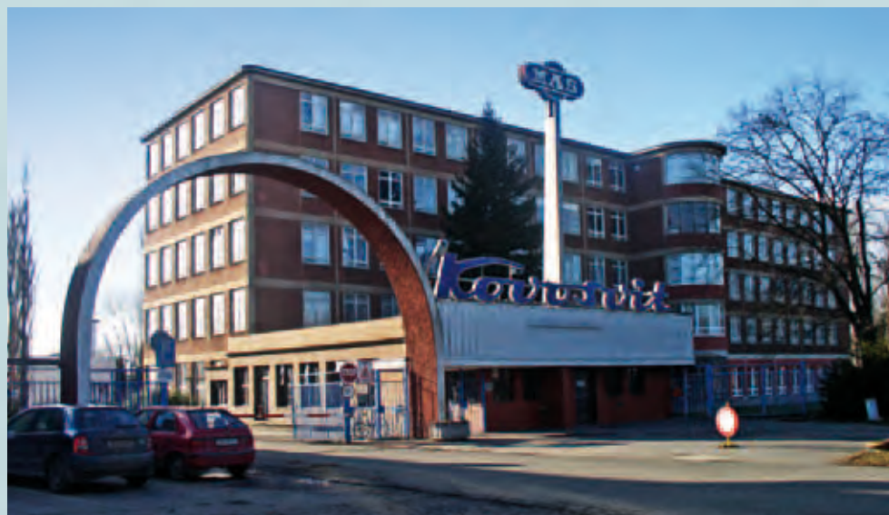
Administrativní budova továrny. Objekt má typický baťovský modulový železobetonový skelet s klasickým exteriérem z režného zdiva.
