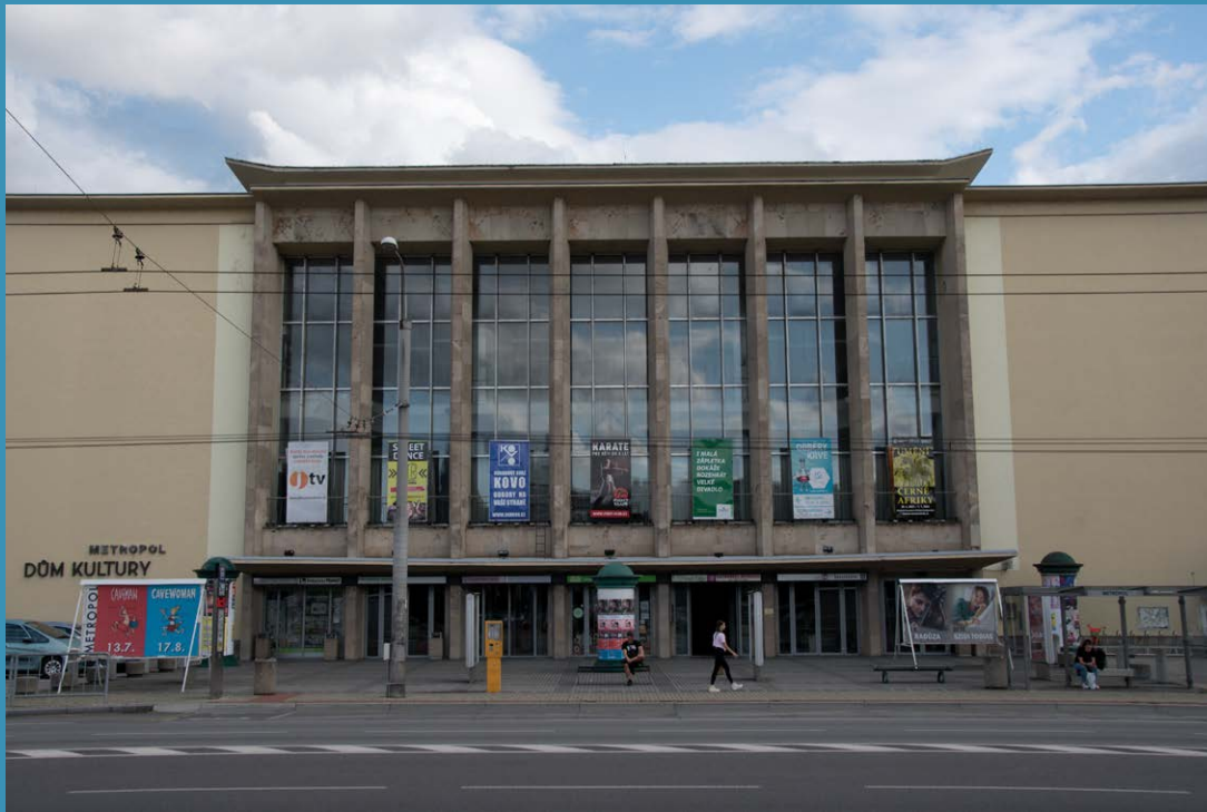
Kulturní dům Metropole; foto Jakub Drozda, 2023
