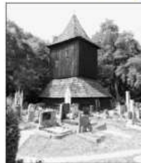
Zvonice na Zámečku.
