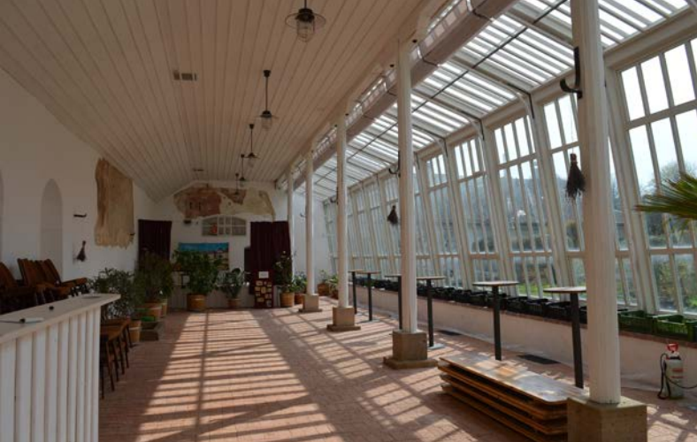
Obr. 2 Manětín – zámecká oranžerie po obnově. Interiér. Foto M. Waldmannová, 2022.
