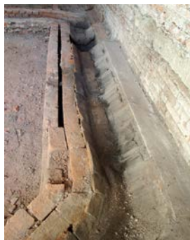
Obr. 9 V rámci archeologického výzkumu odkrytý otopný kanál oranžerie v areálu zámku Letohrad. Foto Aleš Papáček, 2021.
