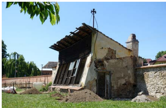
Obr. 5 Zámecká oranžerie v Červeném Poříčí – stav před obnovou. Foto L. Foster, 2021.
