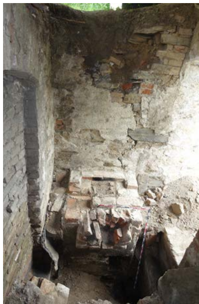
Obr. 29 Horšovský Týn – zámecká oranžerie v areálu zahradnictví. Východní část zadní obslužné chodby se soklem komínového tělesa, s vysunutým krbečkem pomocného topeniště pro zvýšení tahu při zátopu. Otisk komínového tělesa v koutě vlevo až do úrovně zřícené klenby chodby. Vlevo nika v severní zdi obslužné chodby. Pohled k východu. Foto L. Foster, 2021.
