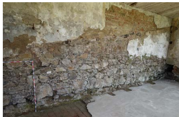
Obr. 10 Oranžerie v Červeném Poříčí – pohled na severní stěnu s otisky rour od kamnového tělesa vlevo ke komínu vpravo. Pod poslední dochovanou betonovou podlahou je starší podlaha z cihel z 19. století. Foto L. Foster, 2021.
