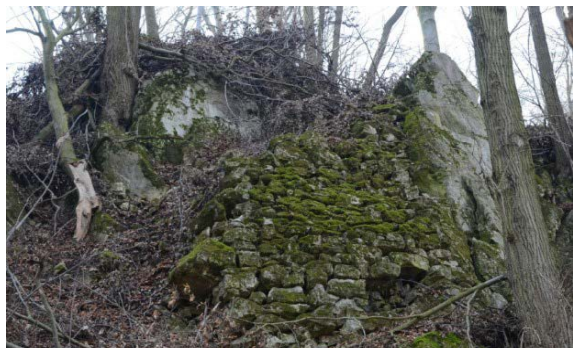
Obr. 16 Zbytky cesty ve skalách na severní straně Třesína. Foto Radovan Urválek.
