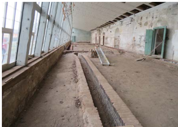
Obr. 4 Topné kanály v interiéru oranžerie v areálu zámku Dobříš. Foto Lenka Křesadlová, 2019.
