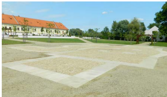
Obr. 26 Olomouc, Klášterní Hradisko, opatská zahrada. Pohled od letohrádku k hospodářskému dvoru (od jihozápadu) po ukončení revitalizace opatské zahrady. Foto H. Dehnerová, 5. 6. 2025.
