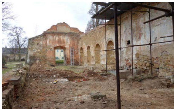
Obr. 31 Manětín – zámecká oranžerie, archeologizovaný interiér. Pohled od východu. Foto L. Foster, 2019.
