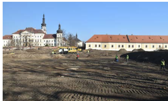
Obr. 20 Olomouc, Klášterní Hradisko, opatská zahrada. Foto z průběhu skrývky v roce 2023, celkový pohled na odkryté základové zdivo letohrádku od jihu. Foto H. Dehnerová, 1. 3. 2023.
