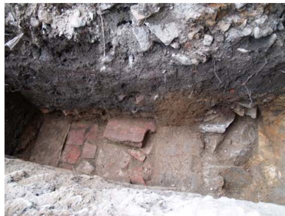
Obr. 4 Dolní parter Horní zámecké zahrady v Českém Krumlově, archeologicky odkrytý relikt boční stěny vodní nádrže z poloviny 18. století. Zajištění nepropustnosti nádrže bylo vyřešeno zdvojením bočních stěn, které byly tvořeny (na fotografii zleva) vnitřní cihlovou zídskou, izolační vrstvou jílů a nasucho vyskládanou zídskou z kamenů. Foto Jiří Havlice, 2009.
