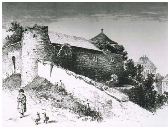
Obr. 7 Český Krumlov, bašta Paraplíčko na rytině A. Liebschera z druhé poloviny 19. století. Na straně přivrácené k městu je patrná kuželovitá střecha vyhlídkového altánu, kterou bylo možné zdvihnout pomocí vahadlového mechanismu ve sklepe bašty. Podle A. Sedláček, Hrady, Díl třetí – Budějovsko, 1884.
