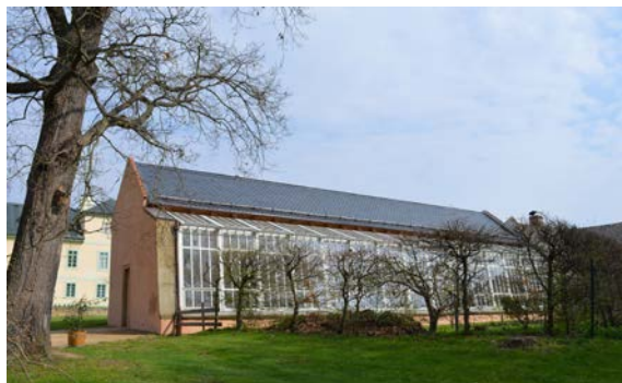
Obr. 3 Manětín – zámecká oranžerie po obnově. Exteriér. Foto M. Waldmannová, 2022.
