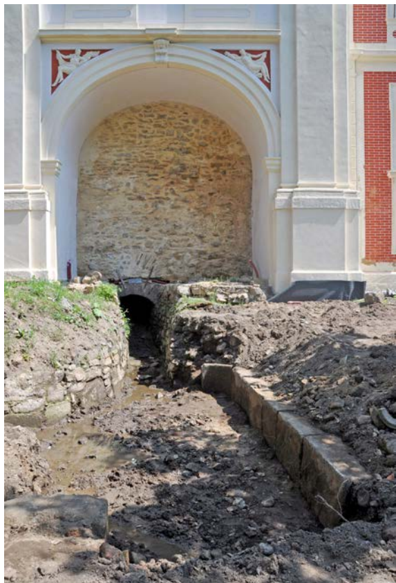
Obr. 16 Nádrž s odtokem z kaskád věže Velkého muže. Foto Lubomír Zeman, 2015.
