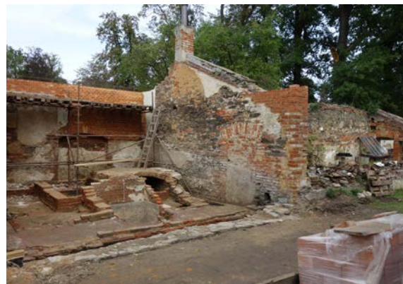
Obr. 22 Horšovský Týn, areál zahradnictví – torzo zámecké oranžerie z 19. století. Střední část před adaptací na garáž. Při stěnách pod podlahou vede topný kanál, ve středu místnosti vyvýšený blok s klenutými komorami nejasného účelu, snad podesta pro zimování rostlin. Uprostřed nádrž na vodu s cementovým potěrem. Na štítové zdi zjevně několik fází úprav, se zazdívkou vstupu do východní části oranžerie (dnes ruina). Pohled od jihozápadu. Foto L. Foster, 2020.
