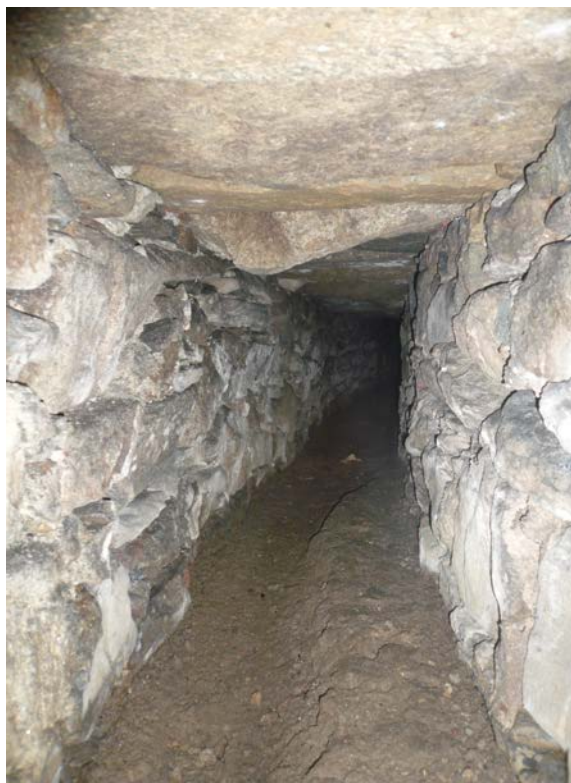
Obr. 5 Interiér odvodňovacího kanálu pivovarského sklepa. Foto Jiří Doupal, 2018.
