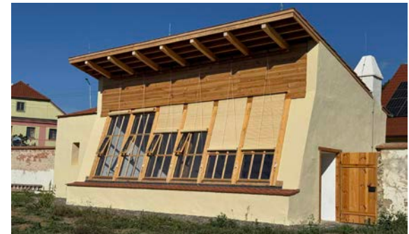
Obr. 1 Červené Poříčí – zámecká oranžerie po obnově. Exteriér. Foto Státní zámek Červené Poříčí, 2024.
