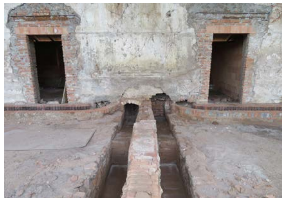
Obr. 5 Topné kanály v interiéru oranžerie v areálu zámku Dobříš. Foto Lenka Křesadlová, 2019.
