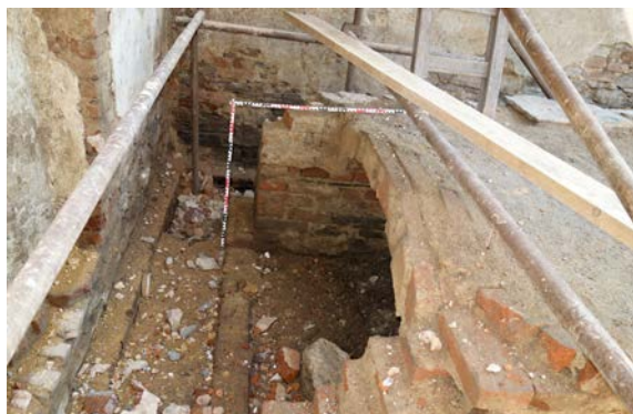
Obr. 25 Horšovský Týn, areál zahradnictví – torzo zámecké oranžerie z 19. století. Zadní část klenutých komor ve střední části půdorysu oranžerie. Mezi komorou a severní zdí vlevo je místo obslužné chodby úzká ulička s topným kanálem pod podlahou (zasypaný). Pohled od západu. Foto L. Foster, 2020.
