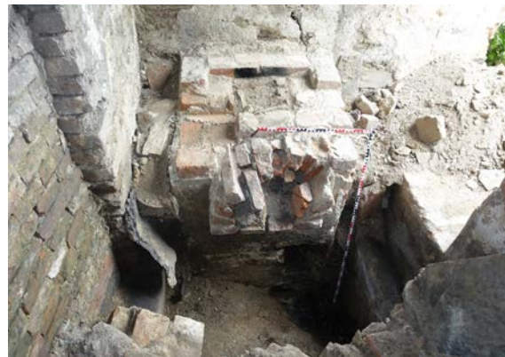
Obr. 28 Horšovský Týn – zámecká oranžerie v areálu zahradnictví. Východní část zadní obslužné chodby se soklem komínového tělesa, s vysunutým krbečkem pomocného topeniště pro zvýšení tahu při zátoku. Malý očázený otvor vpravo pod ním odváděl spaliny z kanálu pod podlahou chodby do komína. Vstup vpravo vede do interiéru skleníku s podlahou přibližně v úrovni prahu tohoto vstupu. Foto L. Foster, 2021.
