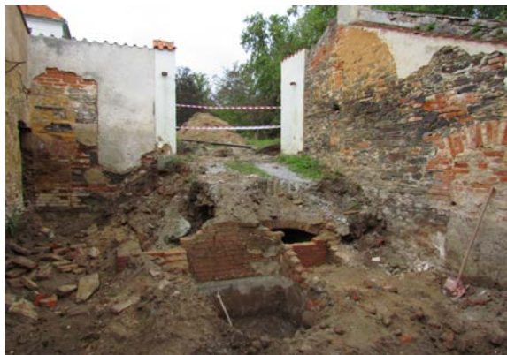
Obr. 21 Horšovský Týn – torzo zámecké oranžerie z 19. století. Nález klenutých komor ve střední části půdorysu zaniklé oranžerie po odbagrování novodobé rampy z areálu níže položeného zahradnictví do vyvýšeného parku. Pohled od jihu. Foto F. Kasl, 2020.
