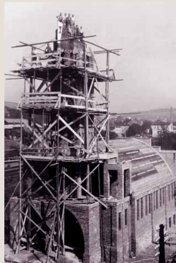
Zakończenie budowy wieży zboru, lato 1938go roku
