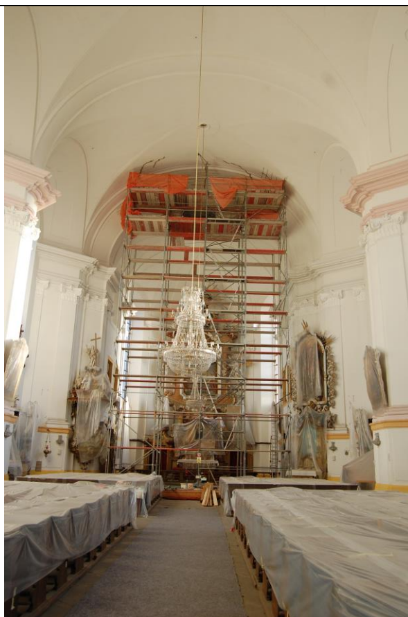
Obrázek 4: Probíhající opravy kostela Nalezení sv. Kříže (foto Bc. Lucie Matysová)
