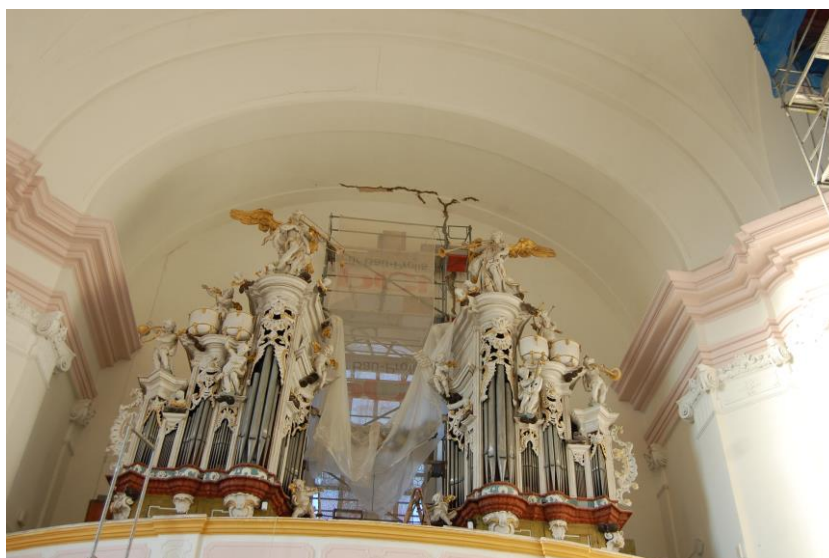
Obrázek 5: Probíhající opravy kostela Nalezení sv. Kříže (foto Bc. Lucie Matysová)
