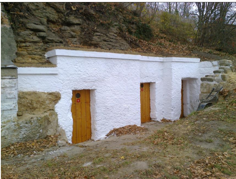
Obrázek 2: Skalní sklípky 6 - 8 po rekonstrukci (foto Ing. Petr Kmínek)
