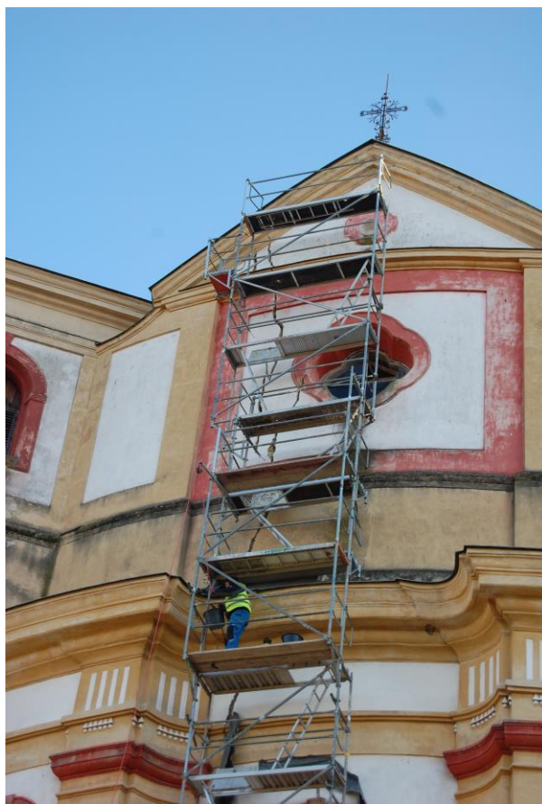
Obrázek 3: Probíhající opravy kostela Nalezení sv. Kříže (foto Bc. Lucie Matysová)
