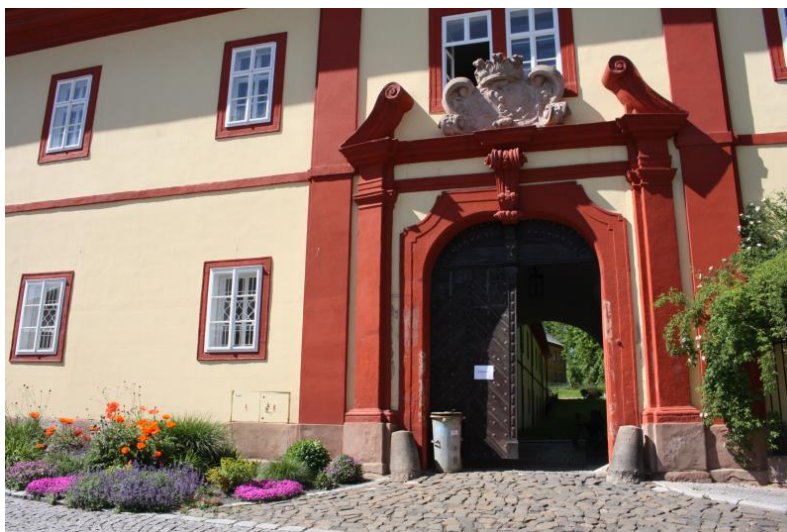
Nahoře: foto severního průčelí (4. 10. 2022), dole: jižní průčelí č. p. 1 (1. 6. 2020)
