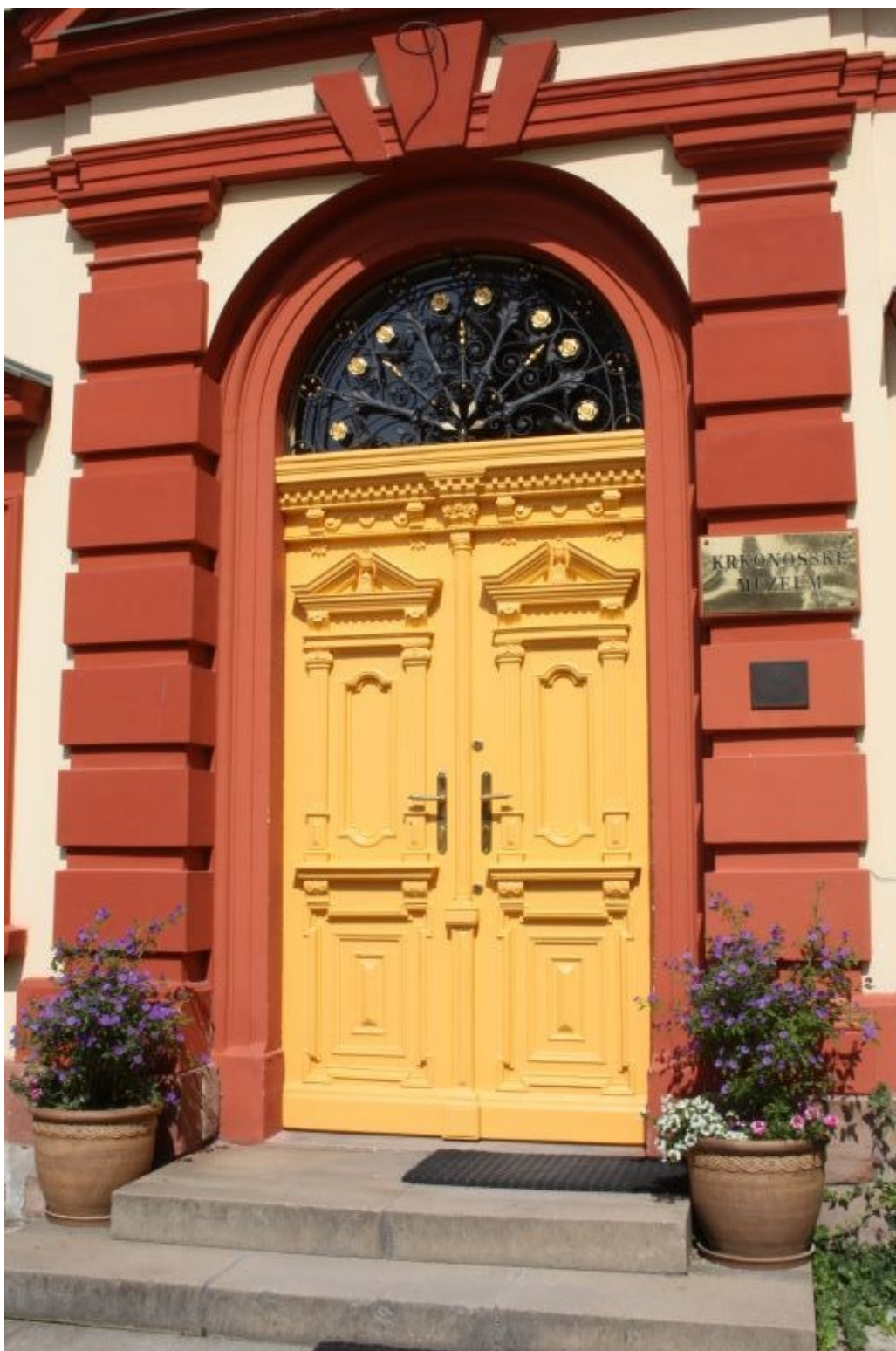
V roce 2024 proběhla celková renovace vstupních dveří zámku. Autor fotografie: Petra Fišerová
