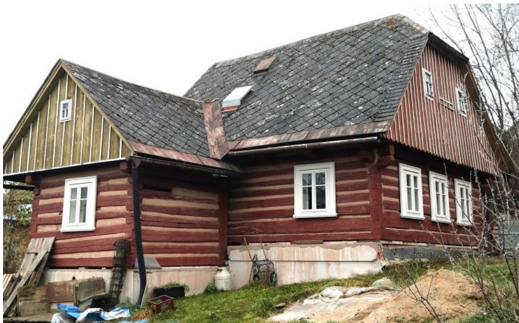
Pohled na chalupu čp. 113 ve Zvědavé uličce v Jilemnicích. Objekt prochází postupnou dlouhodobou obnovou. Zde stav z 12. 11. 2024 po montáži nových špaletových okenních výplní. Podpořeno dotací z grantového programu města Jilemnice. Autor fotografie: Petra Fišerová
