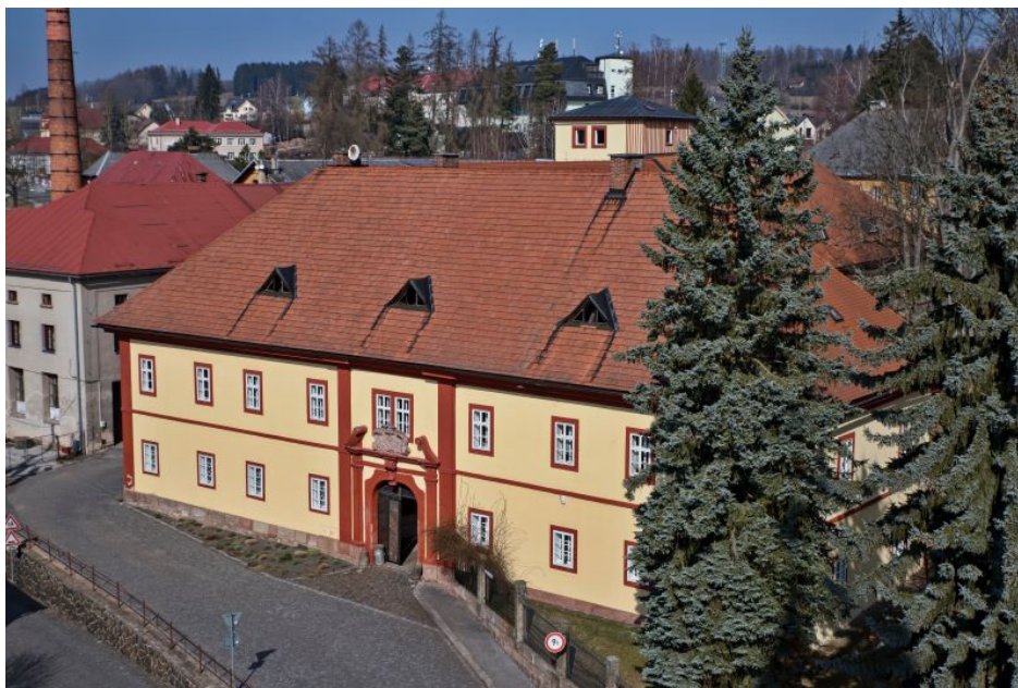
Bývalý panský pivovar č.p. 1: Pohled z věže kostela Autor fotografie: Martin Lukeš
