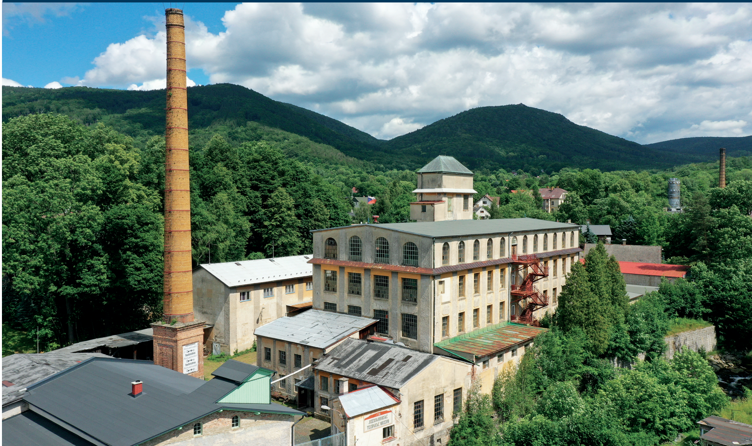
Celkový pohled na areál přádelny od západu
