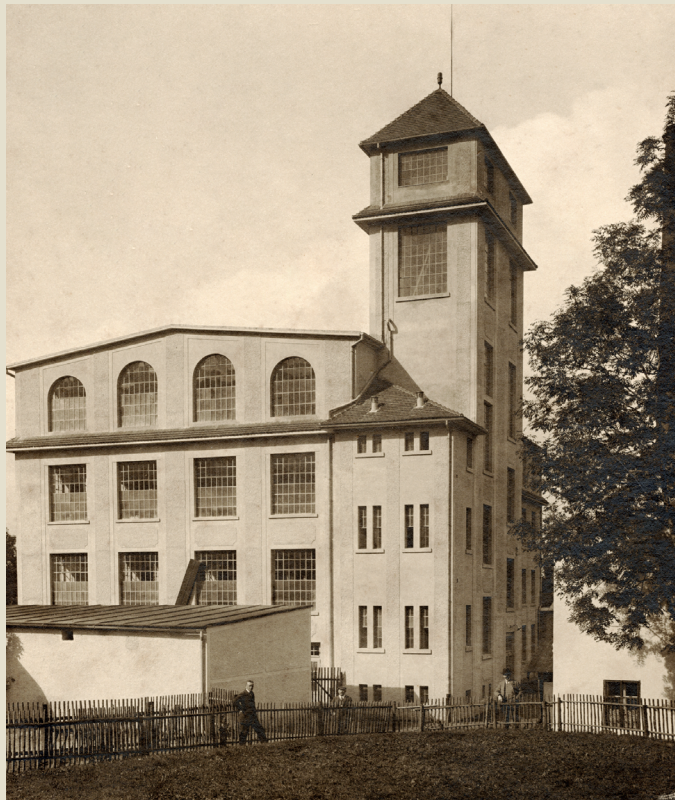
Odpadní přádelna po dokončení přestavby v roce 1913
