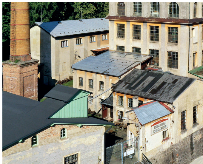
Vstupní partie továrny. Vpravo v popředí vrátnice, strojovna, za ní kotelná, ze které vede podzemní kouřovod do komína. Vlevo objekt pomocných provozů, původně propojený lanovým převodem se strojovnou. V pozadí etážová budova přádelny 2025
