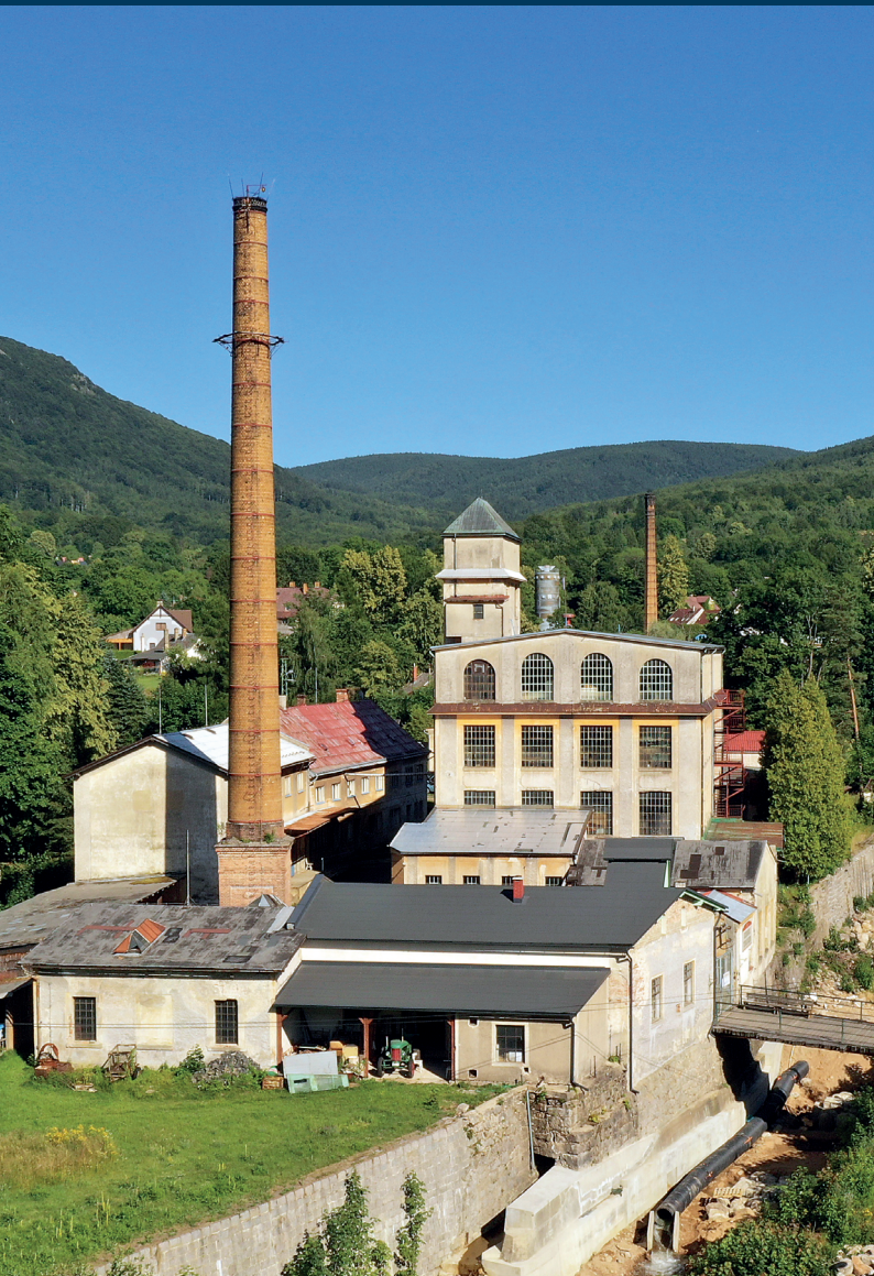
Celkový pohled na továrnu od západu
