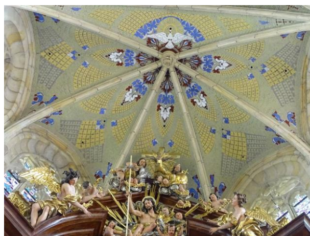
detail obnovené malby nad oltářem
