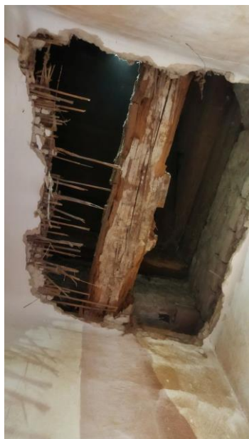
detail trámu s dřevomorkou
