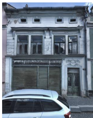
před výměnou oken
