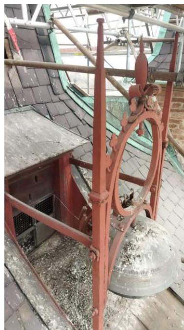
cimbál umístěný na střeše věže
