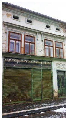
po výměně oken
