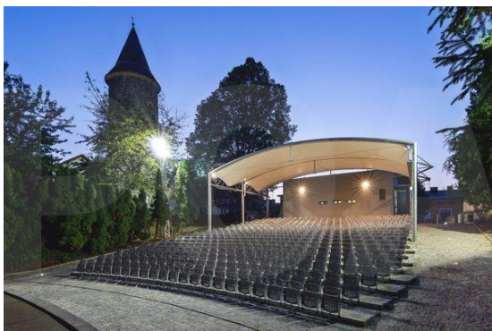
rekonstrukce areálu letního kina
