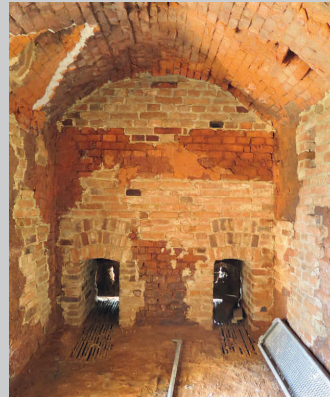
Vypalovací komora pece, foto: D. Tuma, 2024
