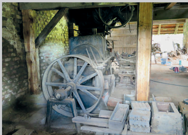
Strojní vybavení v interiéru přízemí lisovny, foto: D. Tuma, 2022
