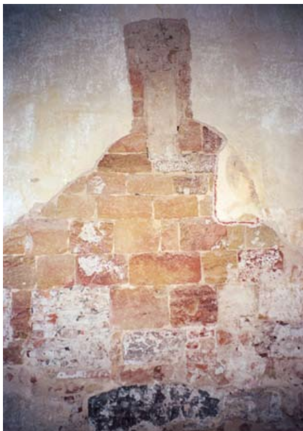
Obr. 10. Plasy, kostel Nanebevzetí Panny Marie. Jižní obvodová zeď (JIV) s nálezem odsekané gotické klenební konzoly a krácené přípory (J4). (Foto Z. Chudárek, 2009)
