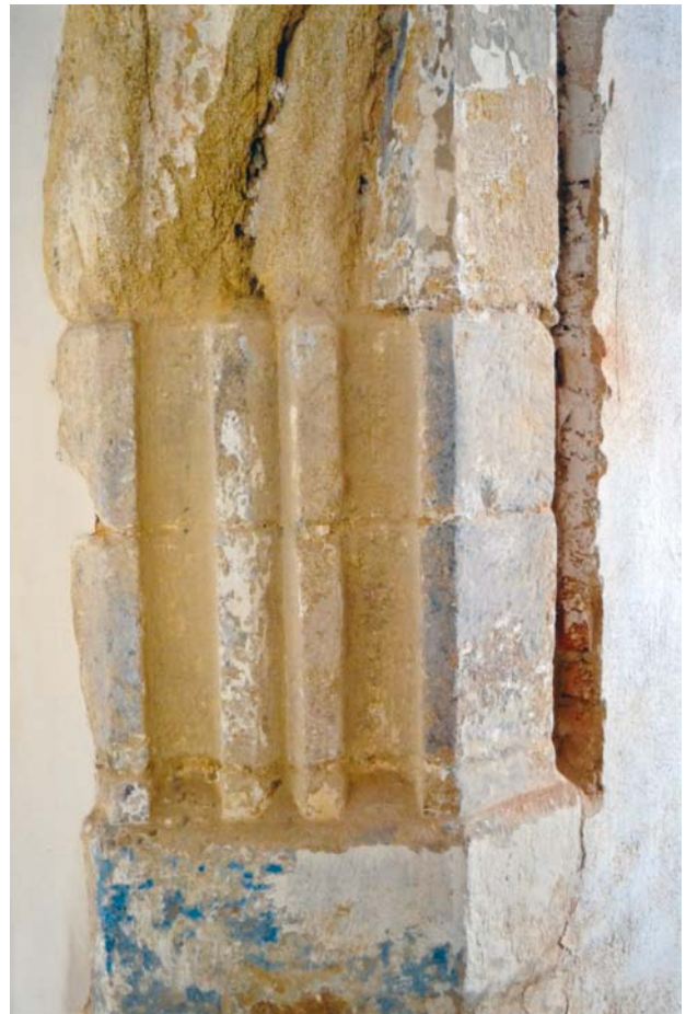
Obr. 11. Blížešov, kostel sv. Martina. Portál v jižní kapli do chrámové lodi – část profilovaného ostění, soklu a oblouku. (Foto J. Kaigl, 2012)
