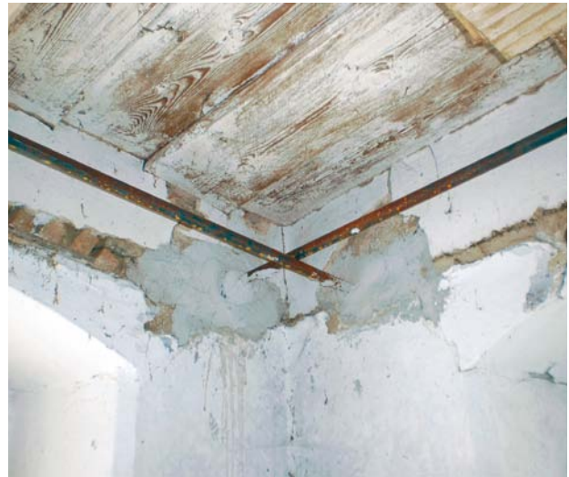
Obr. 17. Kbel, fara čp. 35. Místnost 202, odkrytý starý záklopový strop. (Foto R. Široký, J. Bock, 2011)
