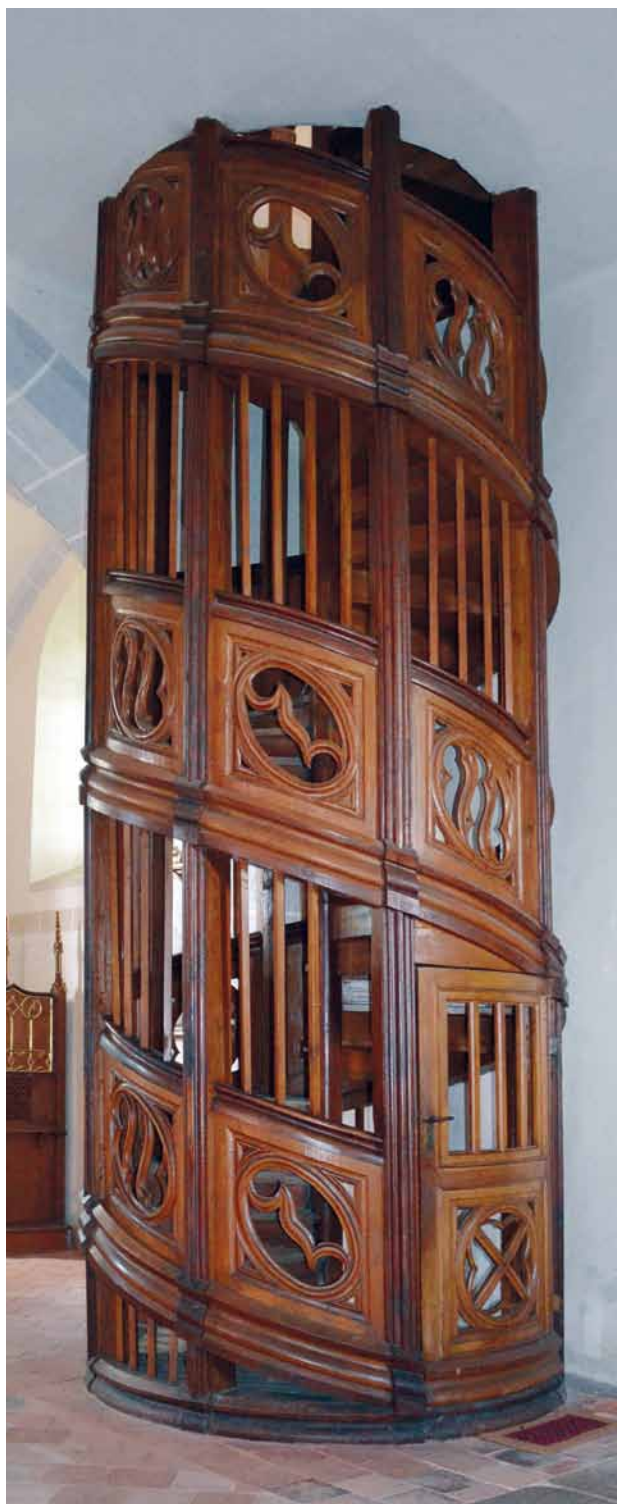
Obr. 2. Nepomuk (okr. Plzeň-jih), kostel sv. Jakuba. Točité vřetenové schodiště na hudební kruchtě. Pohled z hlavní lodi. (Foto P. Kroupa, 2012)
