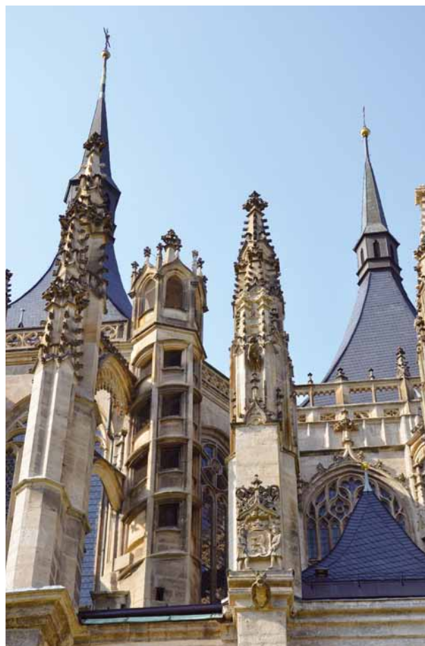
Obr. 8. Kutná Hora, chrám sv. Barbory. Schodišťová věžice na severní straně chóru. (Foto P. Kroupa, 2013)
