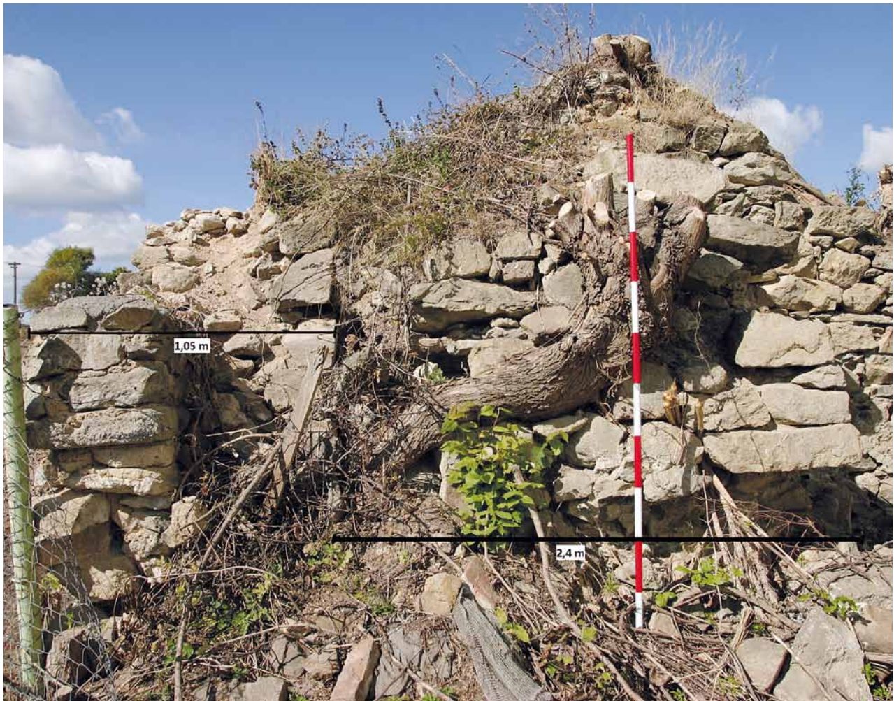
Obr. 9. Tisová, ohradní zeď areálu kostela sv. Mikuláše. Detail jižního úseku zdi (vlevo), konstrukce C – opěrný pilíř (vpravo). Pohled od východu. (Foto L. Foster, 2012. Grafické úpravy M. Waldmannová, 2013)
