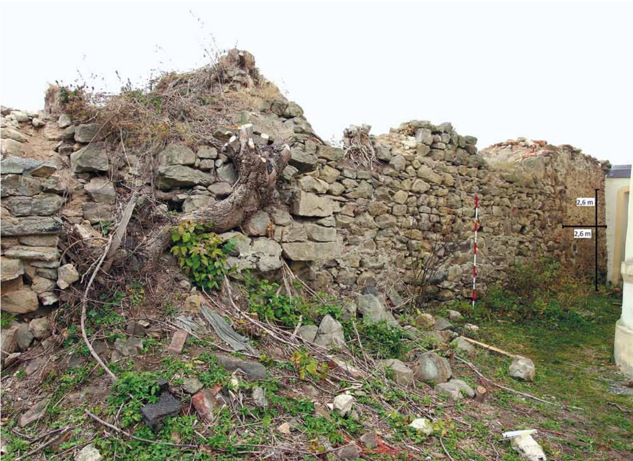
Obr. 11. Tisová, ohradní zeď areálu kostela sv. Mikuláše. Východní líc konstrukce B. Vyznačen upravený severní úsek (u zděné branky) včetně náznaku výšky zazděného okénka se segmentovým záklenkem. Pohled od jihovýchodu. (Foto L. Foster, 2012. Grafické úpravy M. Waldmannová, 2013)
