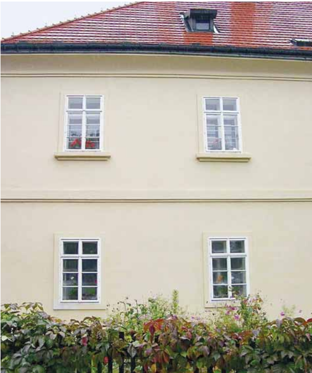
Obr. 5, 6. Praha 6 – Liboc, areál obory Hvězda, dům čp. 1 (dům oborníka). Část jižní fasády a jedno z oken přízemí. – Existují případy, kdy byly vnitřně hydrofobizované omítky použity při opravě fasád a současně i v interiéru. Omítky sice nejsou ani po několika letech poškozeny, ale ze stále přítomnosti vnitřní vlhkosti kondenzující na oknech lze odvodit, že stavba trpí. Nenasákavé omítky nemají schopnost pohlcovat ani provozní vlhkost a interiéry jsou nadměrně vlhké včetně vysokého rizika vzniku plísní.
