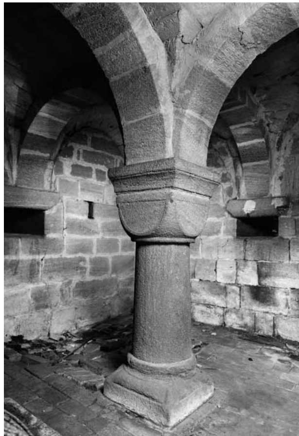
Obr. 2. Svojsín (okr. Tachov), kostel sv. Petra a Pavla. Přizemí věže sklenuté čtyřmi křížovými klenbami bez žeber do pasů a na střední sloup s kubickou hlavicí. Románská, byť neúplně dochovaná stavební etapa svojsínského kostela s mohutnou západní hranolovou věží patří mezi významné projevy stavitelství a architektury vznikající z iniciativy rané pozemkové šlechty v Čechách v době kolem poloviny 12. století. (Fotoarchiv Národního památkového ústavu, ú. o. p. v Plzni, foto J. Gryc, 1995)
