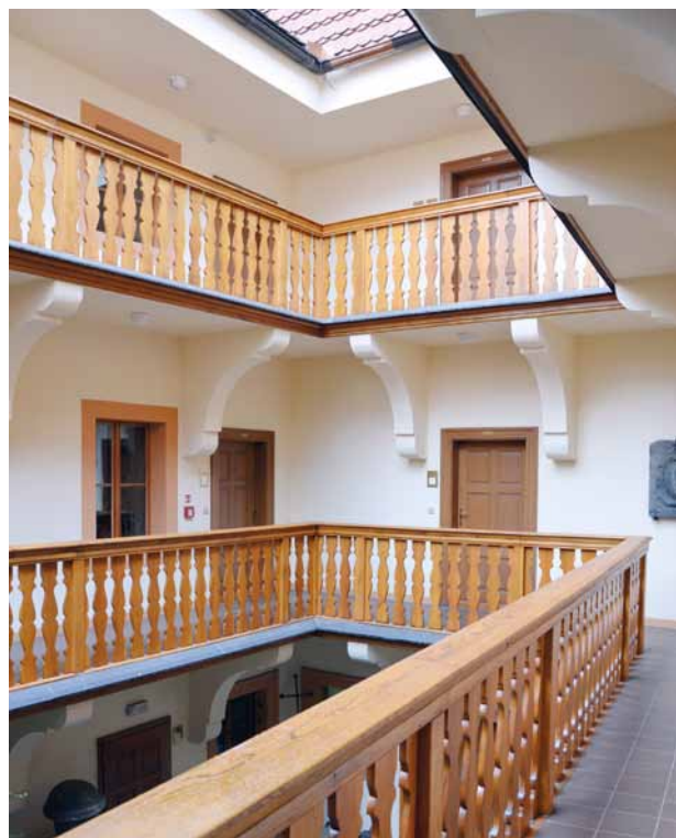
Plzeň, dům U Zlatého slunce. Dvorní fasády a pavlače po renovaci. (Foto J. Kaigl, 13. 1. 2015)
