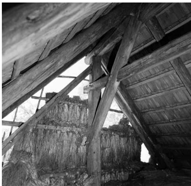
Obr. 3. Žďár (u Zborov, okr. Klatovy). Usedlost čp. 4. Krov stodoly. Koncová část hřebenového vazníku na kobylu s horní částí strmého valbového čela střechy se zbytky doškové krytiny. (Foto J. Škabrada, 1980)
