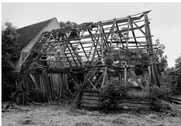
Obr. 2. Újezdec, usedlost čp. 7. Dožívající konstrukce stodoly, zba- vená střešní krytina. Kromě hřebenového vazníku na čtyřech slou- pech, jejichž umístění tvoří základní rozvrh stavby, je patrné rá- mové jádro spodní části objektu s výškou vjezdu na mlat. Střecha mimo vrata pokračovala dolů a končila až na nízkých roubených obvodových stěnách. (Foto J. Škabrada, 1979)
