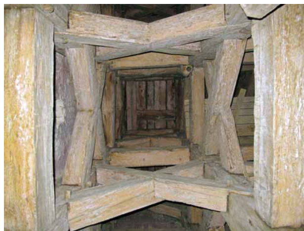
Obr. 2. Plzeň, františkánský kostel Nanebevzetí Panny Marie, věž-zvonice, průhled jedním z polí několikapodlažní vnitřní tesařské konstrukce směrem vzhůru. 70. léta 17. století. (Foto P. Danda, 25. 11. 2014)
