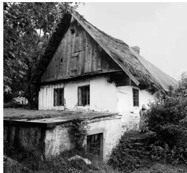
Obr. 1. Újezdec (okr. Klatovy), usedlost čp. 7. Štítové průčelí přední části domu. Vnějšíkovým rozpoznávacím znamením existence krovu na kobylu je uplatnění koncové části vaznic před plochou horní částí štítu. (Foto J. Škabrada, 1979)
