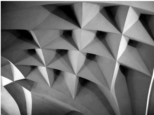
Chomutov, budova čp. 1 (radnice, bývalý zámek a komenda německých rytířů s kostelem sv. Kateřiny), střední sál ve zvýšeném přízemí. Pohled do střední části sklípkové klenby. (Foto J. Pachner, 2012)
