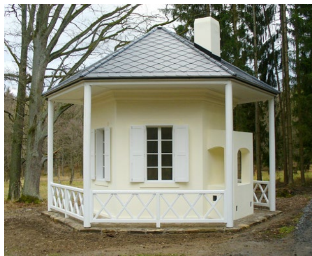
Obr. 6. Chocomyšl (okr. Domažlice), lovecký altán Kuchyňka. Stav po celkové rekonstrukci. (Foto D. Tuma, 2017)
