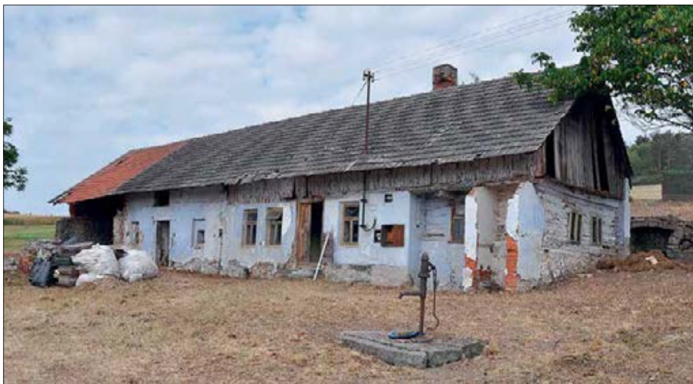
Kuníček (okres Příbram), usedlost čp. 4. Tradiční obytné domy zemědělských usedlostí jsou dnes pro své malé rozměry většinou buď demolovány, nebo velmi radikálně přestavovány. Většina hodnotných objektů tohoto druhu nepožívá památkové ochrany a jsou proto prakticky odsouzeny k zániku. Památková péče v podstatě nemá nástroje jak podobné stavby zachránit. Pro následující léta jsme si proto vytyčili za cíl pořádit alespoň základní dokumentaci nejohroženějších venkovských domů jižního Sedlčanska. První vlašťovkou se díky vstřícnosti majitele stala právě malá usedlost v Kuníčku na Petrovicku (foto J. Veselý).
