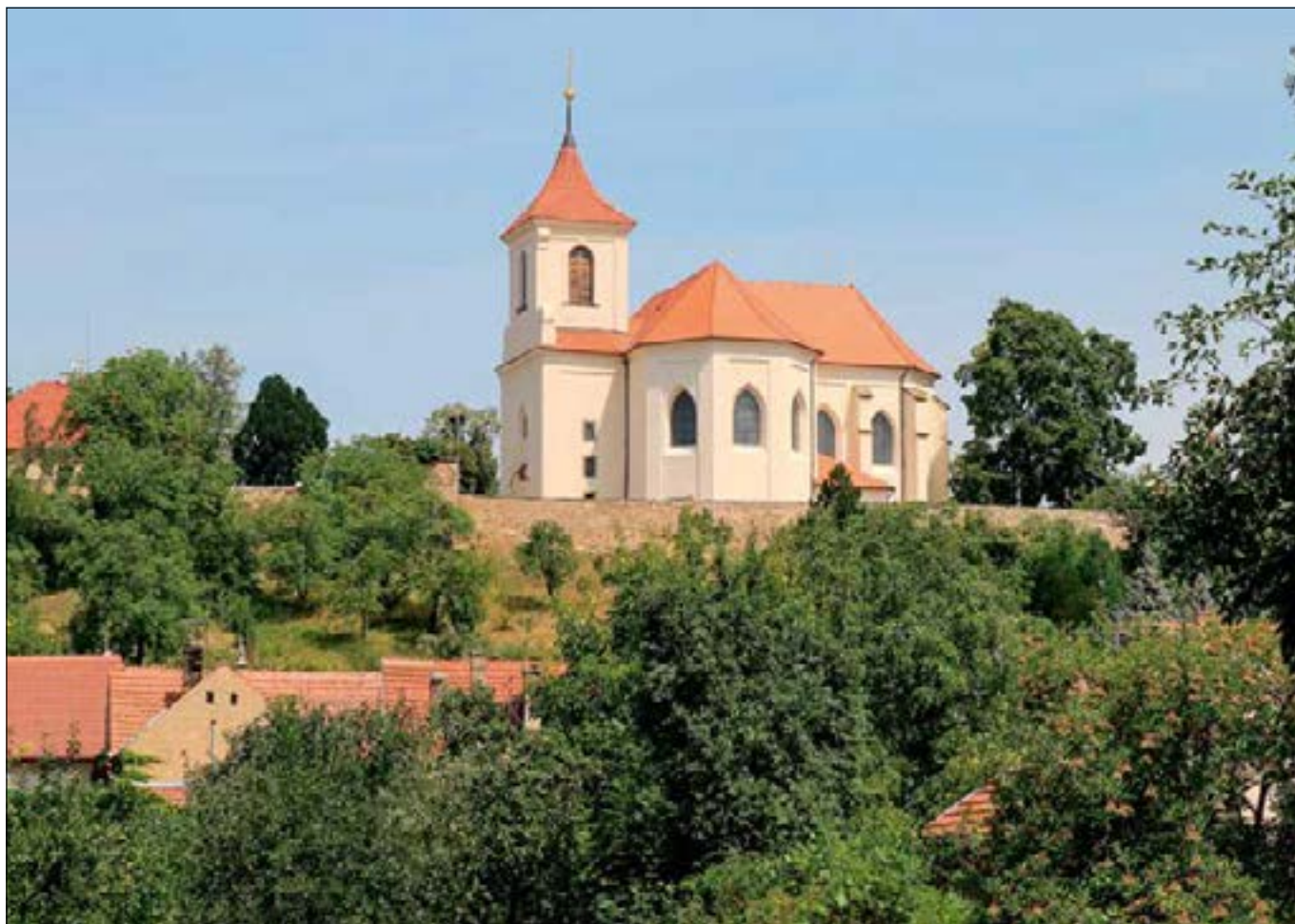
Sadská (správní obvod obce Nymburk), kostel sv. Apolináře. Dnešní podoba původně gotického kostela sv. Apolináře je výsledkem barokně gotické přestavby v letech 1737–1739, obnova vnějšího pláště byla financována z PZAD a probíhala v letech 2009–2018 a její součástí bylo též statické zajištění sakristie a ohradní zdi dle projektu Ing. J. Rineše (foto V. Láska).
