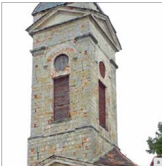
Kněžmost (správní obvod obce Mnichova Hradiště), kostel: a – průčelí kostela vystavené dlouho trvající degradaci mělo ve velkém rozsahu opadané omítky, které se na věži nezachovaly téměř vůbec. Při obnově členění se vycházelo jednak z archivních fotografií, ale i z fragmentů profilací zjištěných při průzkumu fasády. Detaily provedení byly upřesňovány v rámci památkového dohledu v průběhu prací; b – detail obnovy architektonického členění věže (foto E. Vyletová).
