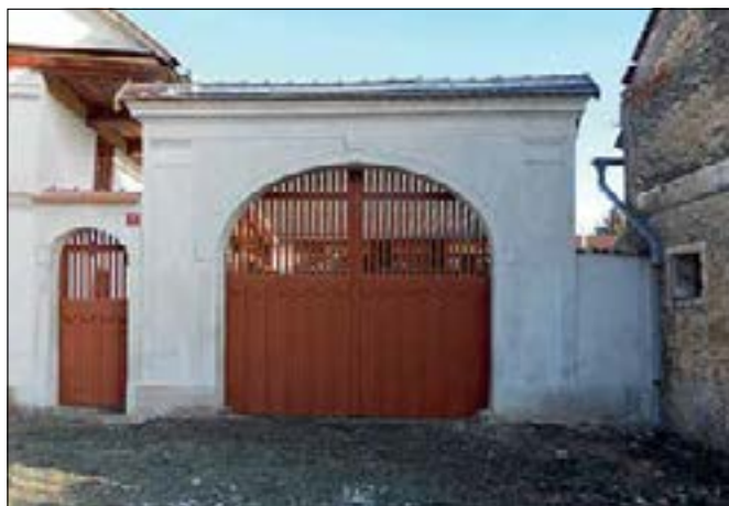
Zamachy – Syslov (správní obvod obce Mladá Boleslav), usedlost čp. 19 – pohled na obnovenou bránu s novými vraty, vyrobenými jako replika podle dochovaného původního křídla. K dokončení celkové obnovy hlavního průčelí usedlosti zbývá provedení jednotného fasádního nátěru (foto J. Berková).
