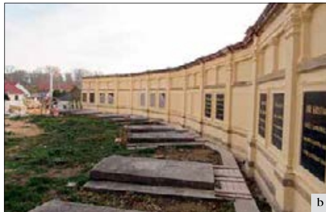
Hořín (správní obvod obce Mělník), pohřební kaple Lobkowiczů: a – část ohradní zdi před obnovou; b – ohradní zeď po obnově (foto před restaurováním litinových křížů na hrobních deskách). Ohradní zeď byla staticky zajištěna, nově omítnuta a doplněna novými odlítky patek, hlavic a rohy lemování náhrobních desek. Restaurovány byly i náhrobní desky na ohradní zdi a byla dokončena také obnova samotných hrobů a litinových křížů na hrobních deskách (foto V. Hlaváčková).
