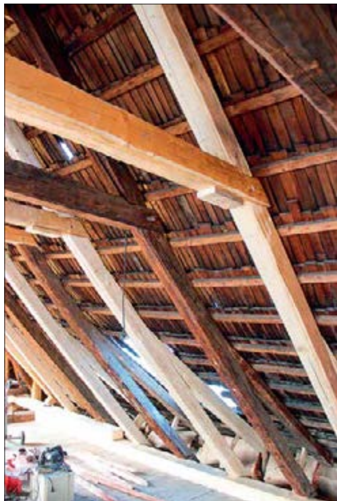
Kutná Hora (správní obvod obce Kutná Hora), Jungmannovo náměstí, dům čp. 479. Při obnově střechy byl poddimenzovaný krov zesílen vložением mezilehlých „áček“, jejichž prohnutý tvar krokví vznikl ohýbáním v období předchozí zimy. Dřevěný šindel byl zachován jako pohledový „záklop“ a funkci izolační vrstvy na celé ploše střechy tvoří pásy ovčího rouna nad krokvemi. Jde o zateplení krovu s použitím tzv. nadkroevní izolace, které bylo v Kutné Hoře realizováno zcela poprvé (foto A. Pospíšil).
