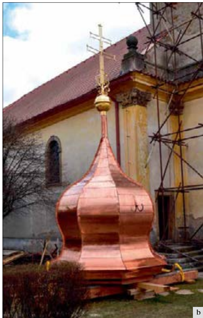
Družec (správní obvod obce Kladno), kostel Nanebevzetí Panny Marie: a – dokončovací práce při instalování opravené střechy věže s postupným vyzdvižením částí střechy věže pomocí jeřábu; b – vrchní část pláště věže nad lucernou, s horní bání, pozlacenou makovicí a křížem, připravená k transportu a osazení na opravený krov (foto E. Volfová).
