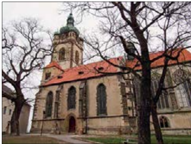
Mělník (správní obvod obce Mělník), kostel sv. Petra a Pavla. Pohled na obnovenou jižní střešní rovinu lodi. Kvůli dožilé střešní krytině docházelo k zatékání do půdního prostoru a panovaly obavy, že by zatékáním mohlo dojít k poškození zrestaurovaných a obnovených částí v interiéru (foto V. Hlaváčková).
