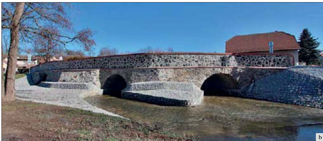
Kamenné Mosty (správní obvod obce Čáslav), silniční most přes Hostačovku: a – stav před obnovou, únor 2016; b – stav po dokončení celkové obnovy, únor 2019 (foto A. Rákosníková).
