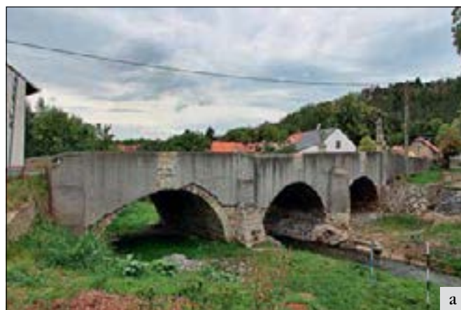
Sazená (správní obvod obce Slaný), silniční most přes Bakovský potok: a – stav po částečném otlučení torkretu v rámci projektové přípravy, září 2015; b – stav po celkové obnově včetně doplněných podstavců soch. Doufejme, že sochařskou výzdobu se podaří doplnit v blízké budoucnosti, březen 2019 (foto A. Rákosníková).
