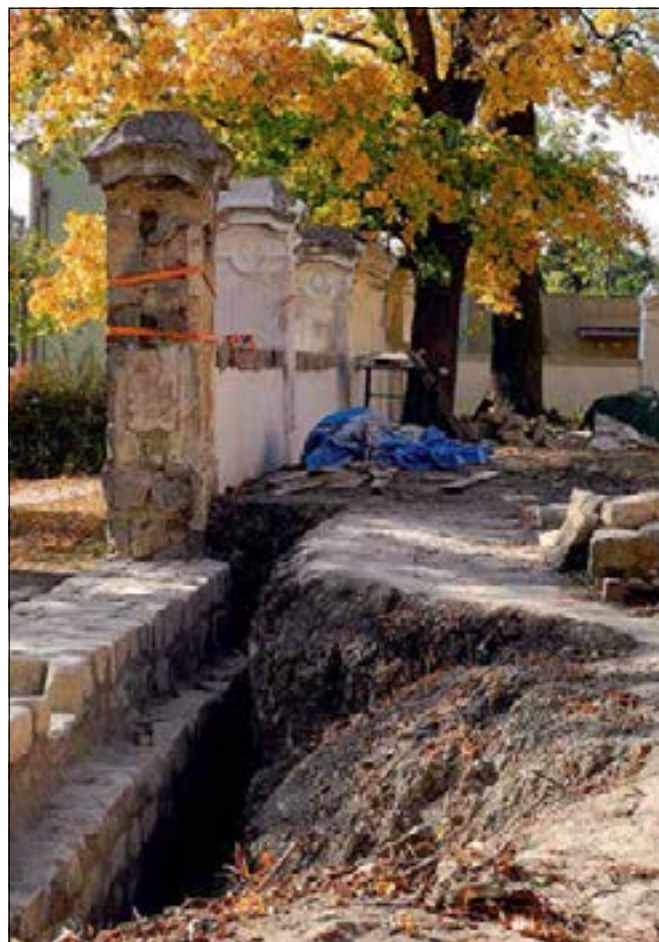
Březno (správní obvod obce Mladá Boleslav), barokní opločený areál zámku. Při přezdívaní staticky narušených částí byl proveden transfer částí pilířů, které byly po přezděni osazeny zpět. To umožnilo zachování původních bohatě tvarovaných hlavic (foto E. Vyletová).
