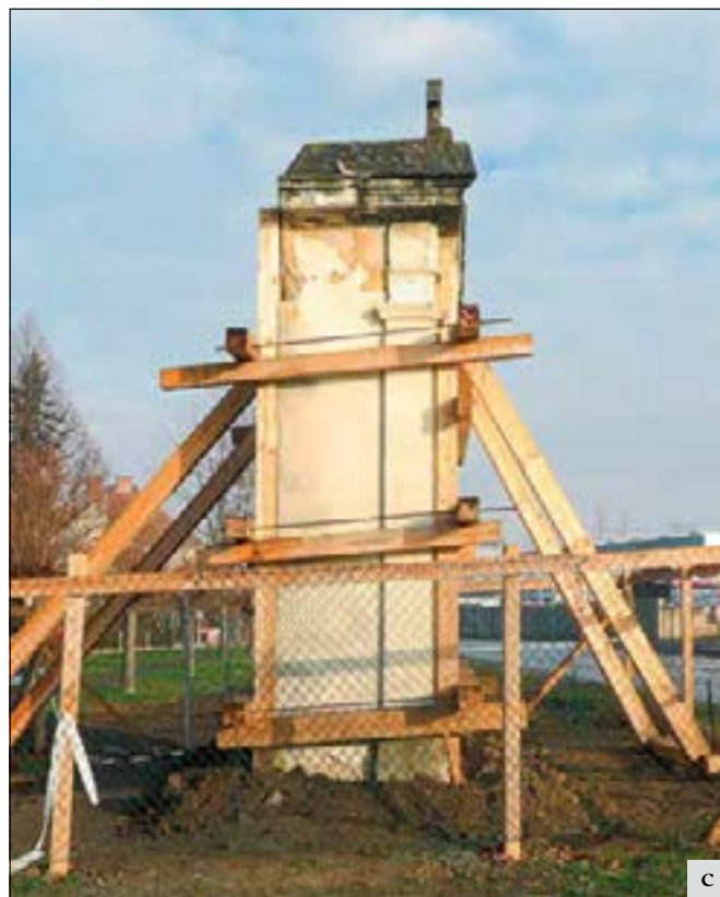
Vrábí, Brandýs nad Labem (správní obvod obce Brandýs na Labem – Stará Boleslav), výklenková kaple čp. 41 poutní cesty do Staré Boleslavi: a – stav kaple před narovnááním (foto J. Černochovej), b – narovnáání kaple pomocí heverů (foto P. Volná), c – stav kaple po narovnáání (foto P. Volná).
