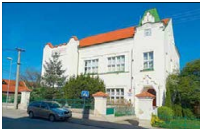
Záryby (okres Praha-východ), škola čp. 92. Plánová dokumentace školy v Zárybech byla vypracována v letech 1904–1906 místním stavitelem Františkem Hradeckým, který stavbu také řídil. Nová škola byla slavnostně otevřena v září 1907 a definitivně dokončena v následujícím roce. Fotografie zachycuje hlavní uliční průčelí s plastickou modelací fasády. Místní škola se intaktně dochovala do současnosti včetně dispozice, hmoty objektu a původních stavebních prvků a detailů. Zároveň budova slouží od otevření nepřetržitě svému primárnímu účelu (foto M. Karásková).
