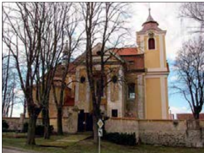
Chlumín (správní obvod obce Neratovice), kostel sv. Máří Magdalény. V roce 2018 proběhla celková rekonstrukce vnějšího pláště věže kostela (foto V. Hlaváčková).
