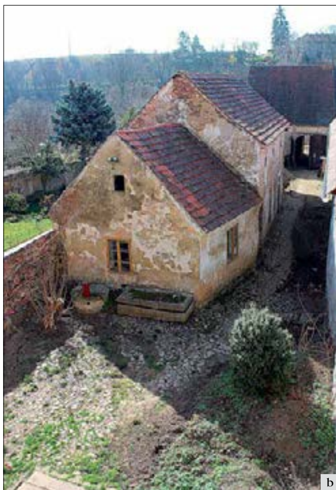
Žebrák (okres Beroun), dům čp. 23, dvorní průčelí od jihu (a), dvorní objekt a stodola od severu (b). Zděná pavlač s pultovou stříškou přistavěná k dvornímu průčelí, zachovaná souvrství historických omítek, položení sřešní krytiny bez oplechování, valouny vydlážděný dvůr se studnou a kamenným máchadlem, prostorové uspořádání budov bez novodobých přístaveb. To jsou jen některé z řady prvků, které se mohou zdát všední, viděny izolovaně, které ale z našich měst a vesnic postupně a bez povšimnutí mizejí. Jejich souhrn v daném případě podtrhuje památkovou hodnotu areálu a přispívá k jeho celkové malebnosti (foto A. Jančíková).
