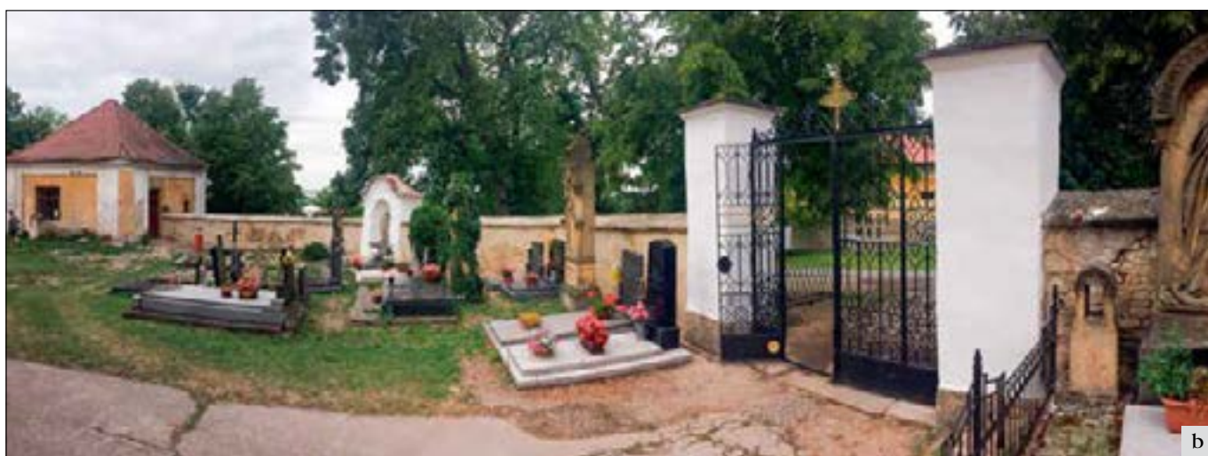
Činěves (správní obvod obce Poděbrady), areál kostela sv. Václava: a – ohradní zeď s kapličkami kostela sv. Václava před obnovou; b – původní zdivo části ohradní zdi bylo zcela rozebráno a znovu vyzděno z původního materiálu doplněného plnými cihlami a nová zeď nahozena vápennou maltou důkladně roztočenou; c – vykloněná kaplička byla zajištěna opěrákem. Obnova byla provedena za použití tradičních materiálů a technologií (foto D. Hofreiterová).
