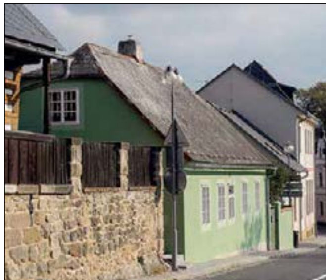
Mnichovo Hradiště (správní obvod obce Mnichova Hradiště, dům čp. 309. Při opravě domu čp. 309 se podařilo zachovat v celistvosti klasicistní podobu včetně tabulkových oken v líci fasády. Právě truhlářsky zhotovené repliky oken umístěných v líci fasády byly podstatnou součástí celé obnovy. Při opravě fasády byla odstraněna vrstva nevhodného břizolitového nástřiku a obklad soklu. U oken byly obnoveny malované šambrány dle nálezu na fasádě (foto E. Vyletová).
