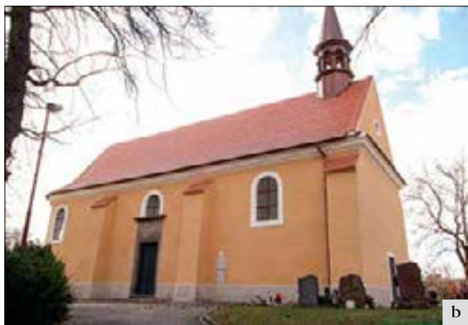
Dobříš (správní obvod obce Dobříš), hřbitovní kostel Povýšení sv. Kříže, obnova vnějšího pláště kostela proběhla za využití tradičních materiálů a technologií: a – původní stav kostela před obnovou vnějšího průčelí; b – stav fasády po obnově (foto M. Gottwaldová).
