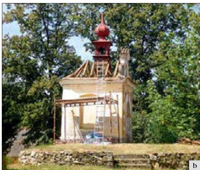
Jetřichovice (správní obvod obce Sedlčany), kaple sv. Jana Nepomuckého: a – fotografie kaple sv. Jana Nepomuckého z roku 1968 (foto L. Štěpánek); b – obnovena byla střecha, degradovaný křídlový štít, nově oplechována zvonička a repasována dřevěná barokní mříž ve vstupu. Při statickém zajištění potrhaného zdiva byla kaple sepnuta železobetonovým věncem, zkomolená korunní římsa byla nově vysazena a vymodelována podle předem sejmuté šablony; c – před jednoduchou barokní barevností upřednostnili restaurátoři výjimečnou a náročnou empírovou podobu nalezenou ve spodní vrstvě omítek (foto H. Řepková).
