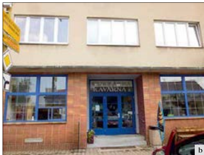
Sedlec u Votic (správní obvod obce Sedlčany), bývalá záložna (později spořitelna): a, b – prolomení nového vstupu do průčelí bývalé spořitelny. Vjezd do dvora a vstupy do záložny, obchodu a bytového domu jsou v pravé vyšší části průčelí. Oříškem bylo, jak udělat kvalitní dveře do průčelí, v němž se žádný prvek nedochoval v původní podobě. Vytvoření nového vstupu bylo povoleno za podmínky citlivého přístupu. Jako předloha pro podobu zcela nových dveří posloužila plánová dokumentace z roku 1936, dochovaná původní vrata na dvůr z doby výstavby domu (foto H. Řepková).
