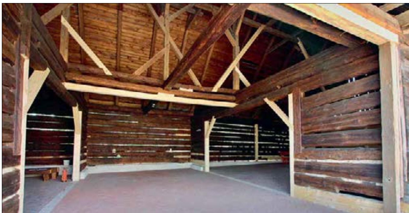
Mnichovo Hradiště (správní obvod obce Mnichovo Hradiště), stodola v areálu děkanství čp. 232, stav po dokončení obnovy roubení, červen 2018 (foto A. Rákosníková).
