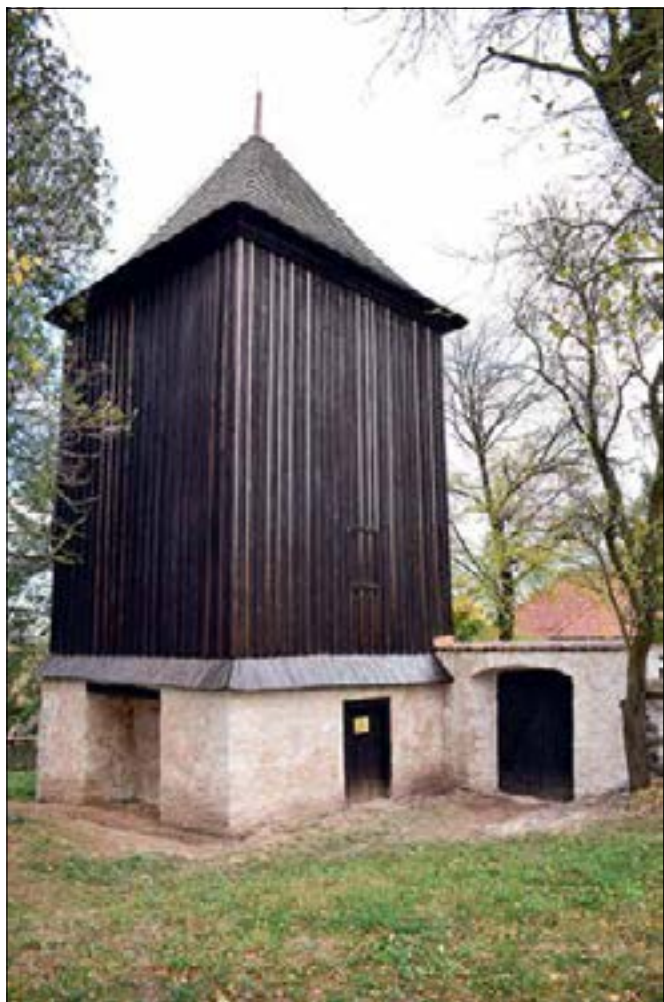
Třebonín (správní obvod obce Čáslav), zvonice v areálu kostela sv. Matouše po celkové obnově vnějšího pláště (foto B. Schmidová).
