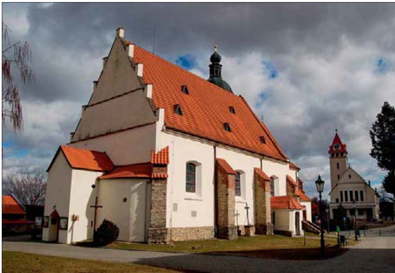
Vlašim (správní obvod obce Vlašim), kostel sv. Jiljí, celková oprava vstupní předsíně. Zdivo a klenby předsíně byly porušeny velkými trhlinami, které vznikly souhrou mnoha nepříznivých okolností. Zejména však zatížením a vibracemi měchů varhan, které jsou umístěné v patře přístavku a ležely na poškozené podlaze, která přímo naléhala na klenbu předsíně. Na zdivo také nepříznivě působil narušený krov. Měchy byly demontovány a opraveny a podlaha pod nimi provedena nově. Předtím však muselo být zdivo sanováno – trhliny vyklínovány a injektovány a provedeno stažení příčnými táhly i podomítkovou výztuží. Nakonec byl opraven krov a fasády a položena nová krytina z pálených bobrovek (foto D. Primusová).
