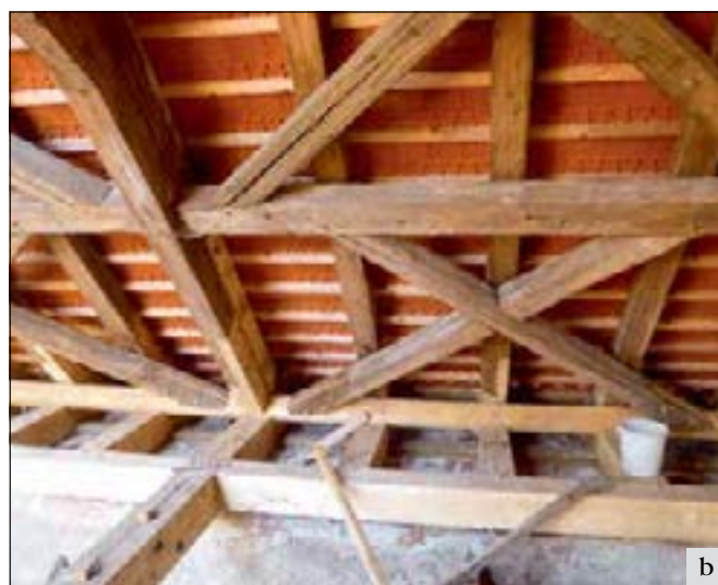
Praskolesy (správní obvod obce Hořovice), kostel sv. Mikuláše: a – krov lodi před obnovou. Spodní část krovu byla zcela degradovaná; b – náročná obnova krovu vyžaduje skutečné odborníky, na sv. Mikuláši je s výjimkou zcela rozpadlé pozednice, která byla kvůli nepřístupnosti nahrazena železobetonovým věncem, převážná část protěz a spojů provedena tradiční tesařskou technikou (foto H. Řepková).
