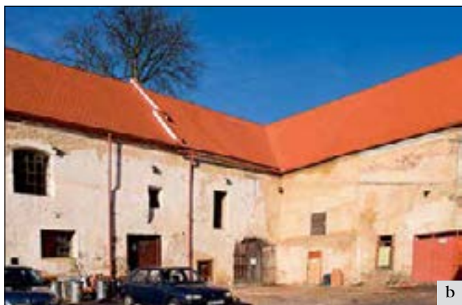
Hvozďany (správní obvod obce Příbram), špýchar: a – před opravou střechy (foto M. Balková); b – špýchar po opravě střechy (foto E. Kosová).
