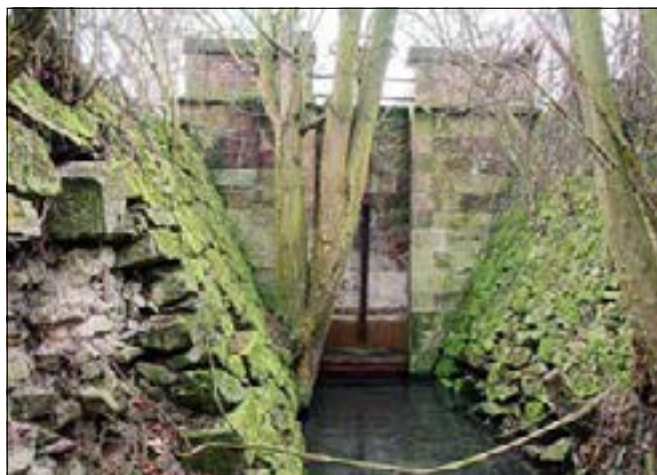
Ratenice (okres Kolín), zaniklý rybník Domek, nazývaný též Klenot. Byl založen v roce 1512 s údajnou rozlohou 416 ha, zrušený před rokem 1836 (dle portálu Cesty a památky). Zachovány jsou hráz rybníka, renesanční bašta – jediná toho druhu ve Středočeském kraji – a unikátní vypouštěcí zařízení (na snímku), upravené nepochybně ještě i po zrušení rybníka (foto V. Láška).
