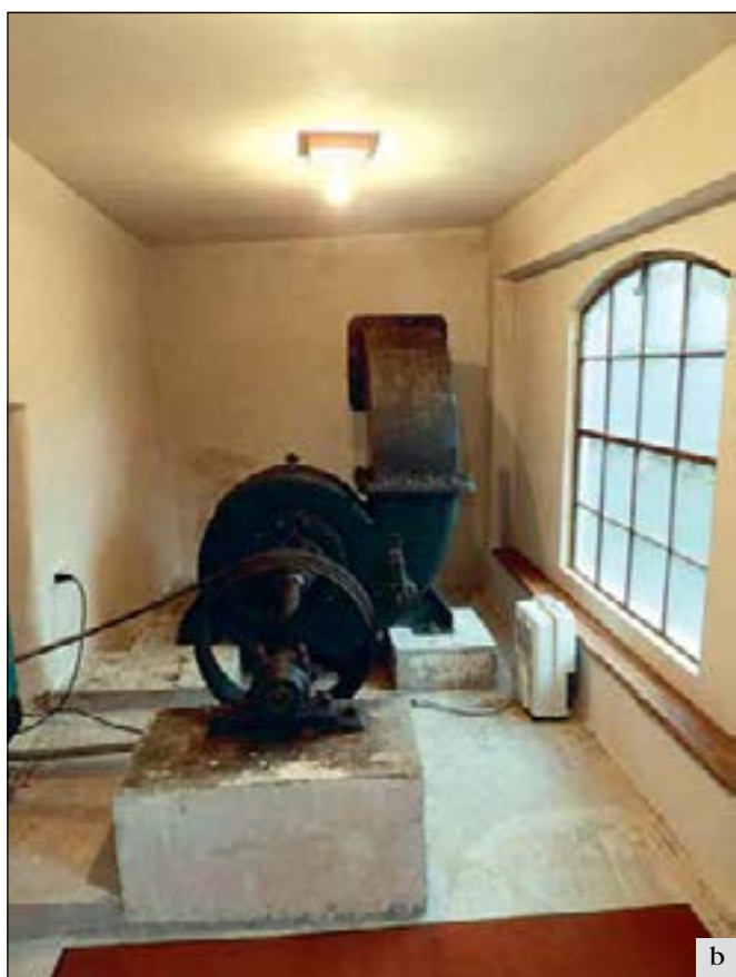
Bratčice (správní obvod obce Čáslav), mlýn čp. 34: a – návodní strana mlýna s turbínovým přístavkem a přiváděčem vody, který ve 30. letech 20. století nahradil starší vanatroky a vodní kolo, stav po obnově; b – interiér turbínového domku s částí dochované technologie, stav po obnově v roce 2018 (foto J. Berková).
