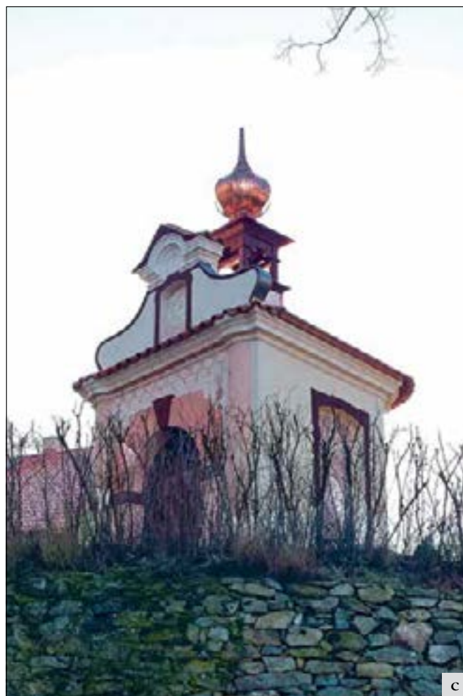
Jetřichovice (správní obvod obce Sedlčany), kaple sv. Jana Nepomuckého: a – fotografie kaple sv. Jana Nepomuckého z roku 1968 (foto L. Štěpánek); b – obnovena byla střecha, degradovaný křídlový štít, nově oplechována zvonička a repasována dřevěná barokní mříž ve vstupu. Při statickém zajištění potrhaného zdiva byla kaple sepnuta železobetonovým věncem, zkomolená korunní římsa byla nově vysazena a vymodelována podle předem sejmuté šablony; c – před jednoduchou barokní barevností upřednostnili restaurátoři výjimečnou a náročnou empírovou podobu nalezenou ve spodní vrstvě omítek (foto H. Řepková).
