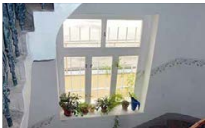
Sídlo NPÚ ÚOP SČ v Sabinově ulici. Okno na schodišti zadní budovy po renovaci (foto L. Havlovic).
