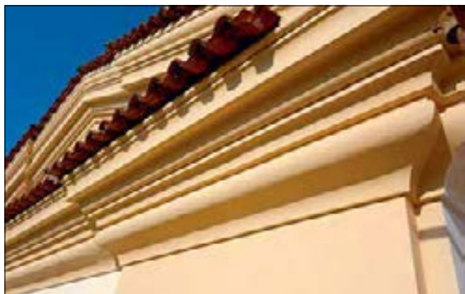
Odolena Voda, (správní obvod obce Brandýs nad Labem – Stará Boleslav), kostel sv. Klimenta, detail jižního průčelí po obnově. V roce 2018 se podařilo obnovit jižní průčelí kostela. Opravené římsy zachovávají preciznost dienzenhoferovské architektury. Po určitých rozpacích v předchozích etapách obnovy fasád byla na základě průzkumu a prověření na vzorcích obnovena okrovobílá barevnost v odstínech podle nejstarší dochované barevnosti, a to v modifikované vápenné technologii (foto J. Žižka).
