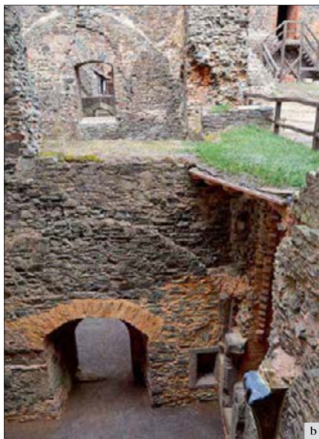
Krakovec (správní obvod obce Rakovník), zřícenina hradu: a – dokončená oprava interiéru západního křídla s vřetenovým schodištěm a kamenickými články, které byly restaurovány po předchozí destrukci způsobené trvalou nadměrnou vlhkostí; b – dokončené opravy s restaurováním kamenických článků v pohledu shora, ze spojovacího můstku (foto E. Volfová).
