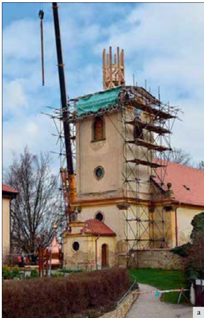
Družec (správní obvod obce Kladno), kostel Nanebevzetí Panny Marie: a – dokončovací práce při instalování opravené střechy věže s postupným vyzdvižením částí střechy věže pomocí jeřábu; b – vrchní část pláště věže nad lucernou, s horní bání, pozlacenou makovicí a křížem, připravená k transportu a osazení na opravený krov (foto E. Volfová).
