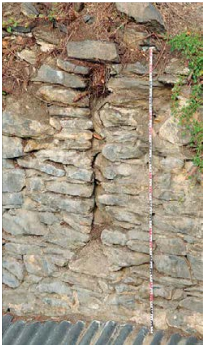
Kolín, parkánová hradba městského opevnění severovýchodně od kostela sv. Bartoloměje. Po odstranění vegetace se objevil v českých zemích dosud ojedinělý typ lučičnické střílny se sklopenou, rozšiřující se dolní částí (foto V. Razím, 2018).
