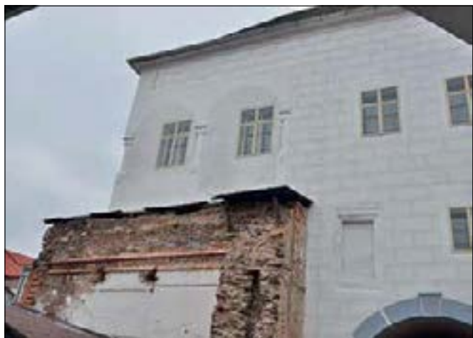
Kolín, zámek čp. 160 a 545. Operativní průzkum a dokumentace fasád zámku probíhá postupně po řadu let. V letech 2017 a 2018 byly nejprve z mobilní plošiny a následně z lešení zpřístupněny jižní a východní fasáda západního zámeckého křídla. Na základě nálezů a jejich podrobné dokumentace se pak během obnovy omítek podařilo částečně iluzivně rekonstruovat zazděnou mohutnou raně renesanční arkádu ve druhém patře (foto J. Veselý, 2018).
