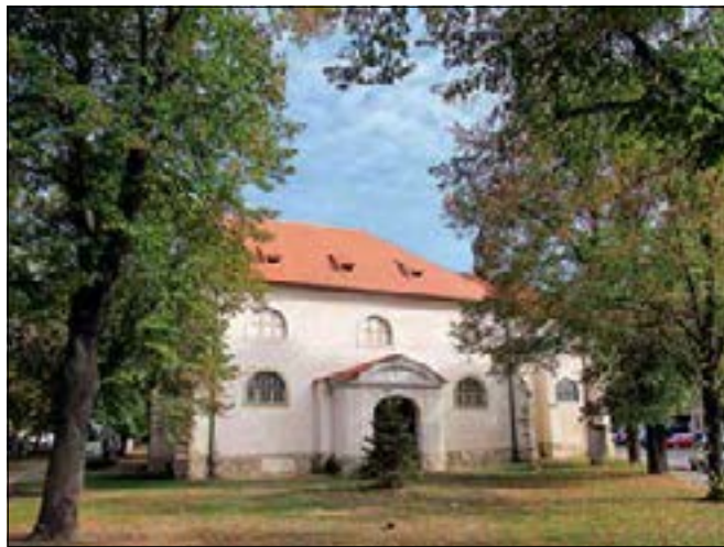
Kostelec nad Labem (správní obvod obce Neratovice), kostel sv. Víta. Dožilá prejzová krytina byla nahrazena bobrovkou, která byla doložena na historických fotografiích. Dle historických fotografií byla upravena také konstrukce a vzhled vikýřů (foto V. Hlaváčková).
