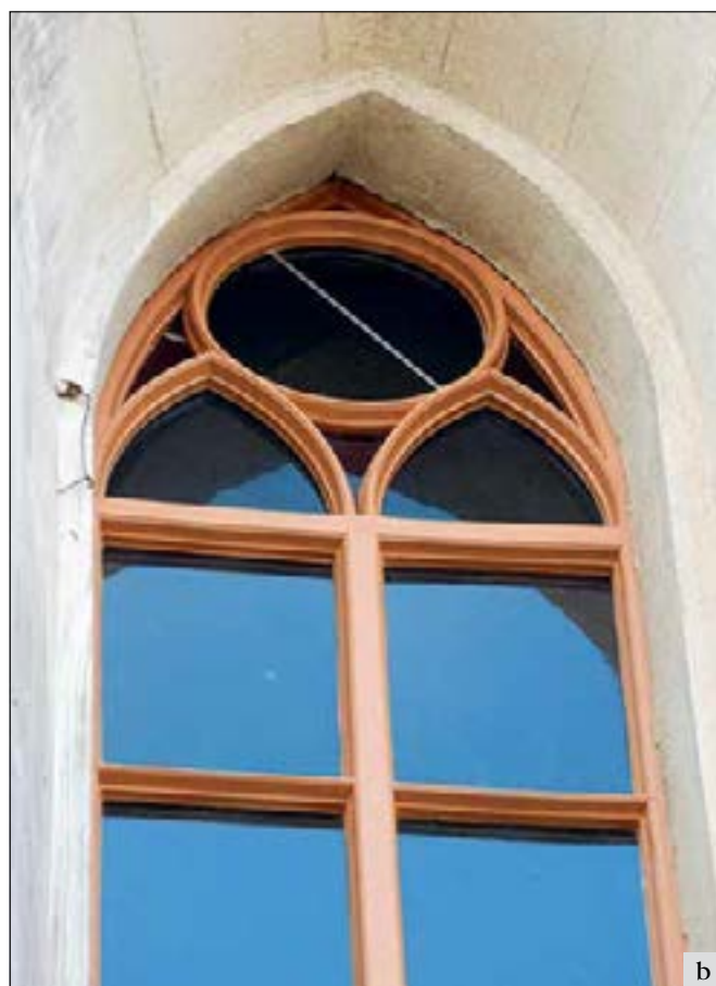
Vidim (správní obvod obce Mělník), kostel sv. Martina: a – stav okenních výplní lodi před obnovou; b – po dokončení prací. Nepřesný tvar záklenků, který je výsledkem utilitárně pojaté obnovy z přelomu 60. a 70. let 20. století, bude opraven v rámci připravované celkové obnovy fasády (foto J. Berková).
