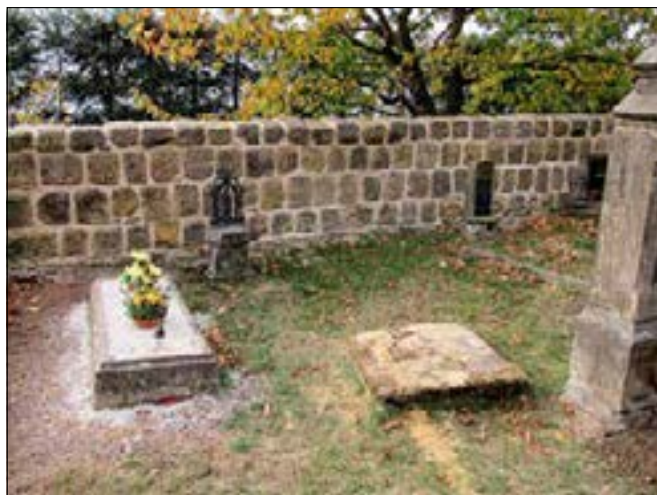
Mšeno – Hradsko (správní obvod obce Mělník), kostel sv. Jiří. Pohled na ohradní zeď areálu z pískovcových kvádrů zvaných místně „štuky“ po obnově. Ohradní zeď byla očištěna od nánosů mečů a náletů, poškozené „štuky“ byly nahrazeny novými a zeď byla nově vyspárována (foto V. Hlaváčková).
