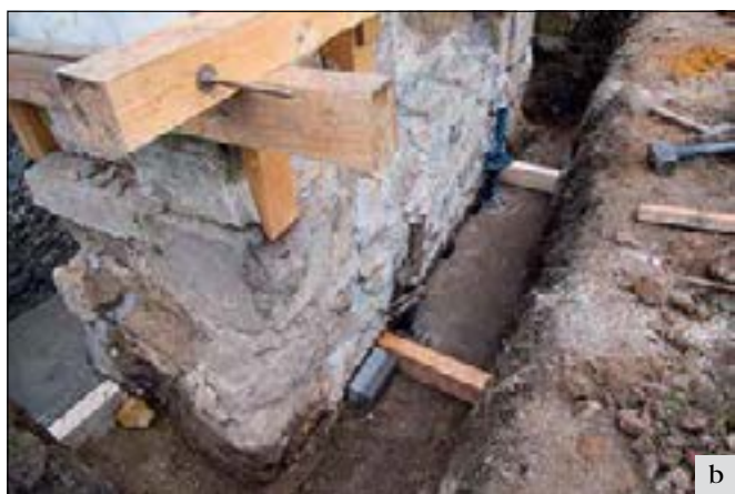
Vrábí, Brandýs nad Labem (správní obvod obce Brandýs na Labem – Stará Boleslav), výklenková kaple čp. 41 poutní cesty do Staré Boleslavi: a – stav kaple před narovnááním (foto J. Černochovej), b – narovnáání kaple pomocí heverů (foto P. Volná), c – stav kaple po narovnáání (foto P. Volná).
