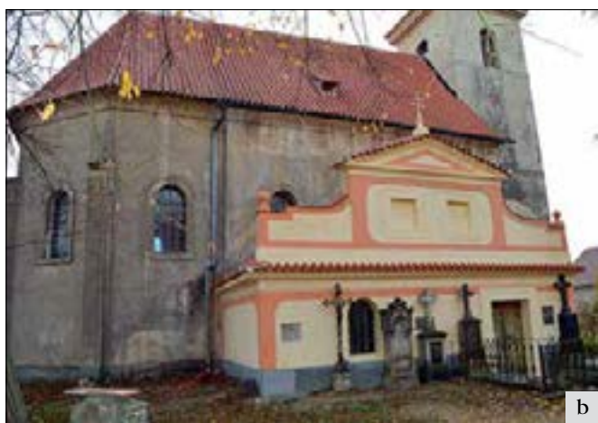
Svárov (správní obvod obce Kladno), farní kostel sv. Lukáše: a – severní přístavek s předsíní a sakristií, stav před opravou v roce 2017; b – severní přístavek po dokončení opravy fasádních omítek, doplněním kamenických detailů, postranních čuček a soklu kříže, opravy krovu a výměny střešní krytiny z pálených bobrovek (foto E. Volfová).
