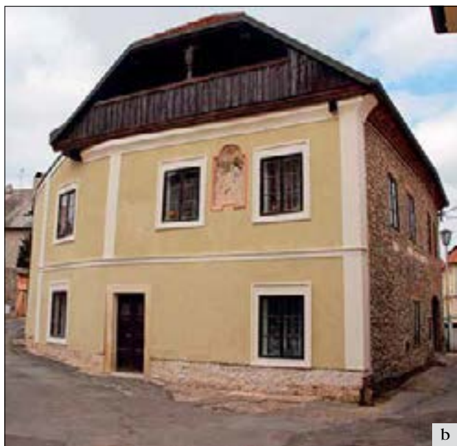
Kutná Hora (správní obvod obce Kutná Hora), Orelská ulice, dům čp. 272. Poškozená fasáda byla rekonstruována při použití čisté vápenné technologie omítek a nátěru. Při snímání degraďovaných zbytků staré fasády byl v přízemí mezi vstupem a pravým oknem učiněn překvapivý nález – zazděné gotické pravoúhlé okno mimořádných rozměrů, srovnatelné např. s Dačického domem. Čelní fasádě bylo navrženo původní architektonické členění podle dochovaných zbytků a dřevěná profilovaná římsa podle historických fotografií. Sokl, freska ve štukovém rámu a další strany domu budou obnovy v následujících etapách: a – jižní fasáda před obnovou, b – jižní fasáda po rekonstrukci (foto A. Pospíšil).
