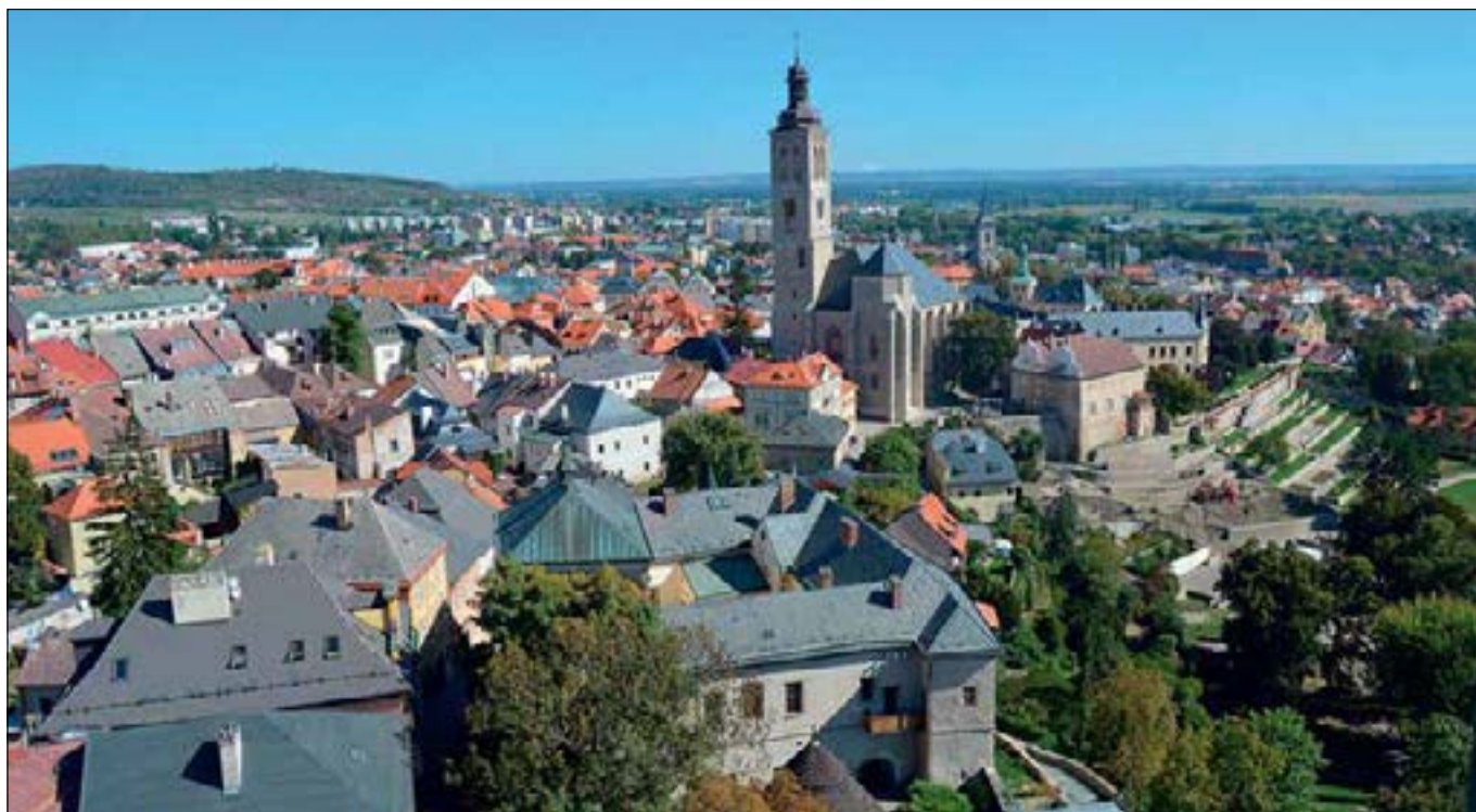
Kutná Hora (správní obvod obce Kutná Hora), pohled na město z věže jezuitské koleje. I z tohoto nadhledu je patrné, že město s celou svou typickou strukturou je zachováno bez vážných poškození, která bývají u jiných srovnatelných lokalit patrná právě při takovém pohledu na střechy, opět tak můžeme konstatovat, že významná součást Světového dědictví, kterou je město Kutná Hora již od roku 1995, je stále tím cenným historickým sídlem, které zná a rád navštěvuje celý svět (foto J. Mrázek).
