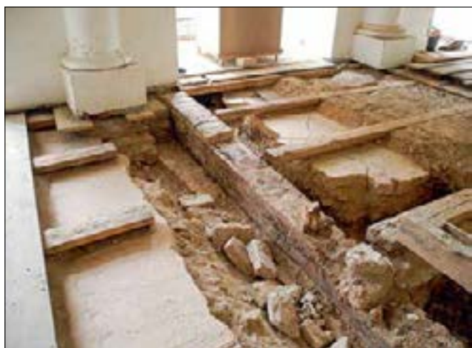
Brandýs nad Labem (správní obvod obce Brandýs nad Labem), zámek. Zahájena byla obnova místností 1. patra severního křídla. Podlaha v kapli byla z důvodu poškození dřevomorkou rozebrána. Snímek ukazuje nálezovou situaci po rozkrytí, která byla dokumentována v rámci archeologického výzkumu. Nejstarší dochovanou vrstvu tvořila pečlivě utužená maltová vrstva, která odpovídala úrovni původních patek polosloupů odhalených pod současnou úpravou. Dřevěné prvky byly dendrochronologickým průzkumem datovány do několika etap 18. a 19. století, v podlaze 2. patra do poloviny 16. století. Snímek současně poukazuje na význam průzkumů a dokumentace v průběhu oprav i na to, k jakým ztrátám by mohlo při jejich zanedbání a poškození nálezů dojít (foto E. Vyletová).
