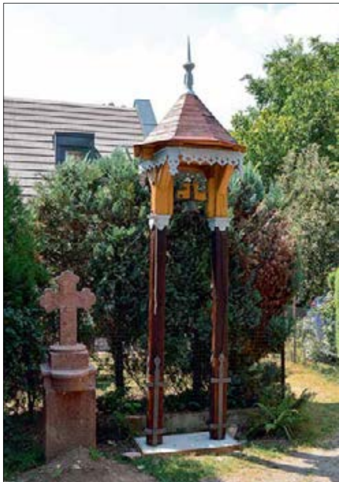
Svatý Jan pod Skalou – část Sedlec (správní obvod obce Beroun), dřevěná zvonička u bývalého brodu a dnešního mostu přes Kačák. Zvonička sestává z dvojice dubových dřevěných stojek nesoucích osmibokou jehlanovou stříšku podpíranou pásky (měkké dřevo), spodní lem stříšky je zdoben řezbou na způsob krajky (měkké dřevo s polychromií). Zvonička byla dle všeho vystavěna v roce 1911 tesaři p. Šurdou se synem. Střešní plechová krytina byla nahrazena štípaným šindelem, makovice s hrotem byla repasována (foto D. Havlíková).
