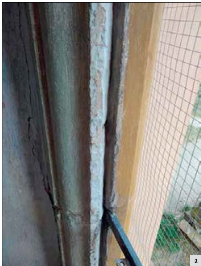
Velvary (správný obvod obce Slaný), kostel sv. Jiří, vitraje a kamenná ostění, průběh restaurování: a – stav po demontáži, b – stav po dokončení prací. Třetí etapa restaurování vitrají, které doprovází restaurátorské práce na kamenných ostěních. Předmětné vitraje zřejmě pochází z kostela sv. Kateřiny ve Velvarech, rozhodně však nebyly primárně určeny do těchto konkrétních okenních otvorů. Při instalaci byla v minulosti necitlivě lokálně osekána kamenná renesanční ostění a skleněné pláty byly do těchto otvorů vloženy nestandardním způsobem, bez lůžka, jen přichyceny maltou a kovovými vzpěrami. Z tohoto důvodu bylo přistoupeno k tomu, že pro každé ostění bylo proříznuto hlubší úžlabí, do kterého byly vitraje mírně zasunuty a dále zatmeleny (foto M. Škrancová, J. Motýčka).
