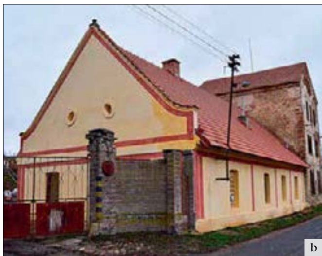
Olešná (správní obvod obce Rakovník), areál zámku: a – jižní křídlo východní části hospodářského dvora s bývalým lihovarem, stav před zahájením oprav v létě 2016; b – jižní křídlo východní části hospodářského dvora s bývalým lihovarem, stav po vztyčení nových krovů, položení pálené krytiny a opravě fasádních omítek (foto E. Volfová).
