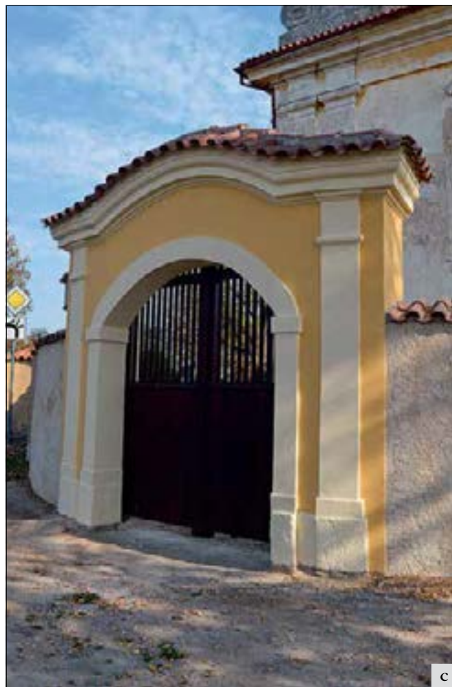
Horní Kruty (správní obvod obce Kolín), brána kostela sv. Václava: a – pohled na bránu před jejím rozebráním z roku 2014; b – terénní skica profilace římsy nad pilastrem před rozebráním brány, podle které se vyráběla okovaná šablona římsy nové brány; c – pohled na kopii historické brány. Brána byla rozebrána a zpětně vystavěna na betonovém základu formou anastyulózy, vrata jsou kopii dle dochovaného torza historické výplně, avšak bez zřetelné povrchové úpravy. Ta byla laděna k ostatním dveřním výplním kostela (kresba, 2015 a foto D. Havlíkové).
