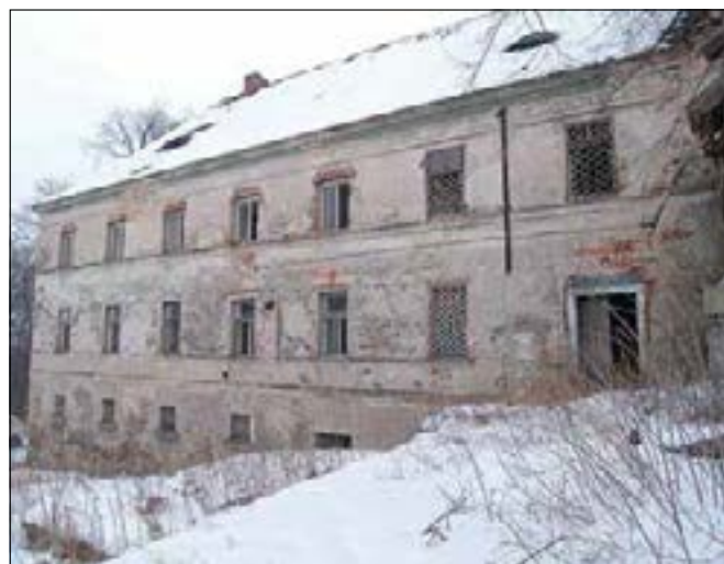
Soutice (okres Benešov), areál zámku, klasicistní správcovská budova. Na jihu dvůr uzavírá třetí, nejnižší umístěná část jihovýchodního křídla – mohutná dvoupatrová správcovská budova, zastřešená sedlovou, valbami ukončenou střechou a složená z několika funkčně odlišných částí, obytného i správního a hospodářského účelu. Fasádu s horizontálním členěním dělí mezipatrová římsa nad přízemím a průběžné parapetní římsy pod okenními otvory prvního a druhého patra a zakončuje kladí s architrávem, s vlysem zdobeným páskou a výrazně profilovanou římsou. Přízemí dominuje trojlodní prostor stáží zaklenutý plackami do pasů, které vyběhají z římsových hlavic kamenných sloupů (foto Š. Koukalová).
