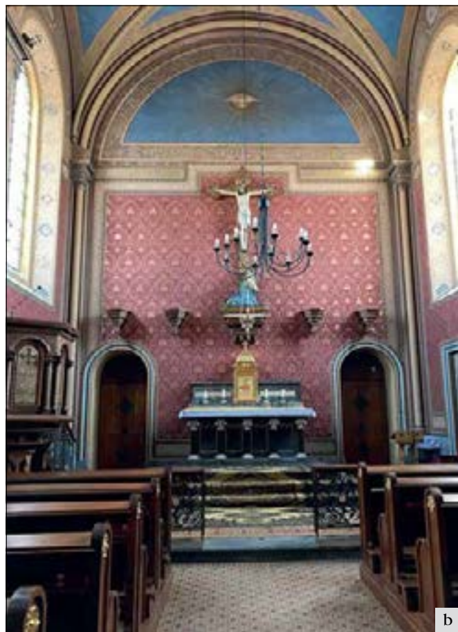
Dolní Břežany (správní obvod Černošice), celková obnova a restaurování šablonové výmalby kaple: a – stav před zahájením prací; b – stav po dokončení. Malířská výzdoba se nachází na všech stěnách kaple. V dolních partiích došlo k poškození vlivem vztlínající vlhkosti, zřejmě z tohoto důvodu v minulosti proběhlo nahrazení omítkové vrstvy a původní malba byla ztracena. Dle nalezené historické fotografie se podařilo obnovit i tyto ztracené partie, které měly imitovat mramor a volně tímto dekorem navazovat na oltář kaple. Lokálně došlo k mechanickému poškození malby i v horních partiích a ztrátám včetně zlacených částí jednotlivých prvků. V partiích klenby došlo k poškození malovaného hvězdného nebe dlouhodobým zatékáním dešťové vody, včetně destrukce podkladové vrstvy (foto J. Motyčka, L. Maděrová).
