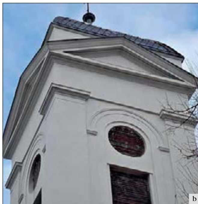
Kněžmost (správní obvod obce Mnichova Hradiště), kostel: a – průčelí kostela vystavené dlouho trvající degradaci mělo ve velkém rozsahu opadané omítky, které se na věži nezachovaly téměř vůbec. Při obnově členění se vycházelo jednak z archivních fotografií, ale i z fragmentů profilací zjištěných při průzkumu fasády. Detaily provedení byly upřesňovány v rámci památkového dohledu v průběhu prací; b – detail obnovy architektonického členění věže (foto E. Vyletová).
