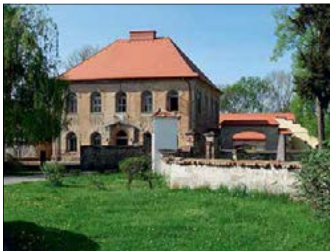
Vrbno (správní obvod obce Mělník), areál fary je situován v pohledově velmi exponované poloze na jihozápadní straně návsi, naproti centrálně umístěnému kostelu Povýšení sv. Kříže. Střecha hlavní budovy byla dlouhá léta pokryta hliníkovými velkoformátovými šablonami. V rámci probíhající obnovy nahradil nový vlastník areálu tento novodobý materiál opět režnými pálenými bobrovkami, které byly použity také pro obnovu střech hospodářských budov ve dvoře a vjezdové brány. Změna velmi pozitivně ovlivnila také prostředí návsi (foto J. Berková).
