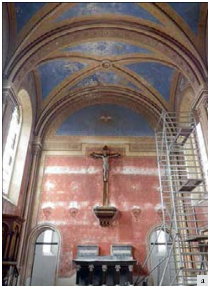
Dolní Břežany (správní obvod Černošice), celková obnova a restaurování šablonové výmalby kaple: a – stav před zahájením prací; b – stav po dokončení. Malířská výzdoba se nachází na všech stěnách kaple. V dolních partiích došlo k poškození vlivem vztlínající vlhkosti, zřejmě z tohoto důvodu v minulosti proběhlo nahrazení omítkové vrstvy a původní malba byla ztracena. Dle nalezené historické fotografie se podařilo obnovit i tyto ztracené partie, které měly imitovat mramor a volně tímto dekorem navazovat na oltář kaple. Lokálně došlo k mechanickému poškození malby i v horních partiích a ztrátám včetně zlacených částí jednotlivých prvků. V partiích klenby došlo k poškození malovaného hvězdného nebe dlouhodobým zatékáním dešťové vody, včetně destrukce podkladové vrstvy (foto J. Motyčka, L. Maděrová).
