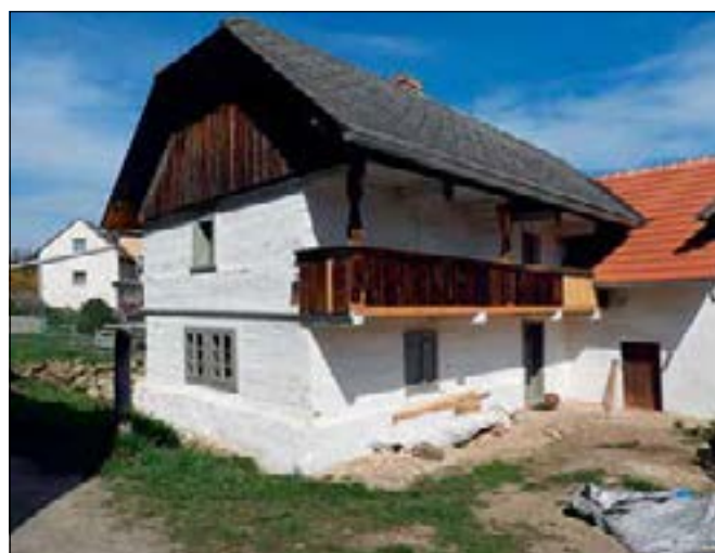
Řehnice (správní obvod obce Mladá Boleslav), roubený dům čp. 18 byl ještě před několika lety značně zdevastován. Po změně vlastníka byla zahájena postupná celková, k památkovým hodnotám stavby velmi šetrná obnova, která v roce 2018 vyvrcholila opravou vnější fasády. Tvoří ji tenká vrstva hliněného pačoku překrytého následně vápenným nátěrem. Akce je přímo ukázkovým příkladem obnovy vnějších pláštíků roubených staveb v dané oblasti, kde pohříchu často přetrvává nesprávný chalupářský přístup kombinující tmavě mořené trámy s bílými vymazávkami (foto J. Berková).
