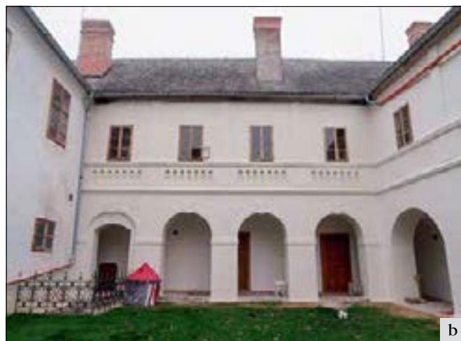
Odolena Voda (správní obvod obce Brandýs nad Labem – Stará Boleslav), tvrz: a – detail fragmentů balustrády na dvorní fasádě západního křídla; b – celkový pohled na obnovenou dvorní fasád západního křídla (foto P. Volná).
