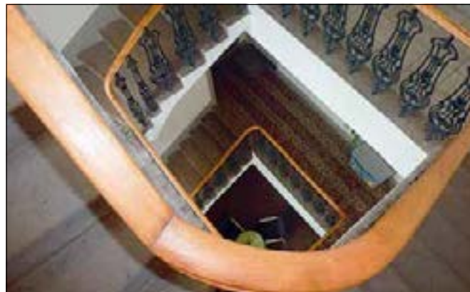
Sídlo NPÚ ÚOP SČ v Sabinově ulici. Obnovené madlo schodišového zábradlí (foto L. Havlovic).
