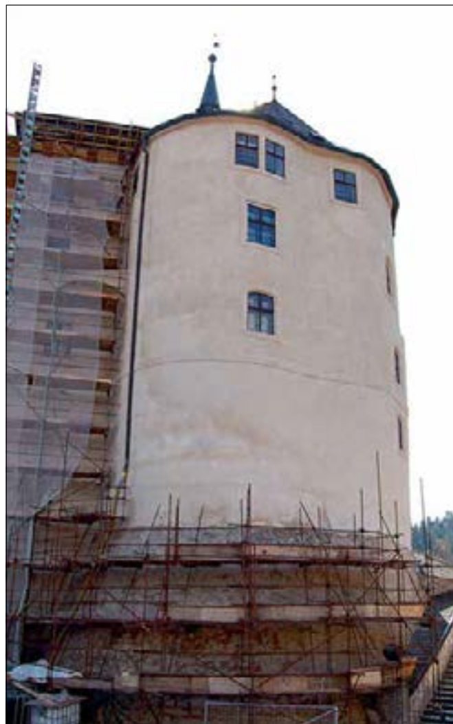
Český Šternberk (správní obvod obce Benešov), hrad, oprava severní fasády hradního paláce. Severní fasáda byla na počátku 20. století opatřena tvrdou omítkou. Při nynější obnově byly všechny soudržné plochy zachovány, nesoudržné a poškozené plochy byly odstraněny a nahrazeny omítkou stejného složení a provedení. Ve spodních vrstvách byly zachovány a konzervovány historické omítky (foto D. Primusová).
