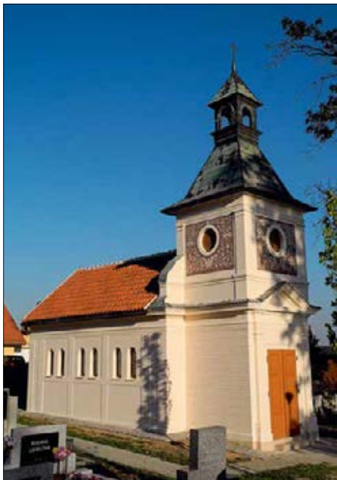
Benátky nad Jizerou (správní obvod obce Mladá Boleslav), hřbitovní kaple sv. Martina po opravě fasády. Podkladem pro současnou obnovu byly i archivní fotografie, na jejichž základě byly doplněny některé chybějící prvky (foto E. Vyletová).
