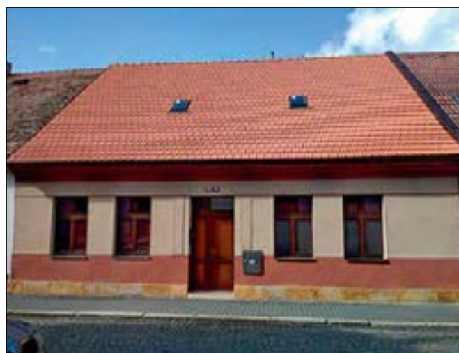
Nymburk (správní obvod obce Nymburk), dům čp. 148 v ulici Eliščina třída, jedná se o dobrý příklad kvalitní obnovy břízolité omítky hlavního průčelí – celkový pohled na dům po obnově (foto M. Gottwaldová).
