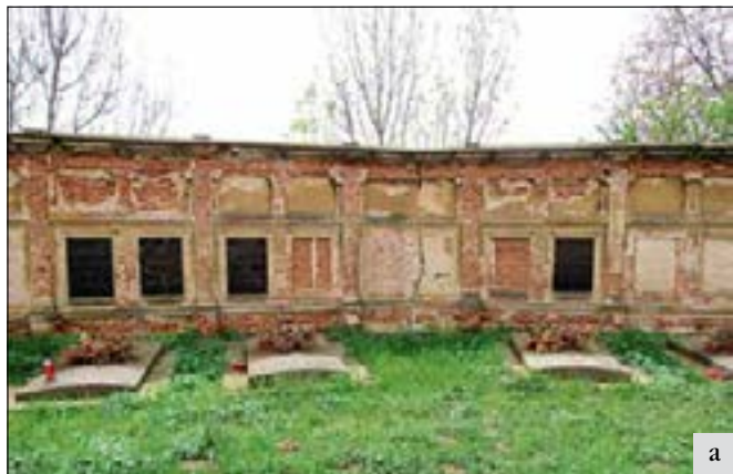
Hořín (správní obvod obce Mělník), pohřební kaple Lobkowiczů: a – část ohradní zdi před obnovou; b – ohradní zeď po obnově (foto před restaurováním litinových křížů na hrobních deskách). Ohradní zeď byla staticky zajištěna, nově omítnuta a doplněna novými odlítky patek, hlavic a rohy lemování náhrobních desek. Restaurovány byly i náhrobní desky na ohradní zdi a byla dokončena také obnova samotných hrobů a litinových křížů na hrobních deskách (foto V. Hlaváčková).
