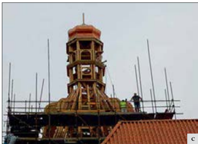
Dolní Břežany (správní obvod obce Černošice), zámek: a – pohled na obnovený plášť zámku ze severovýchodu, před dokončením zahradnických prací; b – nové zastřešení vnitřního dvora zámku, které umožnilo rehabilitovat klasicistní podobu pavlačí jižního a západního křídla a také otevřít arkády východního křídla, c – pohled na přesnou tvarovou kopii zvonového krovu západní věže před opláštěním měděným plechem (foto E. Zápalková).
