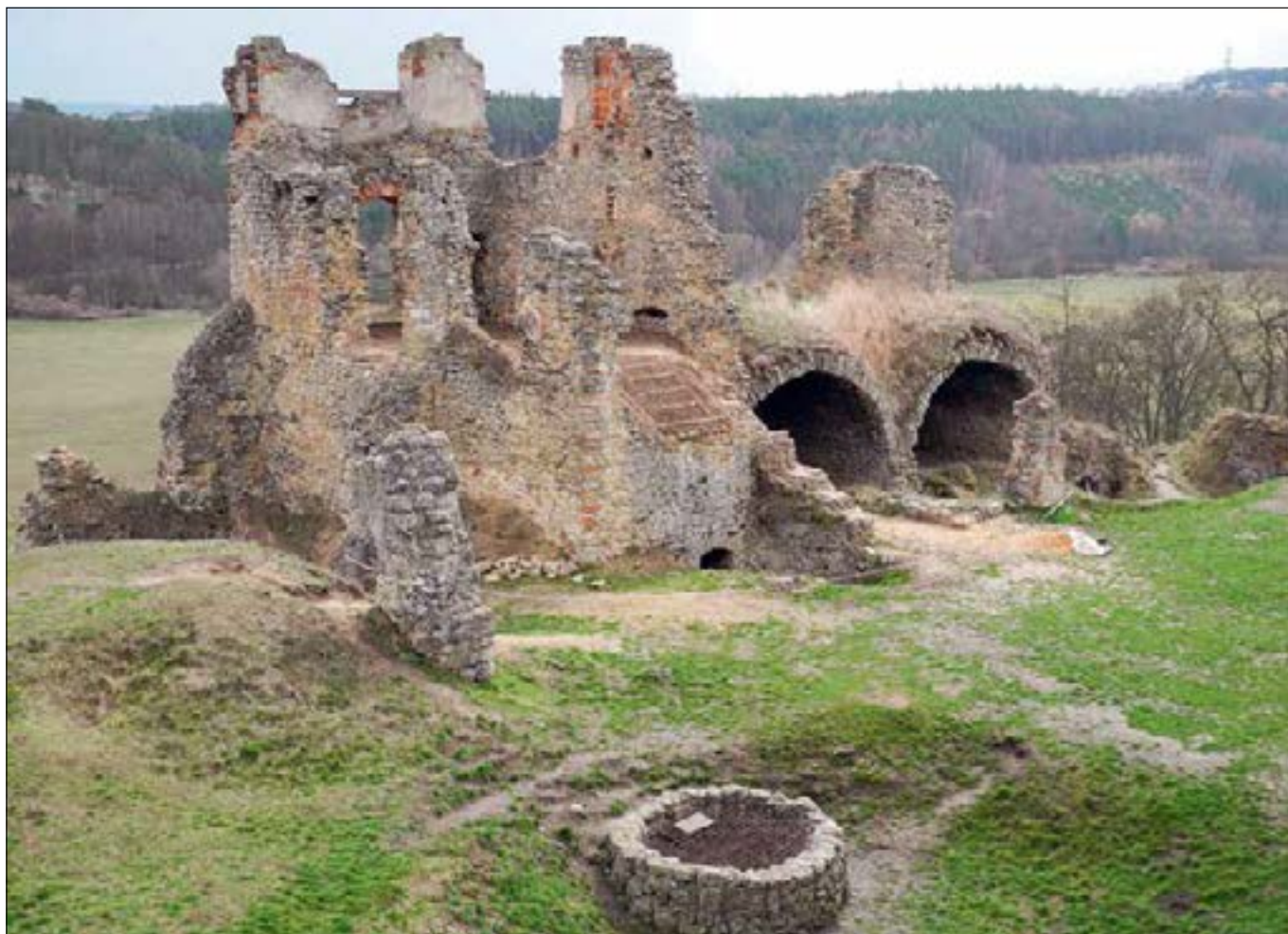
Zvířetice (správní obvod obce Mladá Boleslav), zřícenina hradu. Pohled na gotický palác po dokončení 1. etapy konzervačních prací. U nejvíce poškozené klenby v severní (na snímku levé) části paláce, kde docházelo v důsledku zatékání k postupné destrukci zdiva, bylo provedeno přezdění havarijních částí. Tomu ale předcházela složitá jednání o koncepci opravy a rozsahu přezdívaní, který byl oproti původnímu návrhu na základě požadavků památkové péče omezen pouze na úseky s narušeným zdivem. Na závěr opravy byly na rubu klenby na stávající zásyp položeny vrstvy s hydroizolací a zeminou, kde bude obnovena vegetační vrstva (foto E. Vyletová).
