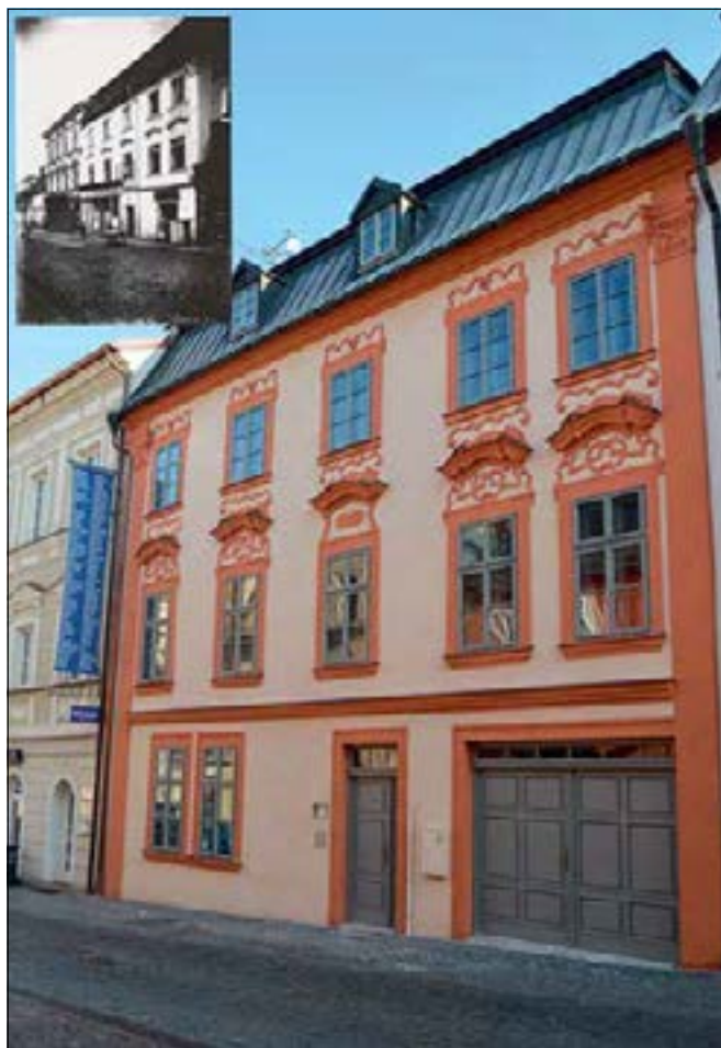
Kolín (správní obvod obce Kolín), MPR, dům čp. 154, celkový pohled na fasádu po její rekonstrukci, výměně okenních výplní, domovních dveří a garážových vrat dle archivní fotodokumentace (vlevo nahoře) (foto D. Havlíková).
