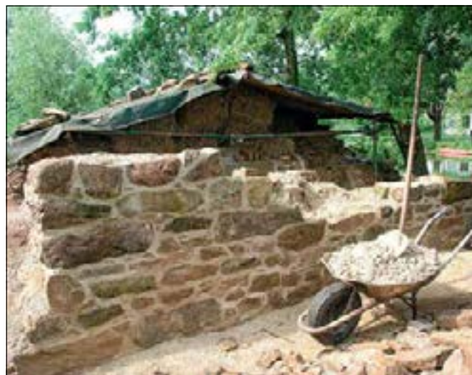
Pšovlky (správní obvod obce Rakovník), sklep s lednicí na tvrzišti, sanace obvodového zdiva předsíně se schody v průběhu oprav (foto E. Volfová).
