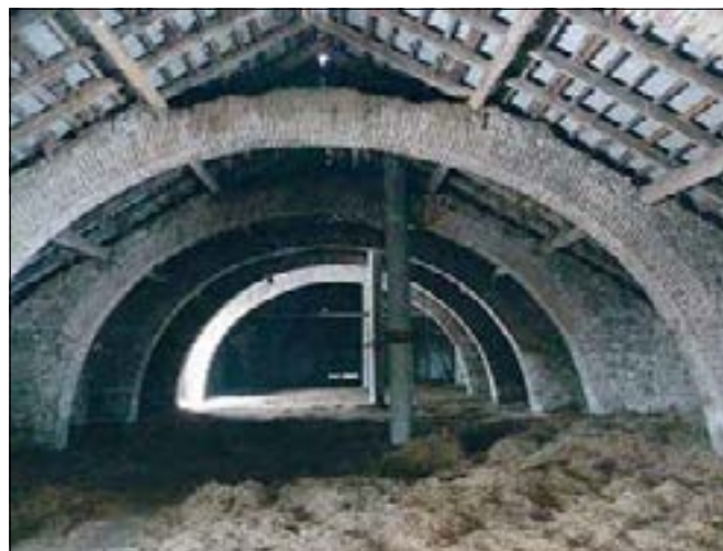
Tmaň (okres Beroun) hospodářský dvůr v areálu zámku. Střechu seníku nad jižním chlévem z roku 1862 nese v našich zemích ojedinělá konstrukce s cihelnými pásy (foto I. Minář).
