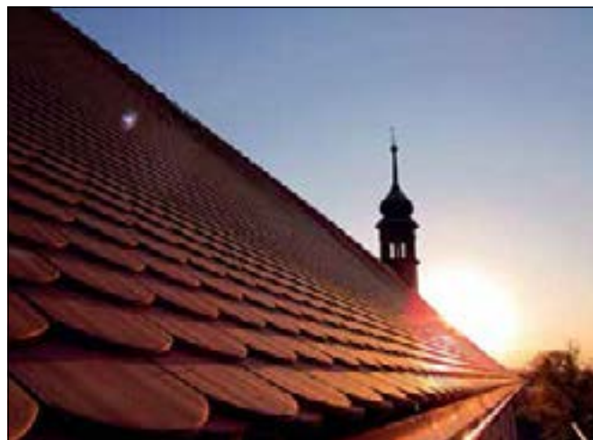
Kostelní Hlavno (správní obvod obce Brandýs nad Labem – Stará Boleslav), kostel sv. Petra v okovech. Pohled na nově opravenou severní střešní rovinu nad lodí při ranním slunci (foto V. Hlaváčková).
