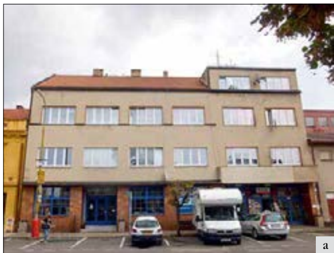
Sedlec u Votic (správní obvod obce Sedlčany), bývalá záložna (později spořitelna): a, b – prolomení nového vstupu do průčelí bývalé spořitelny. Vjezd do dvora a vstupy do záložny, obchodu a bytového domu jsou v pravé vyšší části průčelí. Oříškem bylo, jak udělat kvalitní dveře do průčelí, v němž se žádný prvek nedochoval v původní podobě. Vytvoření nového vstupu bylo povoleno za podmínky citlivého přístupu. Jako předloha pro podobu zcela nových dveří posloužila plánová dokumentace z roku 1936, dochovaná původní vrata na dvůr z doby výstavby domu (foto H. Řepková).
