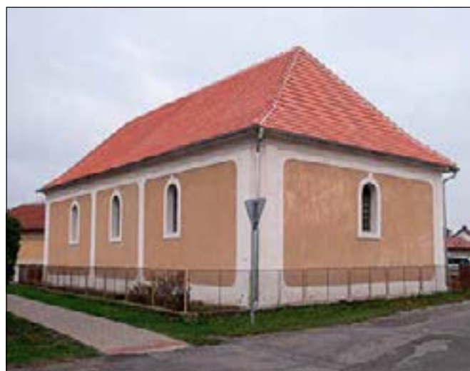
Hořátev (správní obvod obce Nymburk), toleranční modlitebna – celkový pohled na stavbu modlitebny po obnově. Byla dokončena obnova krovu a střešního pláště, tesařské práce proběhly ve velmi dobré řemeslné kvalitě (foto M. Gottwaldová).
