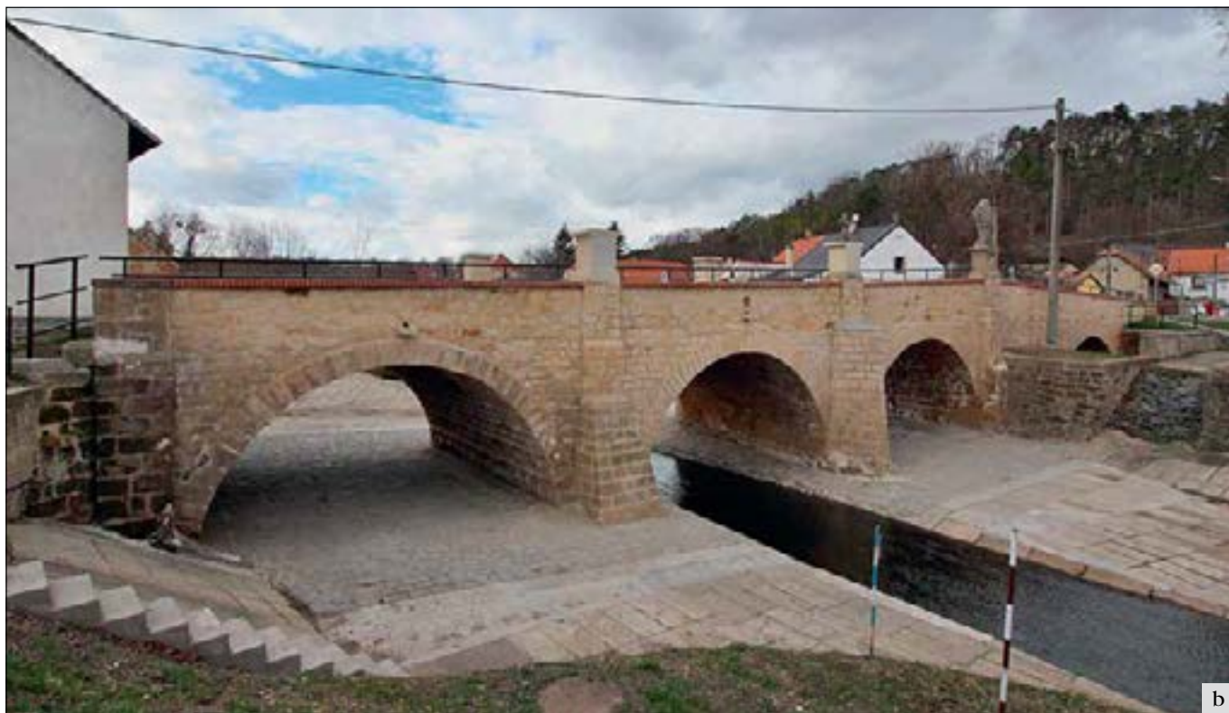
Sazená (správní obvod obce Slaný), silniční most přes Bakovský potok: a – stav po částečném otlučení torkretu v rámci projektové přípravy, září 2015; b – stav po celkové obnově včetně doplněných podstavců soch. Doufejme, že sochařskou výzdobu se podaří doplnit v blízké budoucnosti, březen 2019 (foto A. Rákosníková).
