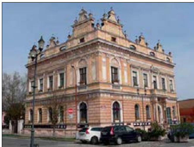
Český Brod (okres Kolín), nová radnice čp. 70. Neorenesanční nárožní budova z let 1897–1898 od architekta Antonína Turka slouží od roku 1948 jako sídlo místní samosprávy. Výstavná patrová budova s dominantní volutovou atikou, připomínající stavby o generaci staršího Antonína Wiehla, je jednou z nejvýraznějších budov na Husově náměstí. Podle původních plánů měla mít téměř dvojnásobnou rozlohu a střeše měla dominovat věž (foto I. Minář).
