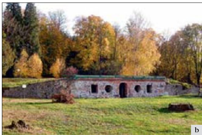
Komorní Hrádek (správní obvod obce Benešov), areál zámku, park, obnova groty: a – práce na obnově groty byly zahájeny po mnoha odkladech a objekt byl na poslední chvíli zachráněn před zánikem; b – torzo stavby bylo staticky zajištěno, degradované zdivo doplněno, spáry kleneb vyklínovány a injektovány. Stavba byla shora zajištěna proti zatékání (foto D. Primusová).
