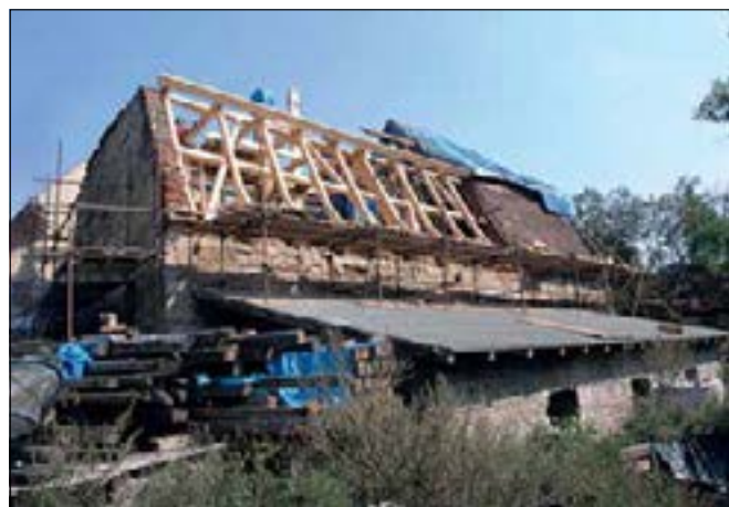
Vepřek (správní obvod obce Kralupy nad Vltavou), areál vodního mlýna čp. 19., první etapa obnovy barokního krovu mlýnice (foto M. Hanzlíková).
