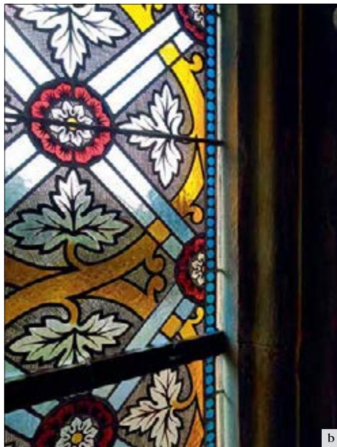
Velvary (správný obvod obce Slaný), kostel sv. Jiří, vitraje a kamenná ostění, průběh restaurování: a – stav po demontáži, b – stav po dokončení prací. Třetí etapa restaurování vitrají, které doprovází restaurátorské práce na kamenných ostěních. Předmětné vitraje zřejmě pochází z kostela sv. Kateřiny ve Velvarech, rozhodně však nebyly primárně určeny do těchto konkrétních okenních otvorů. Při instalaci byla v minulosti necitlivě lokálně osekána kamenná renesanční ostění a skleněné pláty byly do těchto otvorů vloženy nestandardním způsobem, bez lůžka, jen přichyceny maltou a kovovými vzpěrami. Z tohoto důvodu bylo přistoupeno k tomu, že pro každé ostění bylo proříznuto hlubší úžlabí, do kterého byly vitraje mírně zasunuty a dále zatmeleny (foto M. Škrancová, J. Motýčka).
