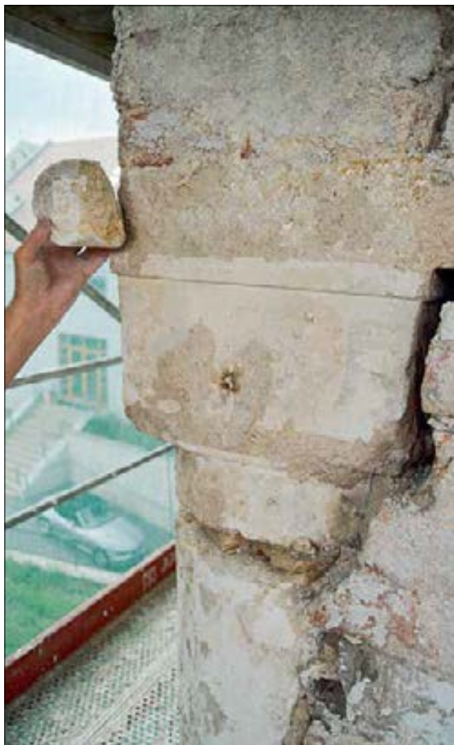
Kolín (správní obvod obce Kolín), MPR, areál zámku, západní křídlo čp. 545. Fotografie částečně odkryté arkády v jihovýchodním nároží včetně kamenné volutky z hlavice sloupku, která byla zazděná vedle prostředního sloupku východní fasády a sloužila jako vzor pro domodelování všech hlavíc. Veškeré profilace renesančních prvků byly patrně při klasicistní rekonstrukci otlučeny a přetaženy omítkou (foto D. Havlíková).
