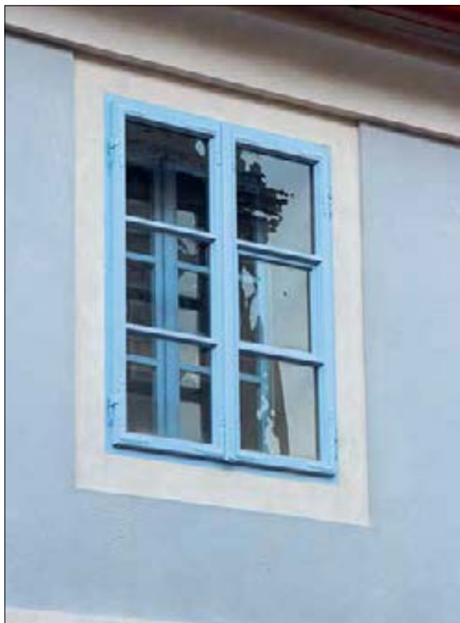
Kutná Hora (správní obvod obce Kutná Hora), dům čp. 223 Bartolomějská ulice. V roce 2018 byla dokončena celková obnova uliční fasády s uplatněním příkladné technologie – jednovrstvé dřevem utahované omítky a vápenného lazurního nátěru. Rekonstrukci klasicistního architektonického členění fasády doplnila nová okna s replikami dobových detailů, jako jsou visuté závěsy, rohovníky či tzv. lehané sklo (foto A. Pospíšil).
