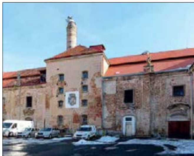
Březnice (správní obvod obce Příbram), pivovar. Oprava střechy pivovaru (foto E. Kosová).
