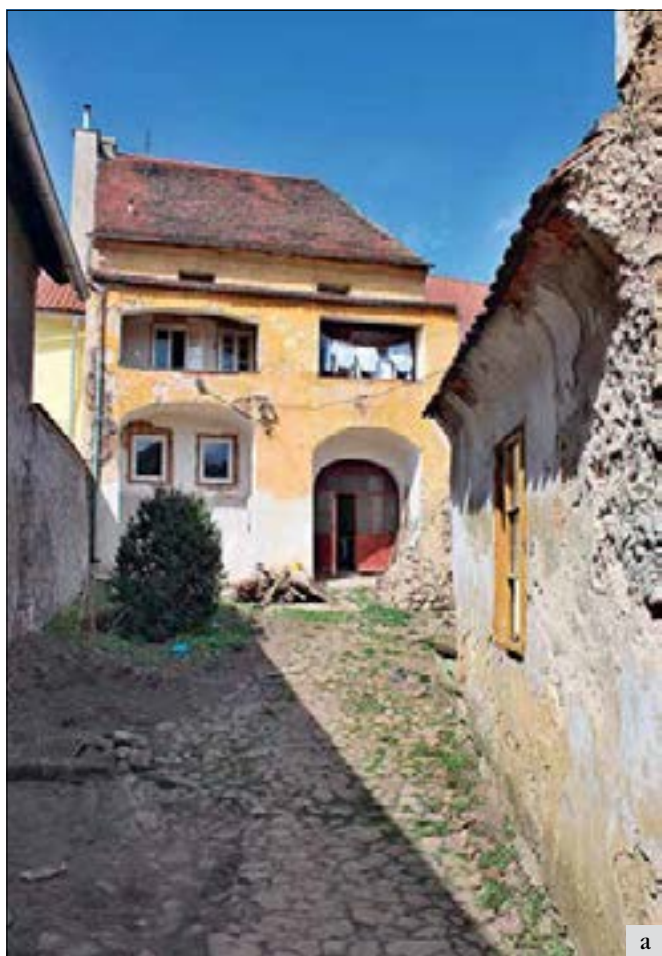
Žebrák (okres Beroun), dům čp. 23, dvorní průčelí od jihu (a), dvorní objekt a stodola od severu (b). Zděná pavlač s pultovou stříškou přistavěná k dvornímu průčelí, zachovaná souvrství historických omítek, položení sřešní krytiny bez oplechování, valouny vydlážděný dvůr se studnou a kamenným máchadlem, prostorové uspořádání budov bez novodobých přístaveb. To jsou jen některé z řady prvků, které se mohou zdát všední, viděny izolovaně, které ale z našich měst a vesnic postupně a bez povšimnutí mizejí. Jejich souhrn v daném případě podtrhuje památkovou hodnotu areálu a přispívá k jeho celkové malebnosti (foto A. Jančíková).
