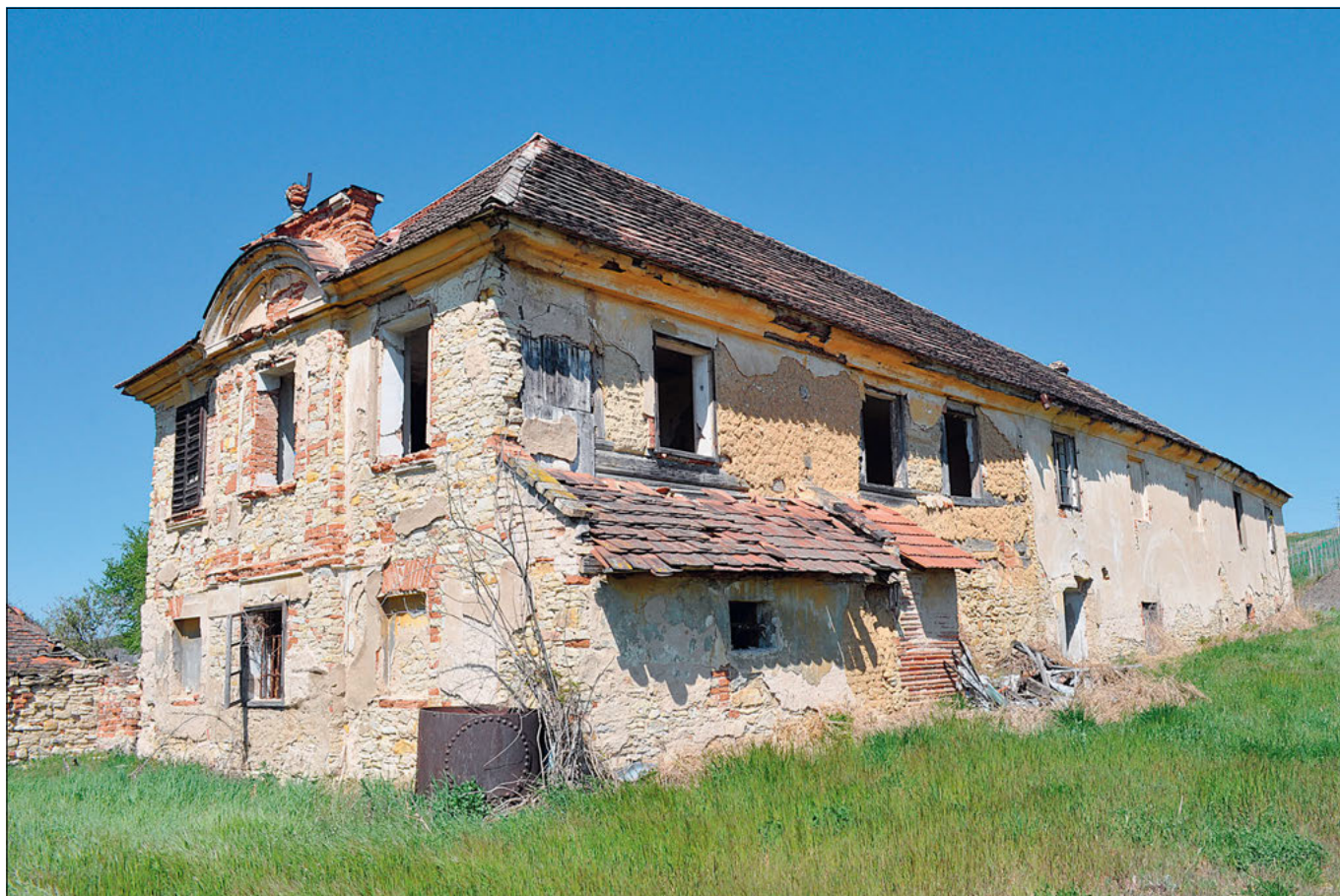
Mělník, viniční usedlost Bašovka čp. 1719. Unikátně dochovaný barokní objekt tzv. viničního lisu s roubeným jádrem z roku 1708 byl naším pracovištěm navržen na památkovou ochranu již podruhé (foto I. Minář).
