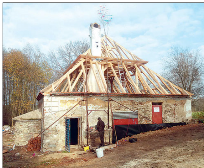
Drahenice (správní obvod obce Příbram), mlýn čp. 23. Celkový pohled na stavení mlýna po dokončení opravy krovu, stav v listopadu 2020. V roce 2021 bude oprava pokračovat položením taškové krytiny (foto J. Pešta).
