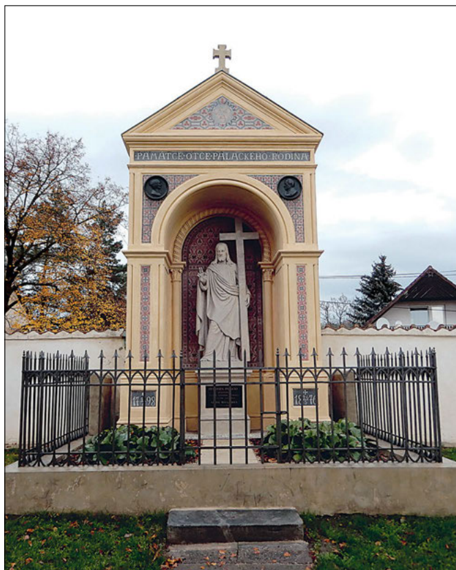
Lobkovice (správní obvod obce Neratovice), hrobka Františka Palackého a jeho rodiny. Hrobka byla po doplnění omítky nově natřena, terazzová mozaika v plochách architektury přebroušena a zavoskována, dále byl rekonstruován chybějící vrcholový pískovcový kříž. Strážka byla překryta novým olověným plechem. Socha Krista byla očištěna. Bronzové medailony F. Palackého a jeho dcery Marie a nápisová deska na zadní stěně hrobky byly konzervovány (foto T. Cachová).
