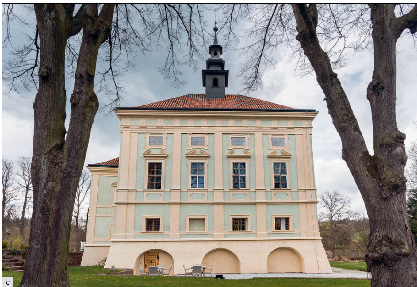
Radič (správní obvod obce Sedlčany), zámek čp. 1: a – pohled na východní křídlo zámku se zachovalými barokními omítkami pod druhotnou štukovou vrstvou; b – při snímání štukové vrstvy byly ve slepých okenních otvorech nalezeny zbytky iluzivní výmalby okenních výplní, fotografie zachycuje stav po obnově iluzivní výmalby – před nátěrem fasády. Při obnově omítek byl kladen důraz na zachování charakteru hrubě točeného povrchu původních omítek; c – zámek po obnově omítek východního křídla a před dokončením nátěrů okenních výplní. Oprava omítek na jižním křídle proběhla v poměrně nedávné době, před nátěrem fasády tak došlo na těchto úsecích pouze k drobným korekcím v plochách a členění (foto J. Černochová).
