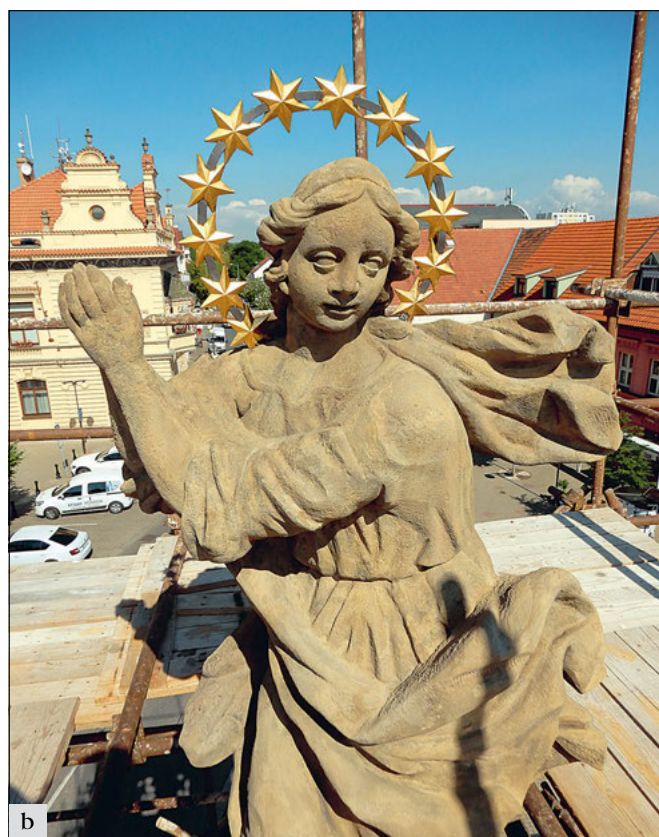
Poděbrady (správní obvod obce Poděbrady), mariánský sloup. Kámen byl zpevněn, chybějící části doplněny a barevně zaretušovány. Byla zajištěna statika sochy sv. Prokopa ohrožené trhlinou vzniklou korozi vnitřního železného trnu: a – celek po restaurování; b – socha Panny Marie, detail (foto T. Cachová).
