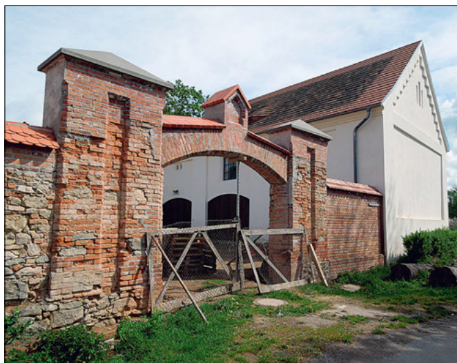
Třebešice (správní obvod obce Benešov), areál zámku, rekonstrukce západní brány do areálu. Novogotická brána bočního vjezdu do hospodářského dvora zámku byla navržena a znovu postavena podle výsledků průzkumu dochovaných fragmentů, historických fotografií a dobového dětského výkresu. Brána byla nově zaklenuta z cihel a zakryta bobrovkami (foto D. Primusová).
