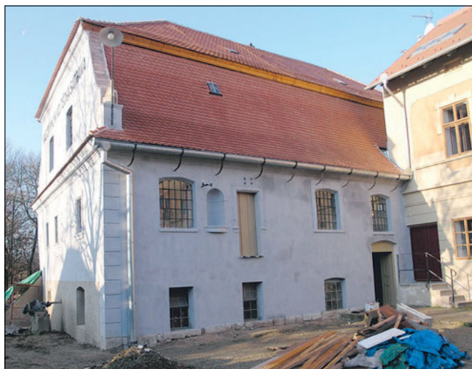
Vepřek (správní obvod obce Kralupy nad Vltavou), areál vodního mlýna čp. 19, stav po celkové obnově mlýnice, v pravé části fotografie kolmo navazuje obytný dům, jehož celková rekonstrukce proběhla v minulých letech (listopad 2020, foto M. Hanzlíková).
