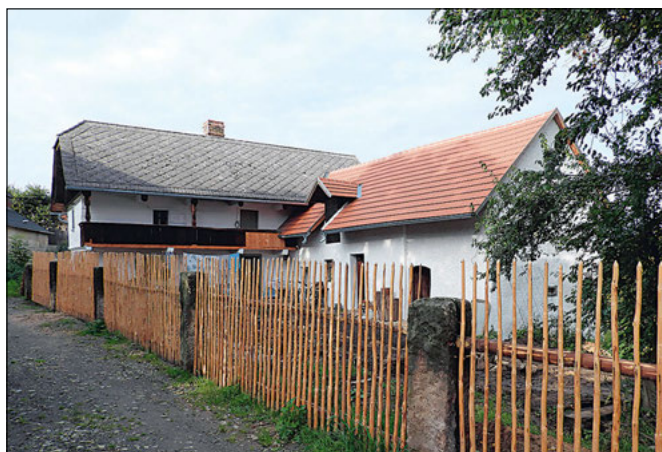
Řehnice (správní obvod obce Mladá Boleslav), usedlost čp. 18 je příkladem citlivé obnovy kulturní památky s maximálním respektem k původním stavebním technikám a technologiím. V souladu s přístupem k obnově vlastního domu je zde přistupováno rovněž k obnově prvků dotvářejících prostředí usedlosti, např. oplocení. Zaniklý plot byl nahrazen opět tradičním plaňkovým z loupané kulatiny, osazeným do druhotně použitých pískovcových sloupků (foto J. Berková).
