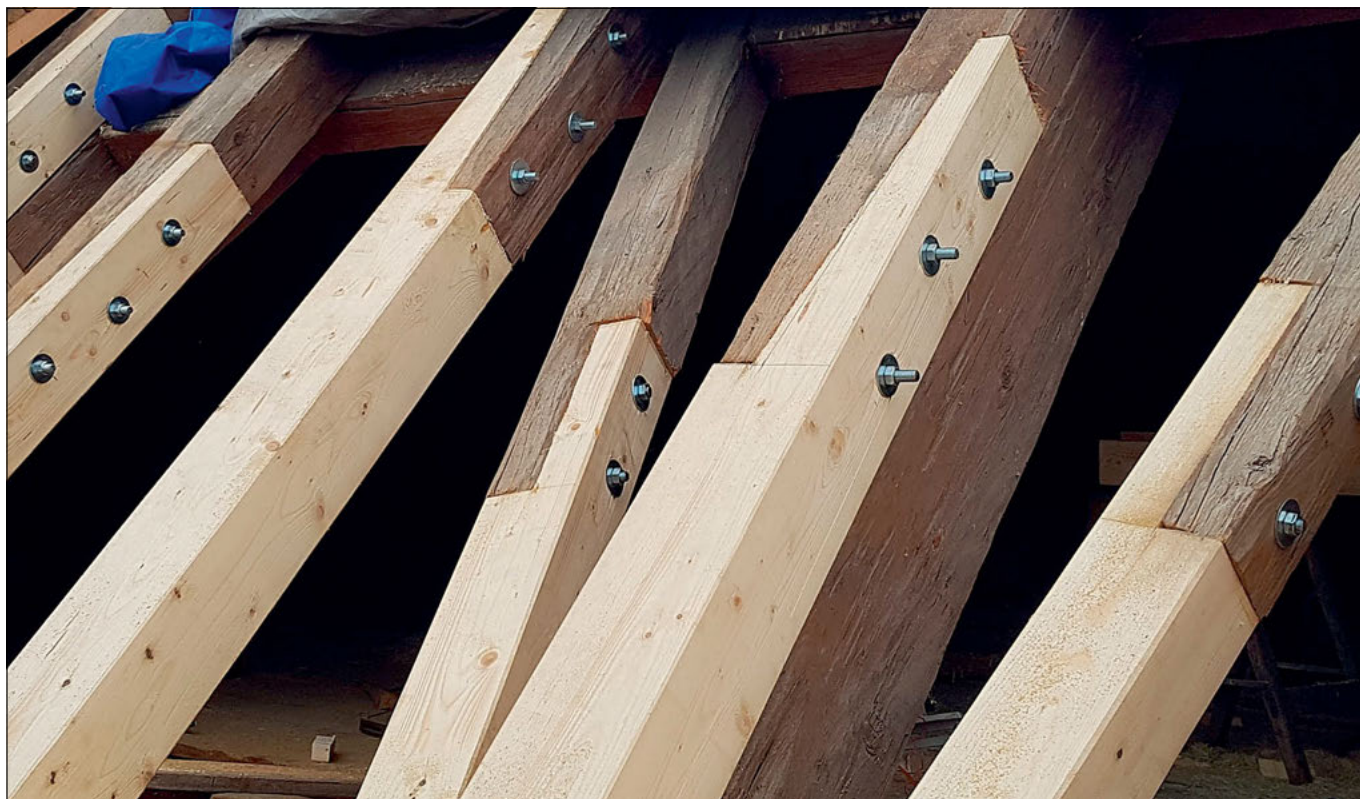
Semice (správní obvod obce Lysá nad Labem), kostel sv. Maří Magdalény, detail vyprotézovaného krovu (foto O. Komorouš).
