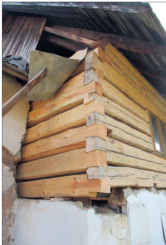
Obděnice (správní obvod obce Sedlčany), usedlost čp. 20. Tentýž detail stav po dokončení opravy. Práce byly díky nadstandardnímu přístupu vlastníka i zhotovitele provedeny v příkladně kvalitě s důrazem na autenticitu materiálu i technologických postupů, včetně použití ručně tesaného dřeva (foto Jan Pešta).
