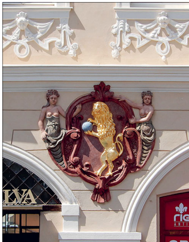
Kolín (správní obvod obce Kolín), domovní znamení domu U Zlatého lva (čp. 90). V rámci celkové obnovy fasády domu bylo zrestaurováno domovní znamení – nahrazeny degradované modelační doplňky a vyzorkována vhodná barevnost. Zlacení samotného lva nyní odpovídá názvu objektu (foto T. Cachová).
