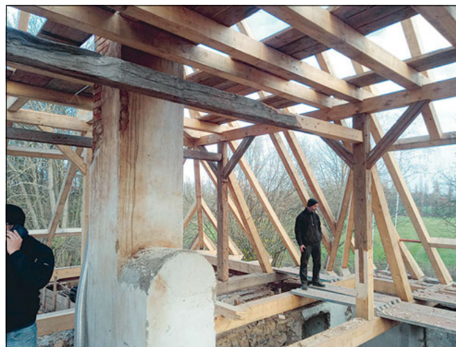
Drahenice (správní obvod obce Příbram), mlýn čp. 23. Pohled do krovu během opravy ukazuje velký rozsah nutných výměn dřeva (foto J. Pešta).
