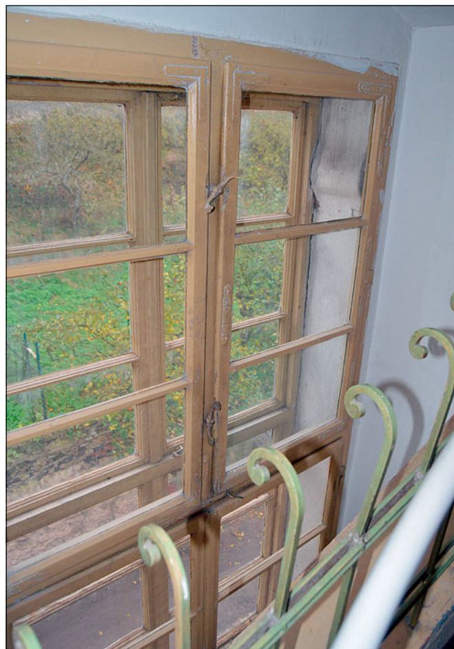
Svätý Jan pod Skalou, benediktinský klášter čp. 1, okres Beroun, II. etapa dokumentace oken kláštera. Pohled na vnitřní barokní okno 1. patra východní fasády severního křídla – prelatury, které osvětluje prostor točitého schodiště. Jedná se o původní barokní okno osazené ve vnitřním falci ostění, dodatečně doplněné o venkovní okno z 2. poloviny 19. století. Na okně jdou zachovány původní kované zdobené rohovníky a závěs, dokonce také obrtlíky, v meziokenním prostoru je zbytek původní profilace venkovní části okenního ostění, která se po osazení venkovního okna ocitla v meziokenní špaletě. Jeden z mála dochovaných dokladů původního řešení, většinou došlo k oluštění barokních profilovaných prvků zasahujících do okenního otvoru (foto D. Havlíková, 2020).
