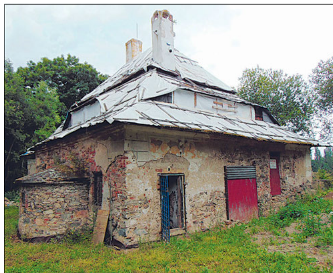
Drahenice (správní obvod obce Příbram), mlýn čp. 23. Celkový pohled na stavení mlýna před zahájením opravy, stav v srpnu 2020 (foto J. Pešta).
