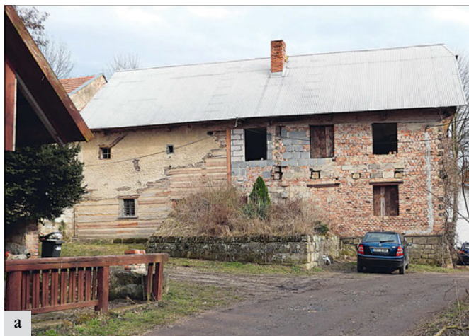
Střehom (správní obvod obce Mladá Boleslav), VPZ. Dům usedlosti čp. 11 se po letech příprav dočkal obnovy roubení v západní stěně, která byla zcela necitlivě přezděna v poslední třetině 20. století. Ve dvou na sebe navazujících etapách, realizovaných v letech 2019 a 2020, byla nevhodná zděná konstrukce nahrazena opět roubenou a opraveno roubení navazujících původních stěn. Obnova stavby má zásadní vliv na danou část VPZ a je základním předpokladem k postupné opravě interiéru domu a vhodného využití (foto J. Berková).
