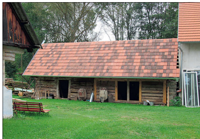
Kojetín (správní obvod obce Sedlčany), vesnická památková zóna, usedlost čp. 6. Celkový pohled na roubené komory po dokončení opravy. Použití recyklované drážkové krytiny namísto vlnitého eternitu přispělo ke zlepšení vzhledu nechráněné hodnotné stavby v prostředí VPZ (foto Jan Pešta).
