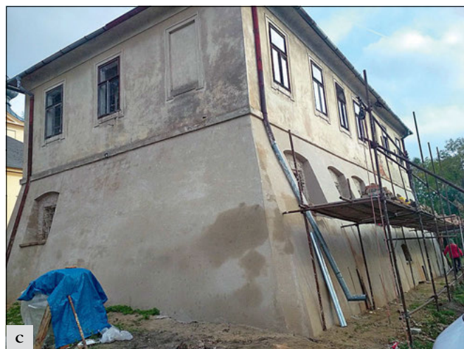
Kráňec (správní obvod obce Nymburk): a – zámek čp. 1, pokračování obnovy fasády západního a východního průčelí hlavního křídla zámku a jižního průčelí západního křídla. V rámci této obnovy byly též osazeny dvojice nové historizující dveře odpovídající současné klasicistní podobě zámku z 1. poloviny 19. století, na snímku fasáda jižního průčelí západního křídla zámku po obnově; b – fara, původní stav před provedením statického zajištění fary, vnější opěráky (skarpy) byly postupně přezděny s využitím druhotně použitých cihel a nově omítnuty. Nakonec byla provedena též injektáž ve větší míře, než se původně předpokládalo; c – stav po provedení statického zajištění fary (foto M. Gottwaldová).
