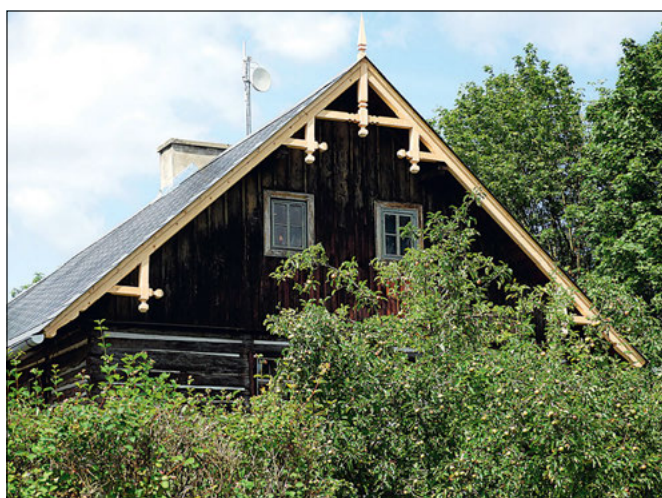
Jestřebice (správní obvod obce Mělník), VPZ, dům čp. 20. V rámci opravy krovu a výměny krytiny byl pečlivě obnoven také první předsazený pár krokví s ozdobnými detaily, které dávají štítu estetickou kvalitu (foto J. Berková).
