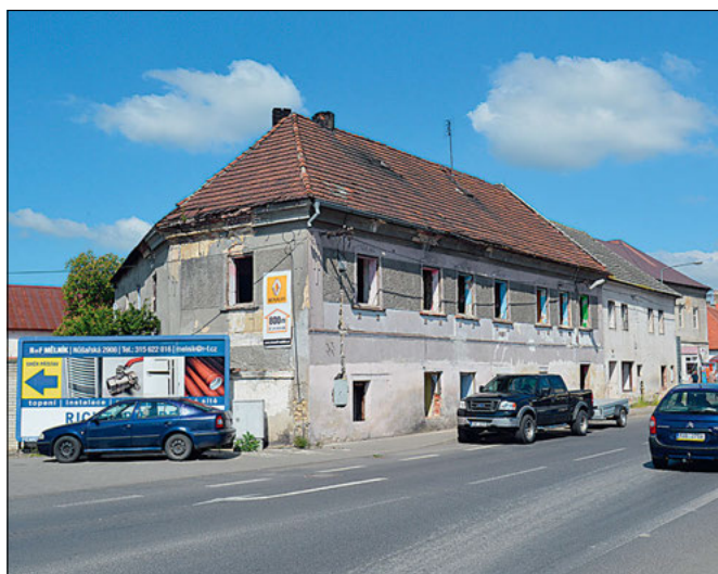
Mělník, místní část Pšovka (správní obvod obce Mělník) pohled od kruhového objezdu směrem ke klášteru. Na záběru zatím ještě stojí blok historické zástavby, tvořící cennou pohledovou podnož významné památce a dokládající původní podobu místa před zásadními novodobými úpravami, které místo změnila na předměstskou průmyslovou zónu. Domy ale byly dlouhodobě ponechány svému osudu a svěřeny k využívání skupině obyvatel, která svým přístupem dosáhla stavu, kdy nebyl problém prosadit demolici. Opravdu se tak stalo v první polovině roku 2020 a fotografie je smutnou připomínkou, jakýmsi nekrologem domů, jejichž blížící se ztráty jsme se celou dobu oprávněně obávali (foto J. Mrázek).
