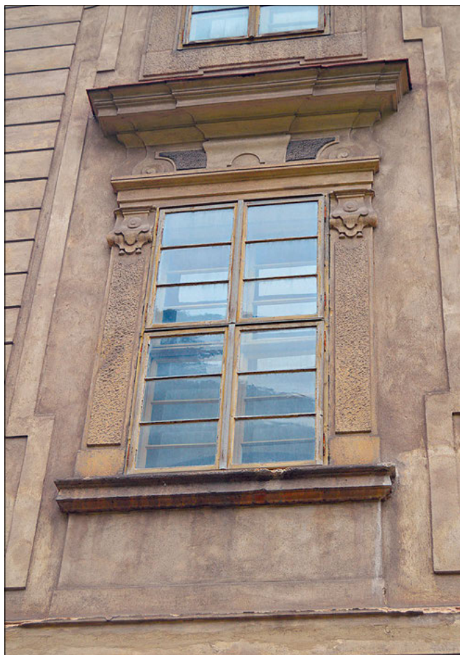
Svätý Jan pod Skalou, benediktinský klášter čp. 1, okres Beroun, II. etapa dokumentace oken kláštera. Pohled na okno 1. patra východní fasády severního křídla – prelatury, které osvětluje prostor točitého schodiště. Původní barokní okno je osazeno ve vnitřním falci ostění, okno venkovní v líci zdíva je dodatečné, z 2. poloviny 19. století. Jde o jeden ze dvou příkladů symbiózy barokního a historizujícího okna na této stavbě (foto D. Havlíková, 2020).
