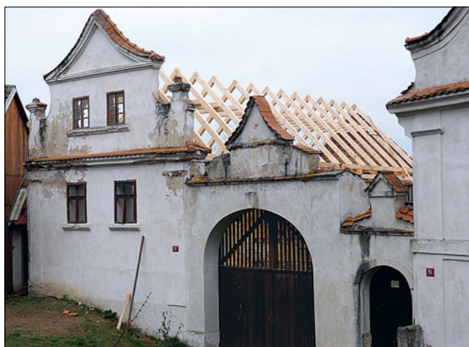
Kanina (správní obvod obce Mělník), dům čp. 17 je výměnkem větší usedlosti z 1. poloviny 19. století, která náleží mezi nejstarší zděné vesnické stavby na Kokořínsku. Střecha z bobrovek byla natolik poškozená, že došlo k částečné destrukci stropů a stav krovu byl havarijní. Jeho kvalitu poškodila rovněž neodborná oprava realizovaná někdy v 2. polovině 20. století. Stav po dokončení krovu (foto J. Berková).
