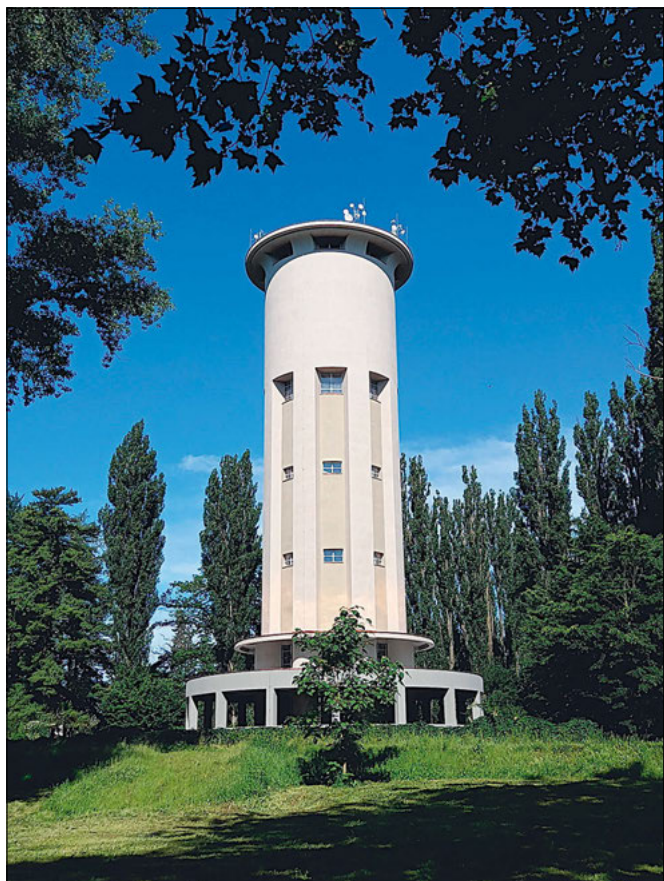
Poděbrady (správní obvod obce Poděbrady), vodojem, stav po dokončení opravy fasády a střech (červen 2020, foto O. Hrdlička).
