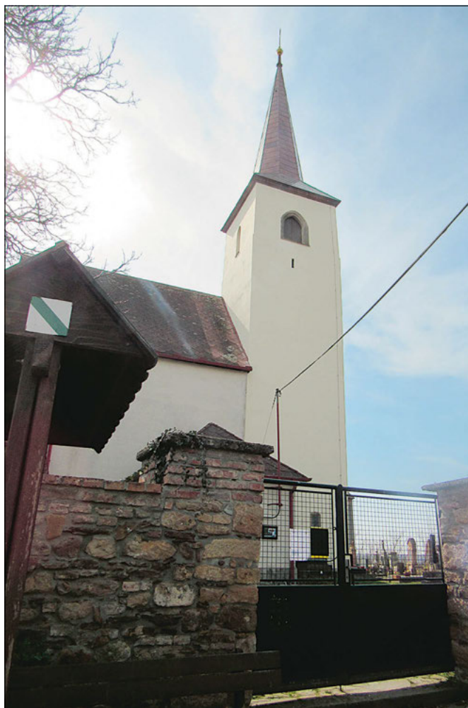
Vitice (správní obvod obce Český Brod), kostel Šimona a Judy, oprava věže (foto A. Švejdarová).
