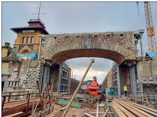
Hořín (správní obvod obce Mělník), zdymadlo vraňansko-hořinského plavebního kanálu, most ve zdvižené pozici (říjen 2020, foto O. Hrdlička).
