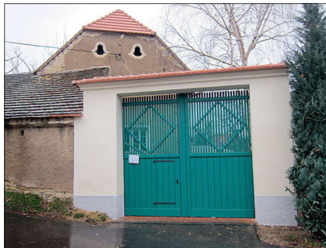
Kněževs (správní obvod obce Praha-západ), obnovená brána a vrata usedlosti čp. 10, říjen 2020 (foto M. Hanzlíková).
