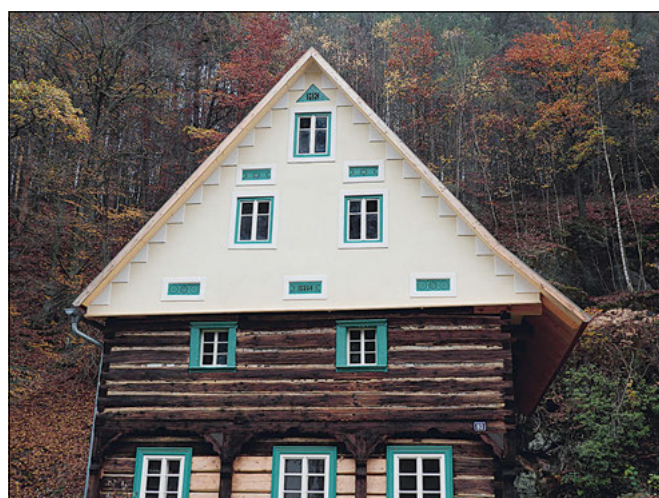
Vidim (správní obvod obce Mělník), VPZ, roubený dům čp. 80 – stav štítu po dokončení obnovy tradičně členěné fasády rekonstruované podle dochované dobové fotografie. Vzhled hlavního průčelí domu se tak navrátil do své původní podoby z roku 1872 (foto J. Berková).
