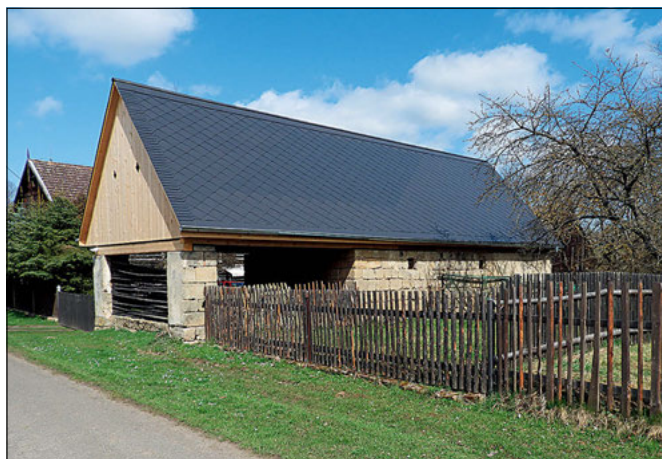
Jestřebice (správní obvod obce Mělník), VPZ, usedlost čp. 1. Hospodářská budova vznikla v 2. polovině 19. století jako kolna, která byla později z větší části upravena jako chlév. Krov a střešní plášť byly v havarijním stavu. Obnova proběhla ve dvou etapách v letech 2019–2020 (foto J. Berková).
