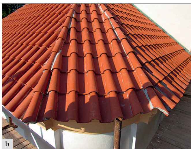
Odolena Voda (správní obvod obce Brandýs nad Labem – Stará Boleslav), oprava střechy sakristie a východní fasády kostela sv. Klimenta: a – stav před opravou; b – stav po opravě (foto A. Švejdarová).
