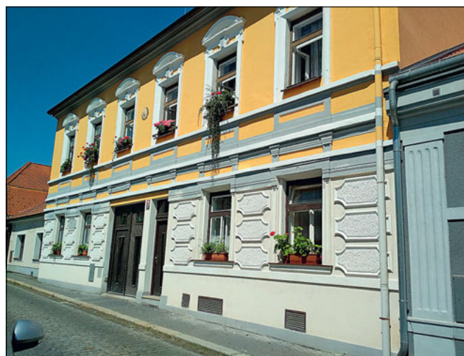
Nymburk (správní obvod obce Nymburk), dům čp. 90 v Dlouhé třídě, obnova historizující eklektické fasády uličního průčelí (foto R. Vančurová).
