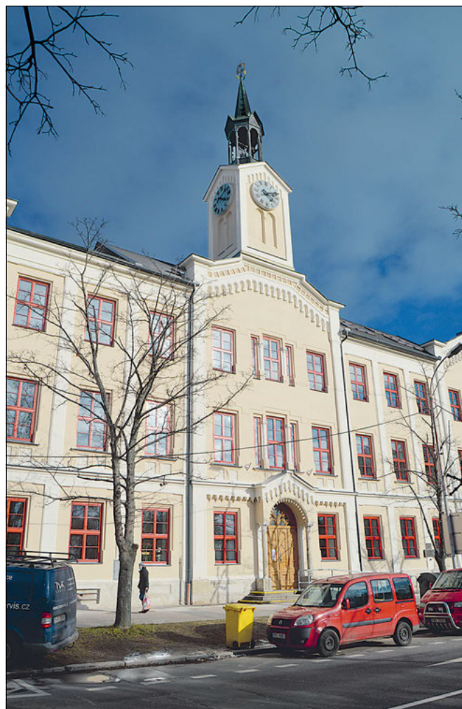
Kolín IV (správní obvod obce Kolín), budova bývalé Obchodní akademie čp. 41 v Kutnohorské ulici, stav po celkové rekonstrukci fasád a výměně socialistických oken za dřevěná (foto D. Havlíková).
