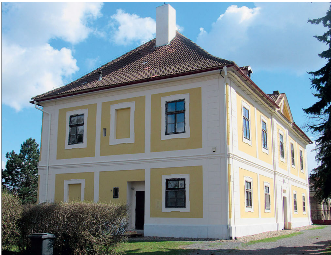
Mratín (správní obvod obce Brandýs nad Labem – Stará Boleslav), oprava fasády zámku, zajímavými prvky jsou historicky hodnotné háky pro uchycení okapních žlabů (foto A. Švejdarová).
