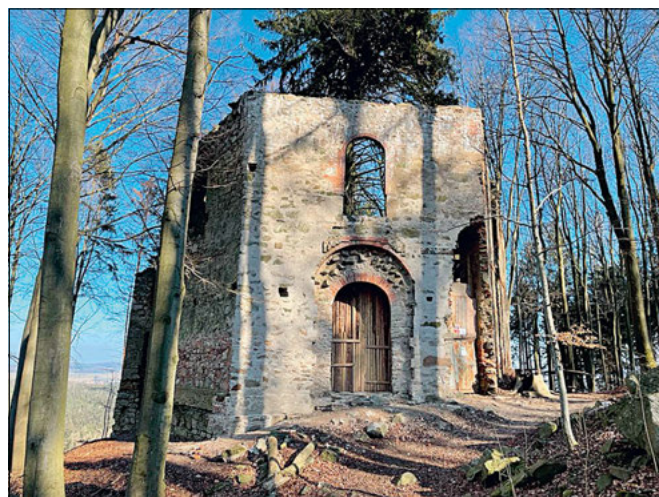
Louňovice pod Bláníkem (správní obvod obce Vlašim), Malý Bláník, zřícenina kaple sv. Máří Magdaleny, sanace zdiva. V roce 2020 byly zahájeny zajišťovací práce na zřícenině barokní kaple sv. Máří Magdaleny na tomto významném poutním místě. Práce začaly na nejfrekventovanější západní stěně, ve které je vstup do vnitřního prostoru. Uvolněné kameny na korně zdi byly rozebrány a znovu vyzděny, spáry horní plochy byly zaplněny maltou a vyspádovány tak, aby do zdiva nezatékalo. Vyspárovány a vyklínovány byly také líce zdiva. Kromě toho byly zajištěny záklenky obou otvorů v této stěně. V příštím roce zde mají práce pokračovat (foto D. Primusová).
