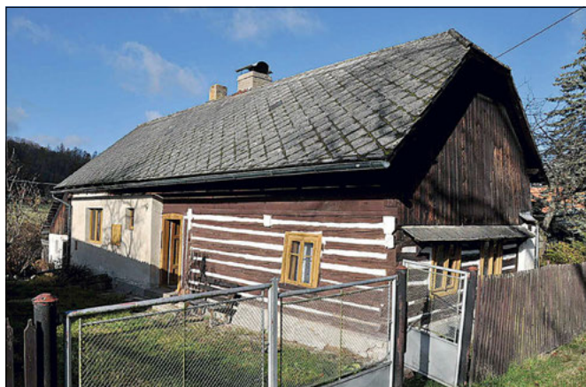
CELKOVÝ POHLED OD JIHOVÝCHODU
