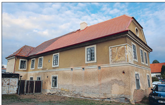
Lokšany (správní obvod obce Příbram), pokračující rekonstrukce KP čp. 635, statické zajištění a obnova střešního pláště (foto Tlučkovi).
