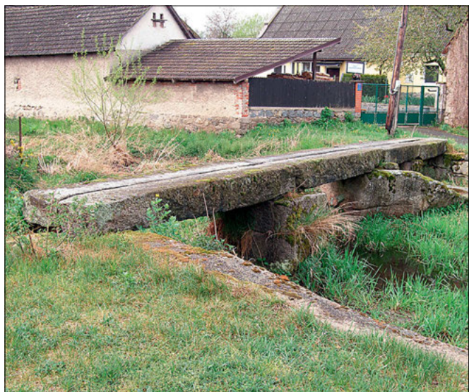
Kamenice (okres Příbram), kamenná lávka: V roce 2020 byla navržena do Ústředního seznamu kulturních památek žulová lávka přes potok Slabá. Ojedinelá stavebně technická památka komunikačního charakteru, velmi působivá v jádru obce v blízkosti kaple. Obdobná lávka se dochovala již jen v několika málo ukázkách, například v lokalitách Valcha v Plzeňském kraji a Vlhošť v Královéhradeckém kraji (Jediná evidovaná v Ústředním seznamu kulturních památek, rejst. č. 45642/6-4682), přičemž lávka v Kamenici je mnohem kvalitnější a výraznější, navíc s datací 1861 (foto Š. Koukalová).
