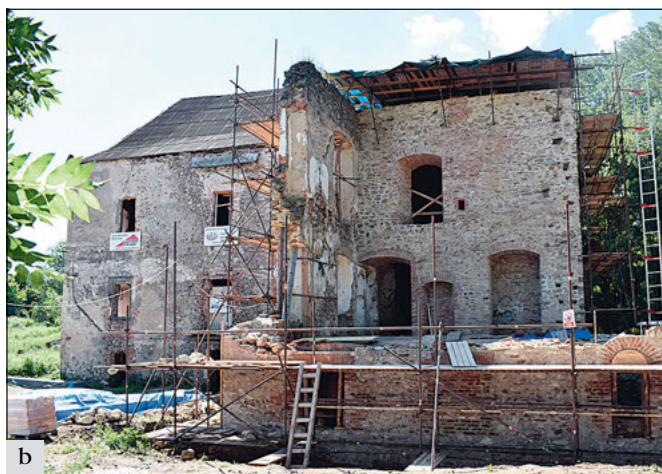
Zvěstov (správní obvod obce Votice), zámek, dozdivání západního křídla: a – stav v létě 2019, kdy bylo dokončeno statické zajištění torza západního křídla dozdiváním, klínováním a injektováním spár; b – stav v létě 2020, kdy bylo započato doplňování konstrukcí odstřelených v 70. letech 20. století. Zdivo bylo po odstranění suti dozdiveno podle zaměření, které bylo před demolicí provedeno, na fragmenty původních konstrukcí, jejichž stav byl prověřen statikem (foto D. Primusová).
