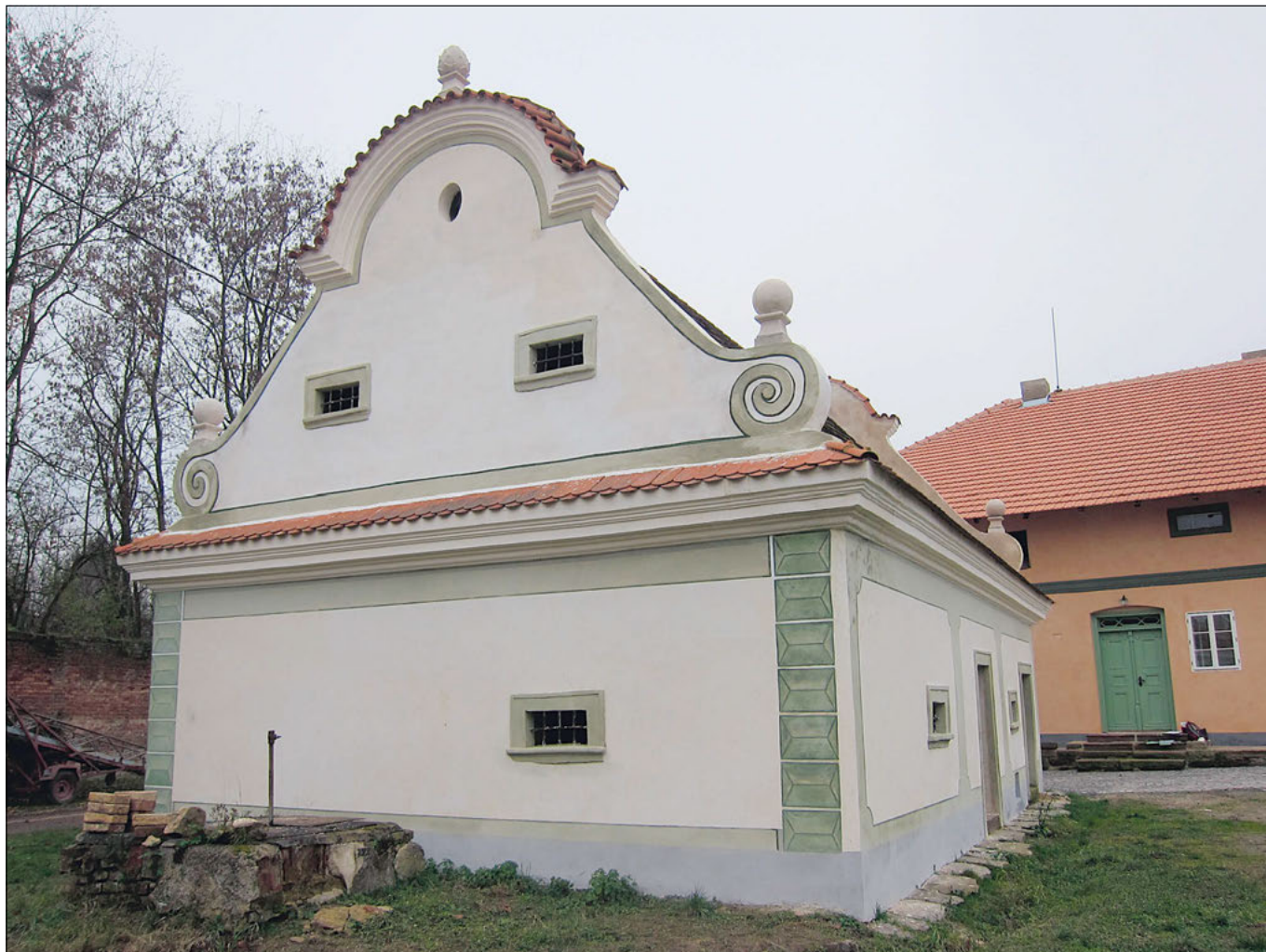
Chotouň (správní obvod obce Český Brod), stav po celkové obnově fasády a doplnění čučků (prosinec 2020, foto M. Hanzlíková).
