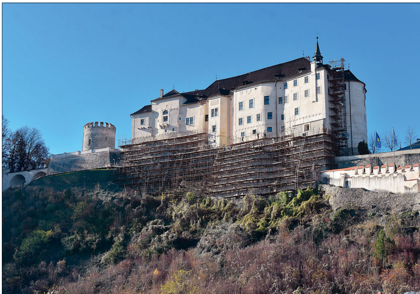
Český Šternberk (správní obvod obce Benešov), hrad, oprava východní fasády hradního paláce. Fasády hradu byly na počátku 20. století opatřeny tvrdou omítkou. Při nynější obnově dožívajících omítek byly všechny soudržné plochy zachovány, nesoudržné a poškozené plochy byly odstraněny a nahrazeny omítkou stejného složení a provedení. V příštím roce má být oprava východní fasády dokončena sanací podnože, která vznikla opláštěním skály kamenem (foto D. Primusová).
