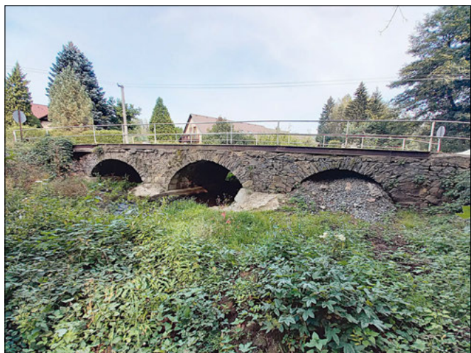
Stříbrná Skalice (správní obvod obce Říčany), most přes Jevanský potok. Současný stav mostu po letech zanedbávání údržby. Obec jako majitel mostu usiluje o zapsání mezi kulturní památky a provést příkladnou opravu. Přejme jim hodně štěstí (září 2020, foto O. Hrdlička).
