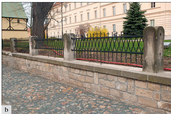
Rakovník (správní obvod obce Rakovník), opěrná zeď mezi kostelem sv. Bartoloměje a zvonící: a – stav před rekonstrukcí; b – stav po rozebrání a opětovném složení na opravených základech a s novým kovářsky zpracovaným zábradlím (foto E. Volfová).
