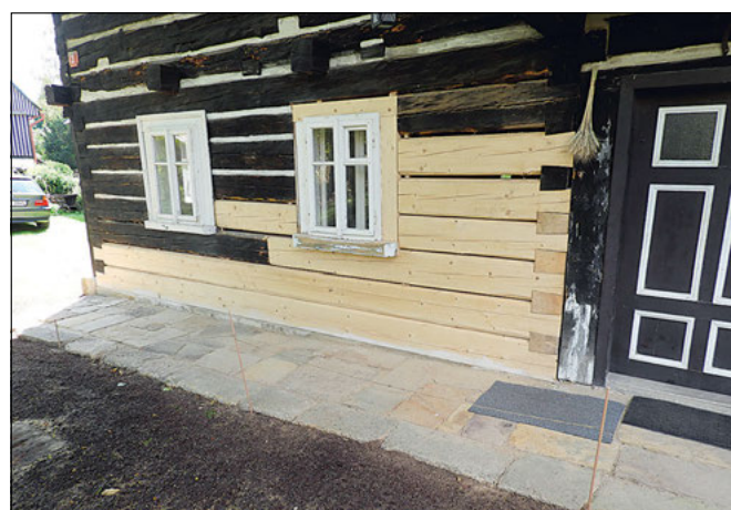
Dobřeň (správní obvod obce Mělník), VPR, roubený patrový dům čp. 3. Stav po tesařské obnově roubených stěn světnice a navazující obnově dlažby v zápraží, která byla nově přeložena a poškozené pískovcové desky nahrazeny materiálem stejného druhu (foto J. Berková).
