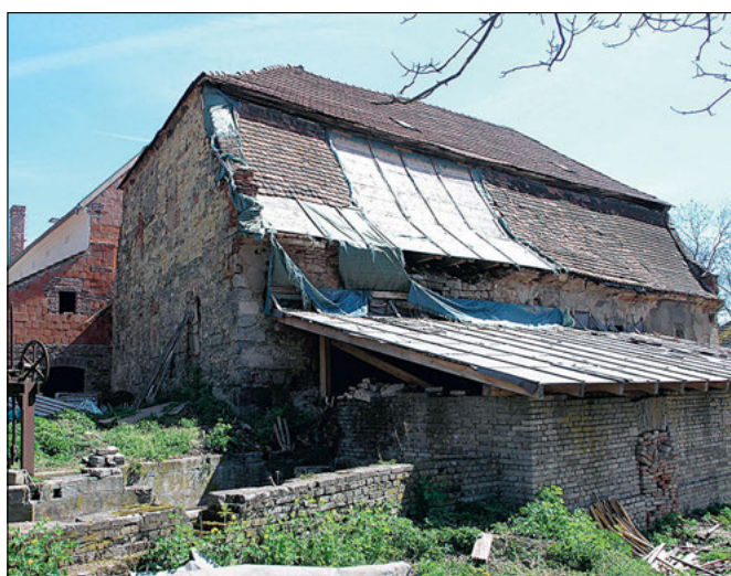
Vepřek (správní obvod obce Kralupy nad Vltavou), areál vodního mlýna čp. 19, stav před celkovou obnovou mlýnice, pohled od severozápadu na mlýnský náhon a částečně destruovaný turbínový přístavek (duben 2012, foto M. Hanzlíková).
