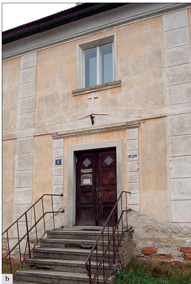
Cítov (správní obvod obce Mělník) fara: a – celkový pohled na vstupní fasádu po obnově; b – stav před obnovou (foto P. Kalinová).
