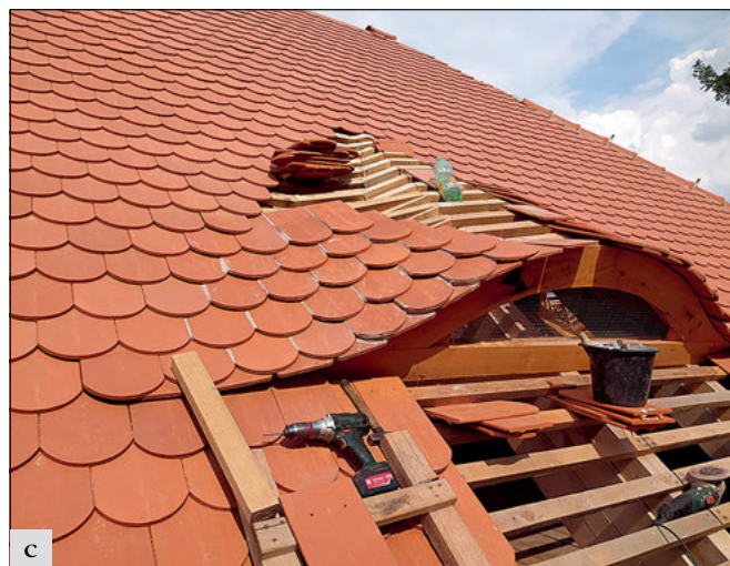
Loukov (správní obvod obce Mnichovo Hradiště): a – lovecký zámeček zv. Bažantnice, zařazený do seznamu ohrožených památek, byl v havarijním stavu bez střechy a s propadlými stropy; b – v letošním roce byla dokončena obnova střechy. Návrh obnovy včetně vikýřů ve tvaru volských ok vycházel z podoby zachycené na starších fotografiích. Dobře provedená obnova je výsledkem kvalitní projektové přípravy i úrovně řemeslných prací (foto E. Vyletová); c – detail vikýře v průběhu pokládky krytiny (foto T. Tomsa).
