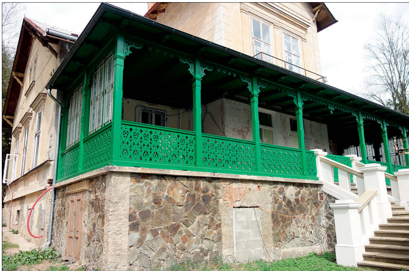
Roztoky u Prahy (správní obvod obce Černošice), vila čp. 110, terasa opět získala svou podobu z přelomu 19 a 20. století, dřevěná konstrukce s výplněmi ve stylu švýcarský a skleněné výplně s ornamenty celou stavbu rozzářily (foto A. Musilová).
