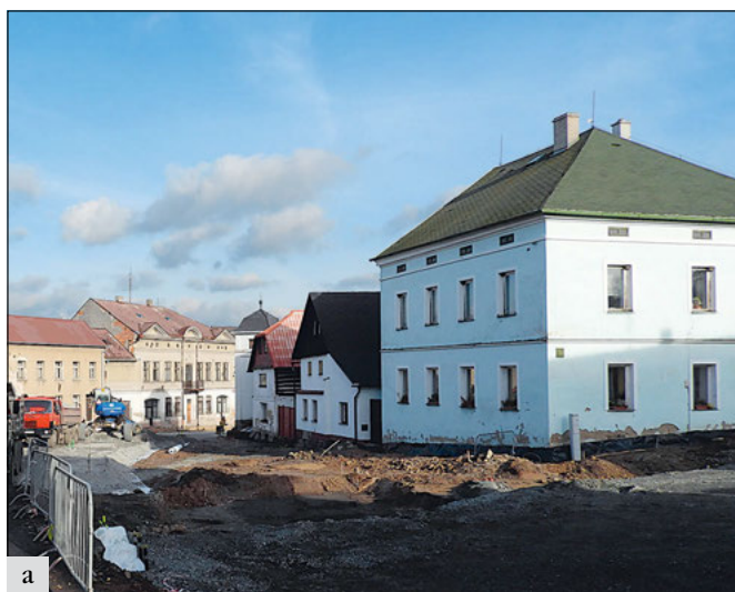
Měno (správní obvod obce Mělník), Mělnická ulice čp. 253, podoba domu daná úpravami realizovanými asi v závěru 20. století: a – snímek z roku 2018 zachycuje prostředí ulice v průběhu zahájené regenerace, při které byly odstraněny asfaltové povrchy a velkoformátové betonové dlažby; b – stav objektu po rekonstrukci fasády a výměně oken. Rehabilitace tradičního vzhledu vnějšího pláště domu, spojená s kultivací veřejného prostranství, vytvořila z tohoto prostoru s charakterem náměstí, příjemný kout města (foto J. Berková).
