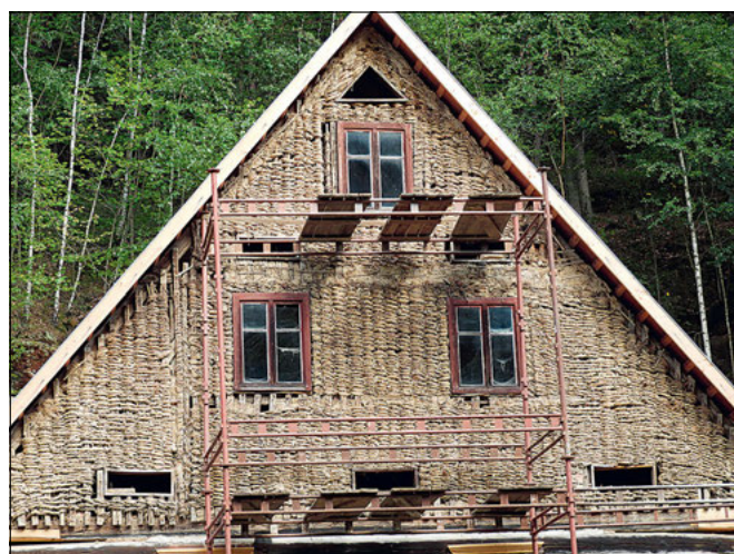
Vidim (správní obvod obce Mělník), VPZ, roubený dům čp. 80. Pod bedněnou lomenicí se zachoval původní štít z roku 1872 s tradiční konstrukcí z tyčí vyplétaných slaměnými povříšly. Vnější omítka byla před osazením dřevěného štítu odstraněna, což umožnilo dokumentovat tuto dnes již vzácnou stavební lidovou techniku a ocenit jak vysokou zručnost tehdejších řemeslníků, tak rovněž estetickou kvalitu díla (foto J. Berková).
