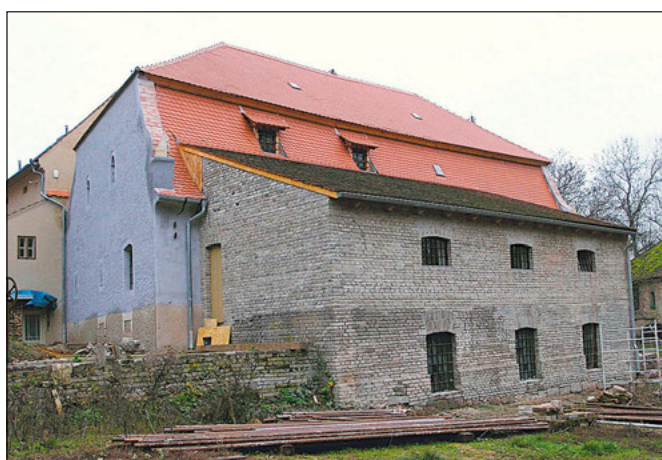
Vepřek (správní obvod obce Kralupy nad Vltavou), areál vodního mlýna čp. 19, stav po celkové obnově mlýnice, pohled od severozápadu na západní průčelí mlýnice s obnoveným turbínovým přístavkem (listopad 2020, foto M. Hanzlíková).
