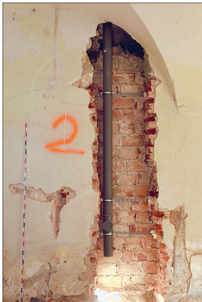
Mělník Pšovka, bývalý augustiniánský klášter. Odhalený gotický portál z ambitu do sakristie byl sice již v minulosti ilegálně probourán pro svislé rozvody, ale i při současné obnově bylo rezignováno na jeho restaurování a prezentaci, zato stoupačka byla rekonstruována (foto V. Jesenský, 2020).
