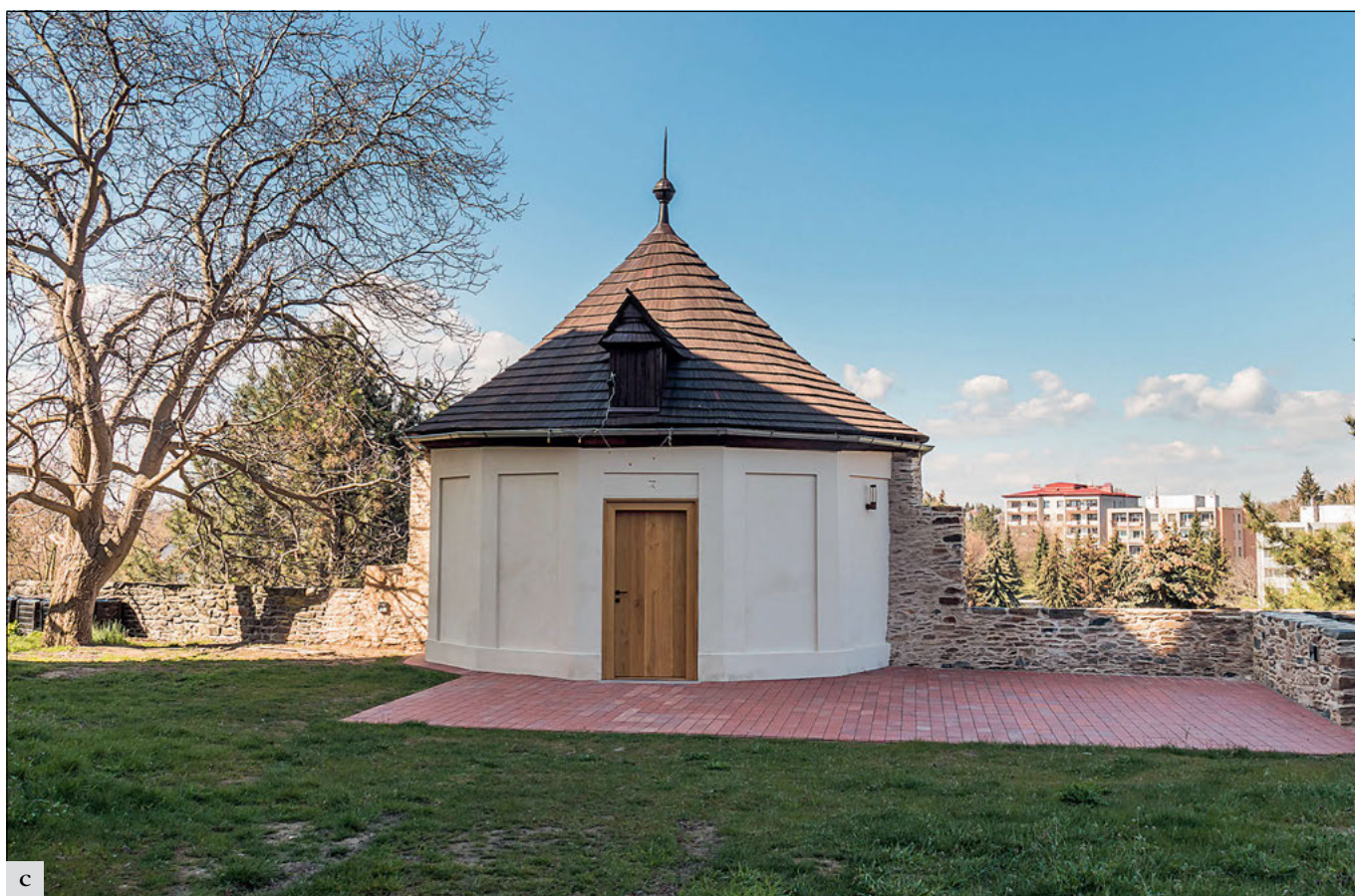
Čáslav (správní obvod obce Čáslav), bašta č. 8 (čp. 158): a – hradební bašta s klasicistní dozdívkou na vnitřní straně byla v 1. polovině 20. století doplněna o přístavky v souvislosti se zřízením bytu kostelníka evangelického sboru. Později sloužila také jako skautské středisko. V roce 2017 došlo k odstranění přístavek (foto B. Schmidová); b – archeologický nález původního půdorysu bašty (foto F. Velímský); c – stav bašty po obnově (foto J. Černochová).
