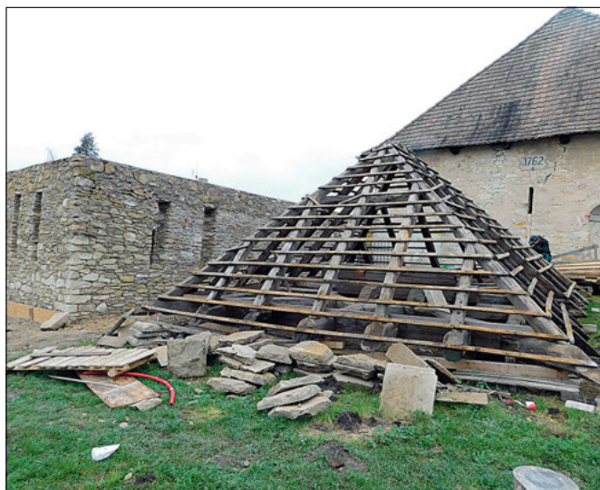
Lysá nad Labem (správní obvod obce Lysá nad Labem), kočárovna v areálu římskokatolické fary čp. 7. Z důvodu havarijního stavu byl stavbě vcelku sejmuto původní krov, rozdělený na dvě části, obvodové zdivo objektu bylo rozebráno a východní část objektu ve svahu nově podzákladována. Na fotografii je stav v rámci nového vyzdívání z původního opukového zdiva a původního prosátého písku, zachován byl konstrukční princip a skladba zdiva. Nově byly vytvarovány okenní otvory v rámci využití stavby jako zázemí komunitního centra (foto E. Zápalková).
