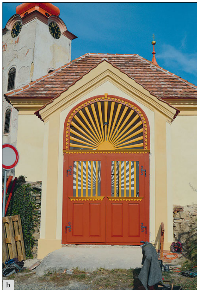
Svojšice (správní obvod obce Kolín), areál kostela sv. Václava: a – výklenková kaple dodatečně přistavěná k fasádě márnice, stav před rekonstrukcí; b – stav po rekonstrukci s odbornou opravou katuru včetně jeho barevnosti (foto D. Havlíková).
