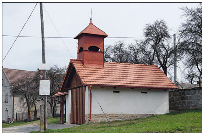
Nosálov (správní obvod obce Mělník), VPR. Drobná stavba staré hasičské zbrojnice je cenným dokladem tradiční vybavenosti vesnice na přelomu 19. a 20. století. V 2. polovině 20. století byla k objektu přestavěna čekárna autobusové zastávky s pultovou střechou navazující na hlavní průčelí, která původní objekt vzhledově velmi poškozovala, stejně jako krytina z vlnitého eternitu. V rámci obnovy byla čekárna nahrazena kvalitnější zděnou stavbou odsazenou od líce průčelí. Stavba dostala novou pálenou taškovou krytinu a nová vrata. Ačkoli se nejedná o kulturní památku, objekt velmi pozitivně dotváří prostředí rezervace a je příkladem citlivého přístupu obce k místní historické zástavbě (foto J. Berková).
