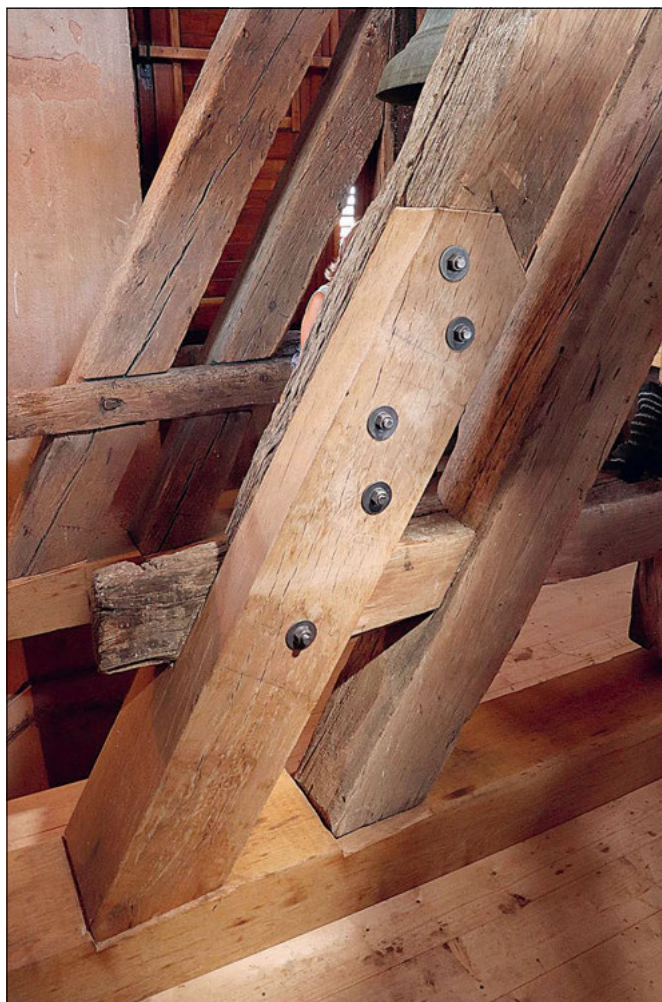
Sadská (správní obvod obce Nymburk), kostel sv. Apolináře, proběhla obnova dubové stolice zvonu ve věži kostela. Zvonová stolice může být starší než z doby barokní úpravy kostela, která proběhla ve 30. letech 18. století. Povrch dubových trámů je totiž vyžilý a celá konstrukce působí archaicky. Nakonec byly přes veškerou snahu pracovníků památkové péče vzpěry dubové stolice protézovány běžným způsobem pomocí ocelových svorníků (foto M. Gottwaldová).
