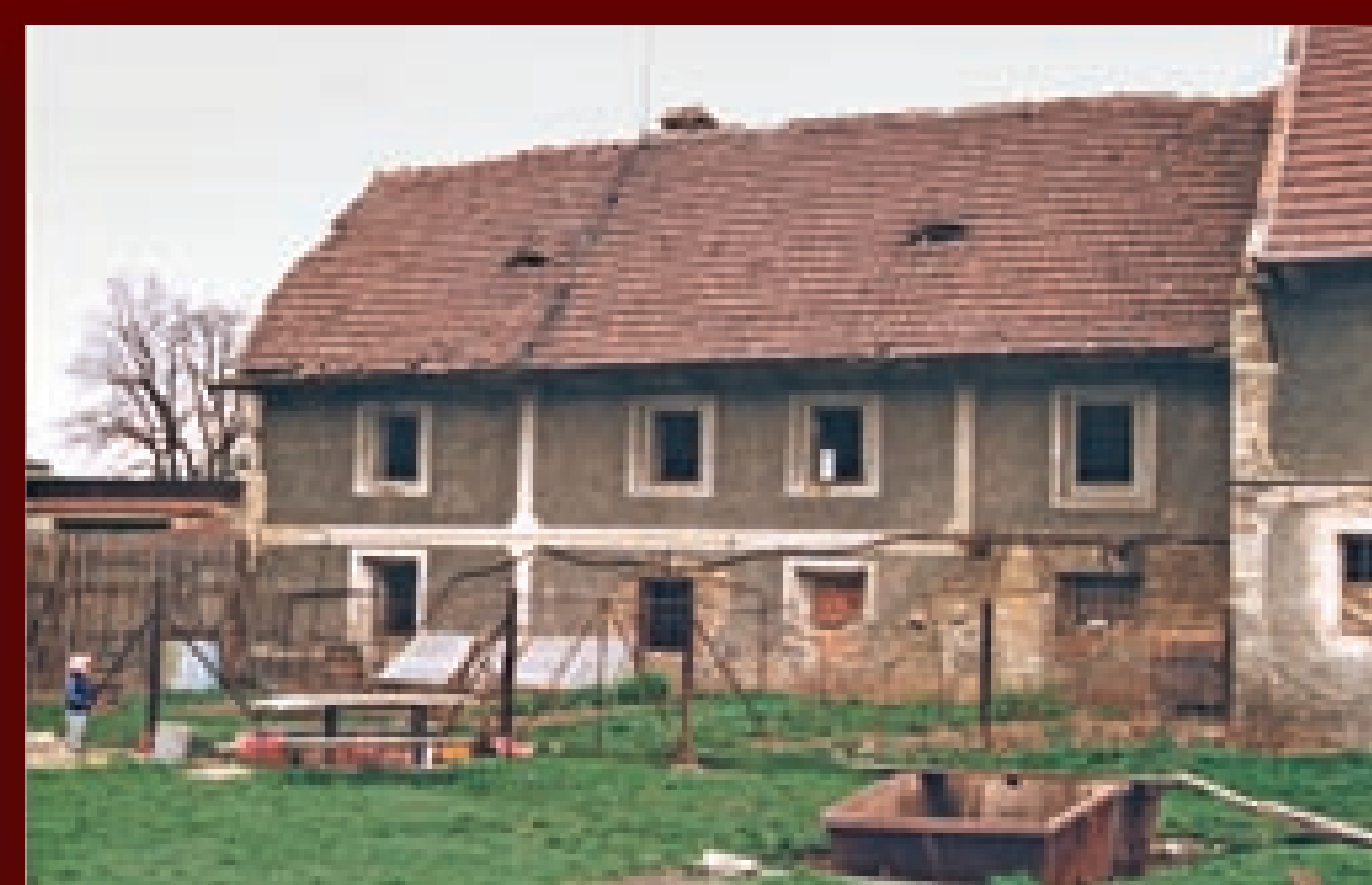
Dvorní průčelí domu – stav v roce 1997.
