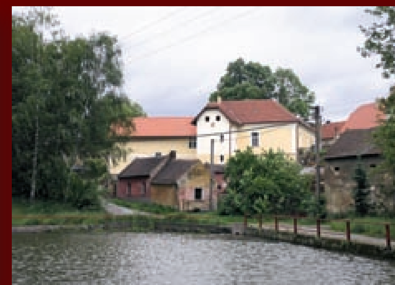
Pohled od rybníka po obnově fasády.
