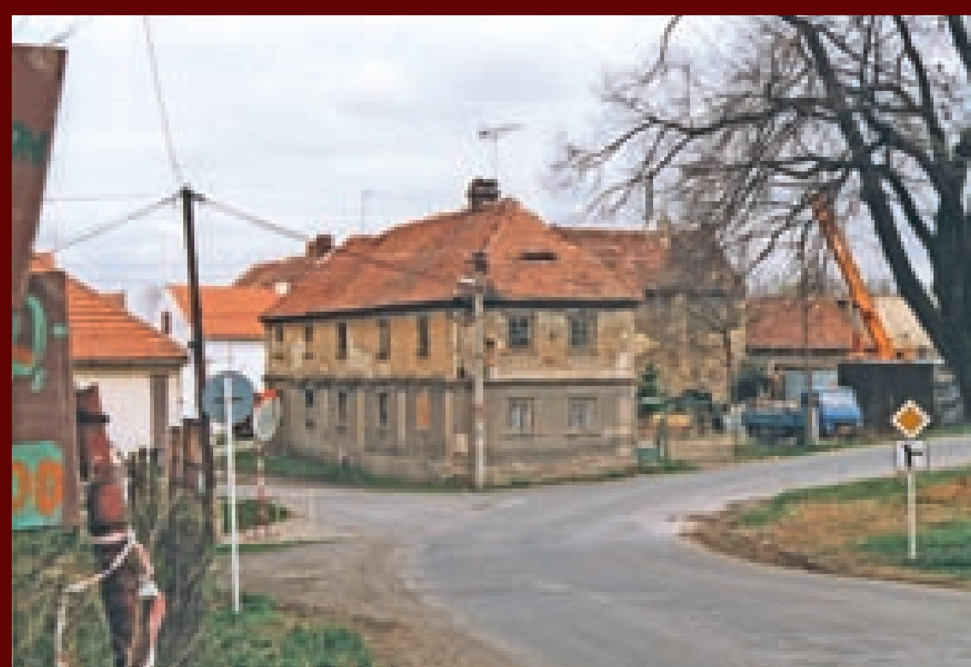
↑ Stav domu před zahájením obnovy na konci 90. let 20. století s výrazným poškozením krovu a střešního pláště.
