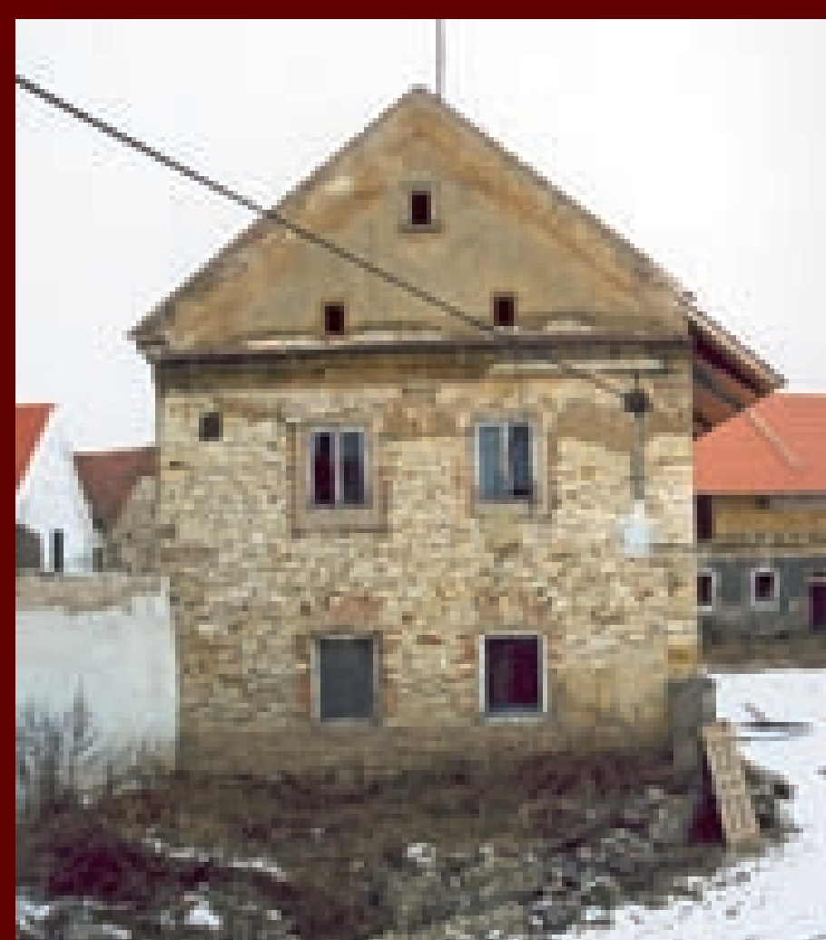
↑↗ Proměny obytného stavení v letech 2001–2005. Obnovená fasáda byla v detailech členění rekonstruována podle dochovaných zbytků původních článků a profilací.
