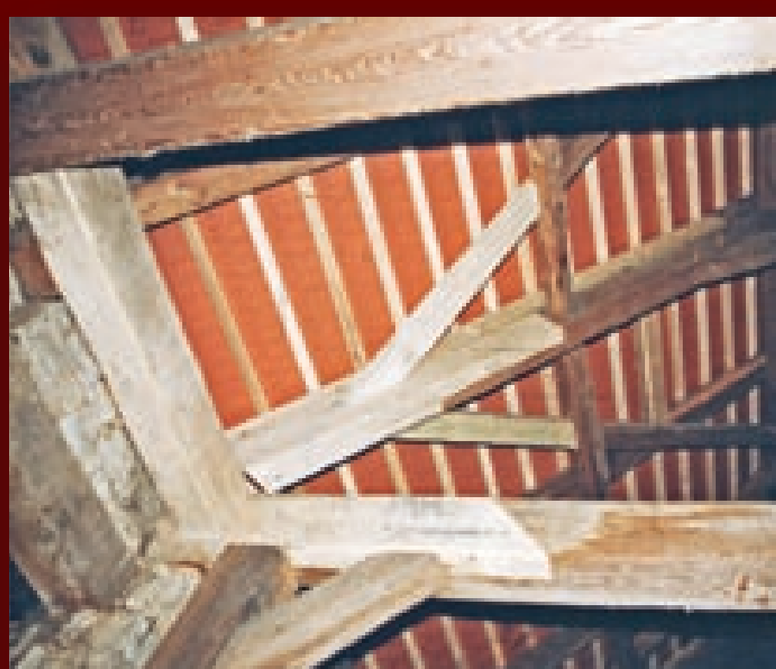
↑ Kvalitní původní krov stodoly bylo nutno citlivě opravit bez zbytečného nahrazování celých původních prvků.
