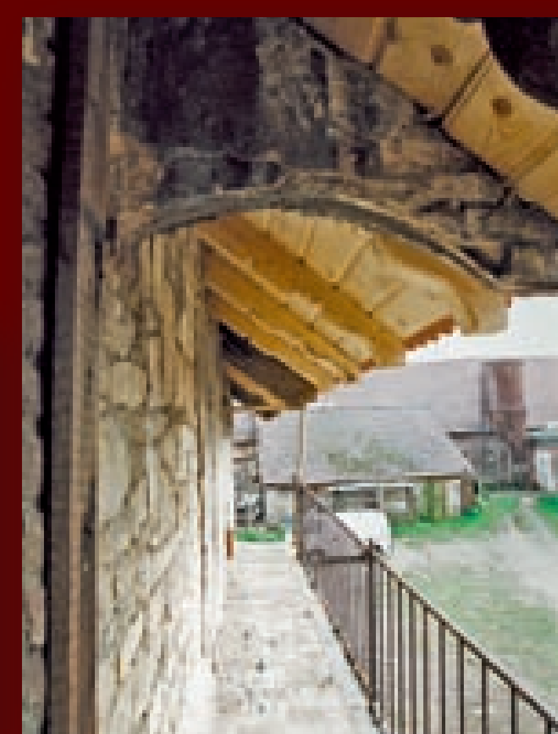
Detail zastřešení pavlače na hospodářském stavení po obnově.
