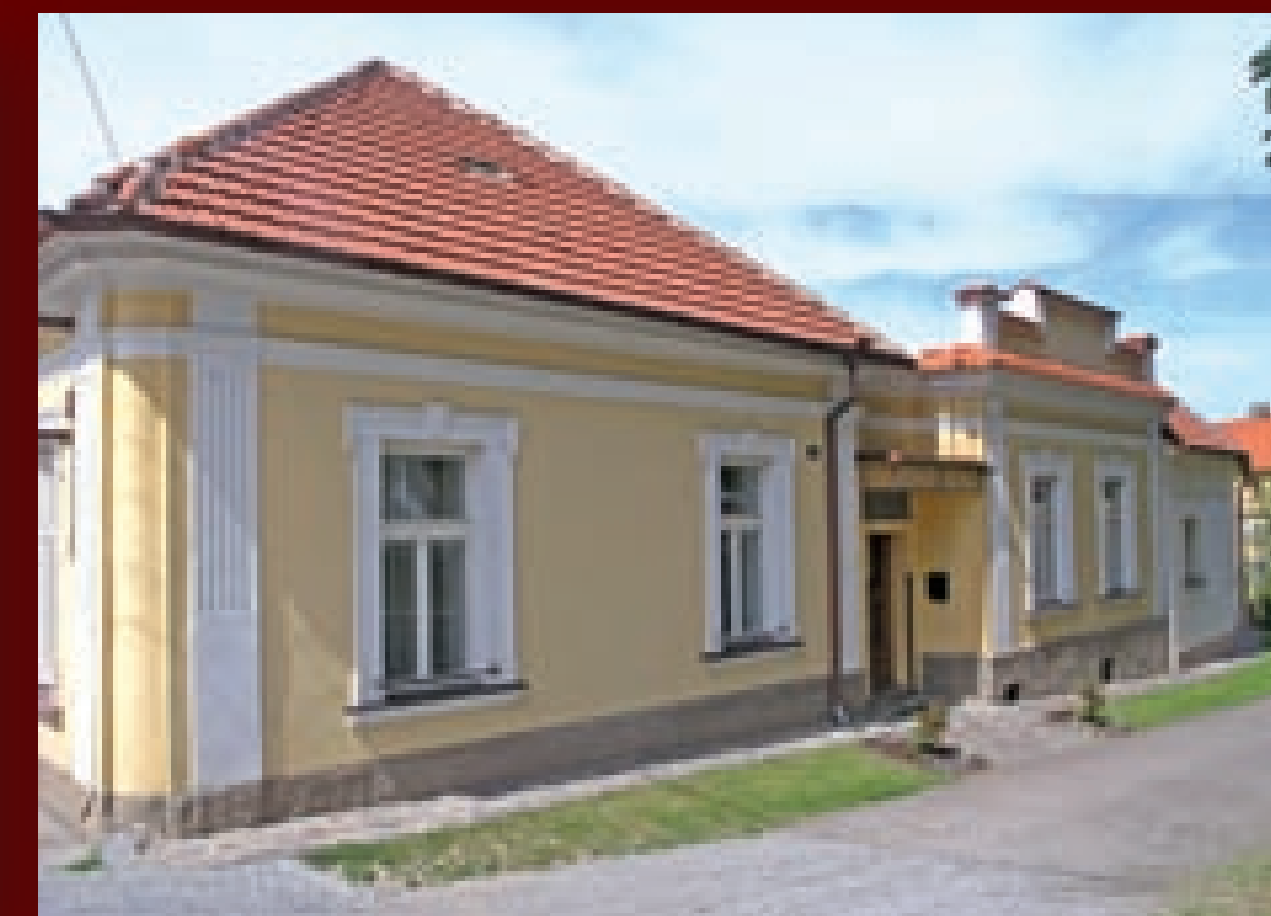
Stav po nahrazení vrat dvojicí oken s profilovanými šambránami a obnově fasády západního a středního dílu jižního průčelí.
