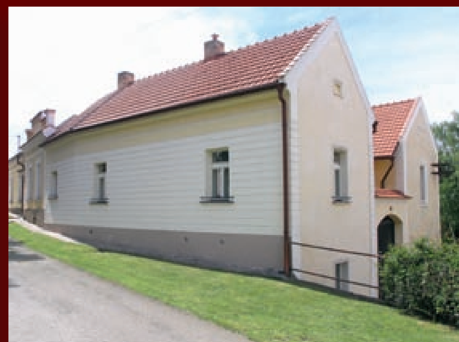
Po obnově – konečná podoba odpovídá výsledkům z průzkumu fasády.
