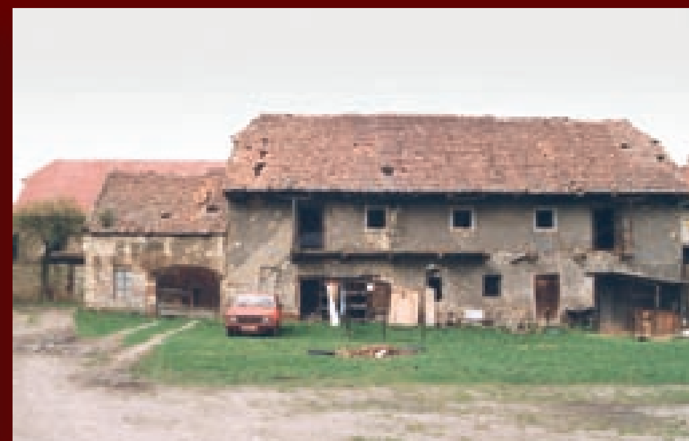
Špýchar s kolnou – stav před obnovou střechy.
