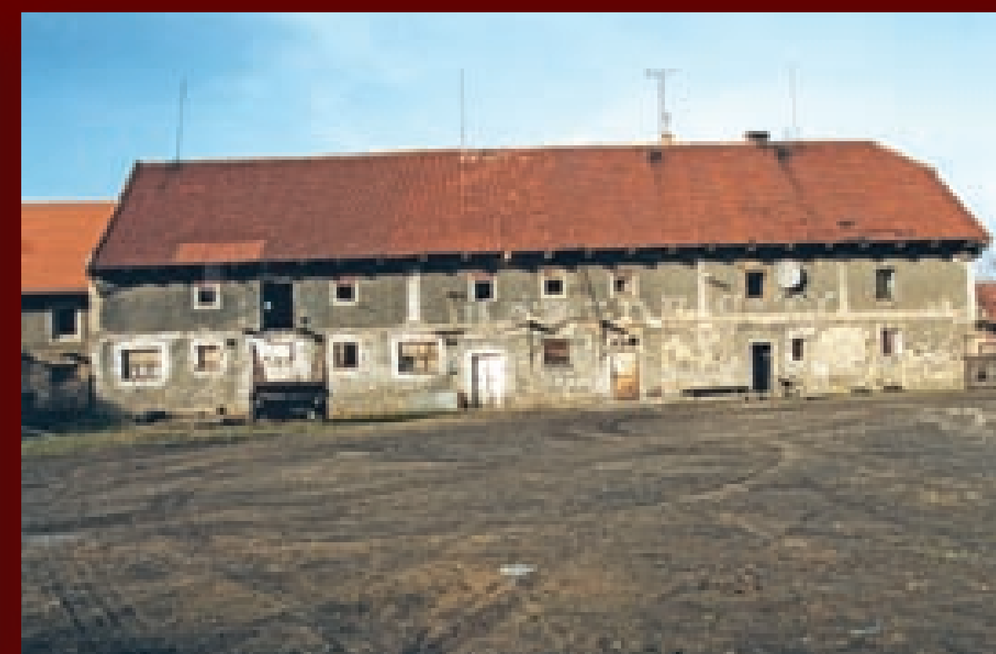
↑↕ Proměna domu v průběhu obnovy. Výraznou pozitivní změnou byla rehabilitace původního řázení okenních os a odstranění novodobých otvorů ve stěnách.
