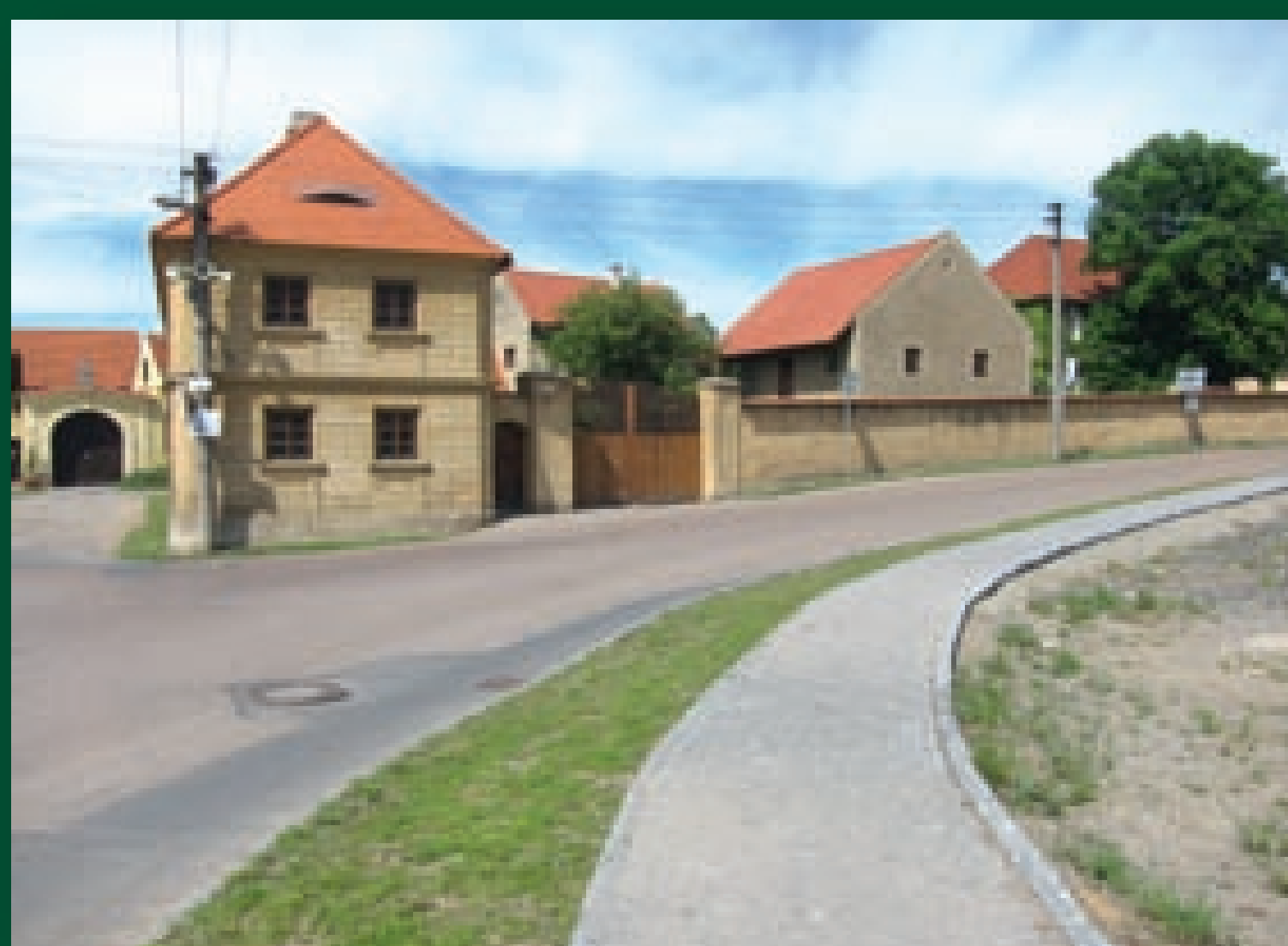
↑ Dokončená kamenná dlažba chodníků a vjezdů k čp. 6.
