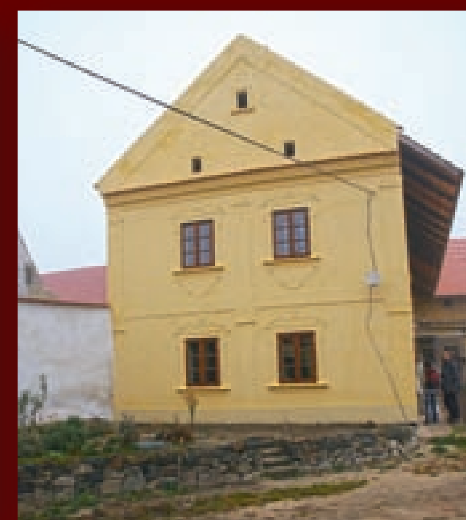
↑↗ Proměny obytného stavení v letech 2001–2005. Obnovená fasáda byla v detailech členění rekonstruována podle dochovaných zbytků původních článků a profilací.
