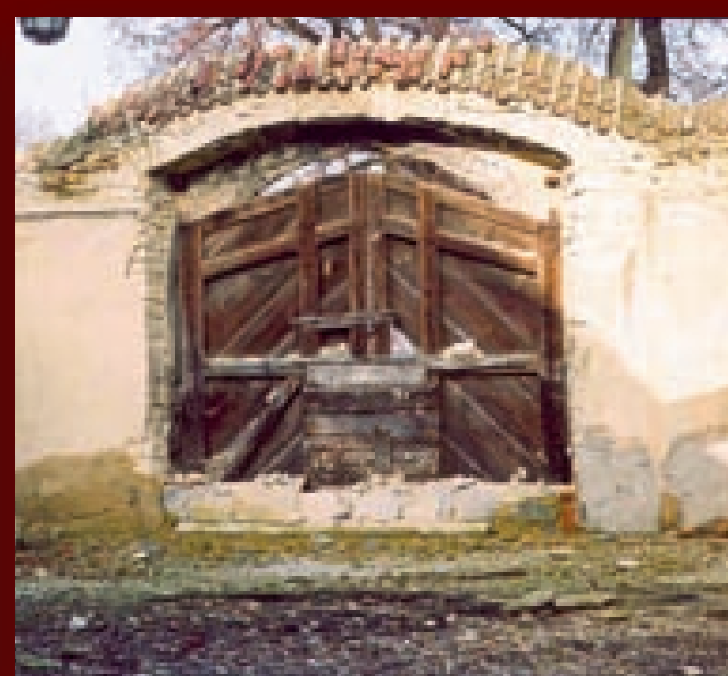
↑ Odstranění novodobých chlívků přizděných k bráně umožnilo obnovit její původní komunikační funkci. Vrata však bylo nutno nahradit funkční kopií.
