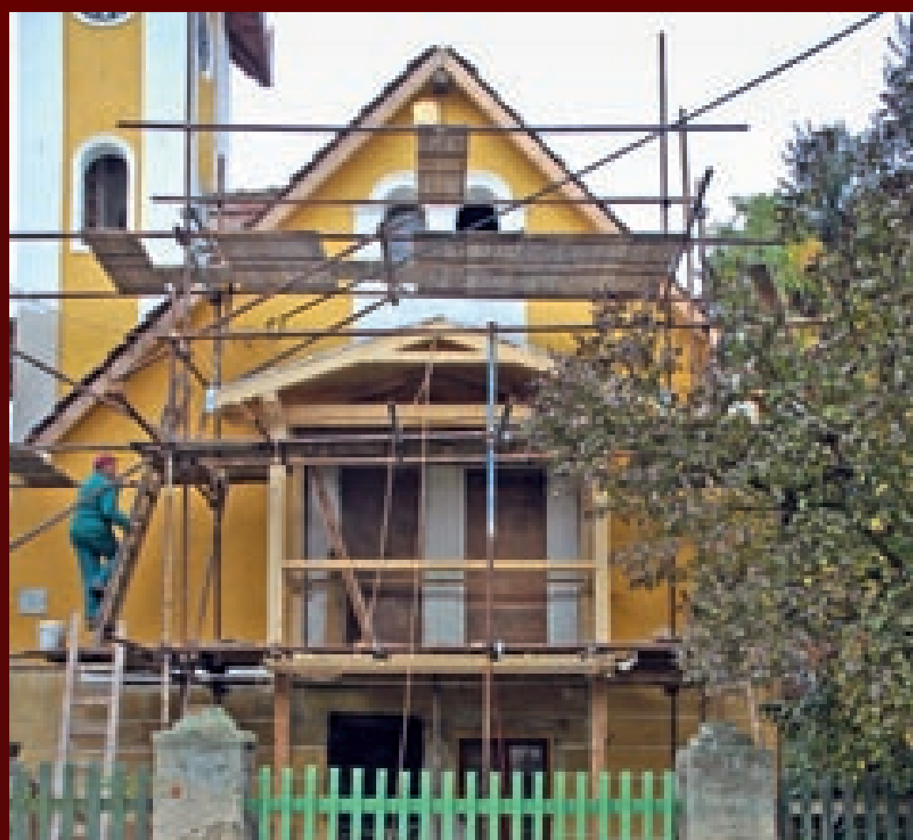
↑ Nosná konstrukce arkýře byla obnovena v původním složení a proflech trámů. Rovněž prkna svisle bedněného pláště bylo nutno z větší části nahradit novými stejné šířky. Na ně byly zpětně osazeny profilované lišty a další zdobné prvky.
