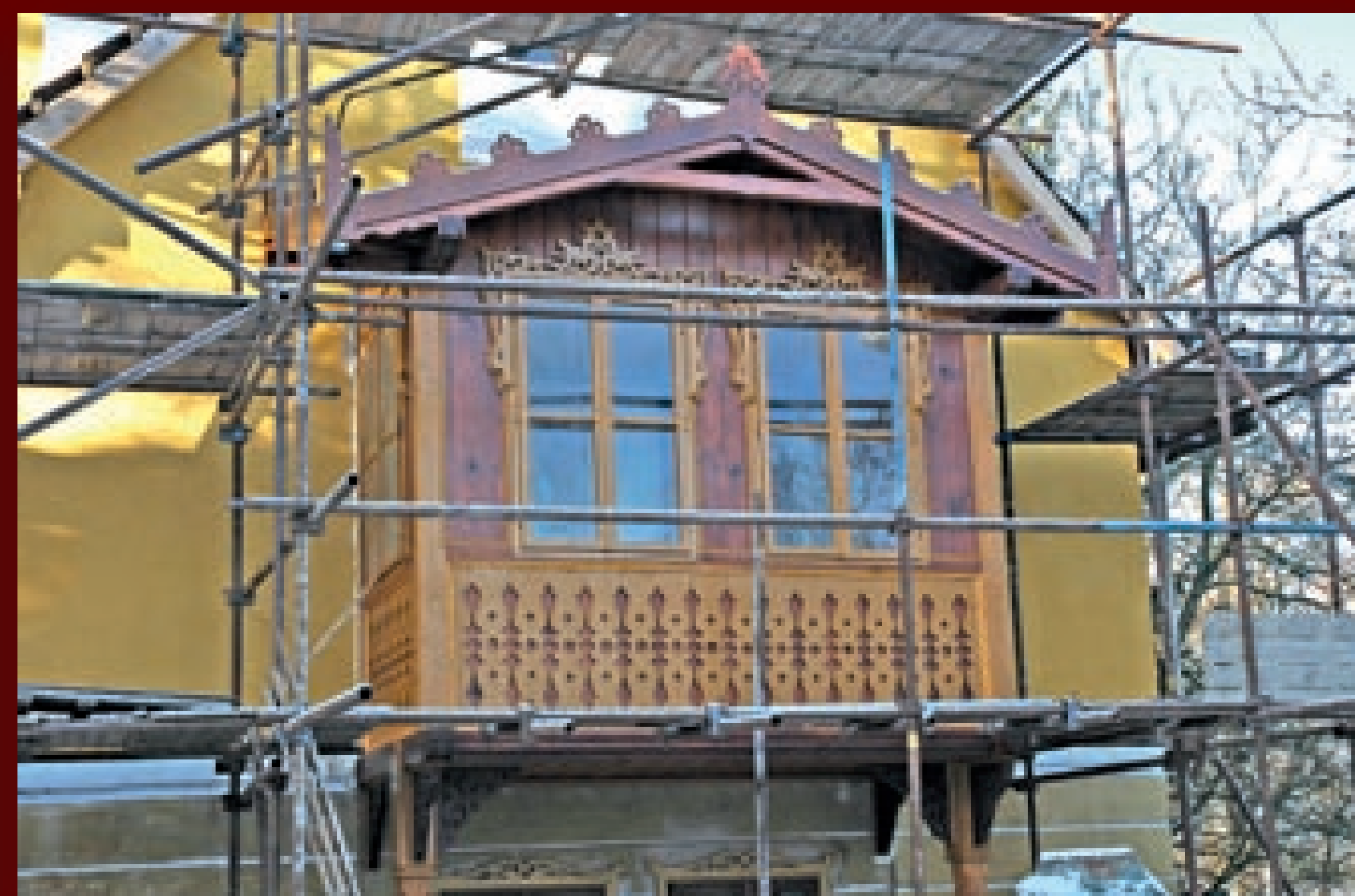
↑ Nosná konstrukce arkýře byla obnovena v původním složení a proflech trámů. Rovněž prkna svisle bedněného pláště bylo nutno z větší části nahradit novými stejné šířky. Na ně byly zpětně osazeny profilované lišty a další zdobné prvky.
