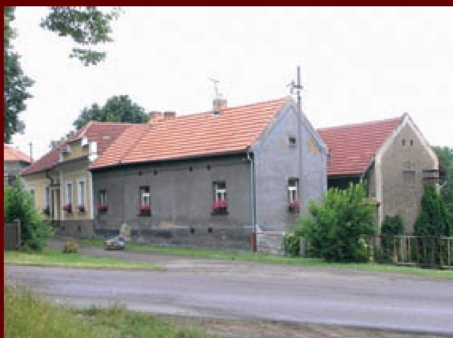
Východní část jižního průčelí a navazující východní průčelí s tvrdou stříkanou omítkou – stav před obnovou.
