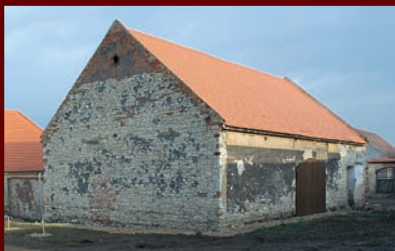
Stodola usedlosti po opravě střešního pláště.
