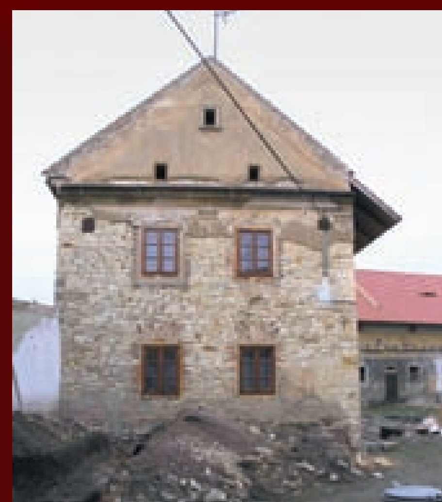
↑↗ Proměny obytného stavení v letech 2001–2005. Obnovená fasáda byla v detailech členění rekonstruována podle dochovaných zbytků původních článků a profilací.
