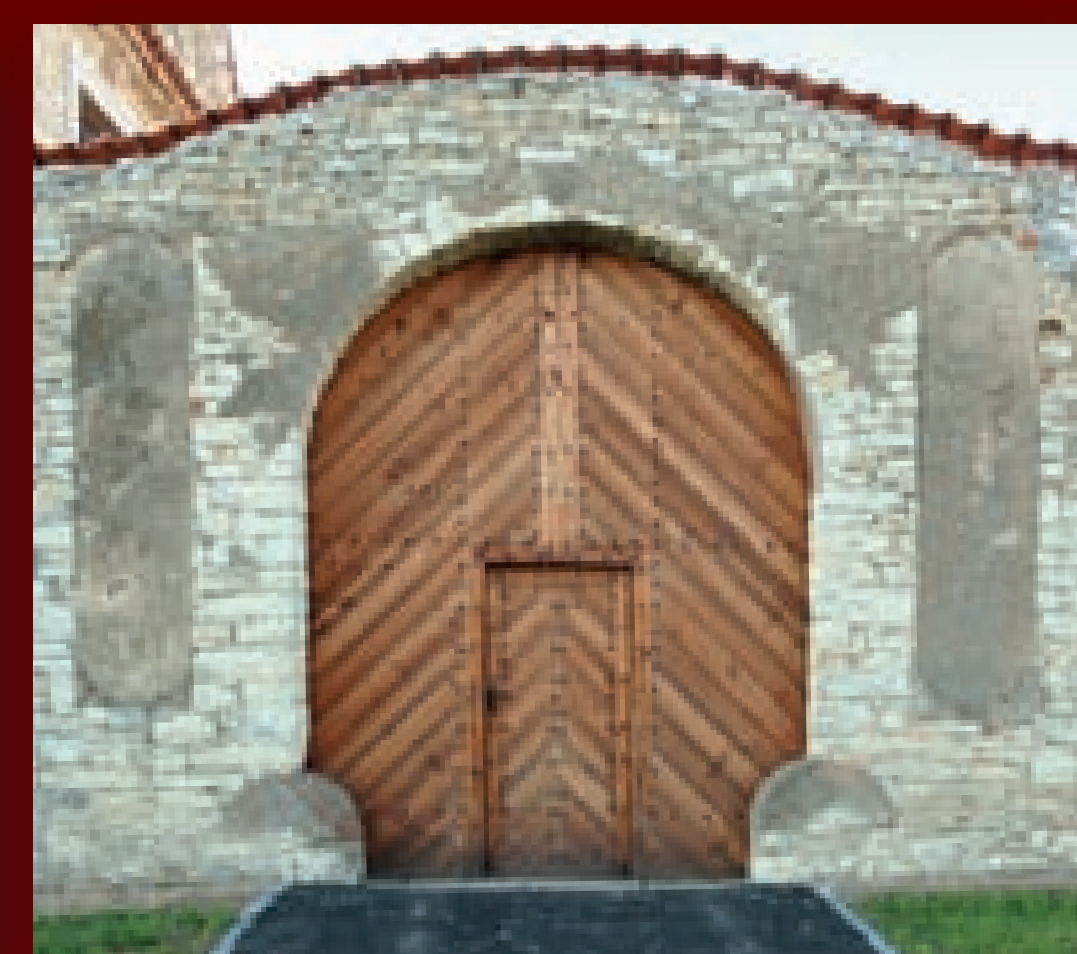
↑ Odstranění novodobých chlívků přizděných k bráně umožnilo obnovit její původní komunikační funkci. Vrata však bylo nutno nahradit funkční kopií.
