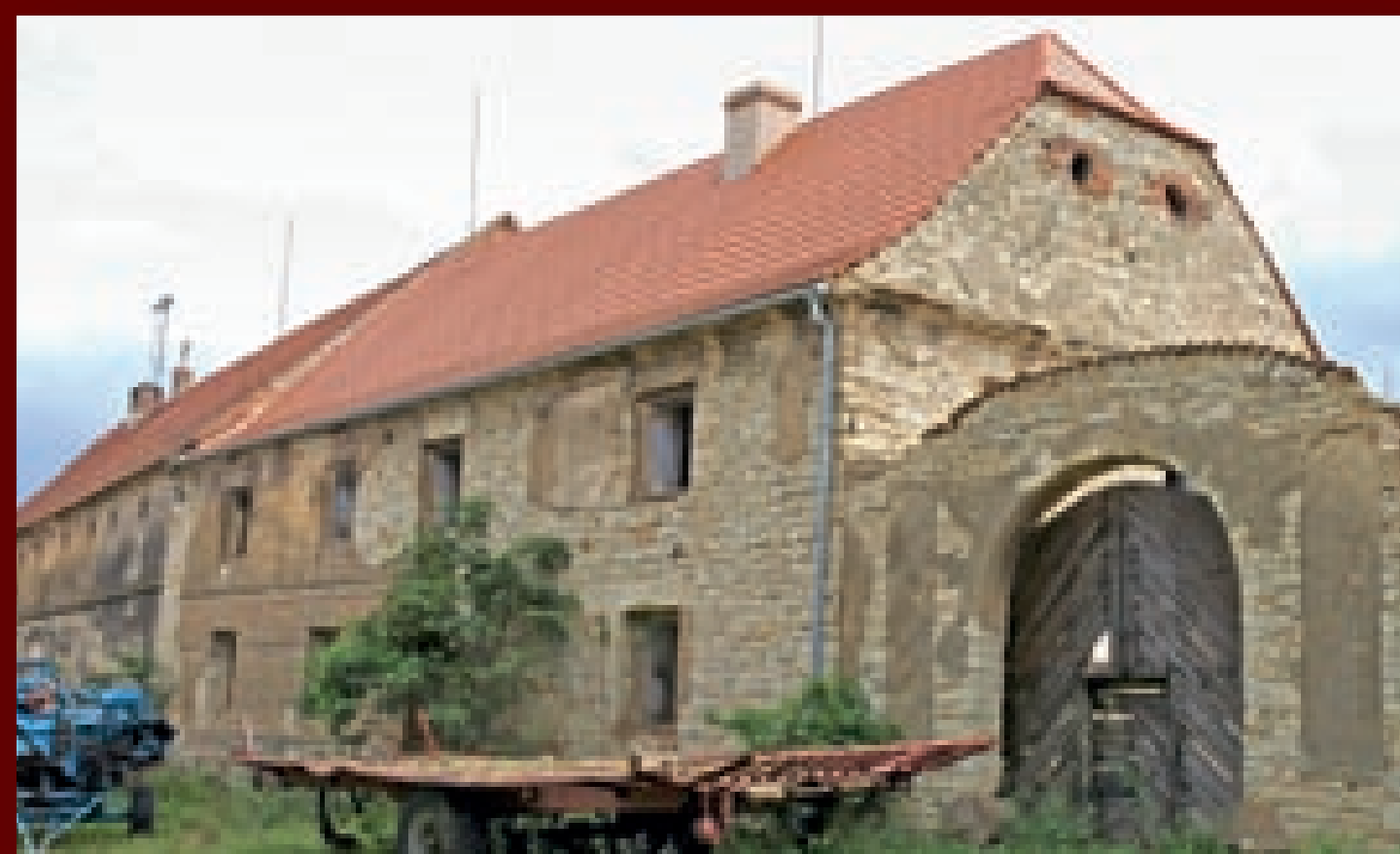
Návesní průčelí – stav po obnově střechy v roce 1999.
