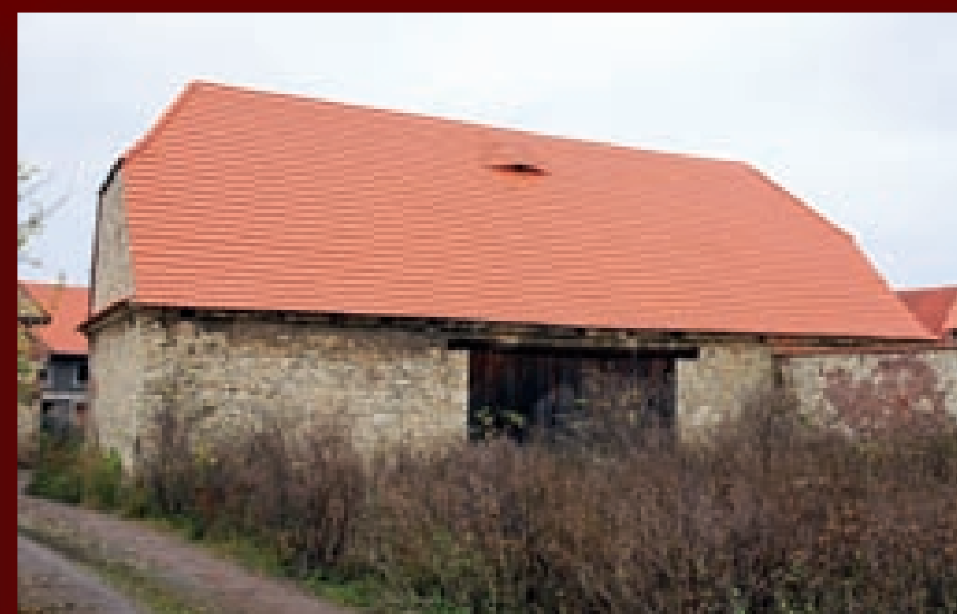
Stodola po obnově střešního pláště a krovu.
