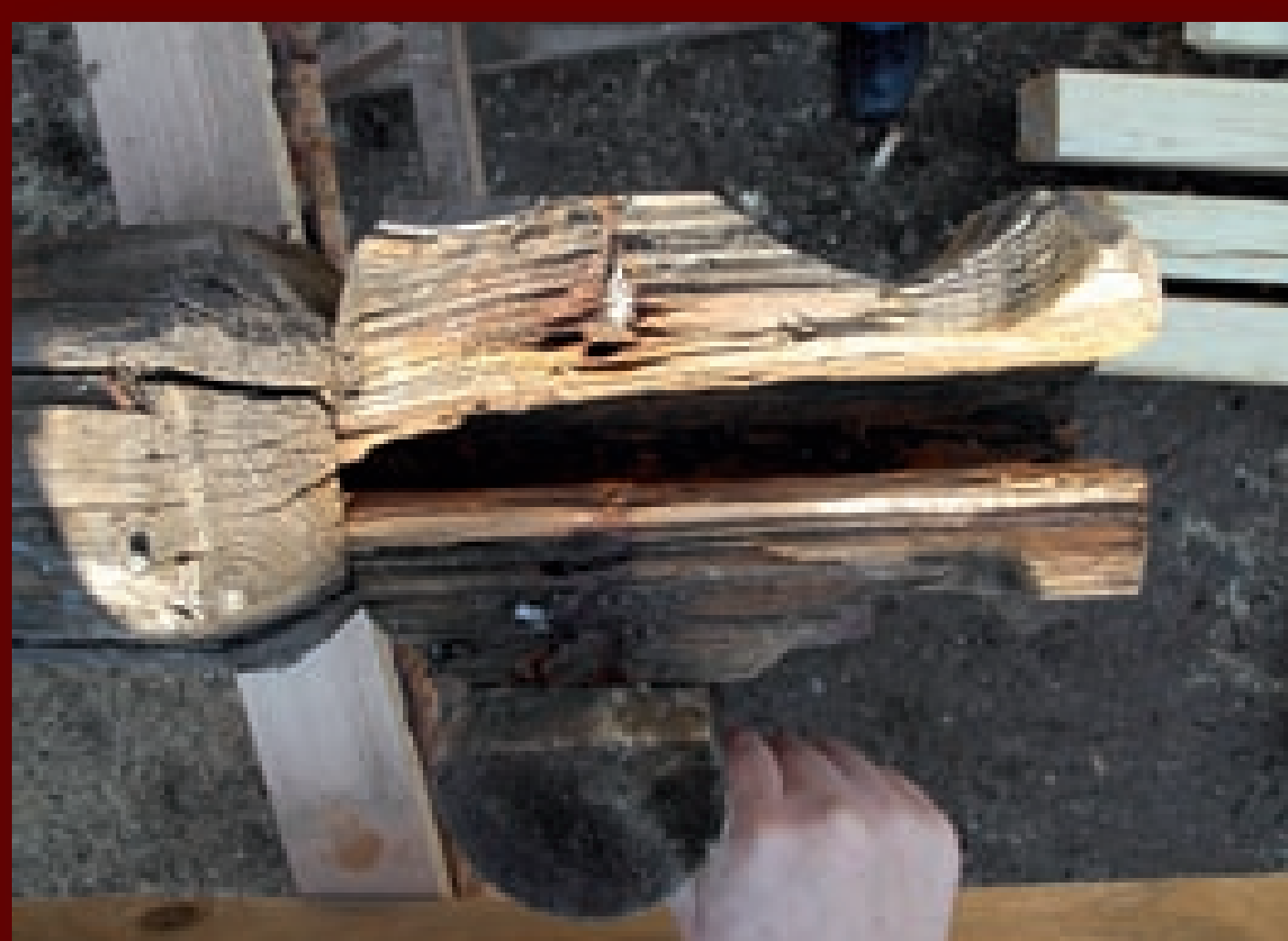
Detail vrcholu dřevěné hrotnice po sejmutí původního oplechování.
