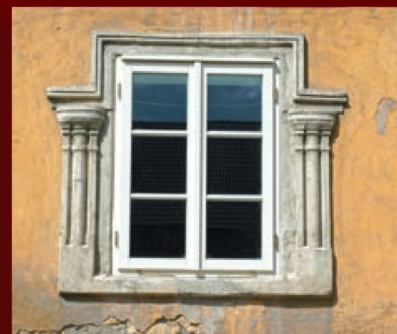
↑ Stav okenních výplní před obnovou a po rehabilitaci jejich původního členění.
