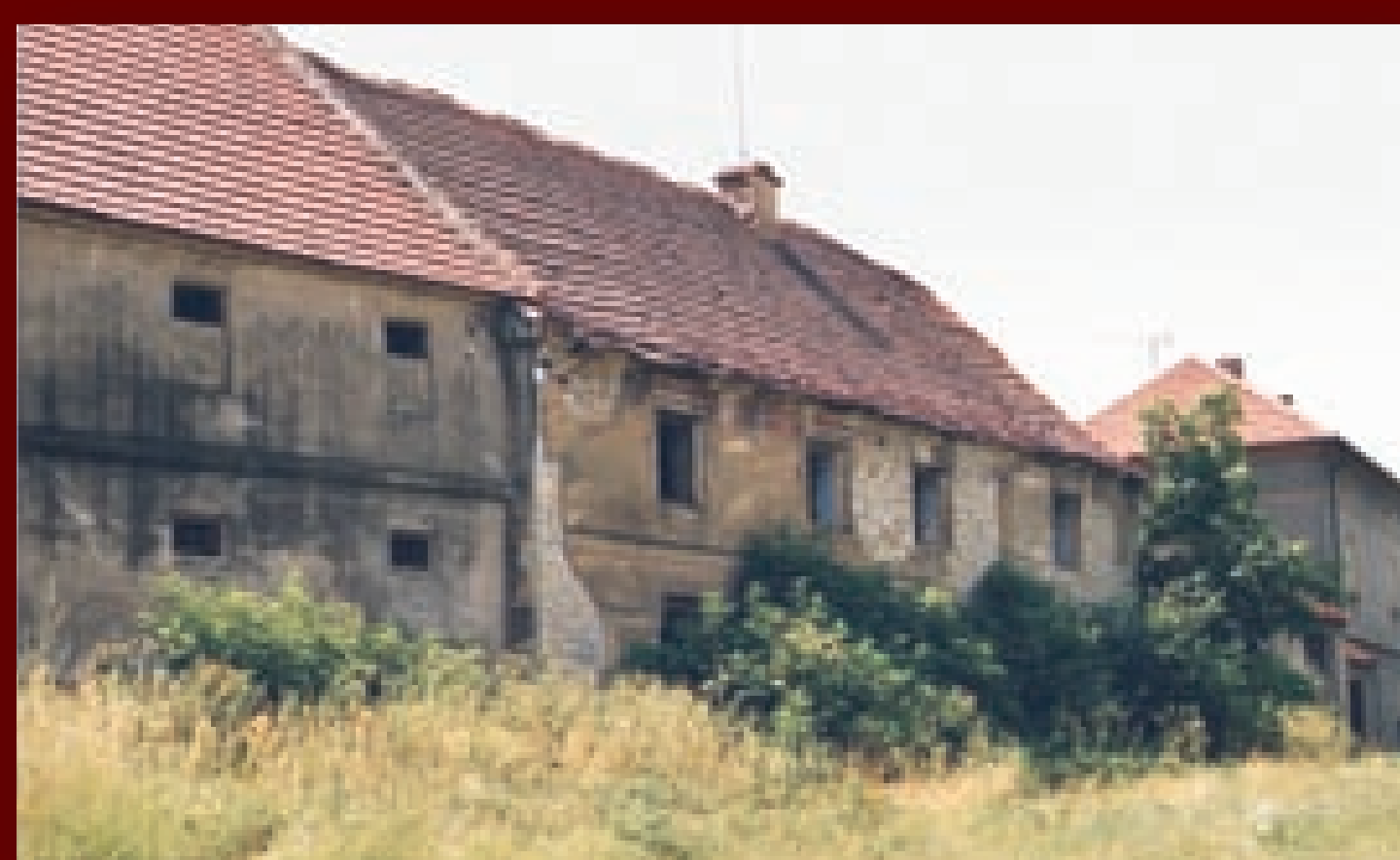
Návesní průčelí domu – stav v roce 1997.
