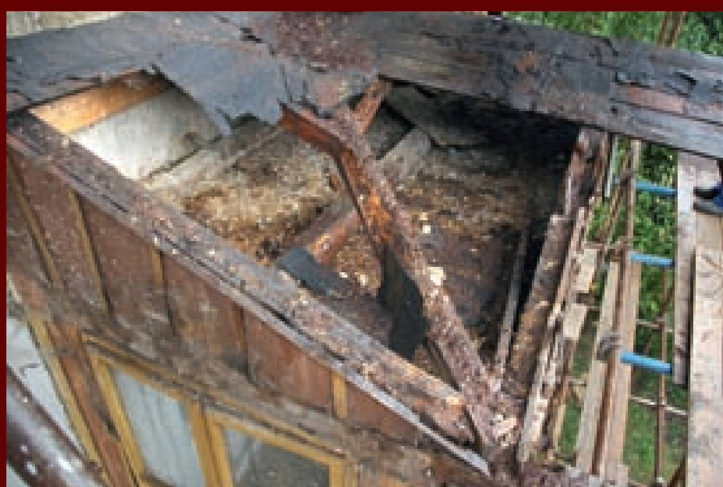
Stav krovu na arkýři byl zcela havarijní.
