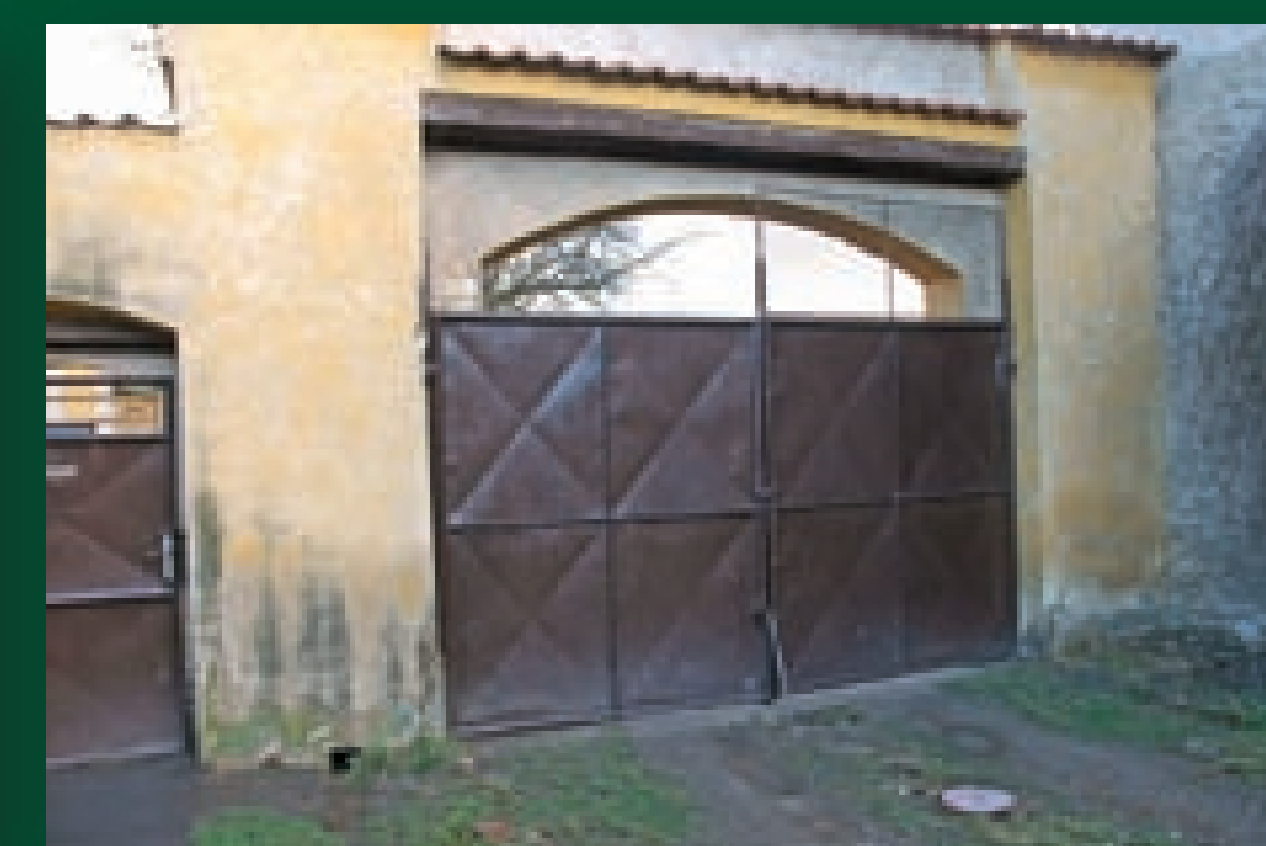
Brána před obnovou s plechovými vraty – pohled ze dvora.
