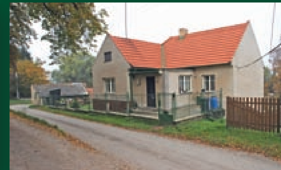
Sdružená okna osazená v rámci protihlukových opatření částečně eliminují nevhodné proporce okenních otvorů.
