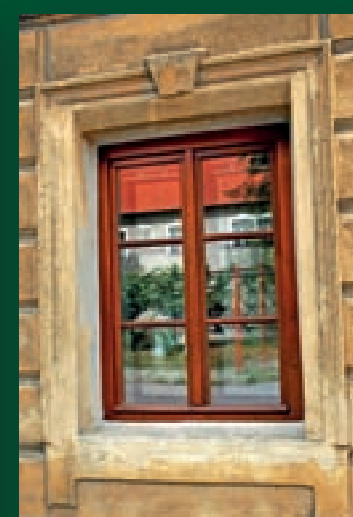
↑ Dům čp. 8 – členěná okna osazená v souvislosti s protihlukovým opatřením korespondují s eklektickou fasádou.
