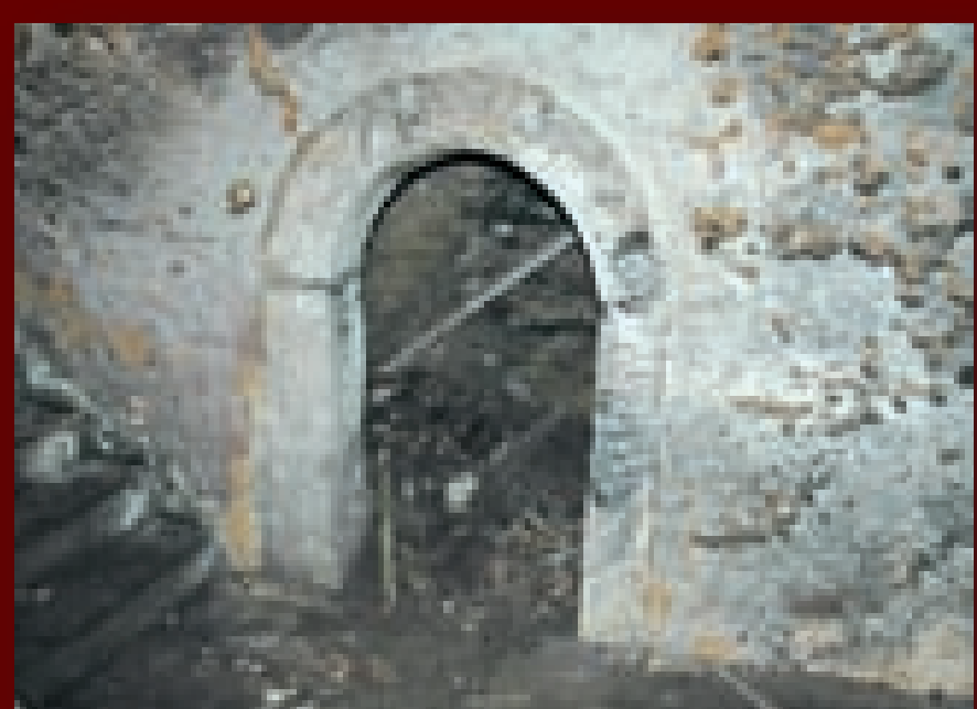
Kamenný portálek spodního sklepa pod domem, datovatelný do 16. století.
