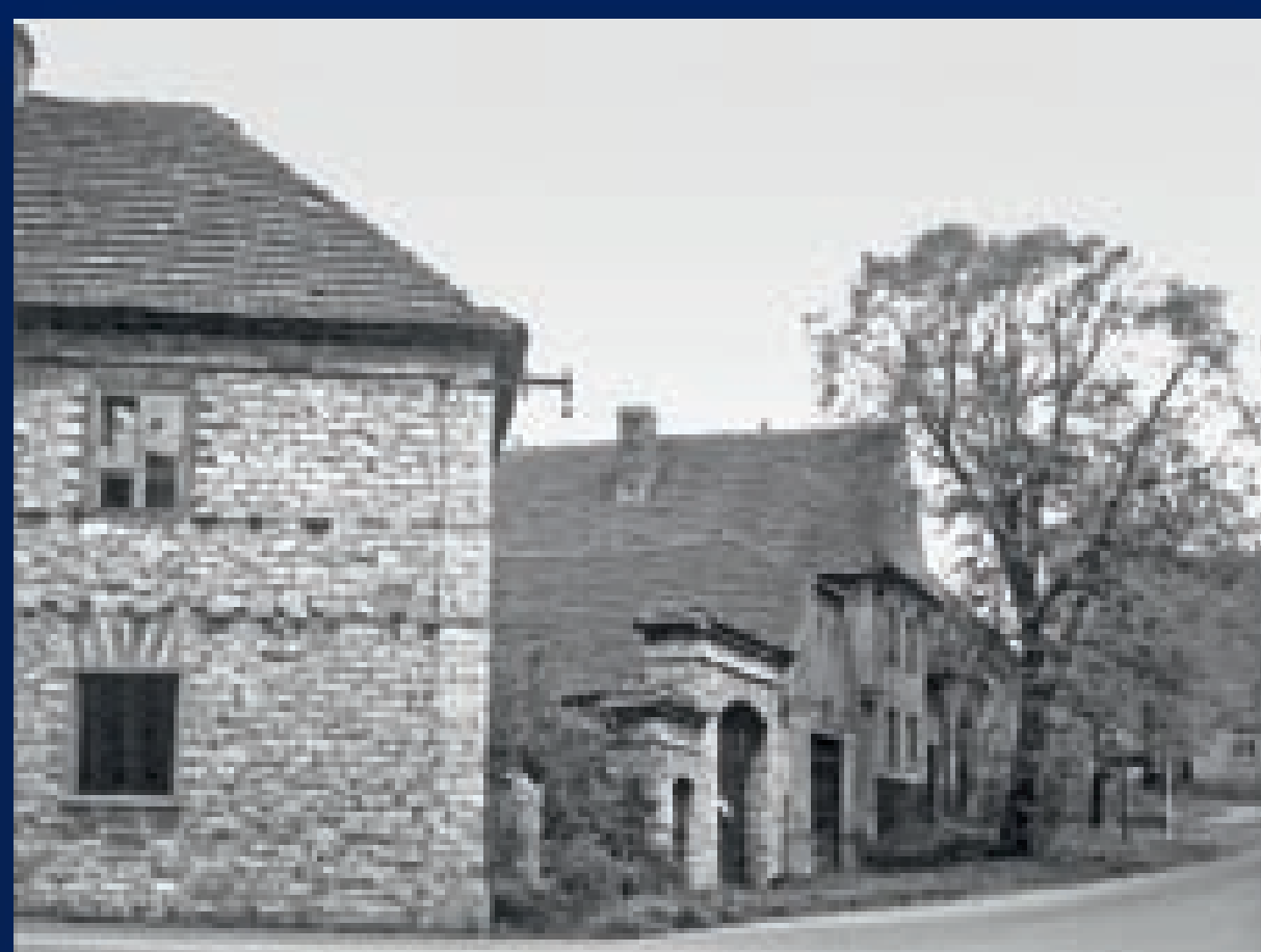
Dnes zaniklá usedlost čp. 7, pohled od severozápadu, foto 1983.
