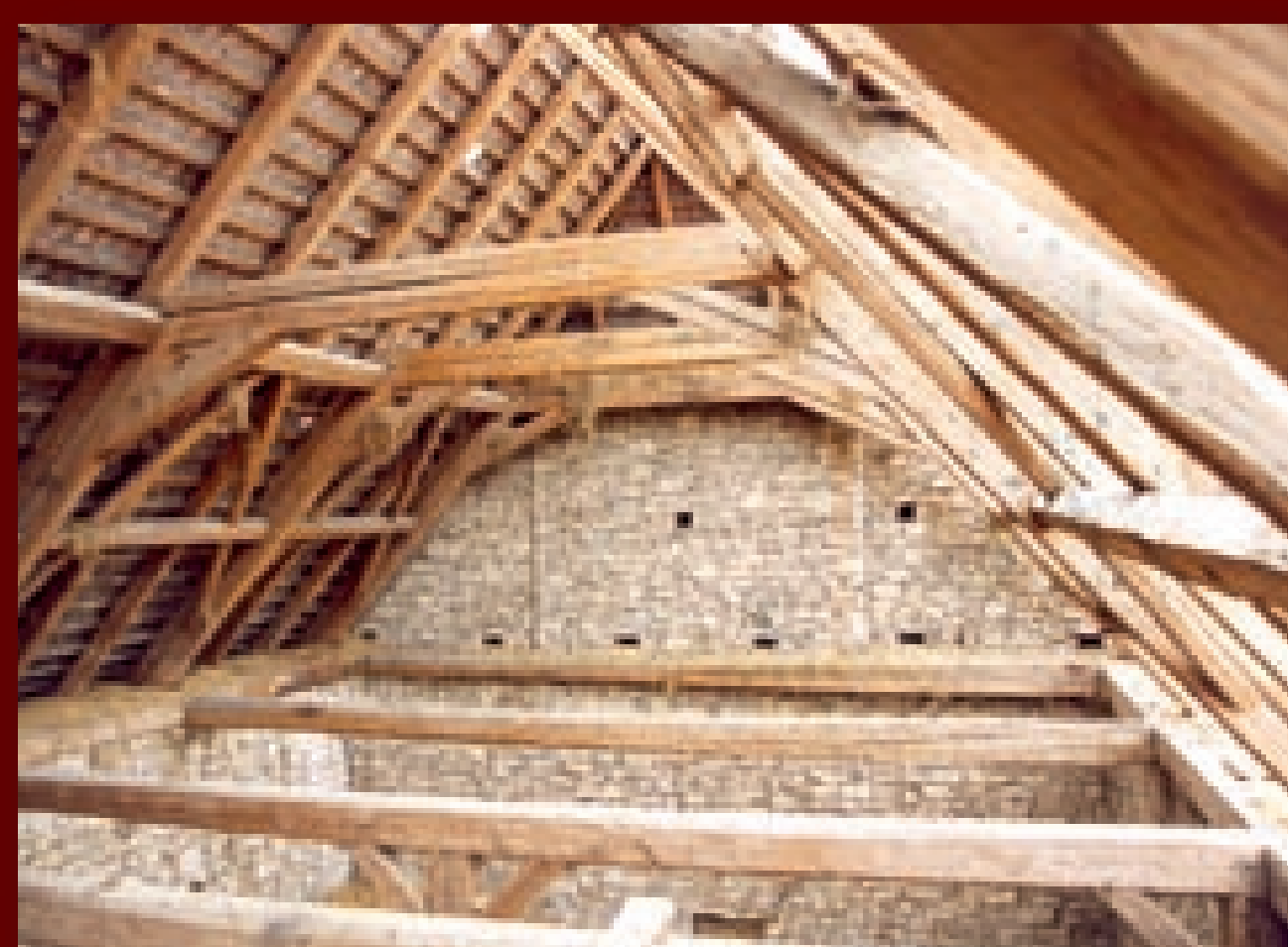
↑ Kvalitní původní krov stodoly bylo nutno citlivě opravit bez zbytečného nahrazování celých původních prvků.
