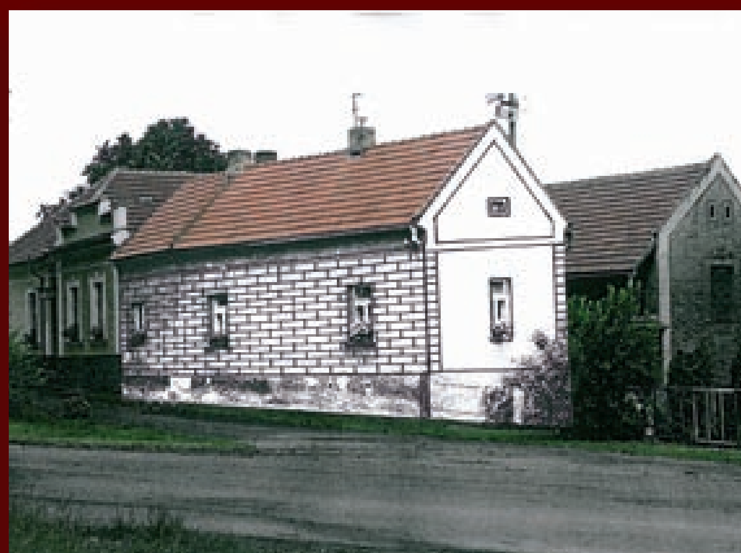
Pracovní návrh obnovy východní části jižního průčelí fasády s kvádrováním a navazujícího východního průčelí s kvádrováním lesenových pásů v nárožích a lesenovými rámy štítu – náčrt do fotografie zhotovený pracovníky NPU.
