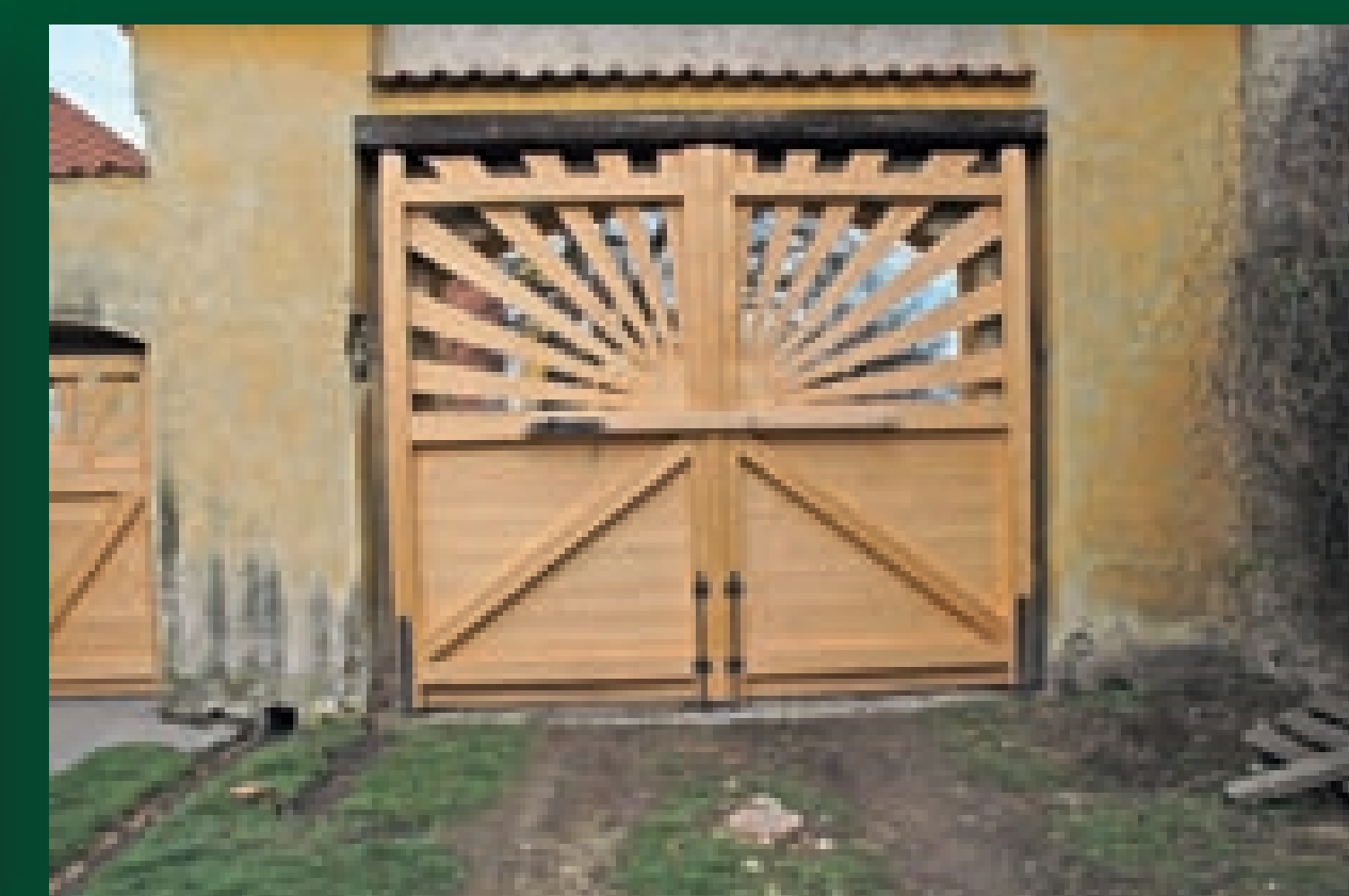
Obnovená brána s točnicovými vraty. Při pohledu ze dvora je viditelná jejich nosná konstrukce.
