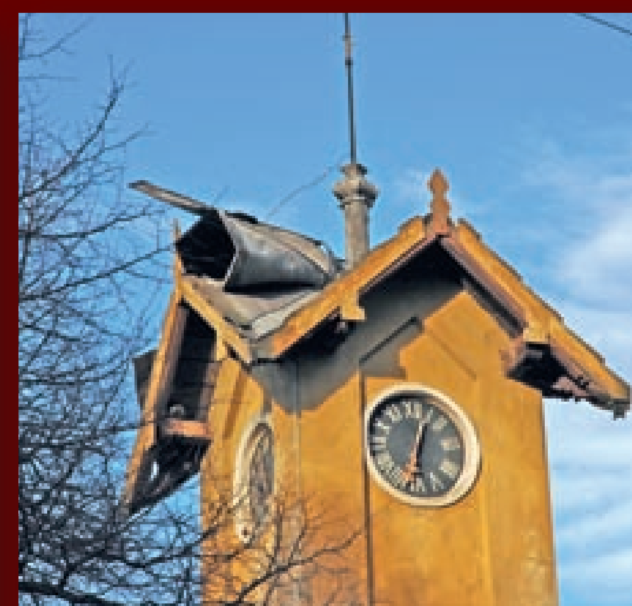
← Orkán na počátku roku 2007 strhl nejen vlastní krytinu, ale odhalil také špatný stav krovu. Současně se stal impulsem k zahájení potřebné celkové obnovy hlavního průčelí usedlosti.
