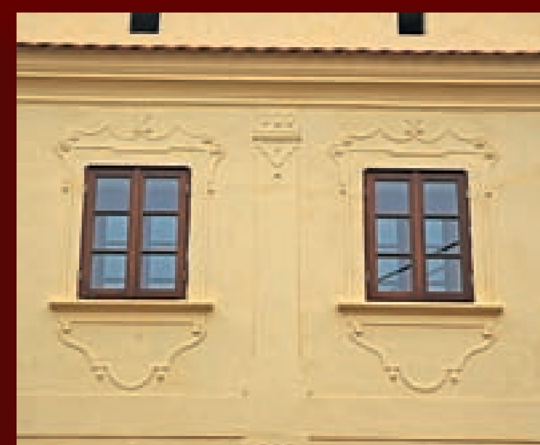
↑↗ Proměny obytného stavení v letech 2001–2005. Obnovená fasáda byla v detailech členění rekonstruována podle dochovaných zbytků původních článků a profilací.
