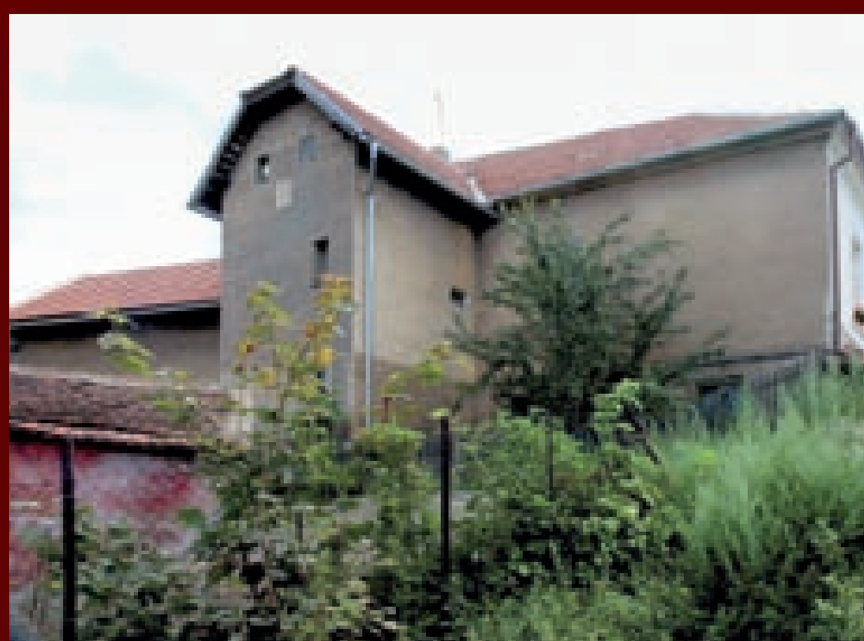
Pohled od rybníka před obnovou.
