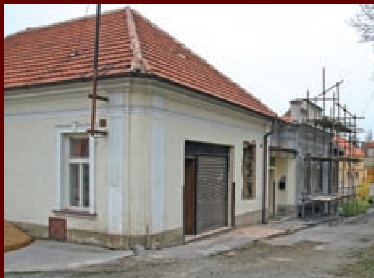
Zahájení obnovy západní části jižního průčelí bývalého hostince čp. 22 s navazujícím středním dílem s atikou.
