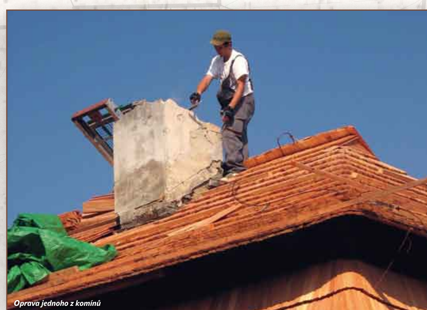
Oprava jednoho z komínů
