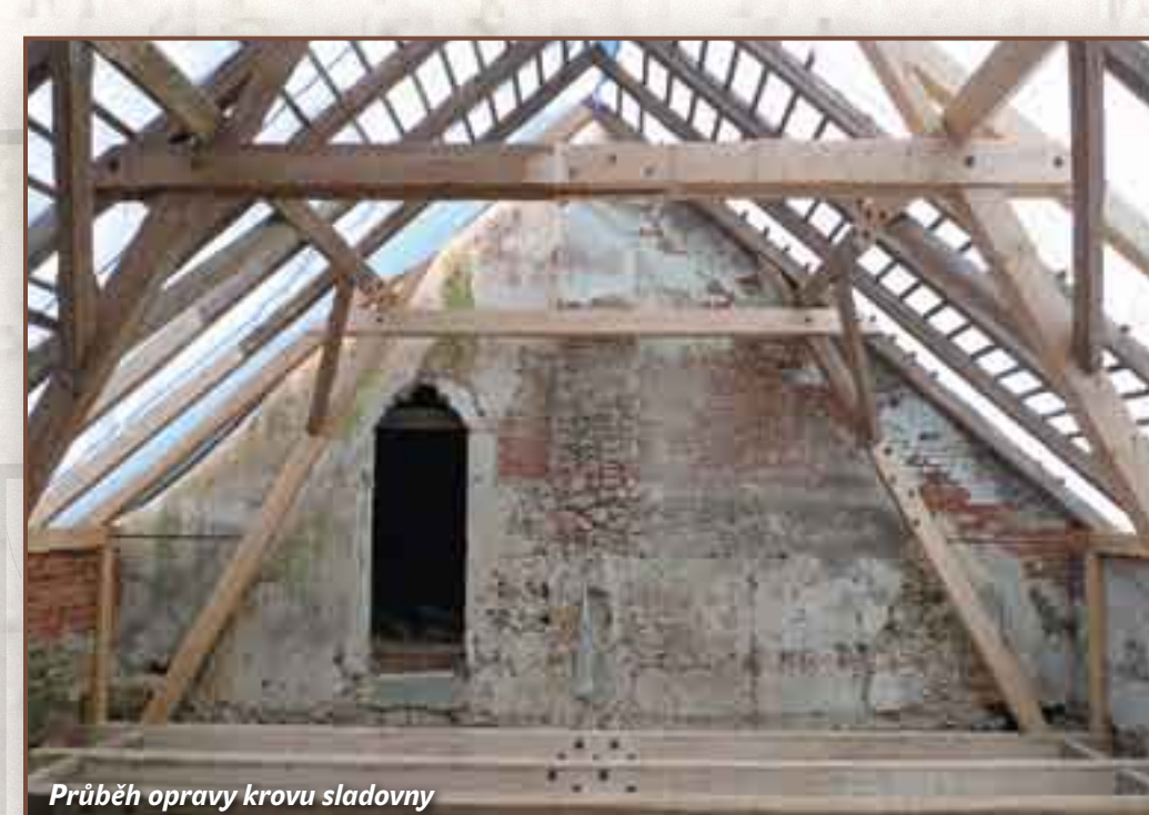
Průběh opravy krovu sladovny
