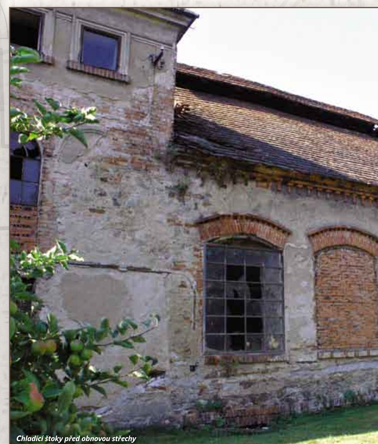
Chladicí štoky před obnovou střechy
