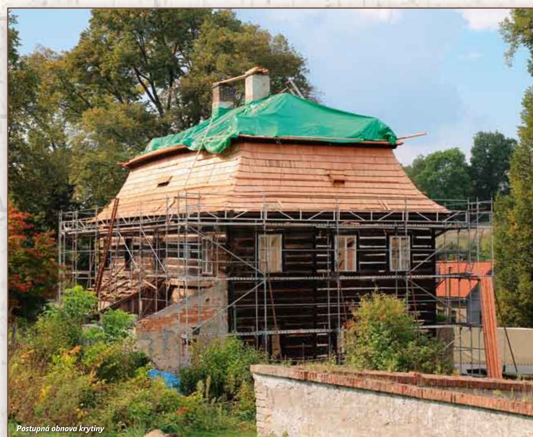
Postupná obnova krytiny
