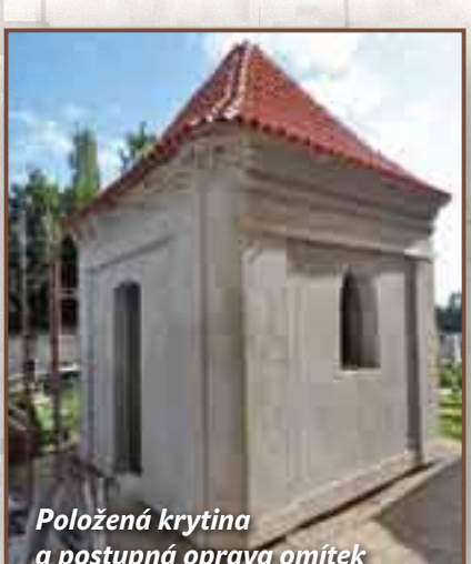
Položená krytina a postupná oprava omítek
