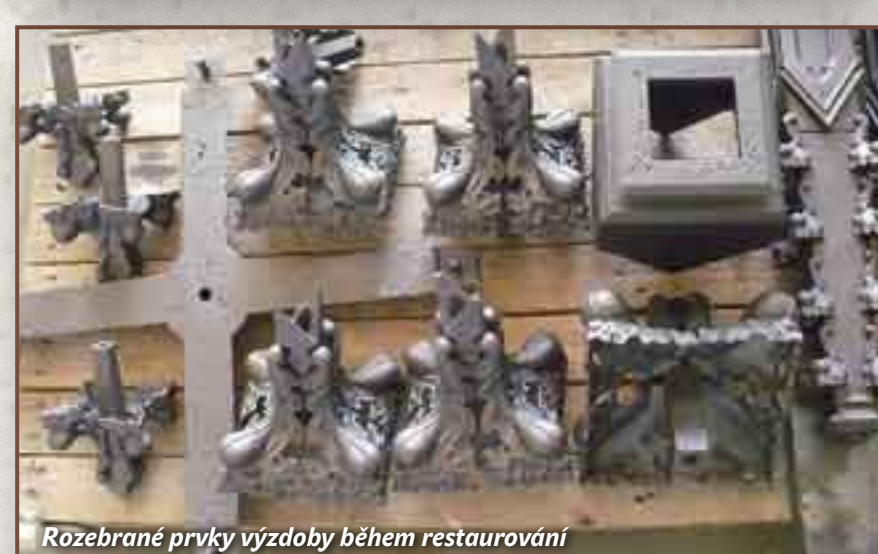
Rozebrané prvky výzdoby během restaurování
