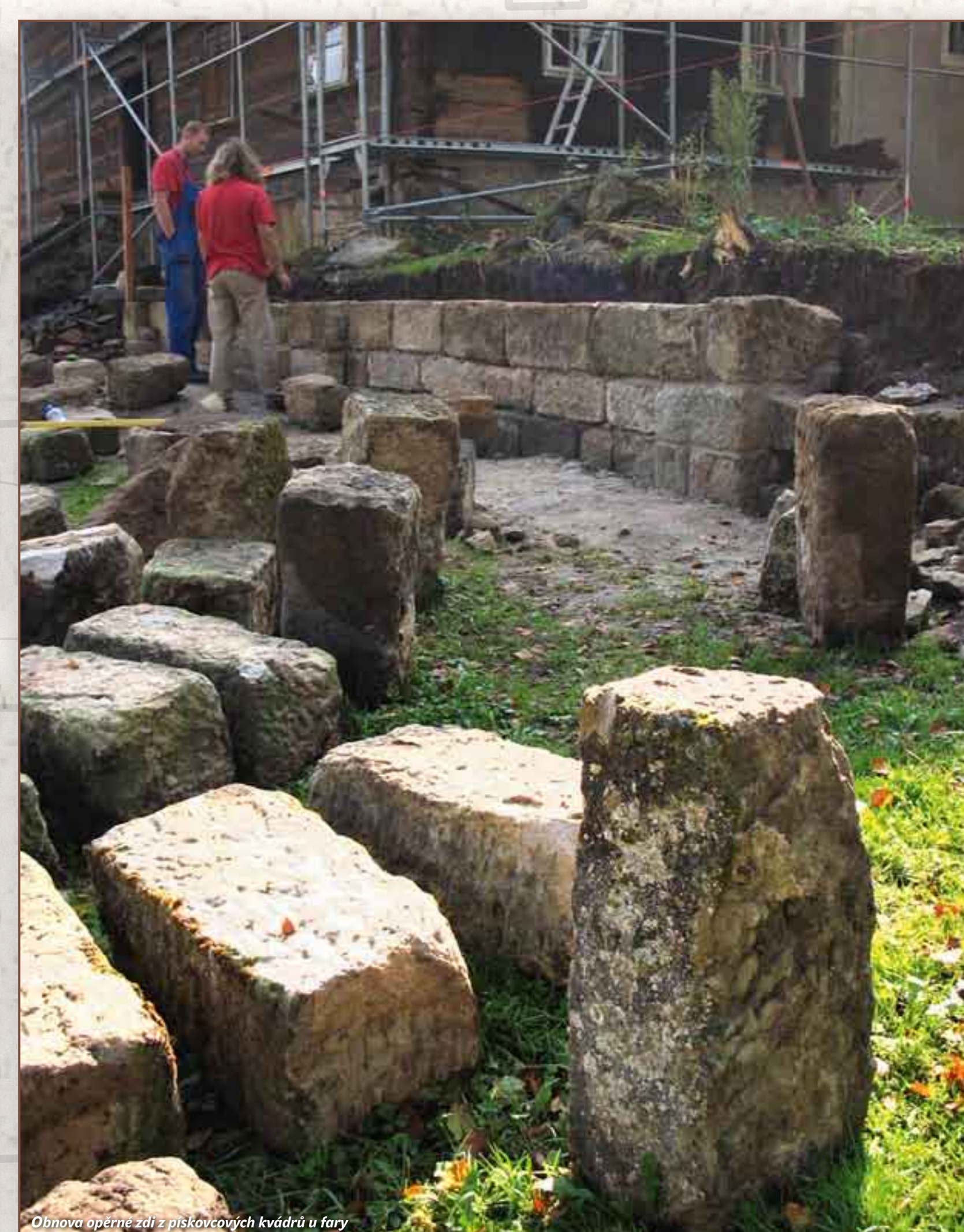
Obnova opěrné zdi z pískovcových kvádrů u fary
