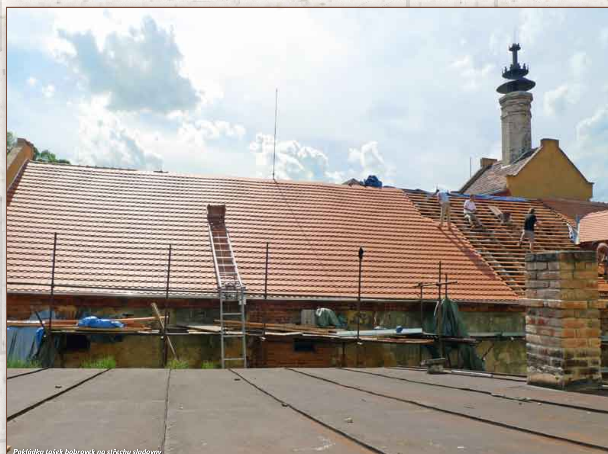
Pokládka tašek bobrovček na střechu sladovny
