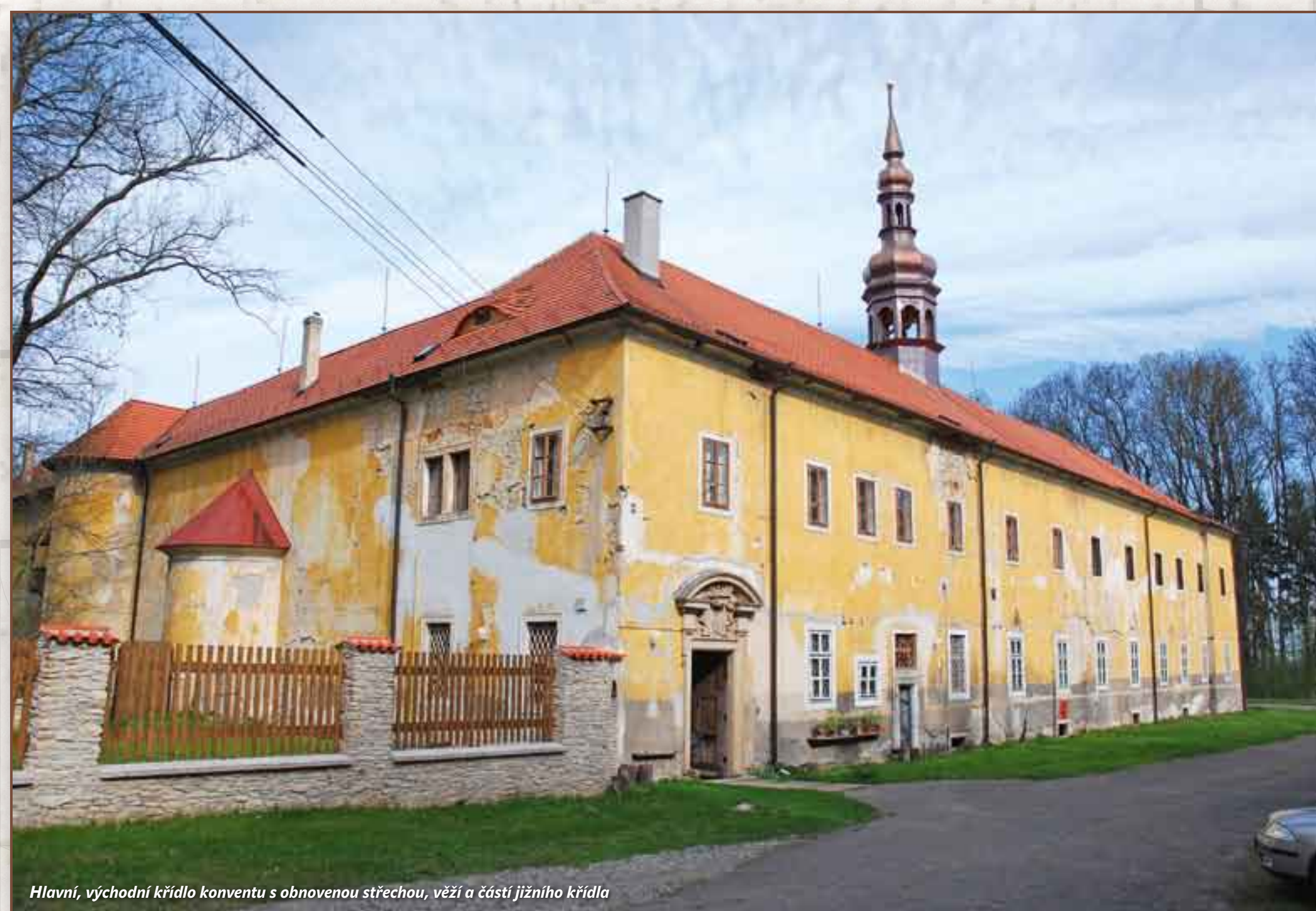
Hlavní, východní křídlo konventu s obnovenou střechou, věží a částí jižního křídla
