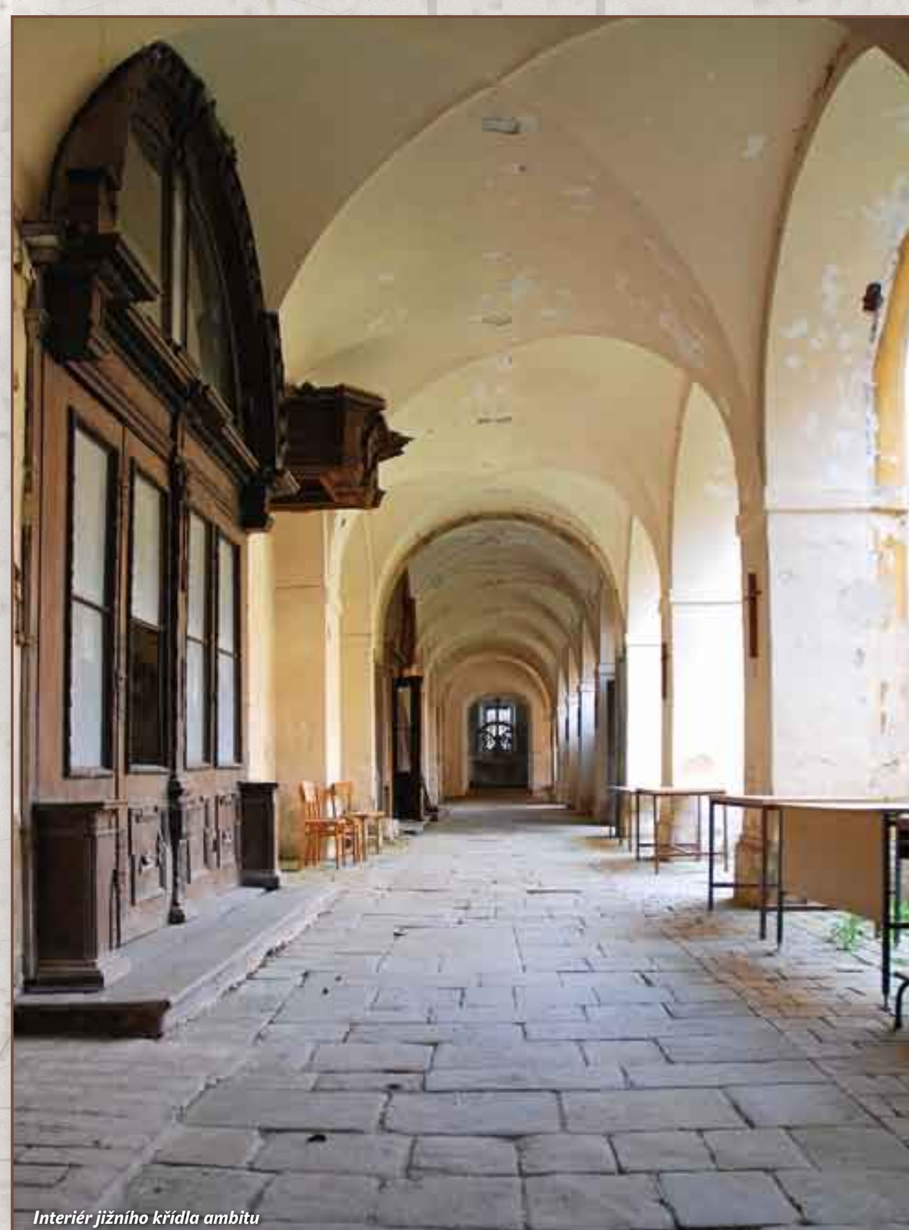
Interiér jižního křídla ambitu
