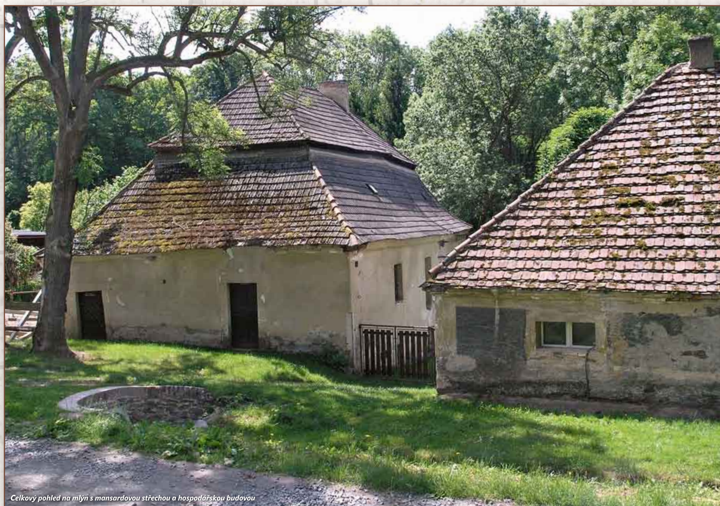
Celkový pohled na mlýn s mansardovou střechou a hospodářskou budovou
