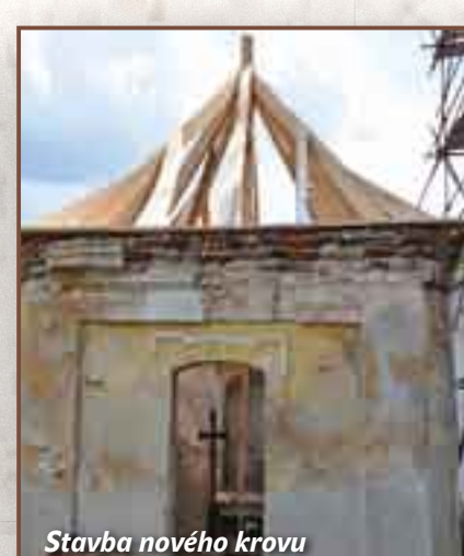
Stavba nového krovu
