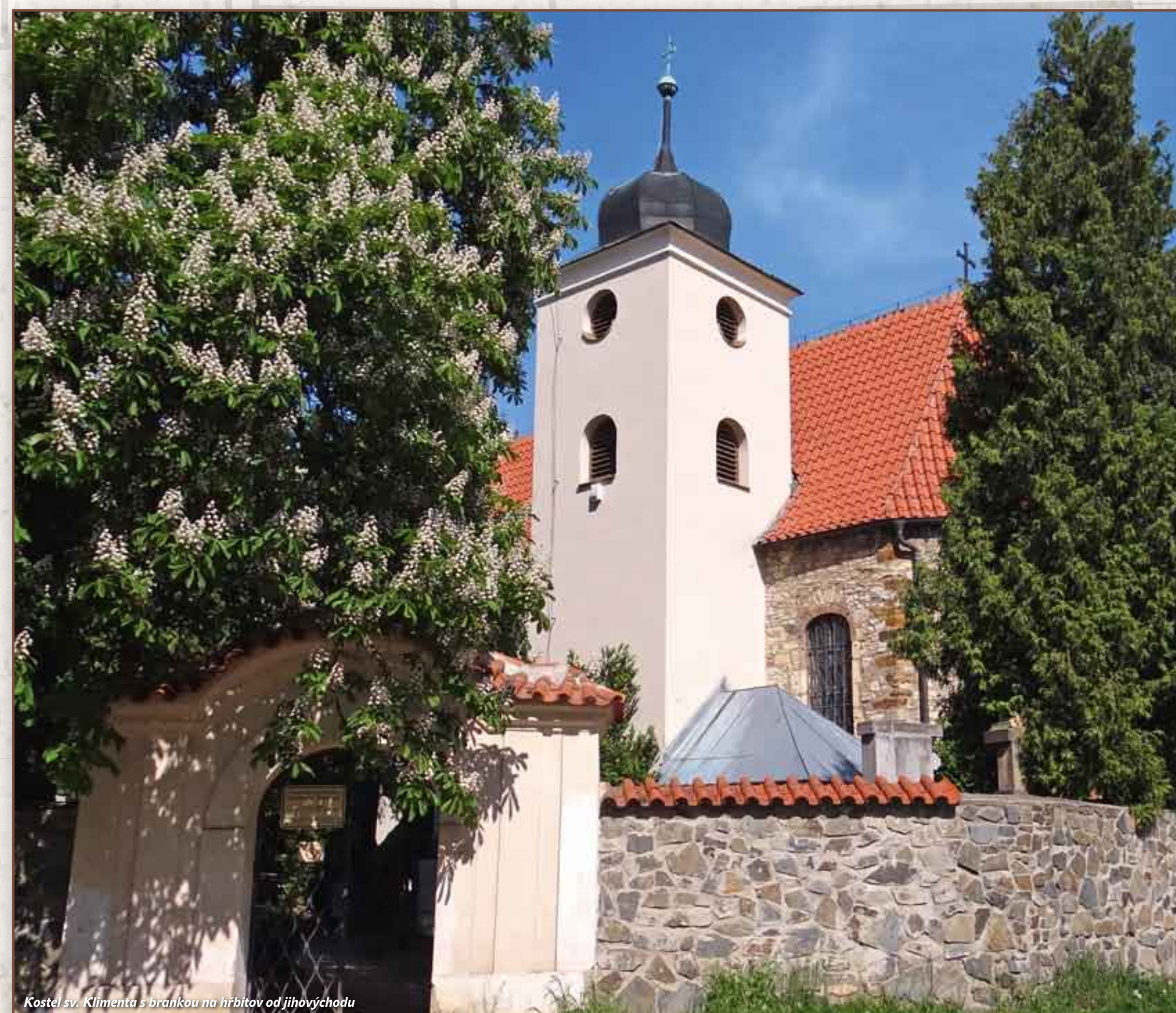
Kostel sv. Klimenta s bráncou na hradištích od jihovýchodu
