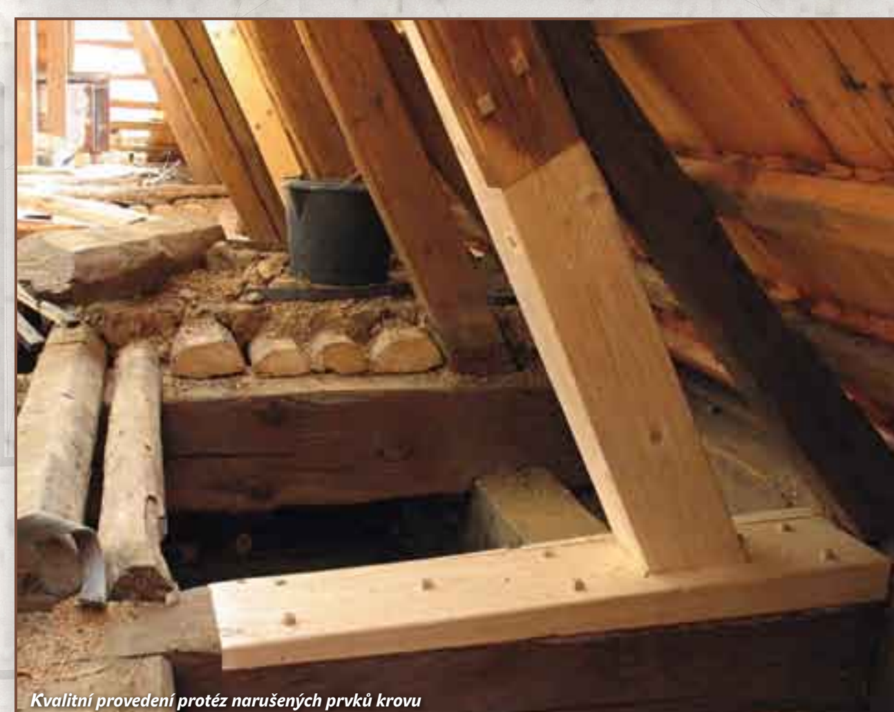
Kvalitní provedení protéz narušených prvků krovu
