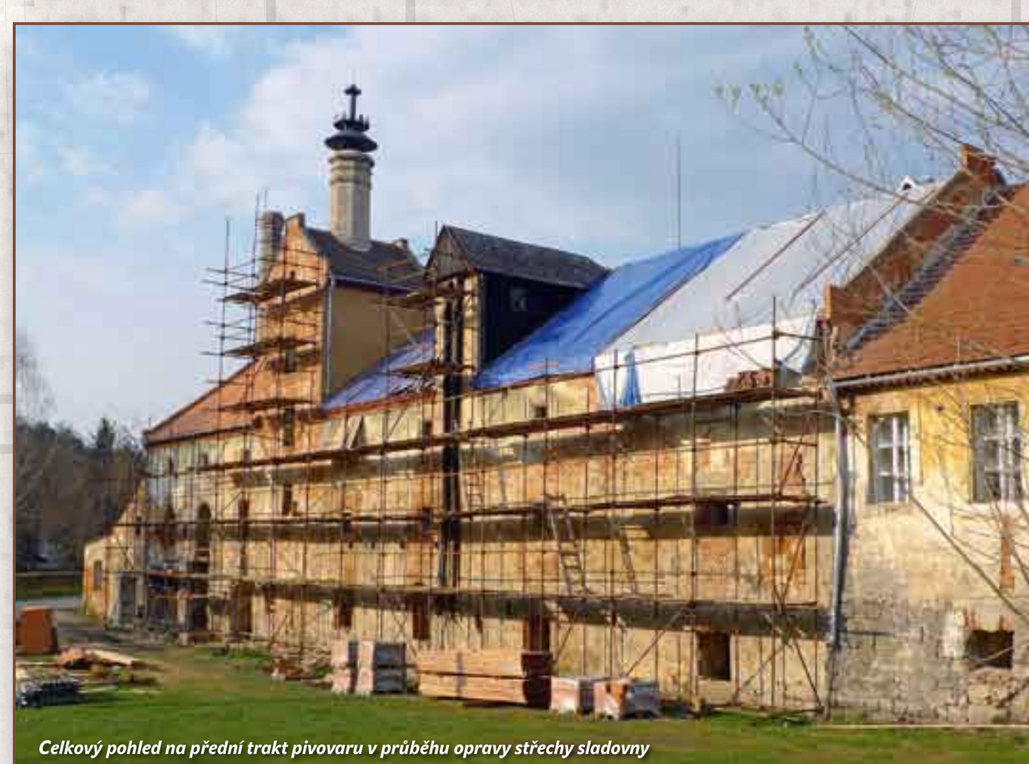
Celkový pohled na přední trakt pivovaru v průběhu opravy střechy sladovny
