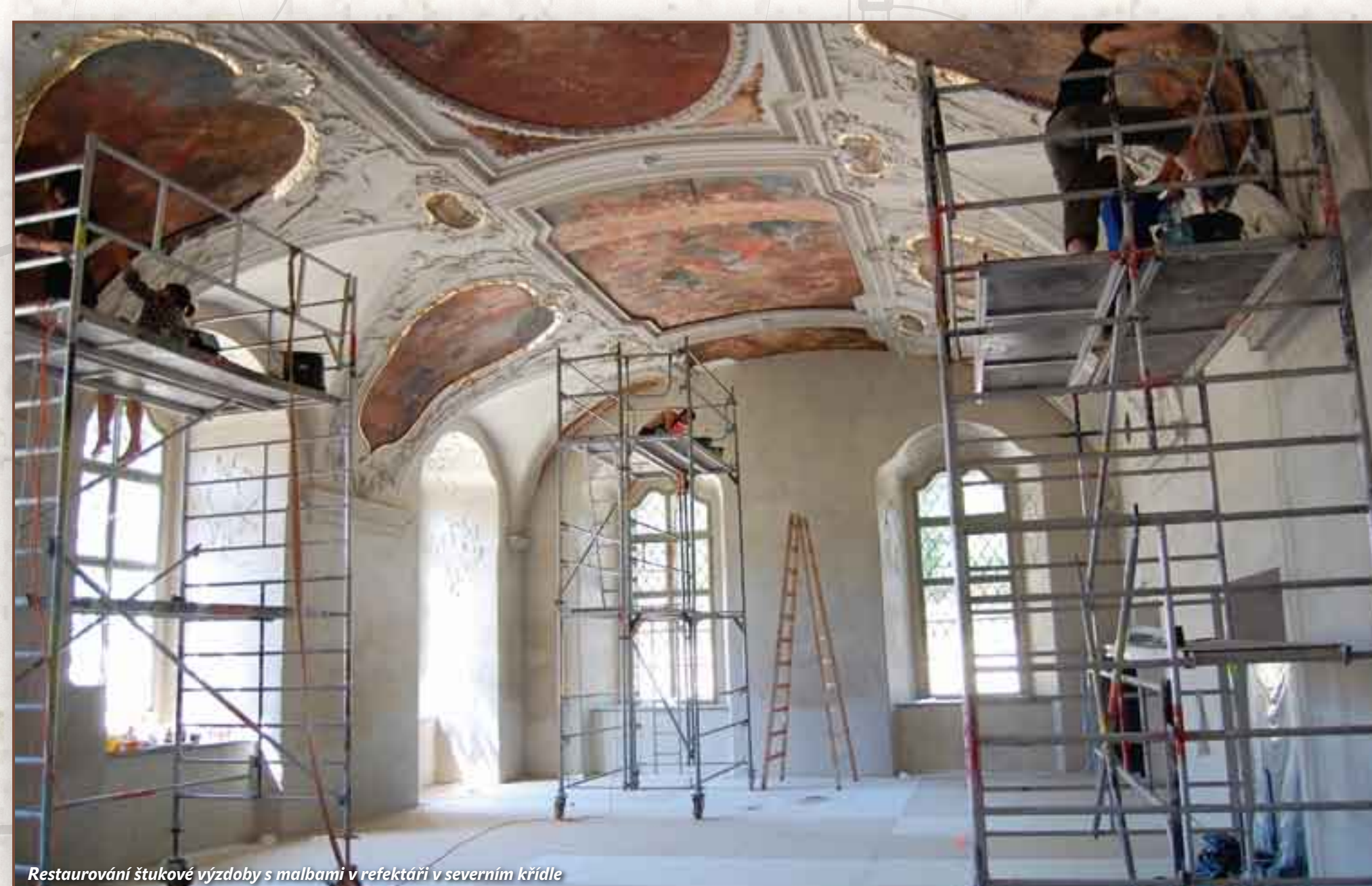
Restaurování štukové výzdoby s malbami v rektoriu v severním křídle
