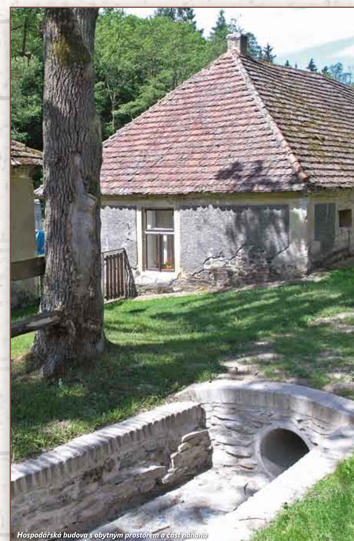
Hospodářská budova s obytným prostorem a část náhonu
