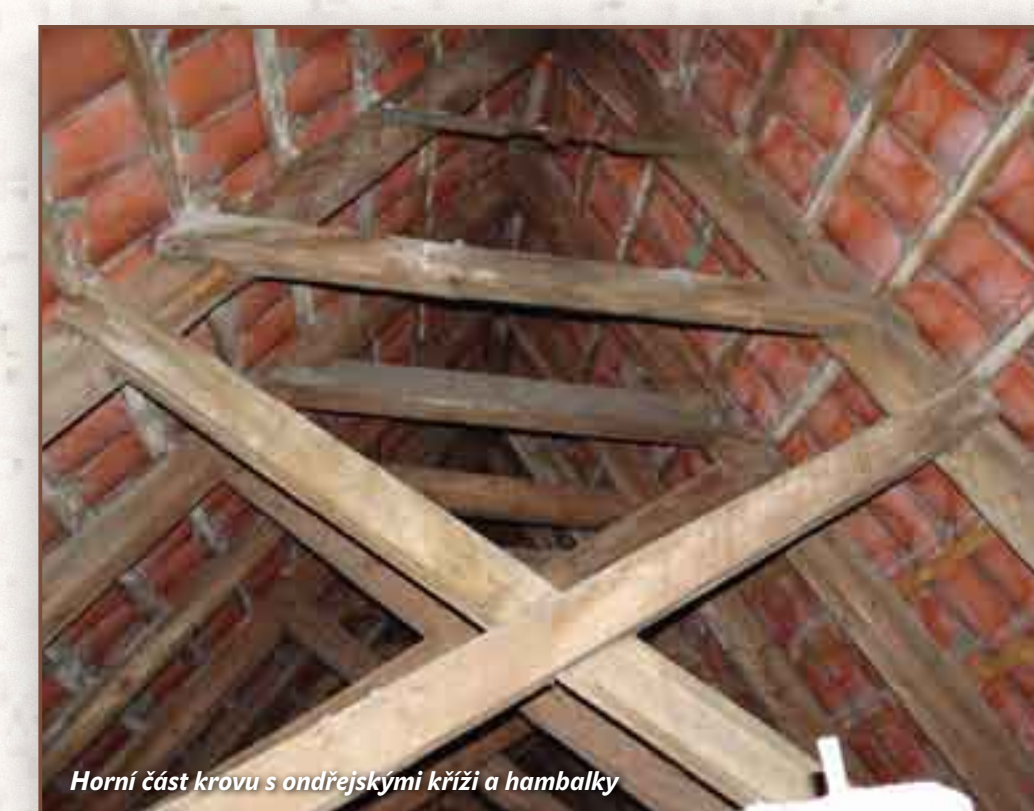
Horní část krovu s andréjskými kříži a hambalky
