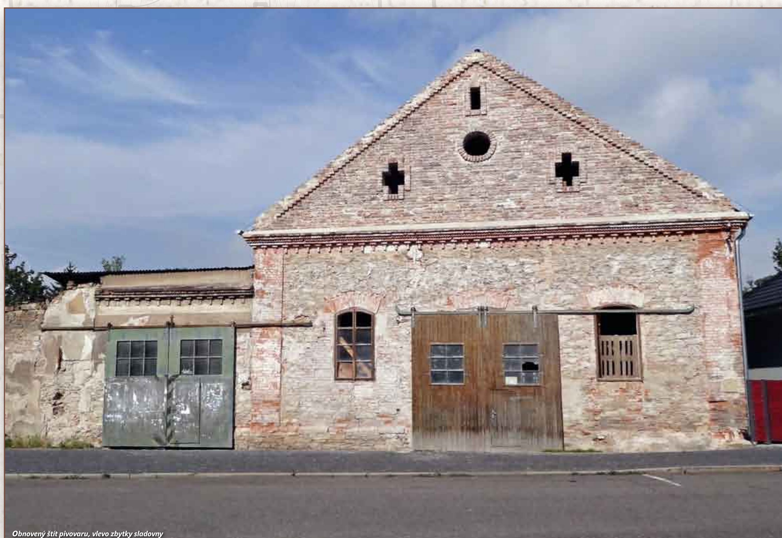
Obnovený štít pivovaru, vlevo zbytky sladovny
