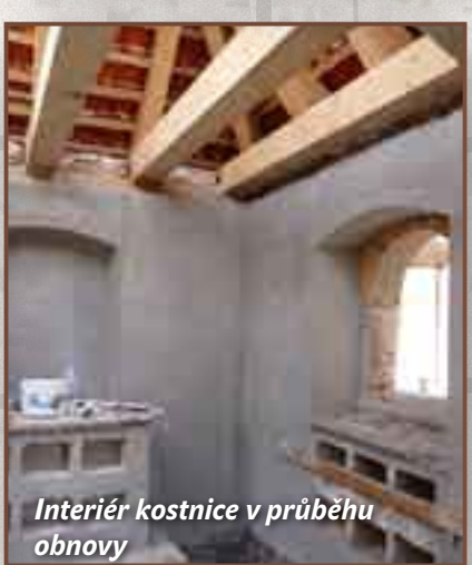
Interiér kostnice v průběhu obnovy
