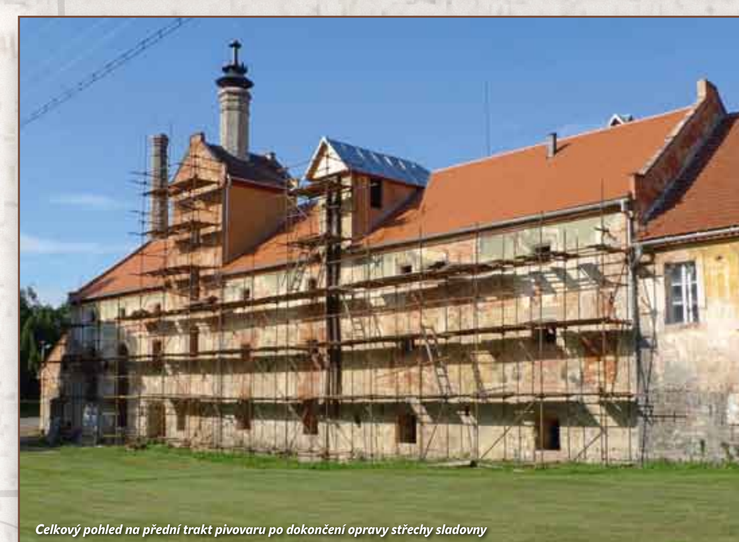
Celkový pohled na přední trakt pivovaru po dokončení opravy střechy sladovny
