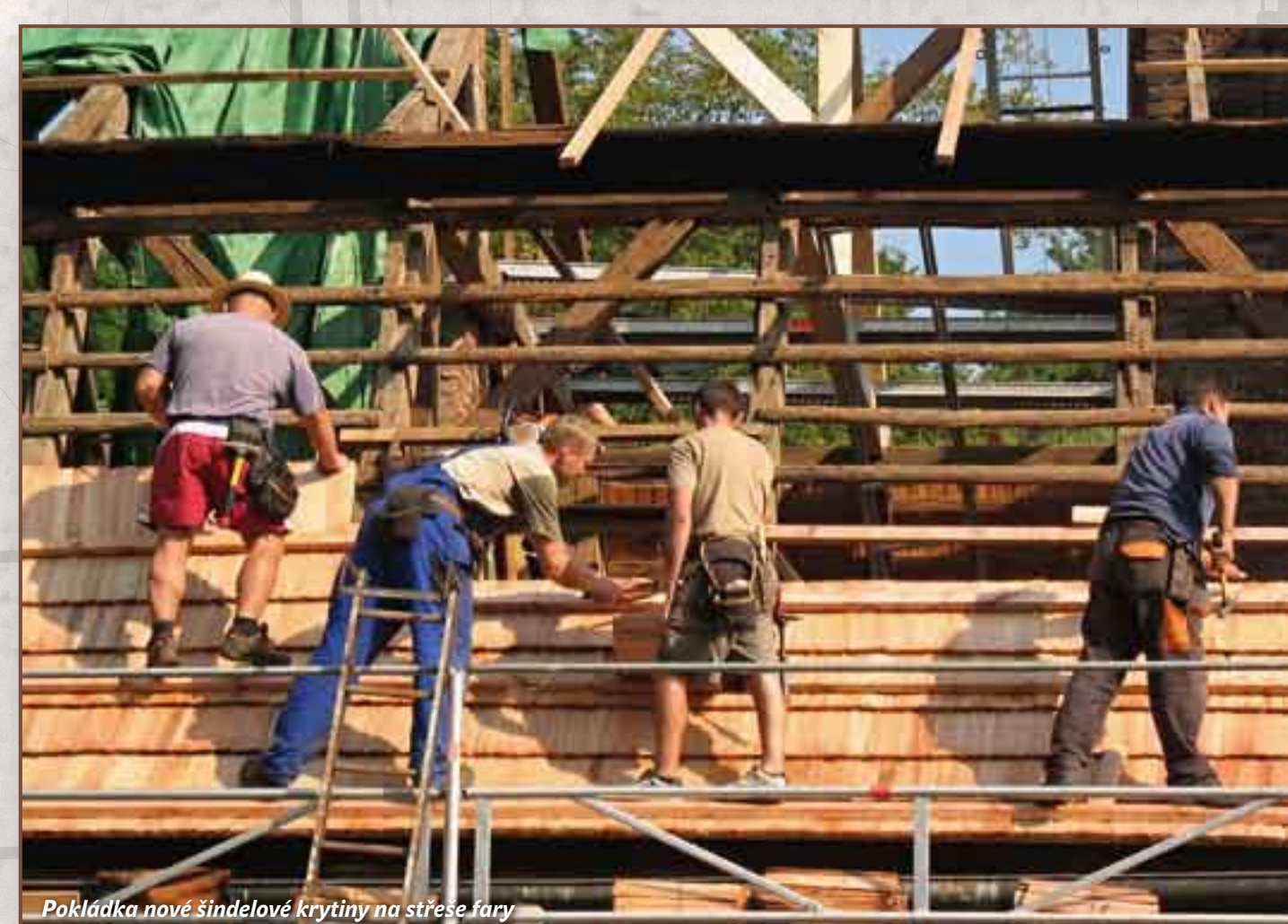
Pokládka nové šindelové krytiny na střechu fary
