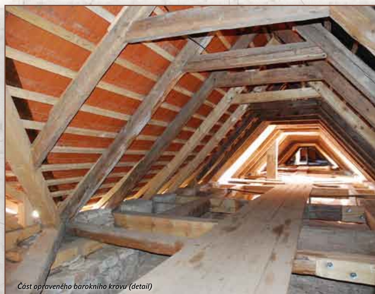
Část opraveného barokního krovu (detail)
