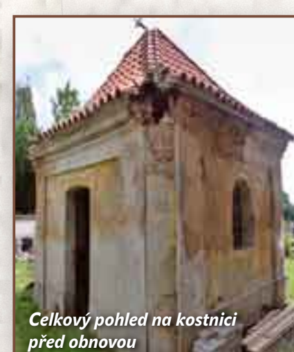
Celkový pohled na kostnici před obnovou
