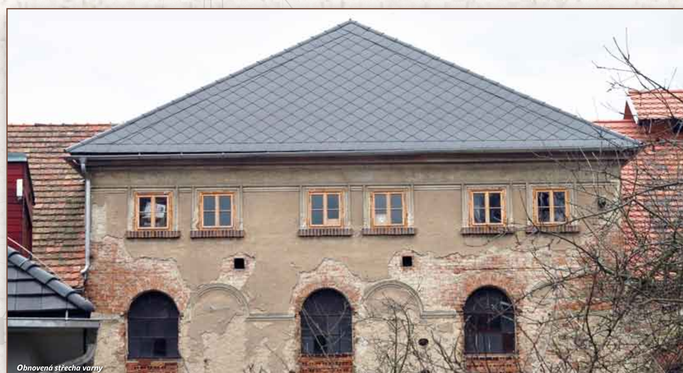
Obnovená střecha varny
