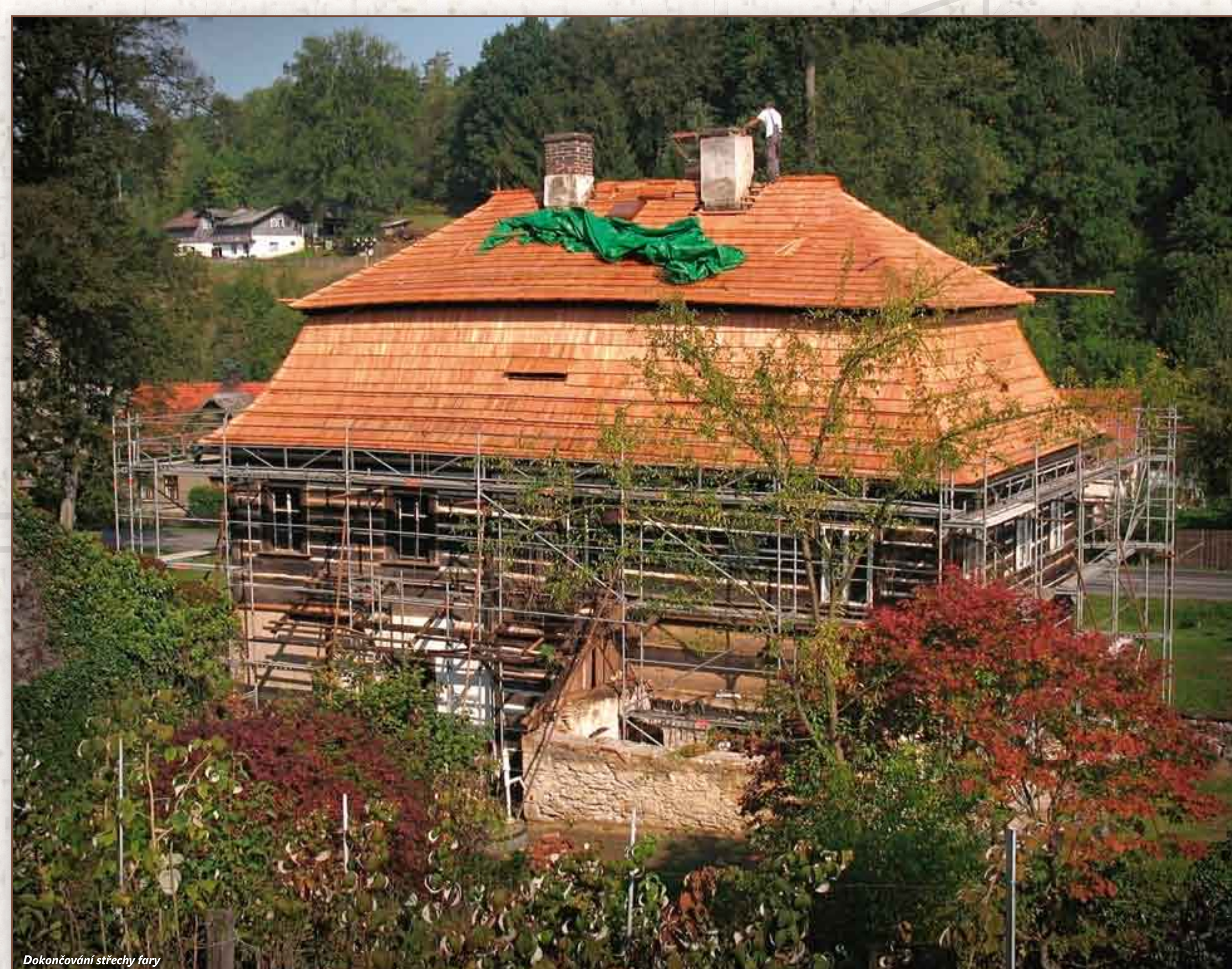
Dokončování střechy fary
