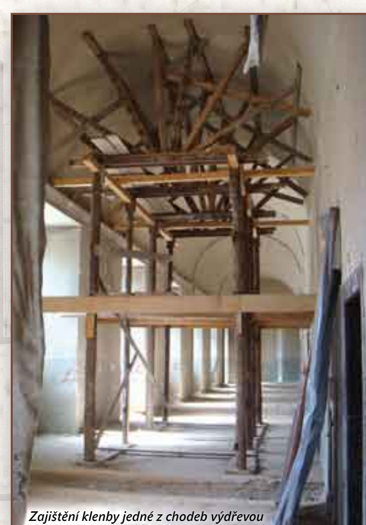
Zajištění klenby jedné z chodeb výdřevou
