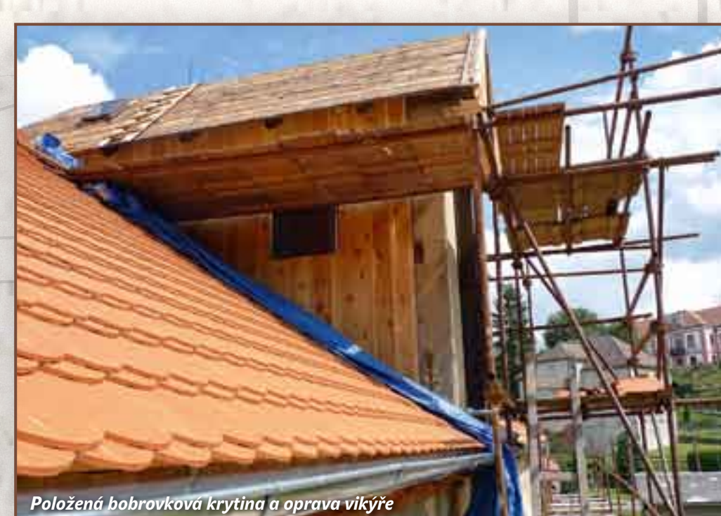
Položená bobrovková krytina a oprava vikýře
