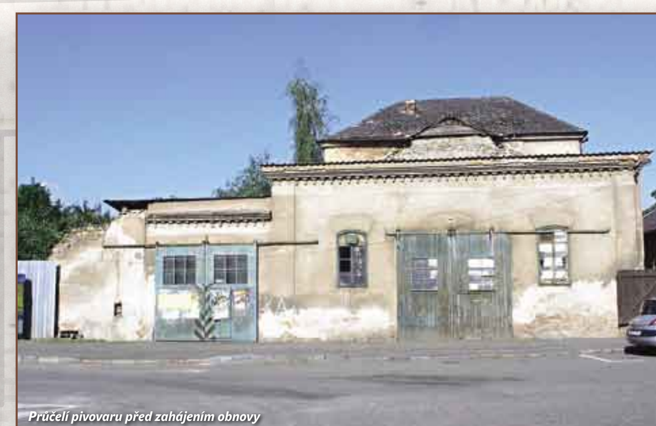
Průčelí pivovaru před zahájením obnovy
